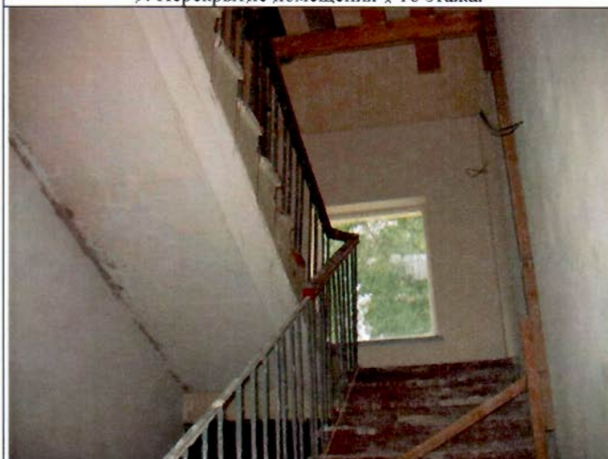
11. Лестницы. Общий вид.
