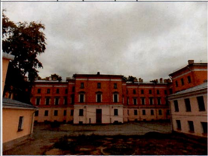
10. Центральный ризалит дворового фасада. Общий вид.
