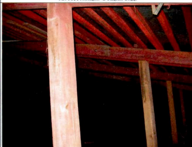
14. Конструкции крыши. Общий вид.
