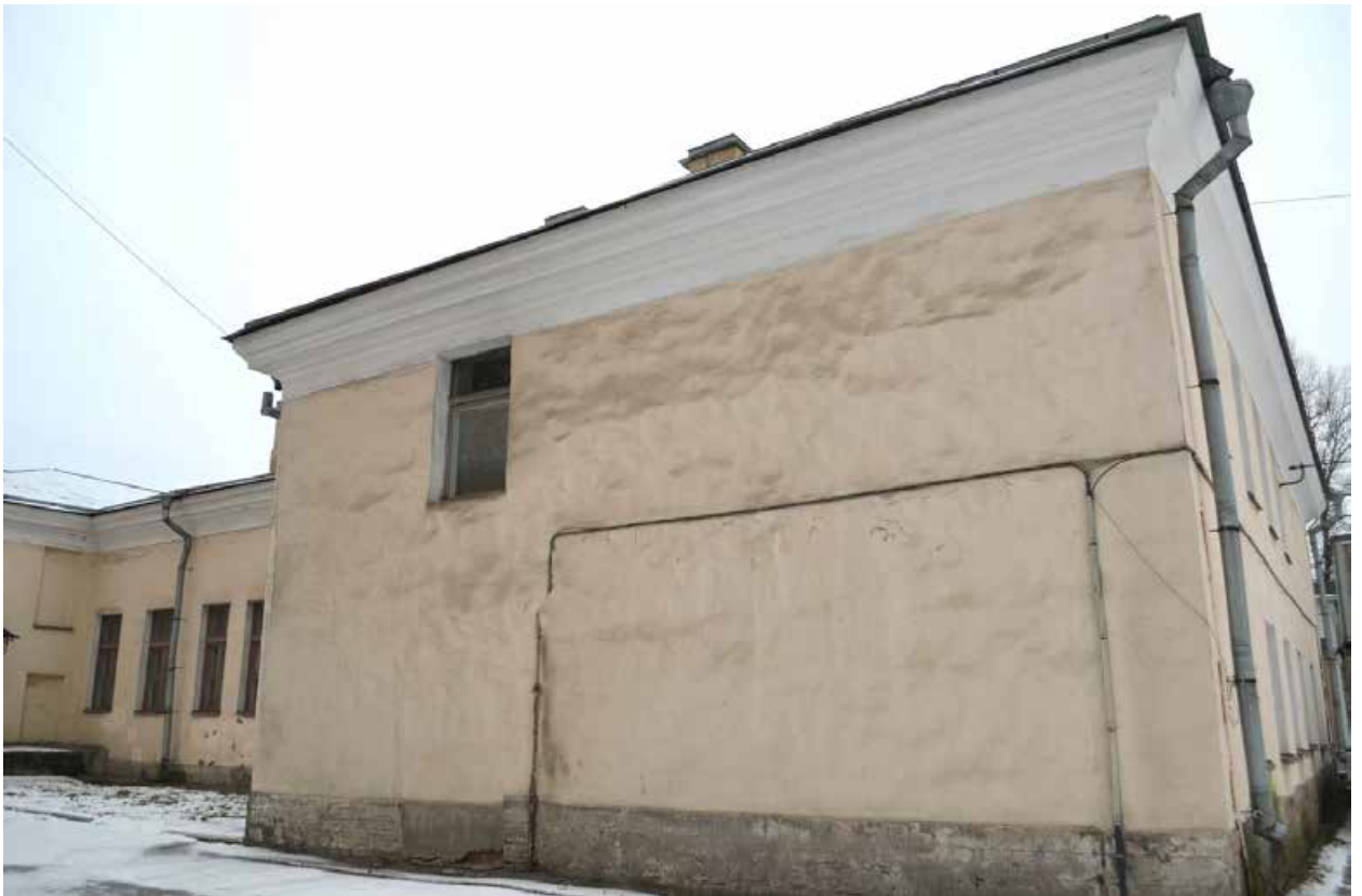
Фото 2.11. Духовная академия. Больничный флигель (наб. Обводного канала, 7, литер А). Восточный фасад. Фрагмент. Съёмка 01.12.2021 г.
