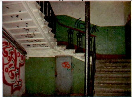
28. Лестница в южной части здания. Общий вид.
