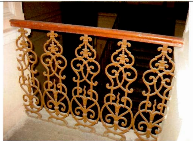
16. Ограждение лестницы северной части здания. Фрагмент.
