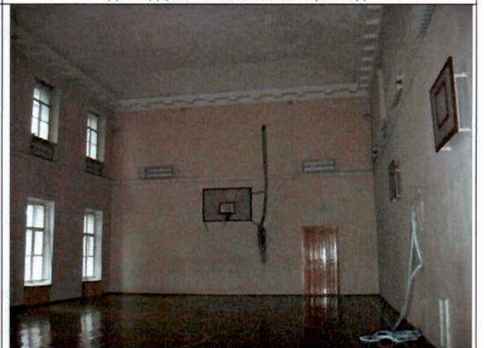
33. Помещение 3-Н (111) бывшего Актового зала. Общий вид.
