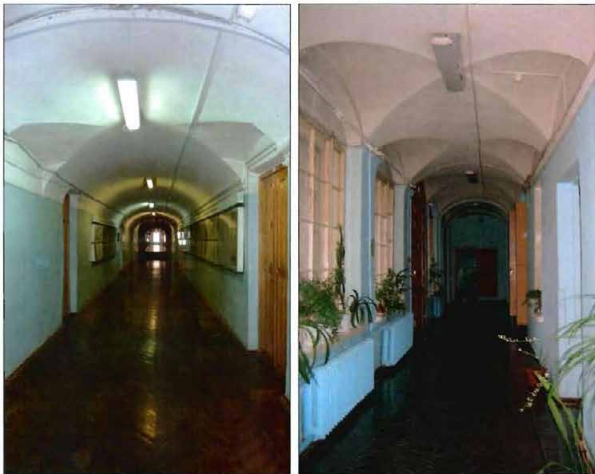
11, 12. Своды. Коридоры первого этажа (пом. 3-Н (15, 29)).
