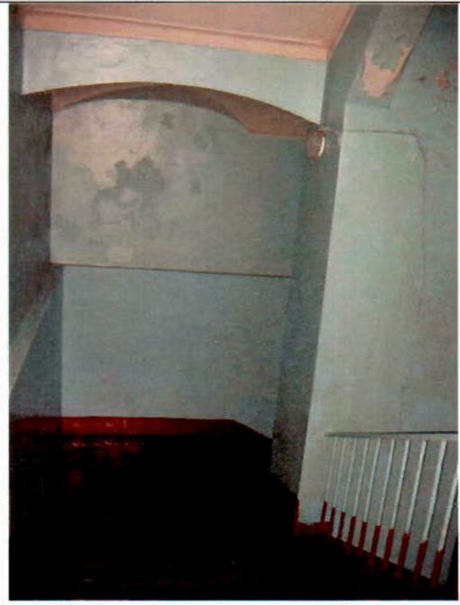
39. Лестница в южном крыле. Фрагмент.
