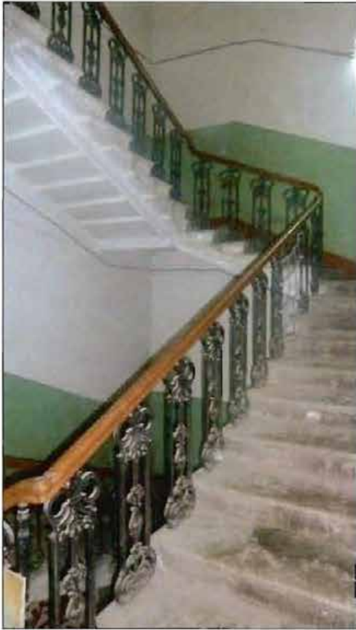
7. Лестница в южной части здания. Л-1.
