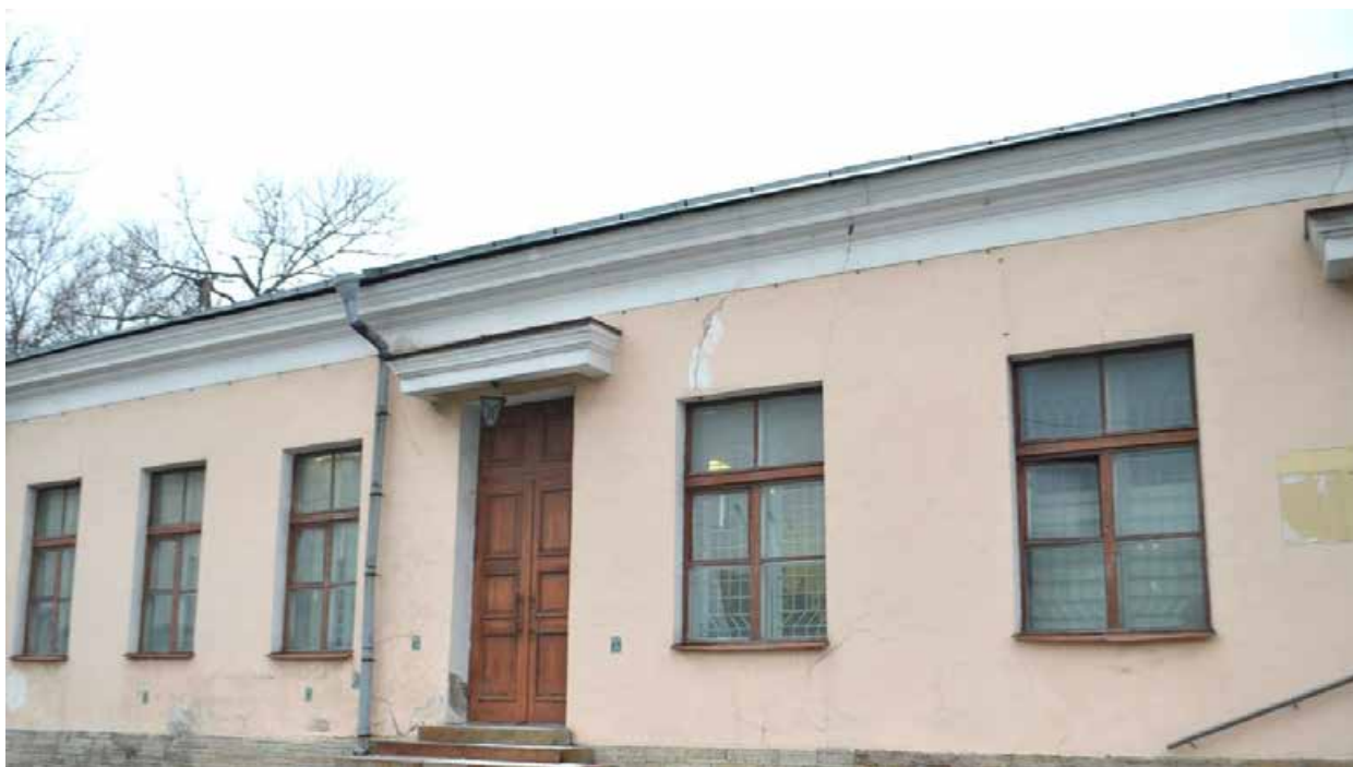
Фото 2.2. Духовная академия. Больничный флигель (наб. Обводного канала, 7, литер А). Южный фасад. Фрагмент. Съёмка 01.12.2021 г.
