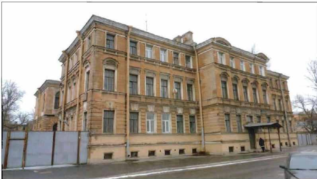
1. Объект культурного наследия. Южный фасад. Вид с юга.
