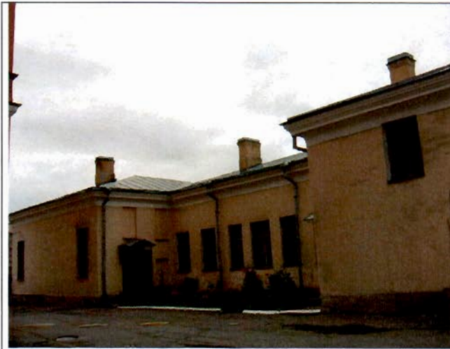
1. Восточный фасад. Общий вид.
