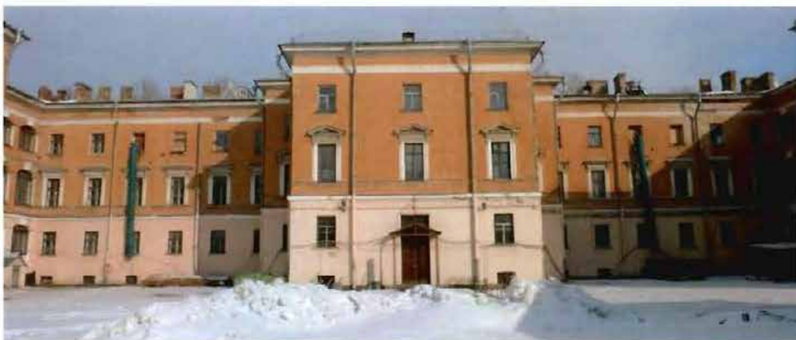
4. Объект культурного наследия. Центральная часть западного (дворового фасада).
