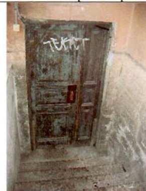
6. Входной проем восточного фасада. Общий вид.
