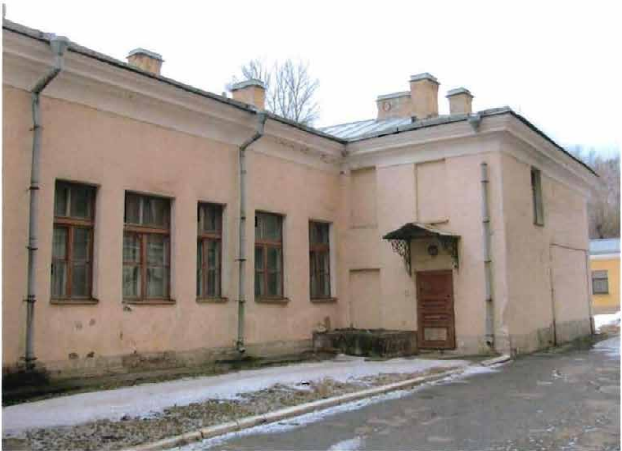
3. Фрагмент восточного фасада. Вид с юго-востока.
