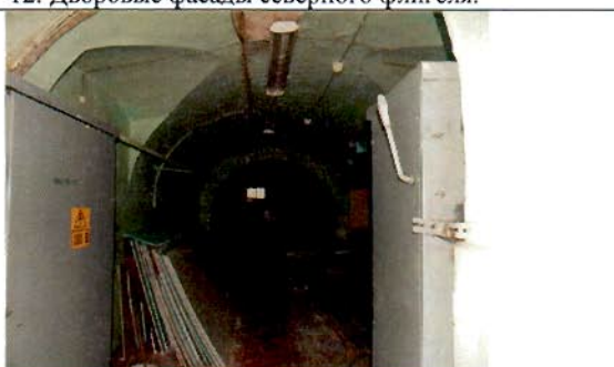
14. Коридор в уровне подвала. Общий вид.
