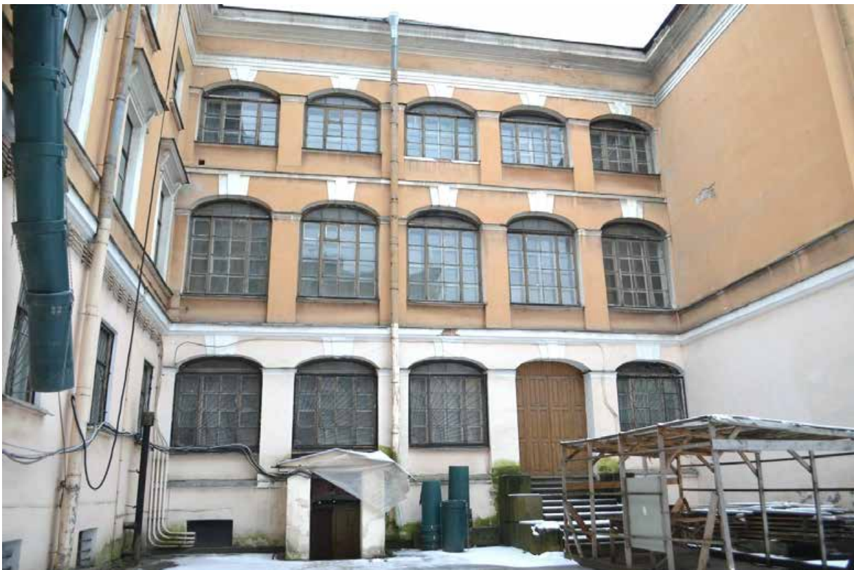
Фото 1.23. Духовная академия. Главное здание (наб. Обводного канала, 7, литер Г). Западный дворовый фасад. Южное крыльцо. Съёмка 01.12.2021 г.
