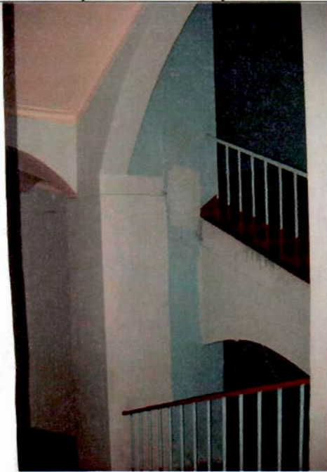
38. Лестница в южном крыле. Фрагмент.
