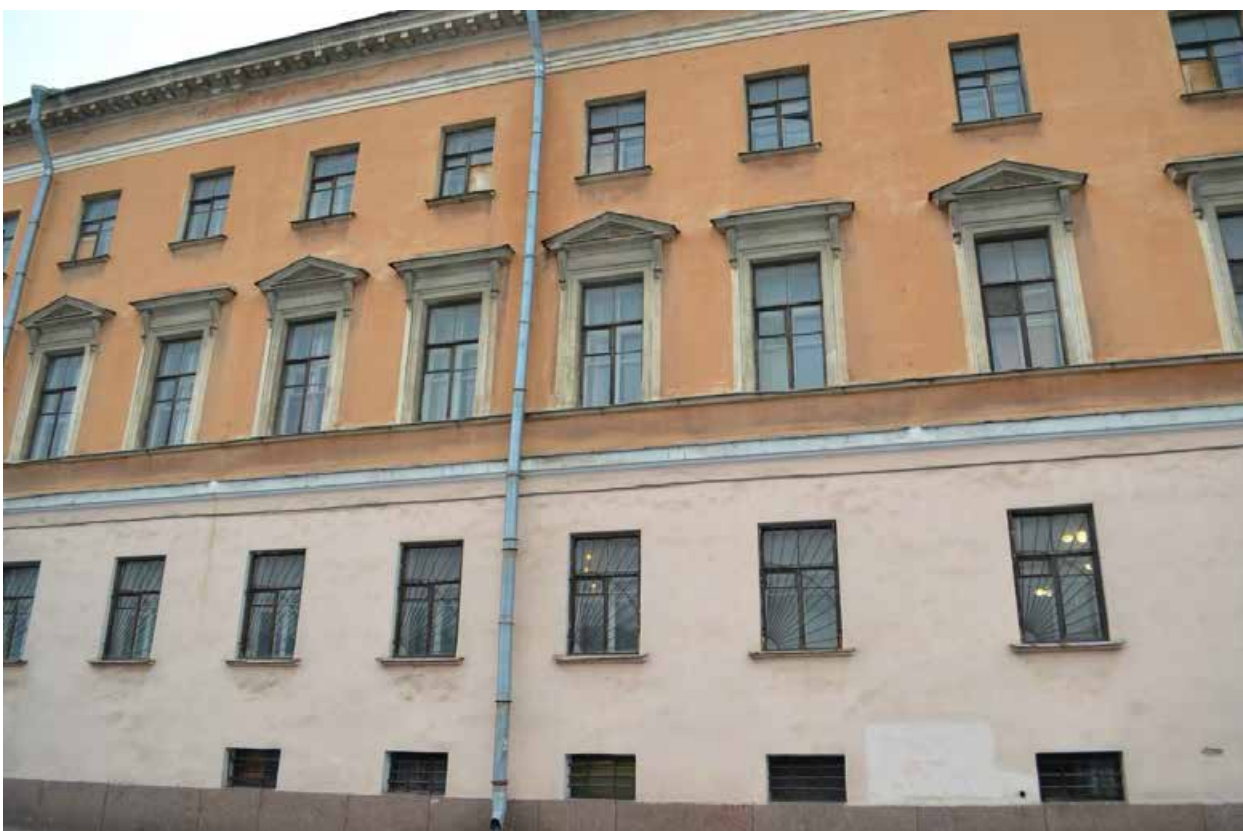
Фото 1.28. Духовная академия. Главное здание (наб. Обводного канала, 7, литер Г). Западный дворový фасад. Фрагмент. Съёмка 01.12.2021 г.
