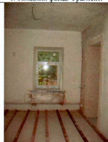
8. Помещение 1-го этажа. Общий вид.
