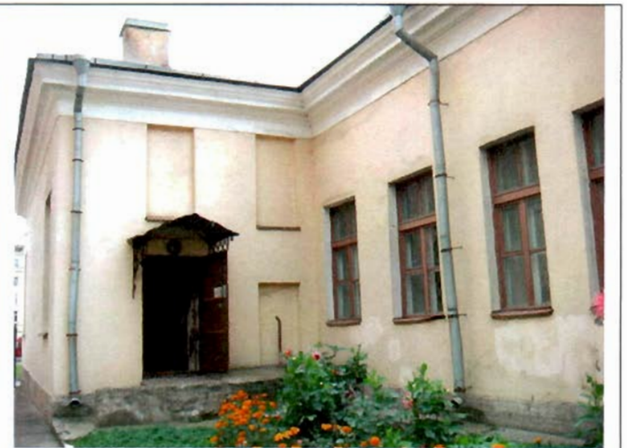
2. Фрагмент восточного фасада.
