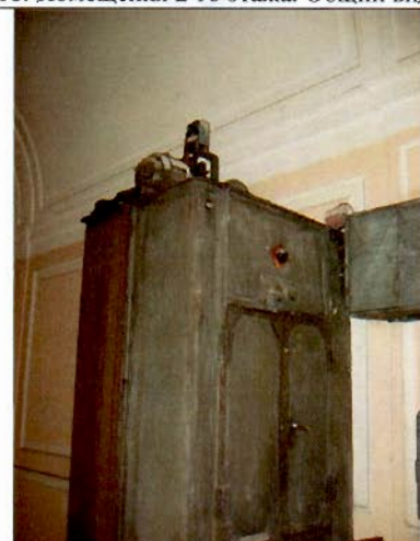
20. Лифтовая шахта. Фрагмент.
