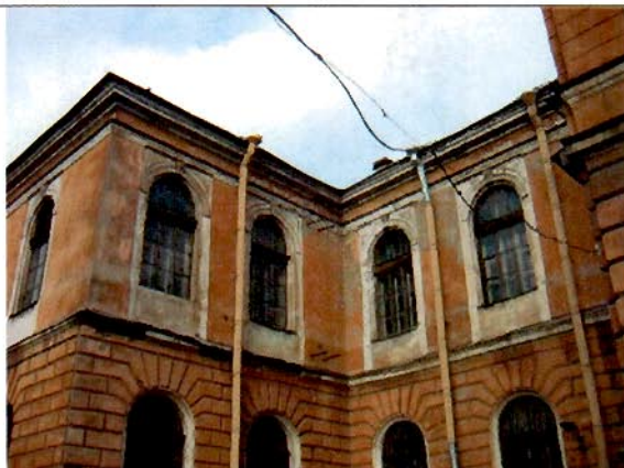
13. Западный фасад. Фрагмент.
