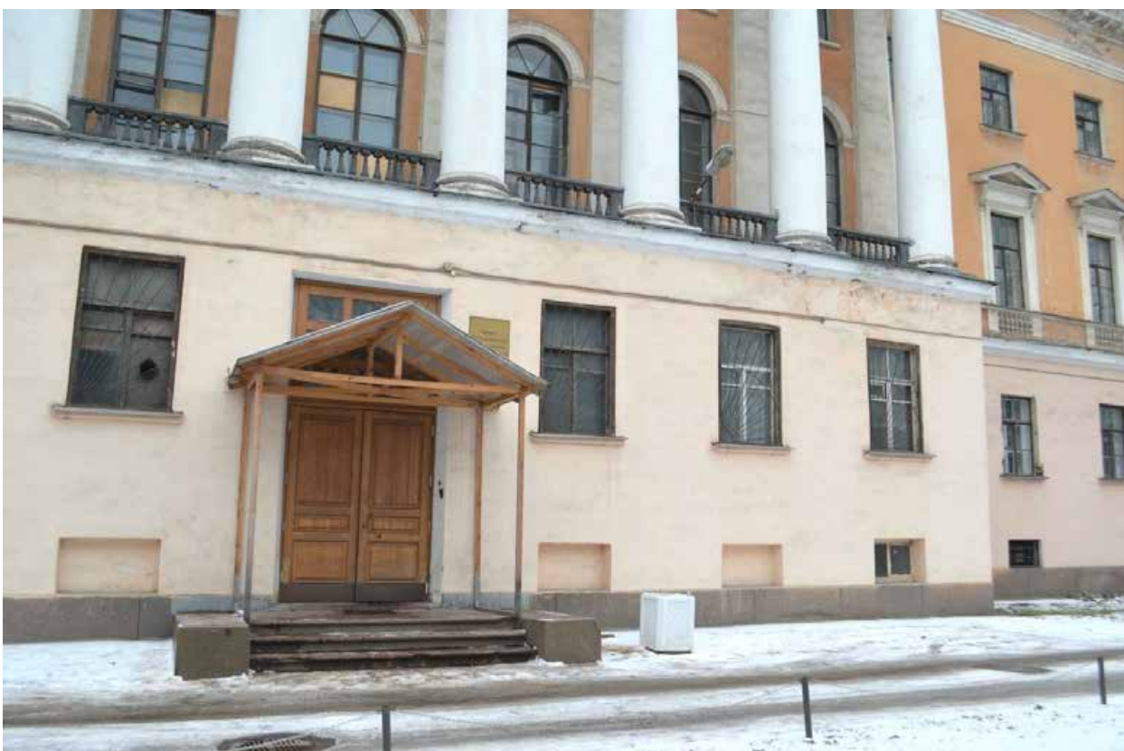
Фото 1.6. Духовная академия. Главное здание (наб. Обводного канала, 7, литер Г). Восточный фасад. Центральное крыльцо. Фрагмент. Съёмка 01.12.2021 г.
