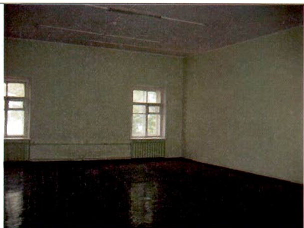
25. Помещения в уровне 2-го этажа. Общий вид.
