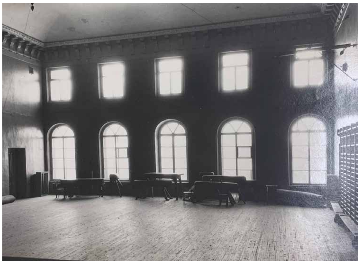
Илл. 31. Спортивный зал (быв. помещение церкви). Восточная и западная стены. Фото А.А. Григорьева. 1952 г. Архив ГИОП.
