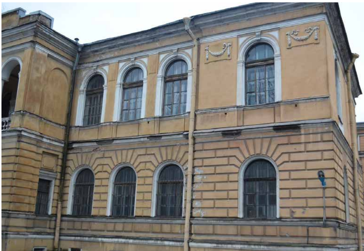
Фото 3.11. Духовная академия. Библиотека (наб. Обводного канала, 11, литер А). Северный фасад. Фрагмент. Съёмка 01.12.2021 г.
