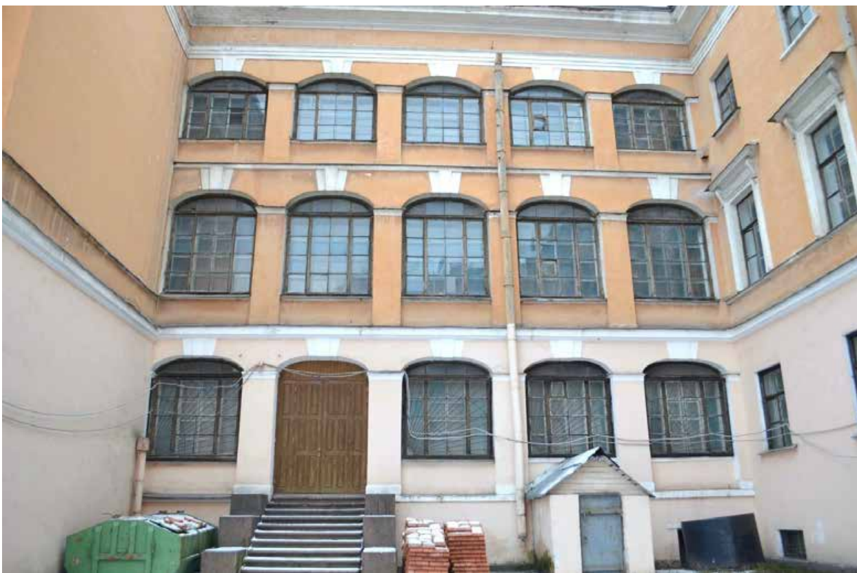
Фото 1.15. Духовная академия. Главное здание (наб. Обводного канала, 7, литер Г). Западный дворовый фасад. Северное крыльцо. Съёмка 01.12.2021 г.
