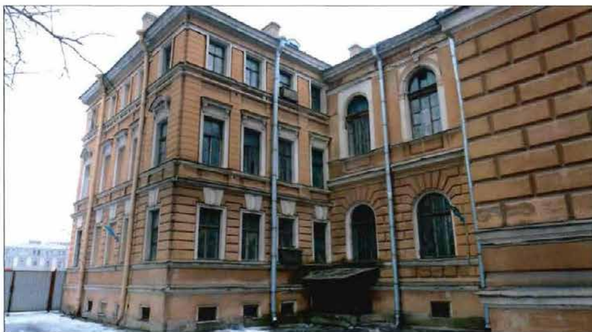
6. Объект культурного наследия. Восточный фасад. Фрагмент. Вид с северо-востока.
