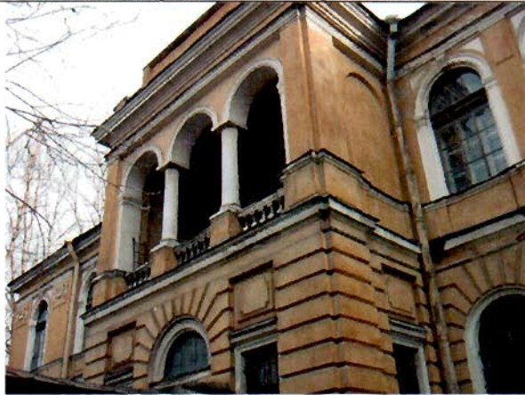
9. Северный фасад. Фрагмент.
