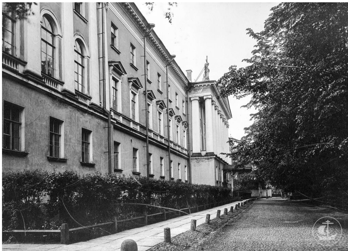
Илл. 21. Главный фасад здания Духовной Академии. 1910-е гг.
