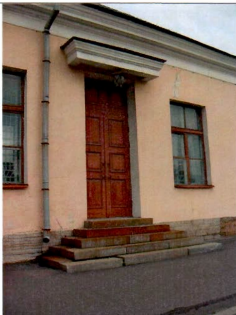
7. Дверное заполнение. Южный фасад.
