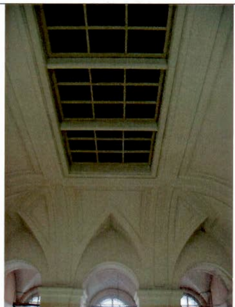
18. Помещения 2-го этажа. Общий вид.
