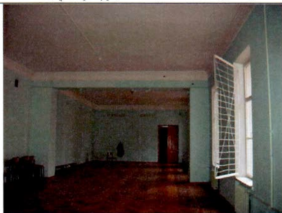
28. Помещение 2-го этажа. Общий вид.
