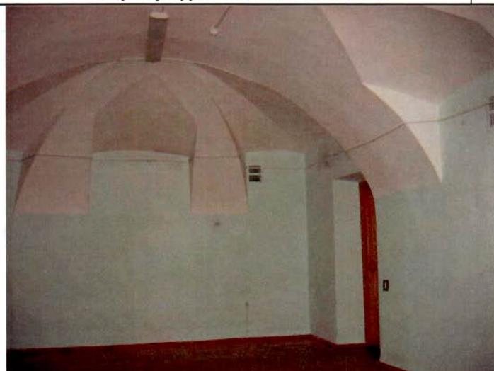
16. Помещения 1-го этажа. Общий вид.
