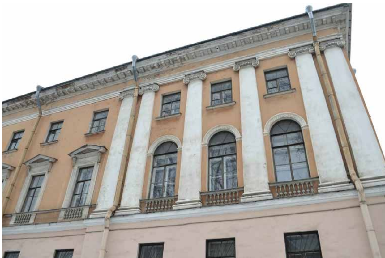
Фото 1.8. Духовная академия. Главное здание (наб. Обводного канала, 7, литер Г). Восточный фасад. Оконные проёмы в уровне второго и третьего этажей. Съёмка 01.12.2021 г.
