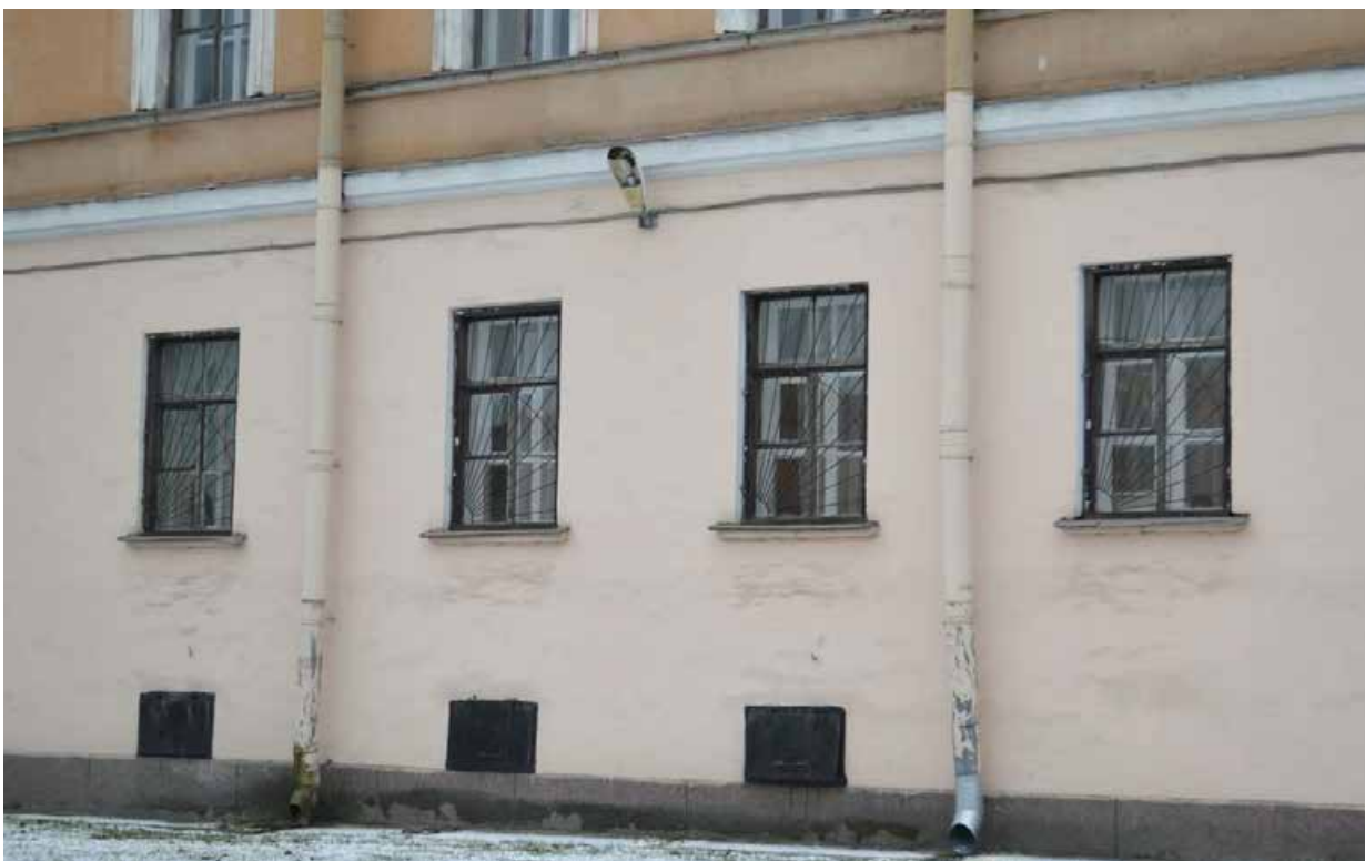
Фото 1.11. Духовная академия. Главное здание (наб. Обводного канала, 7, литер Г). Северный фасад. Оконные проёмы в уровне первого этажа. Фрагмент. Съёмка 01.12.2021 г.
