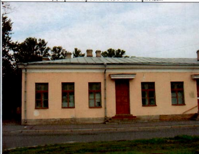
5. Южный фасад. Общий вид.
