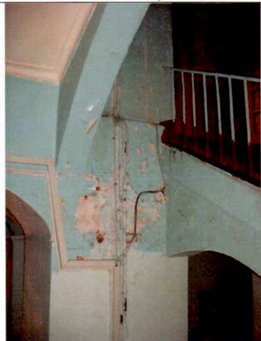
41. Лестница в южном крыле. Фрагмент.
