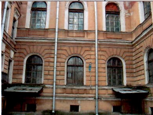
5. Восточный фасад. Фрагмент.
