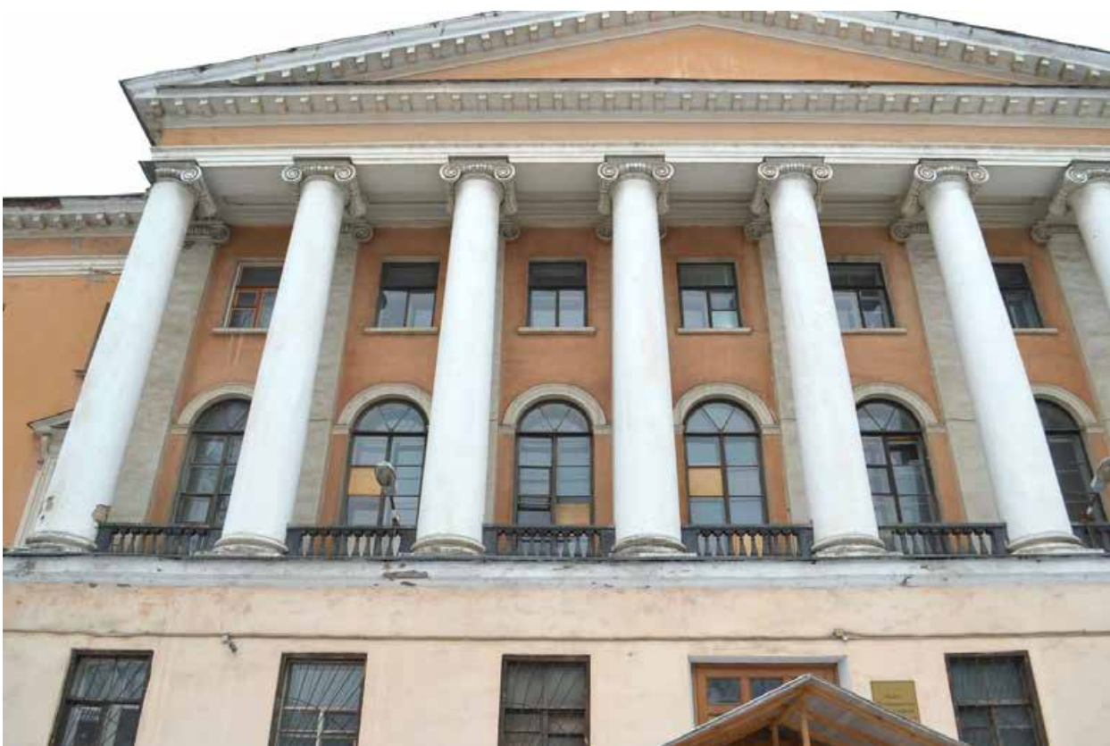
Фото 1.4. Духовная академия. Главное здание (наб. Обводного канала, 7, литер Г). Восточный фасад. Центральный ризалит с восьмиколонным портиком. Общий вид. Съёмка 01.12.2021 г.
