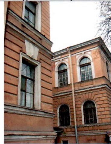
4. Восточный фасад. Фрагмент.
