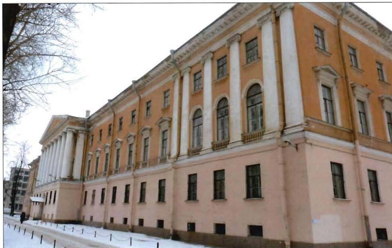
2. Объект культурного наследия. Восточный фасад. Вид с северо-востока.
