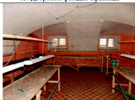
15. Помещение в уровне подвала. Общий вид.
