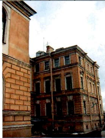
11. Западный фасад. Фрагмент.
