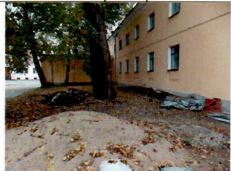
4. Восточный фасад. Фрагмент.
