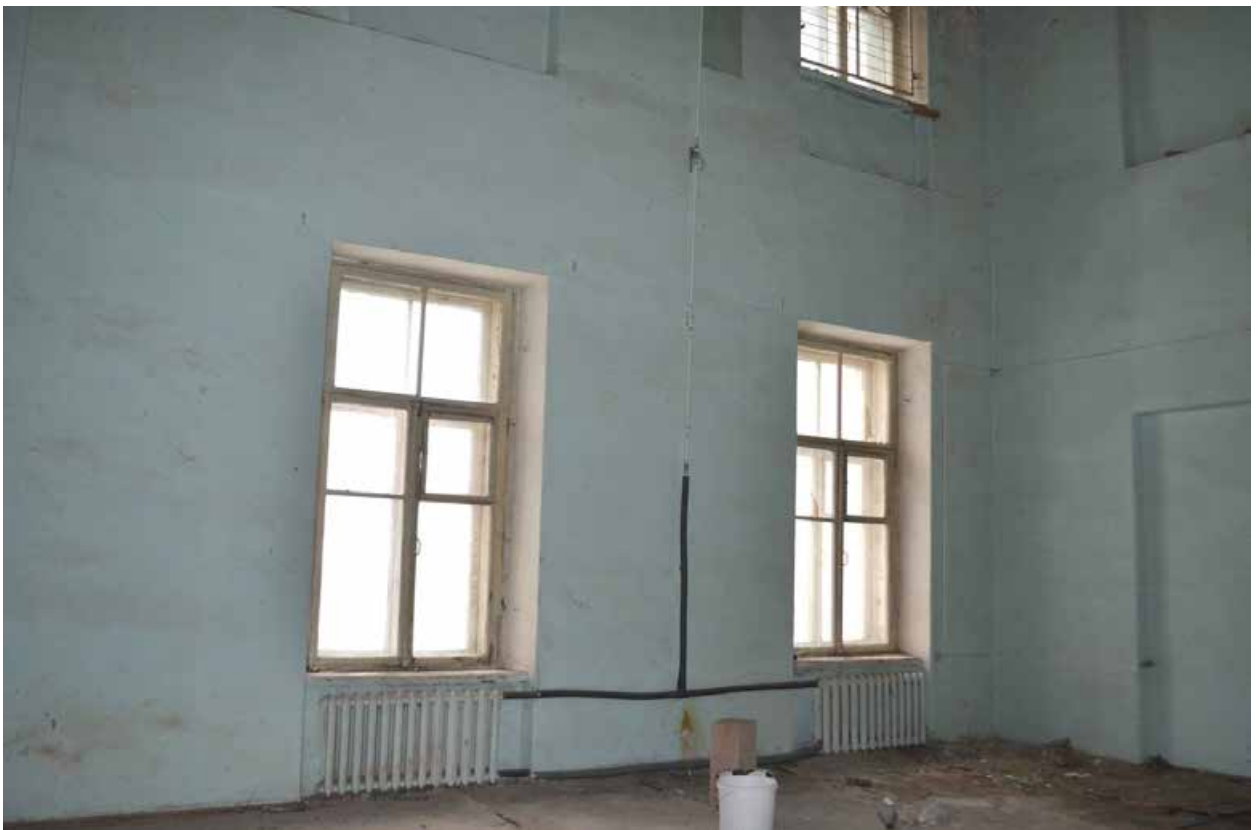
Фото 1.29. Духовная академия. Главное здание (наб. Обводного канала, 7, литер Г). Помещение второго этажа. Фрагмент. Съёмка 01.12.2021 г.
