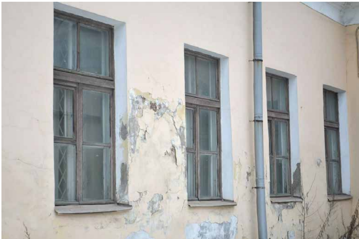
Фото 2.16. Духовная академия. Больничный флигель (наб. Обводного канала, 7, литер А). Западный фасад. Оконные проёмы в уровне первого этажа. Фрагмент. Съёмка 01.12.2021 г.
