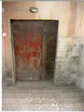
7. Входной проем восточного фасада. Общий вид.
