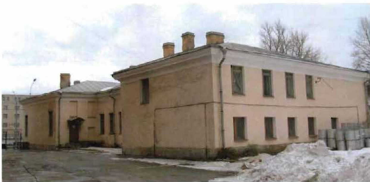
2. Общий вид с северо-востока. Дворовые фасады.
