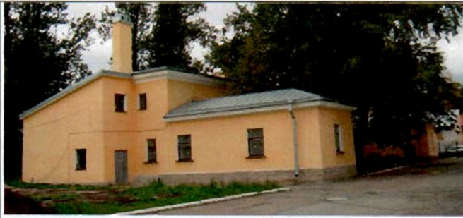
1. Южный фасад. Общий вид.
