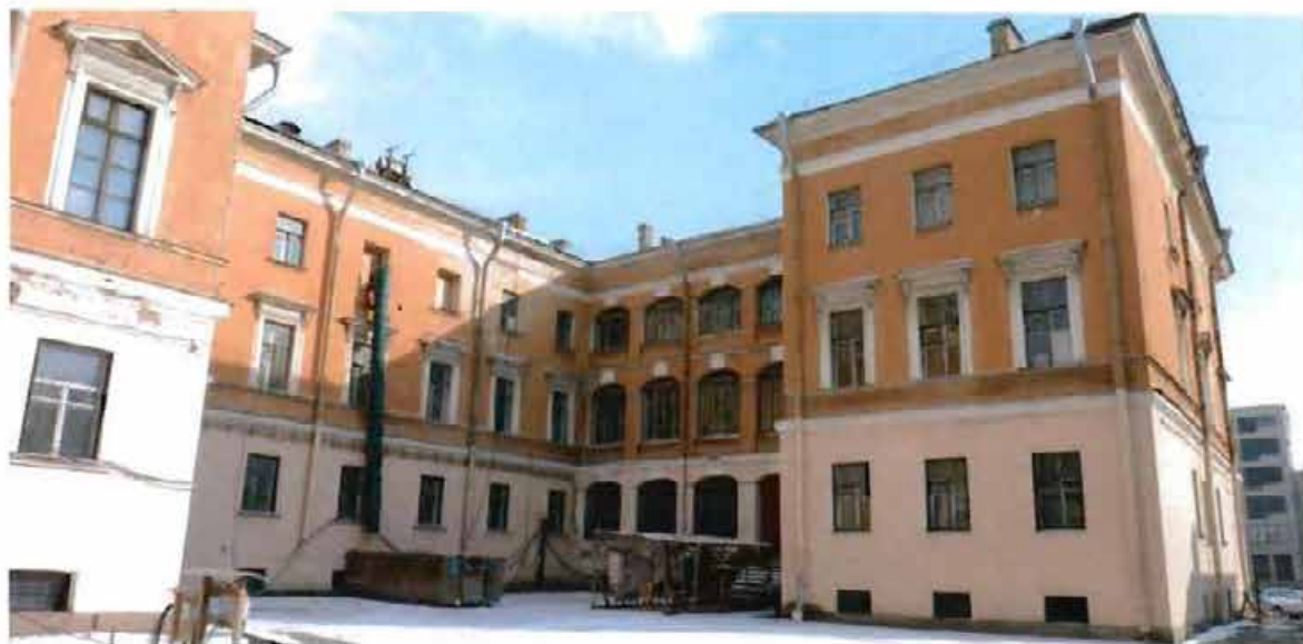
6. Объект культурного наследия. Дворовые фасады. Южный флигель. Вид с севера.
