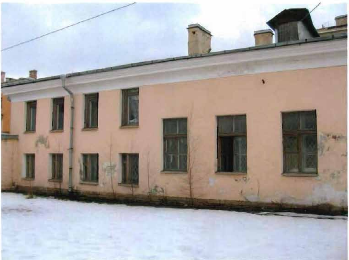
4. Фрагмент западного фасада. Вид с юго-запада.
