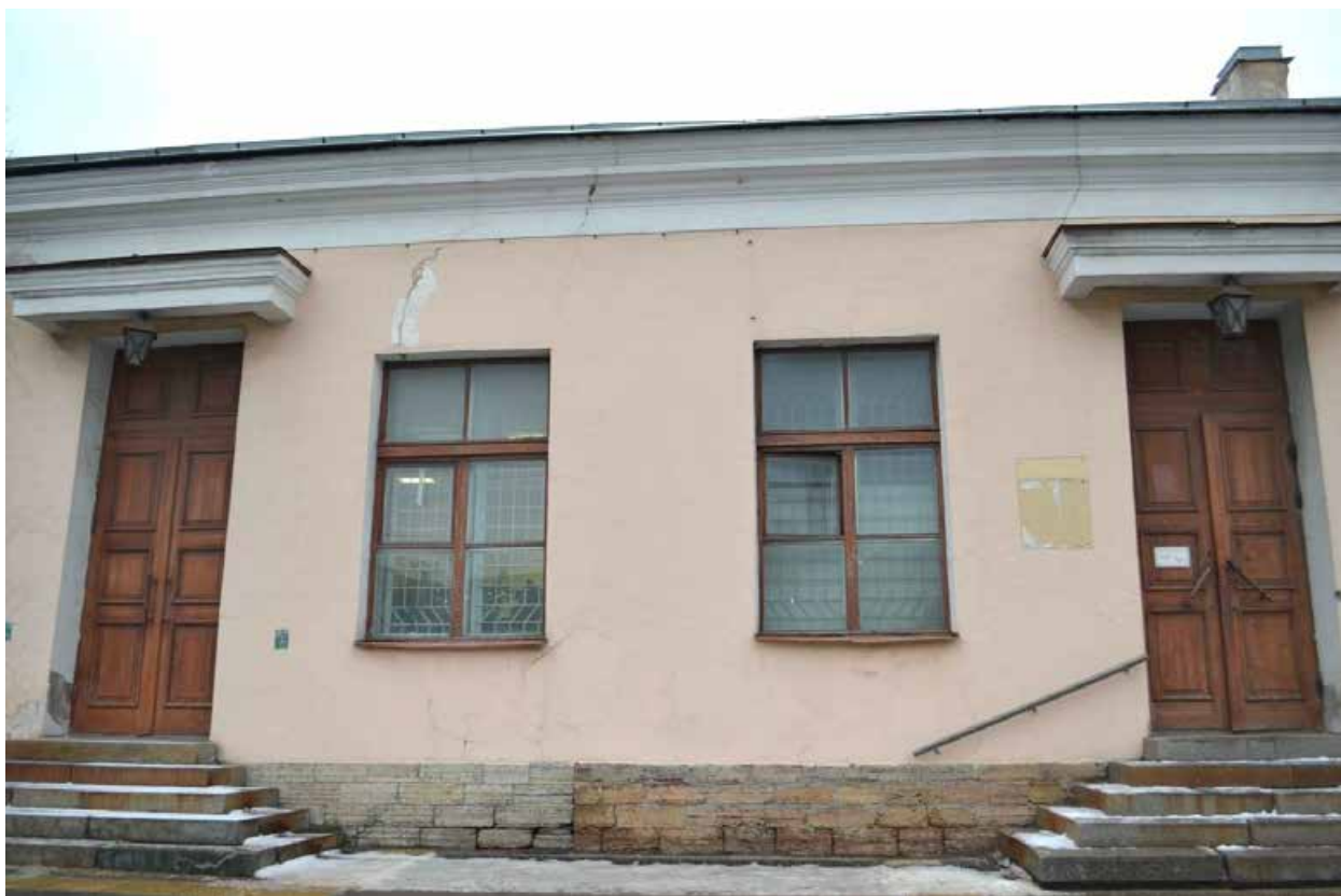
Фото 2.3. Духовная академия. Больничный флигель (наб. Обводного канала, 7, литер А). Южный фасад. Фрагмент. Съёмка 01.12.2021 г.
