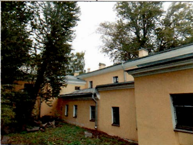
5. Западный фасад. Общий вид.
