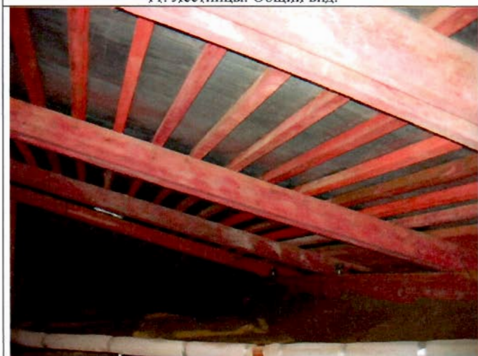
13. Конструкции крыши. Общий вид.
