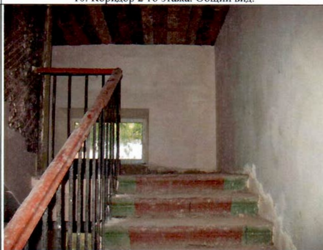
12. Лестницы. Общий вид.
