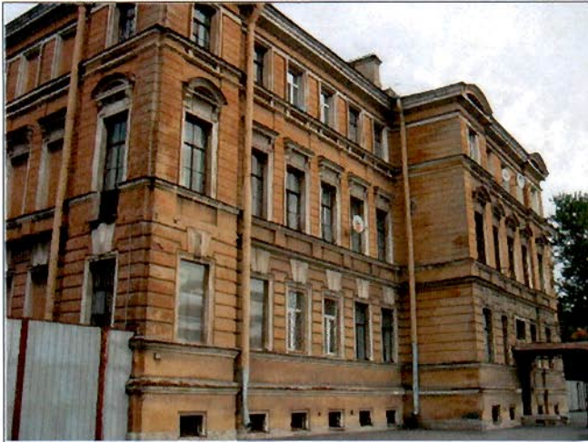
1. Южный фасад. Общий вид.
