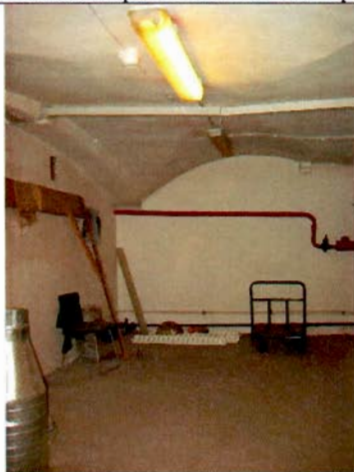
25. Помещение подвала. Общий вид.
