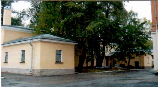
3. Восточный фасад. Общий вид
