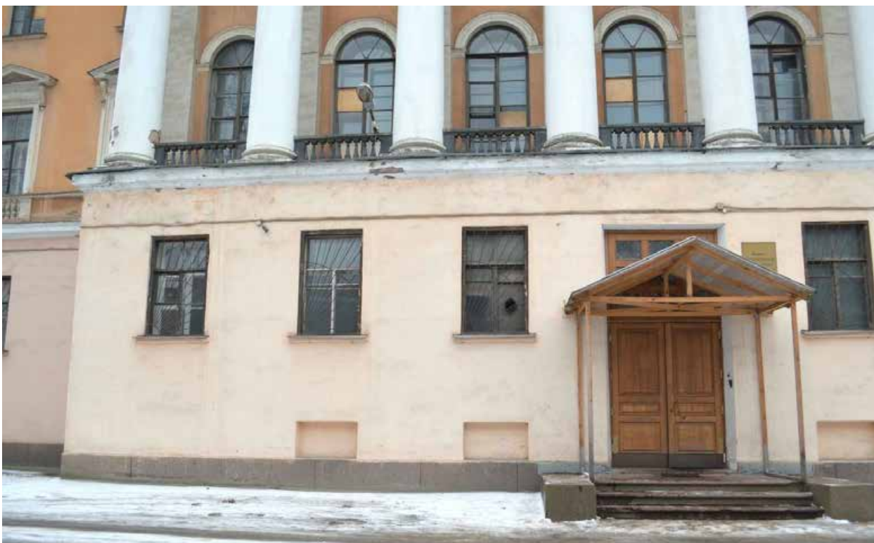
Фото 1.5. Духовная академия. Главное здание (наб. Обводного канала, 7, литер Г). Восточный фасад. Центральное крыльцо. Оконные проёмы в уровне первого и второго этажей. Фрагмент. Съёмка 01.12.2021 г.
