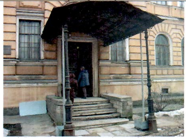
10. Входная группа северного фасада. Общий вид.
