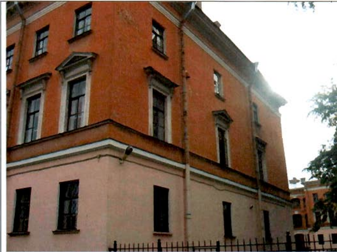
8. Западный торцевой фасад северного флигеля. Общий вид.
