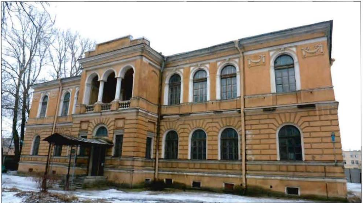
4. Объект культурного наследия. Северный фасад.
