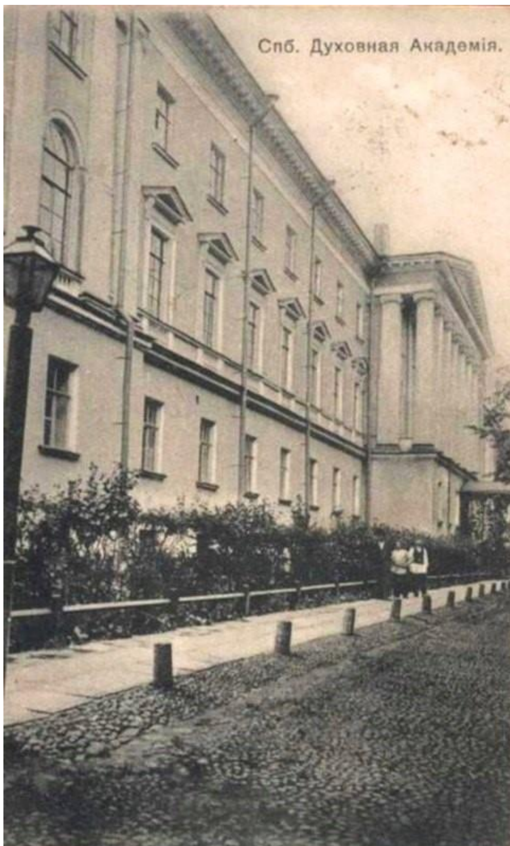
Илл. 20. Главный фасад здания Духовной Академии. 1900-е гг.
