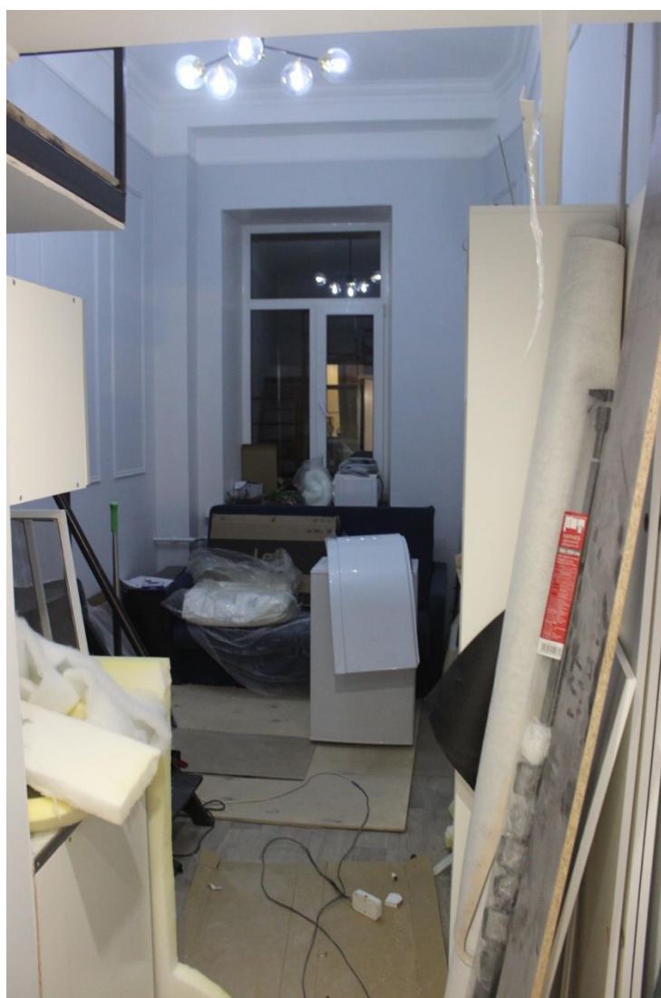
12. Здание по адресу: Санкт-Петербург, улица Чехова, д.3, Лит. А. Интерьеры помещения квартиры №6
