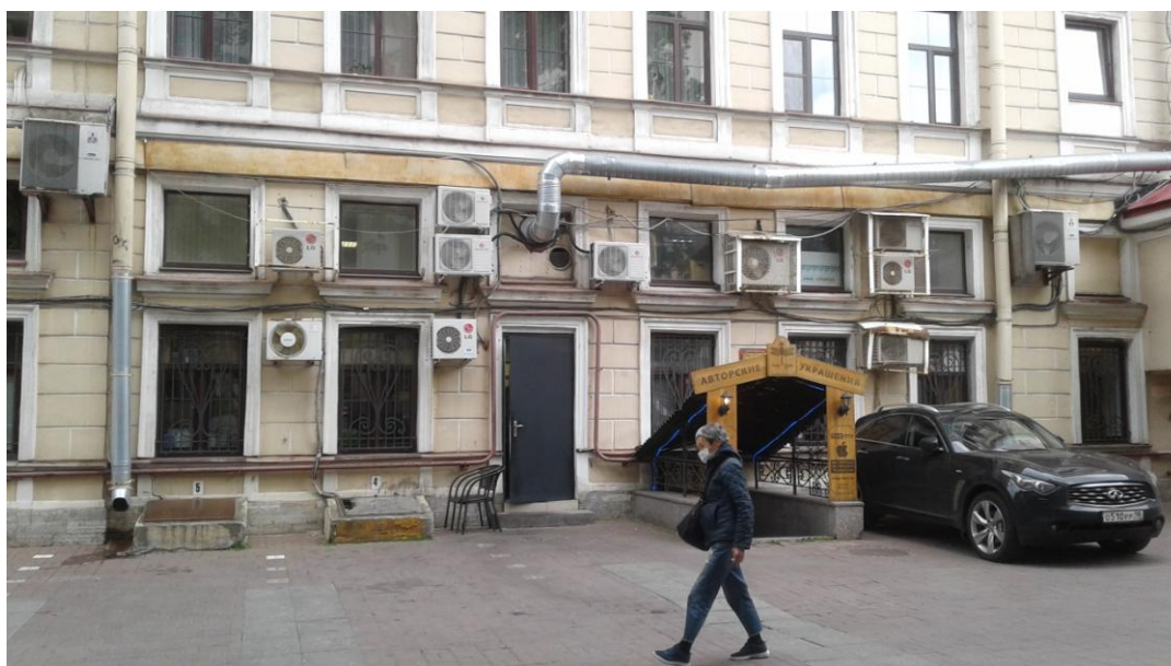
6. Выявленный объект культурного наследия «Дома немецкой лютеранской церкви св. Петра» (Невский пр., 22-24). Дом № 7 по Малой Конюшенной улице. Дворовыйц фасад. Вход в помещение 34-Н. Дверное заполнение (позднее).
