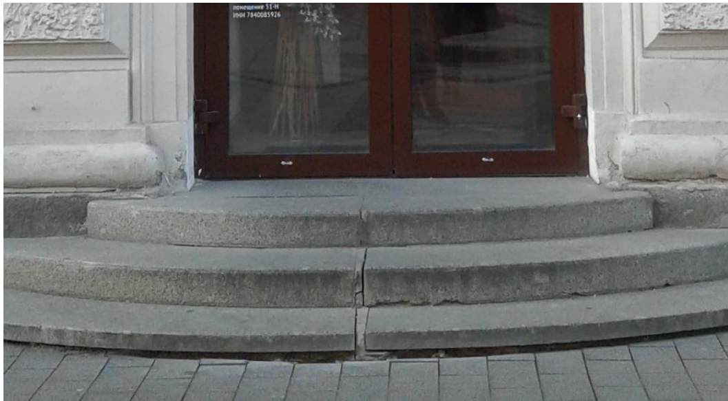
4. Выявленный объект культурного наследия «Дома немецкой лютеранской церкви св. Петра» (Невский пр., 22-24). Дом № 7 по Малой Конюшенной улице. Главный фасад. Вход (главный вход) в помещение 34-Н. Крыльцо (позднее).
