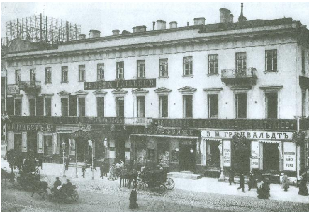
26. Фасад дома № 22 по Невскому проспекту. Фотография. Начало 1900-х гг.
