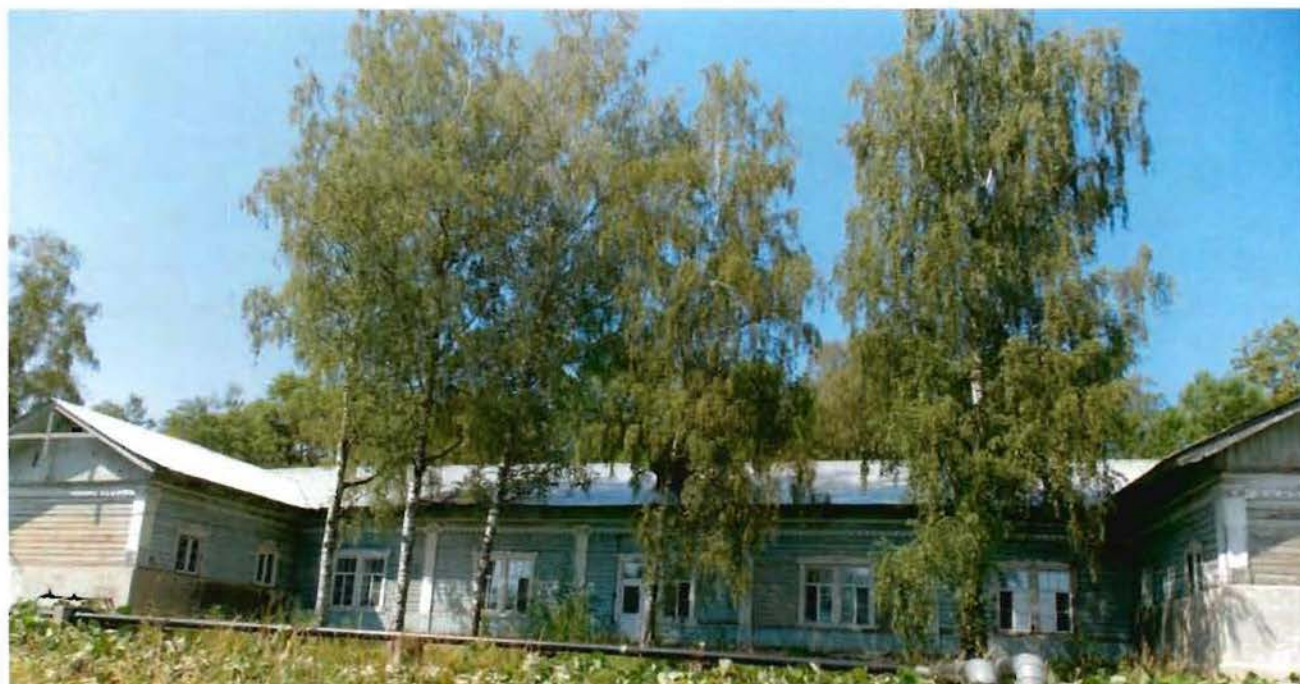
3. Общий вид (восточный фасад объекта культурного наследия, фрагмент)
