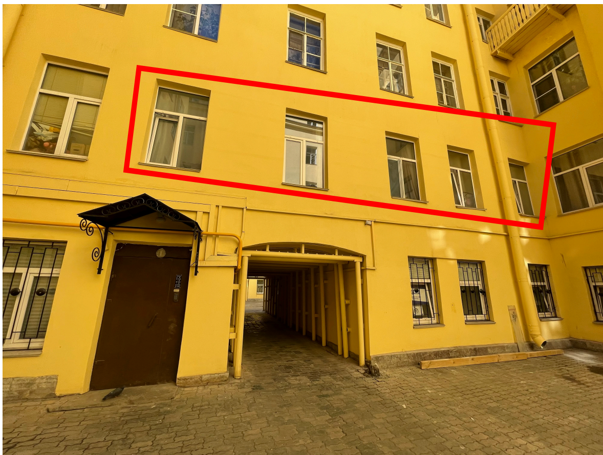
Фото 4. Оконные проемы квартиры № 34. Дворовый фасад.
