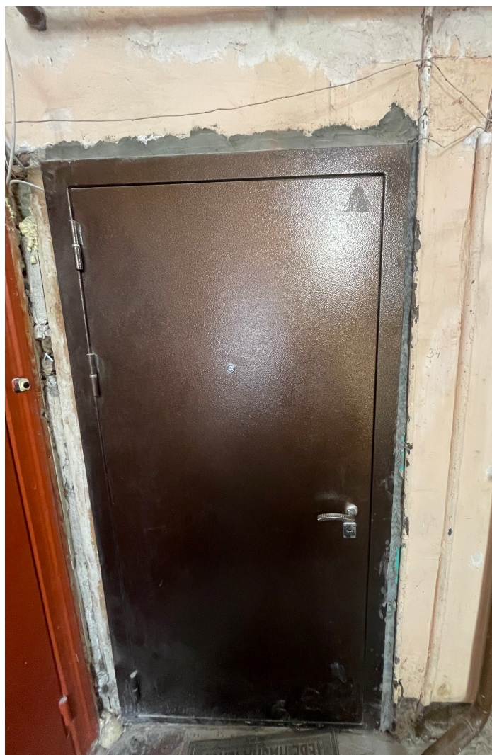
Фото 5. Дверной проем квартиры № 34.
