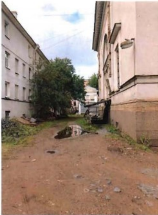
22. Фрагмент территории объекта культурного наследия со стороны юго-восточного фасада церкви.
