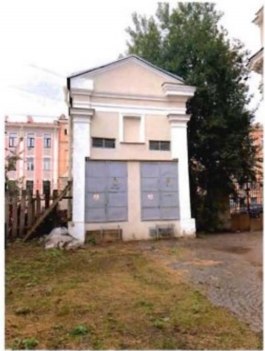
14. Северо-восточный фасад юго-восточной Часовни.
