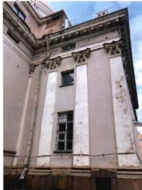
4. Фрагмент юго-восточного фасада объекта культурного наследия.
