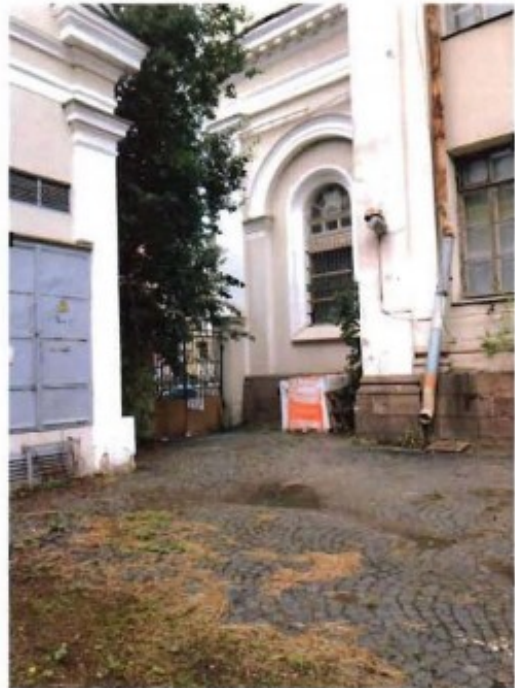
23. Фрагмент территории объекта культурного наследия со стороны юго-восточного фасада церкви.
