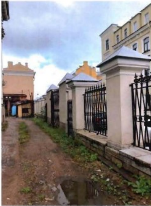
16. Фрагмент ограды вдоль Тучкова переулка. Юго-западный фасад.
