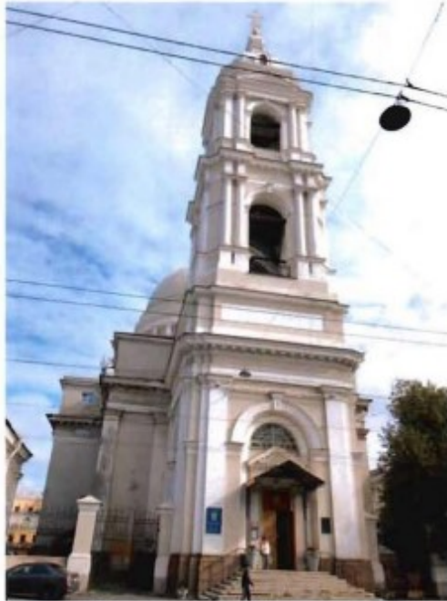
1. Юго-западный фасад объекта культурного наследия.
