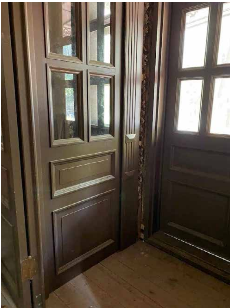
Фото 37. Помещение 1-Н(2). Тамбур главного входа.
