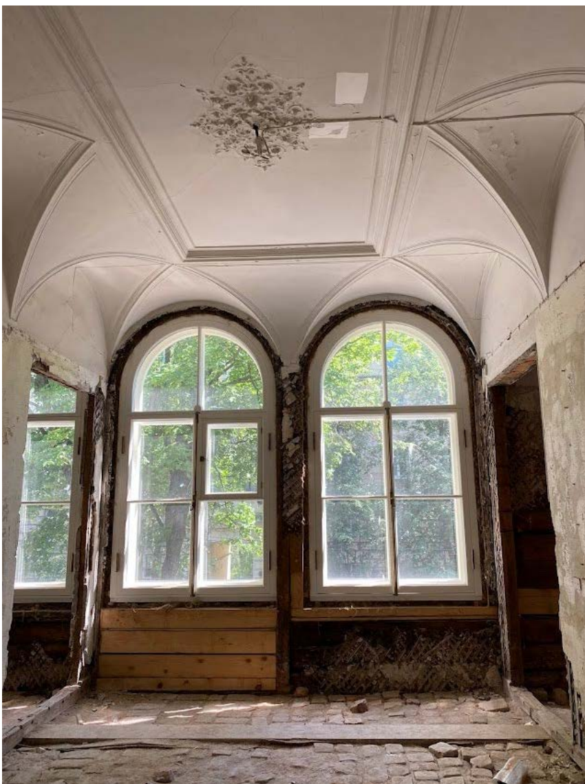
Фото 102. Помещение 1-Н(99). Оформление потолков.
