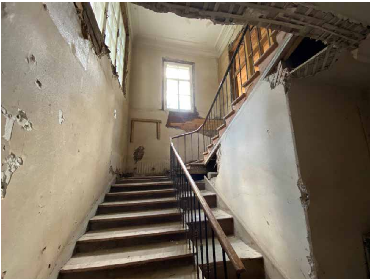
Фото 46. Лестничная клетка в западном объеме здания
