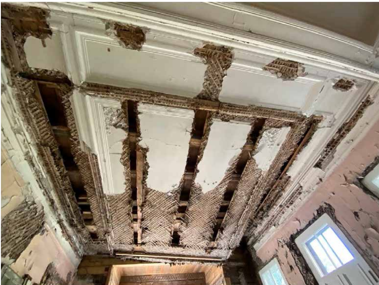
Фото 84. Оформление потолка. Помещение 1-Н(14).
