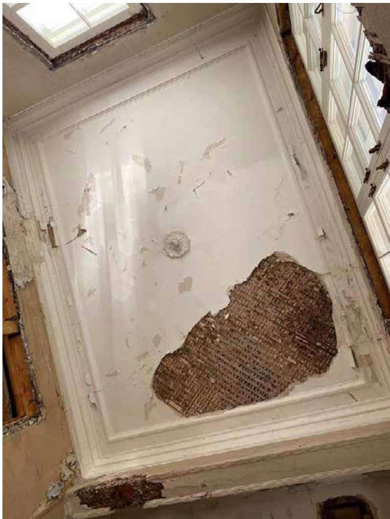
Фото 91. Оформление потолка помещений лестничной клетки в западном объеме здания
