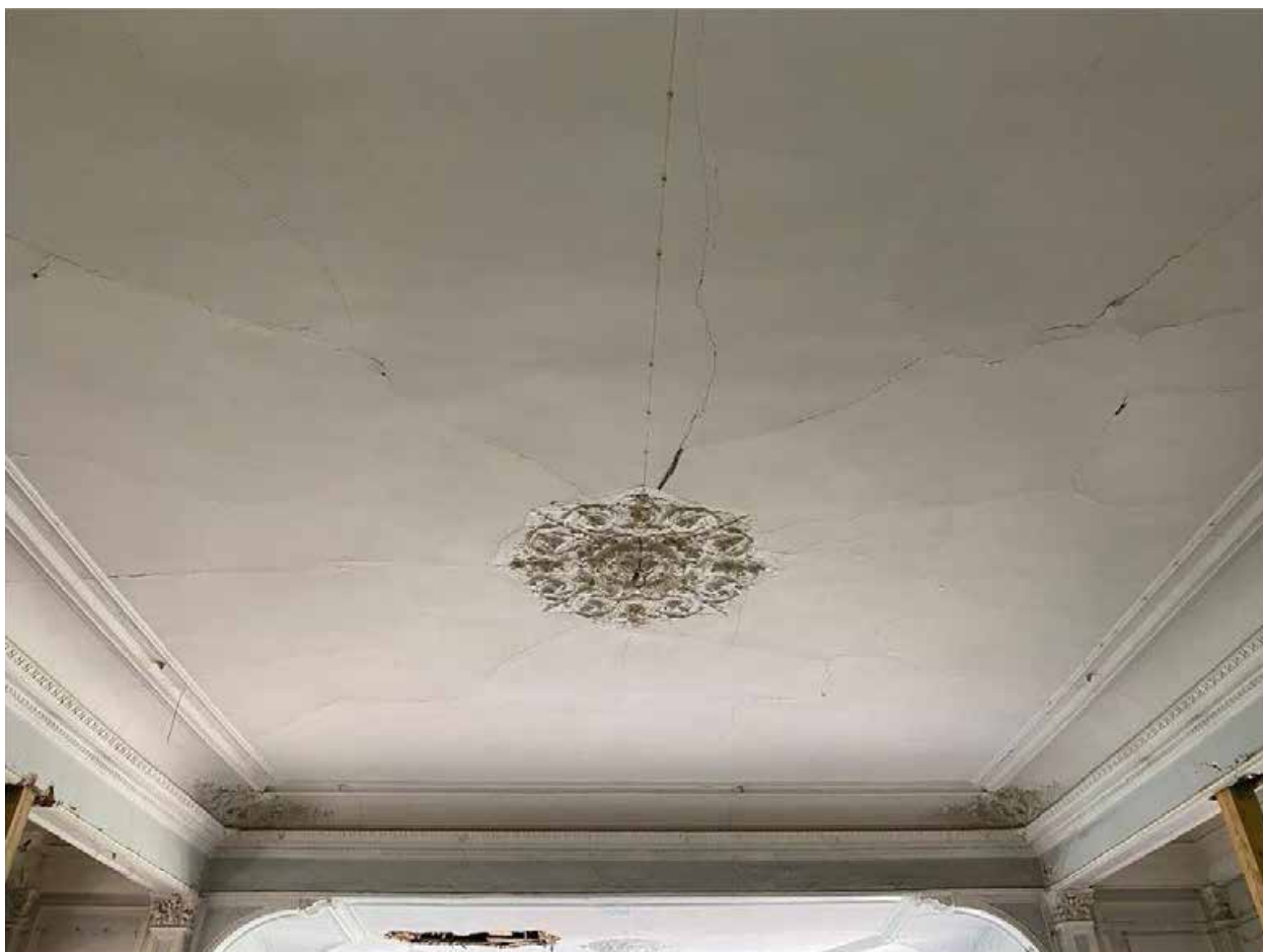
Фото 107. Оформление потолка. Помещение 1-Н(64).
