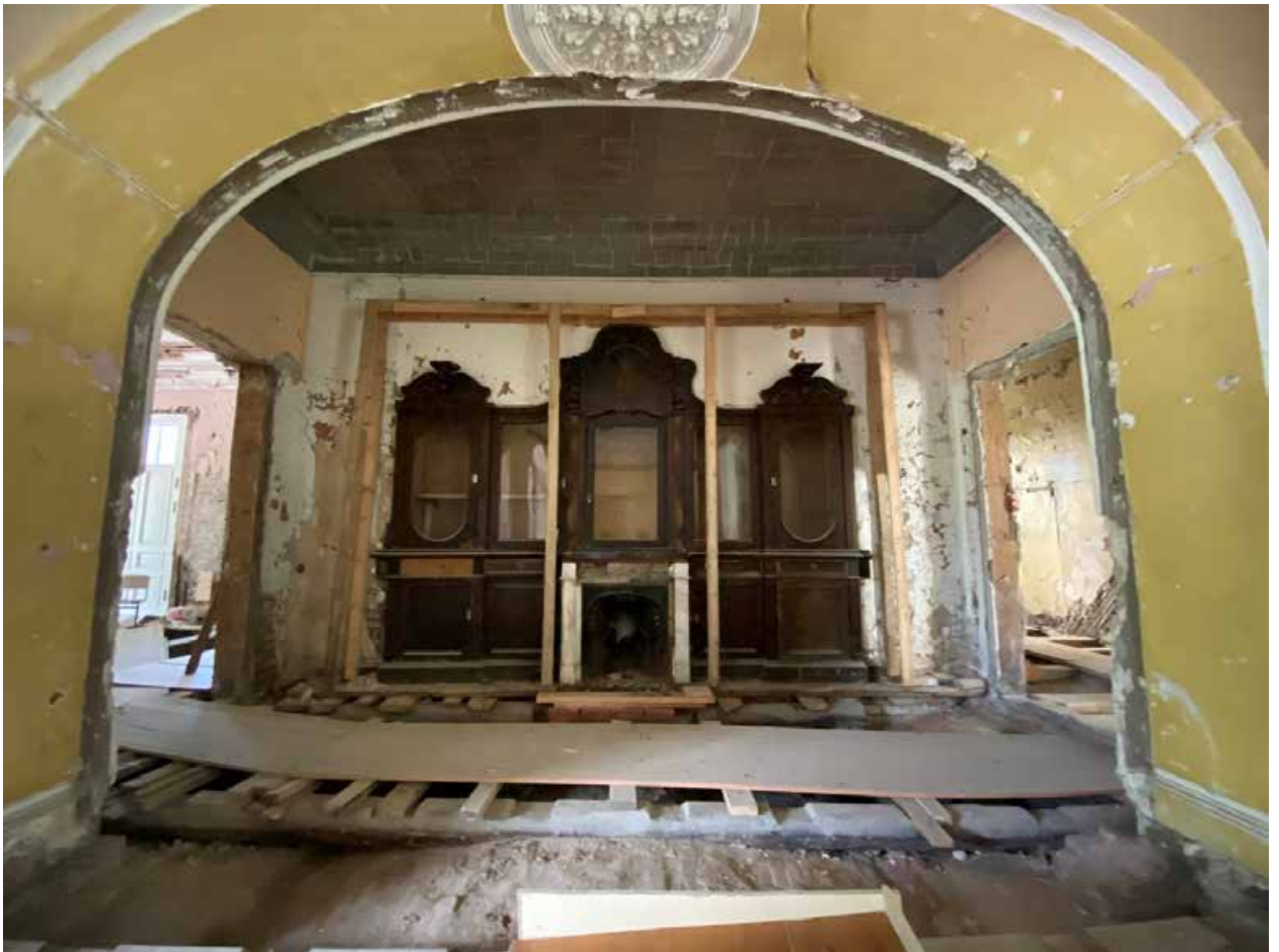
Фото 76. Встроенный шкаф. Помещение 1-Н(20).
