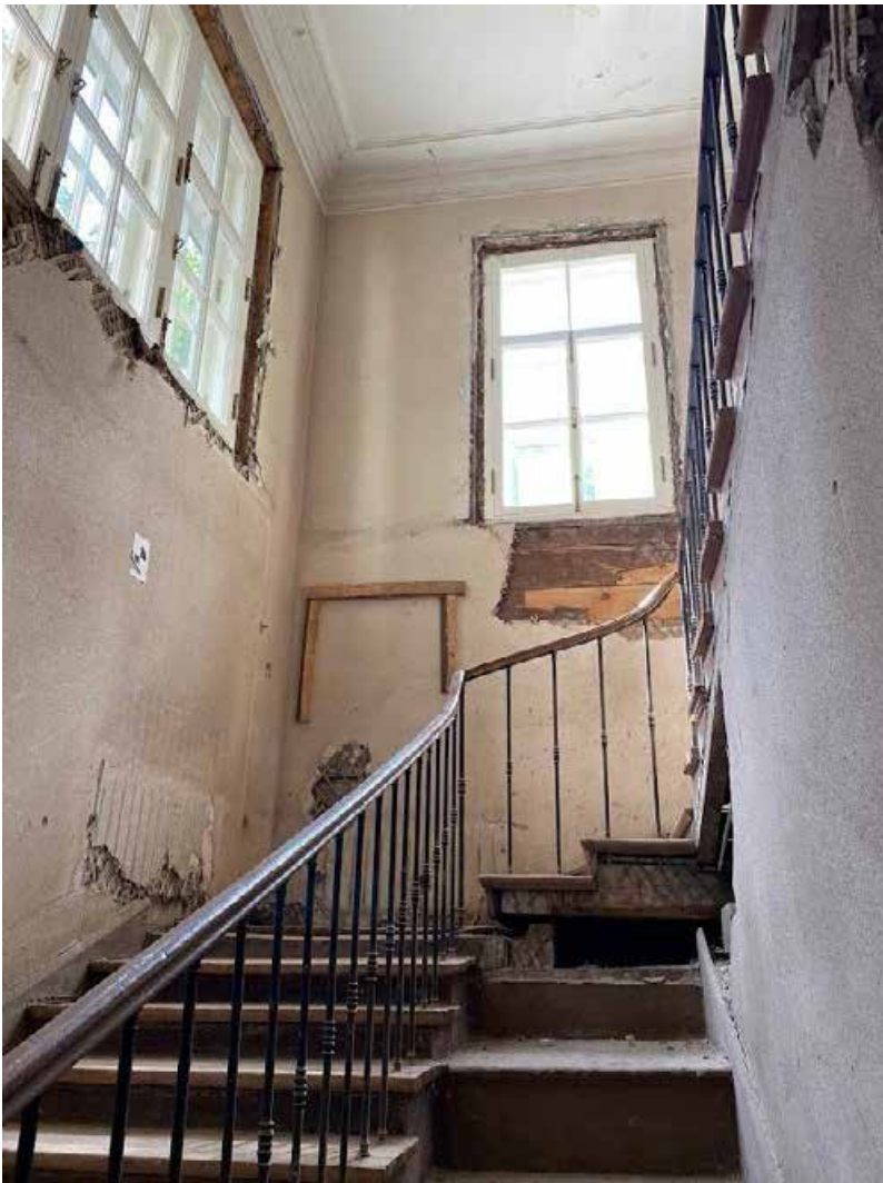
Фото 47. Лестничная клетка в западном объеме здания.
