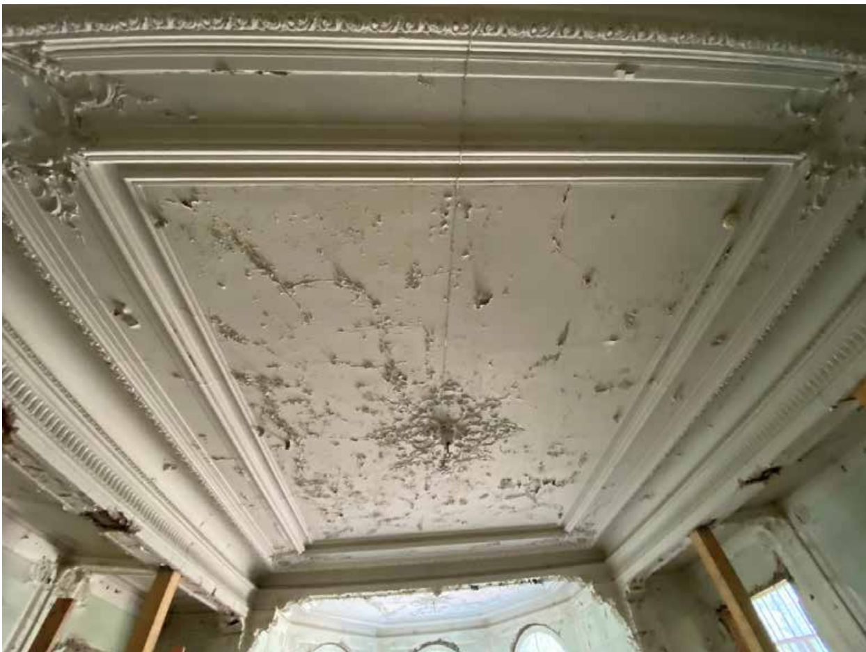
Фото 4. Оформление потолка. Помещение 1-Н(12).
