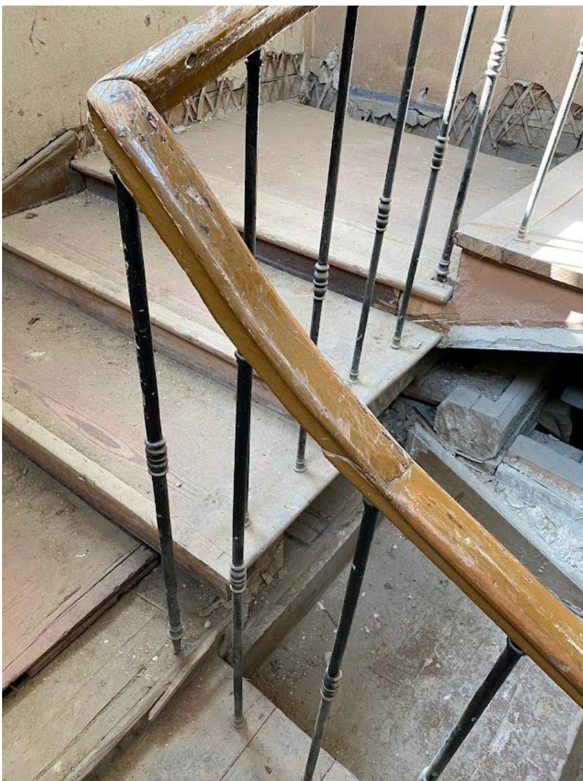
Фото 92. Лестничная клетка в западном объеме здания. Детали ограждения лестничных маршей.
