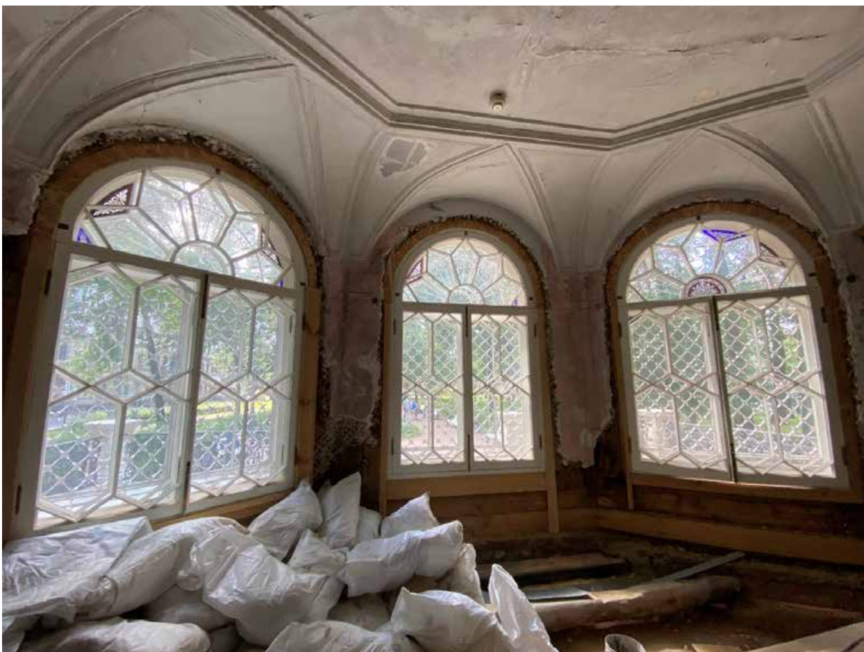
Фото 41. Оконные заполнения. Помещение 1-Н(9).
