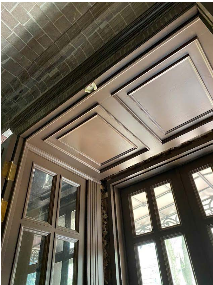
Фото 36. Помещение 1-Н(2). Тамбур главного входа.
