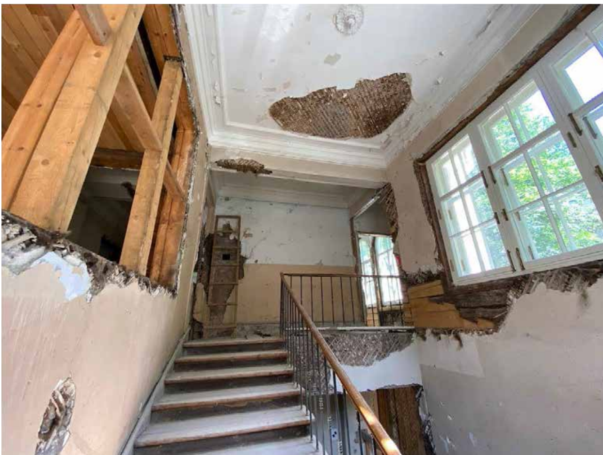
Фото 94. Лестничная клетка в западном объеме здания.
