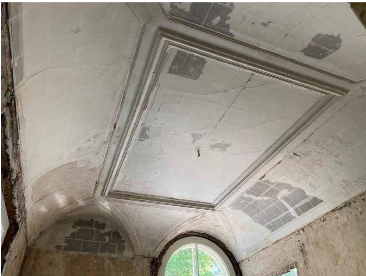
Фото 105. Оформление потолка. Помещение 1-Н(97).
