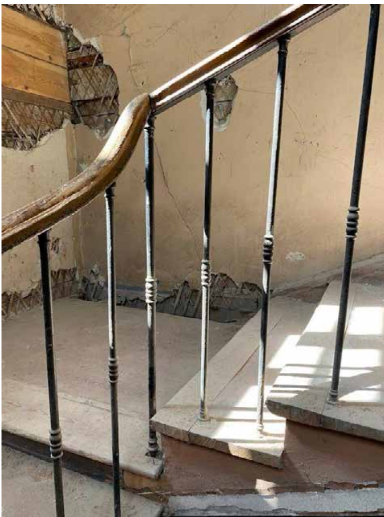
Фото 93. Лестничная клетка в западном объеме здания. Детали ограждения лестничных маршей.
