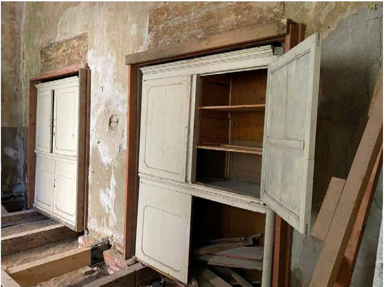
Фото 87. Встроенные шкафы. Помещение 1-Н(15).
