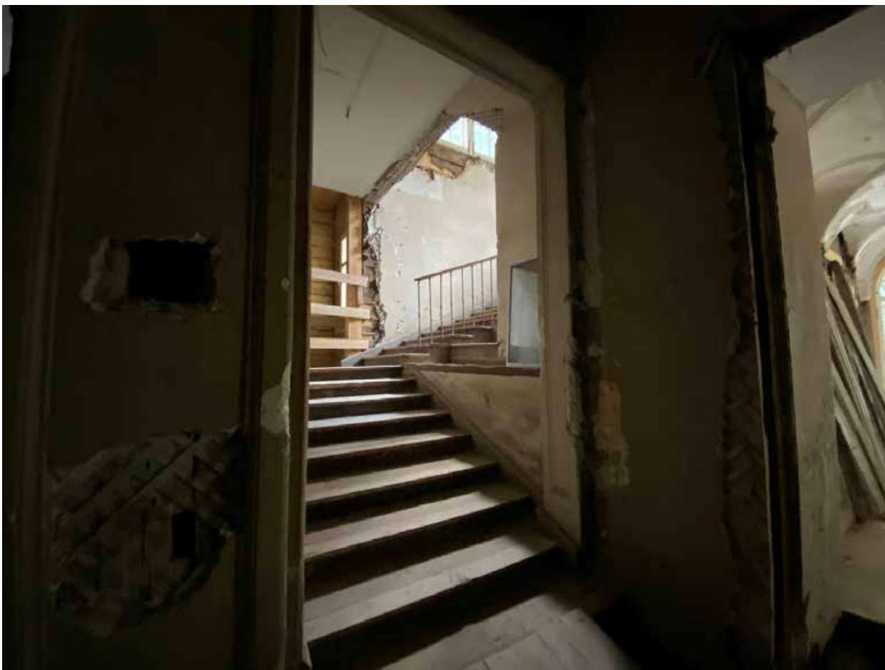
Фото 38. Лестничная клетка в западном объеме здания.
