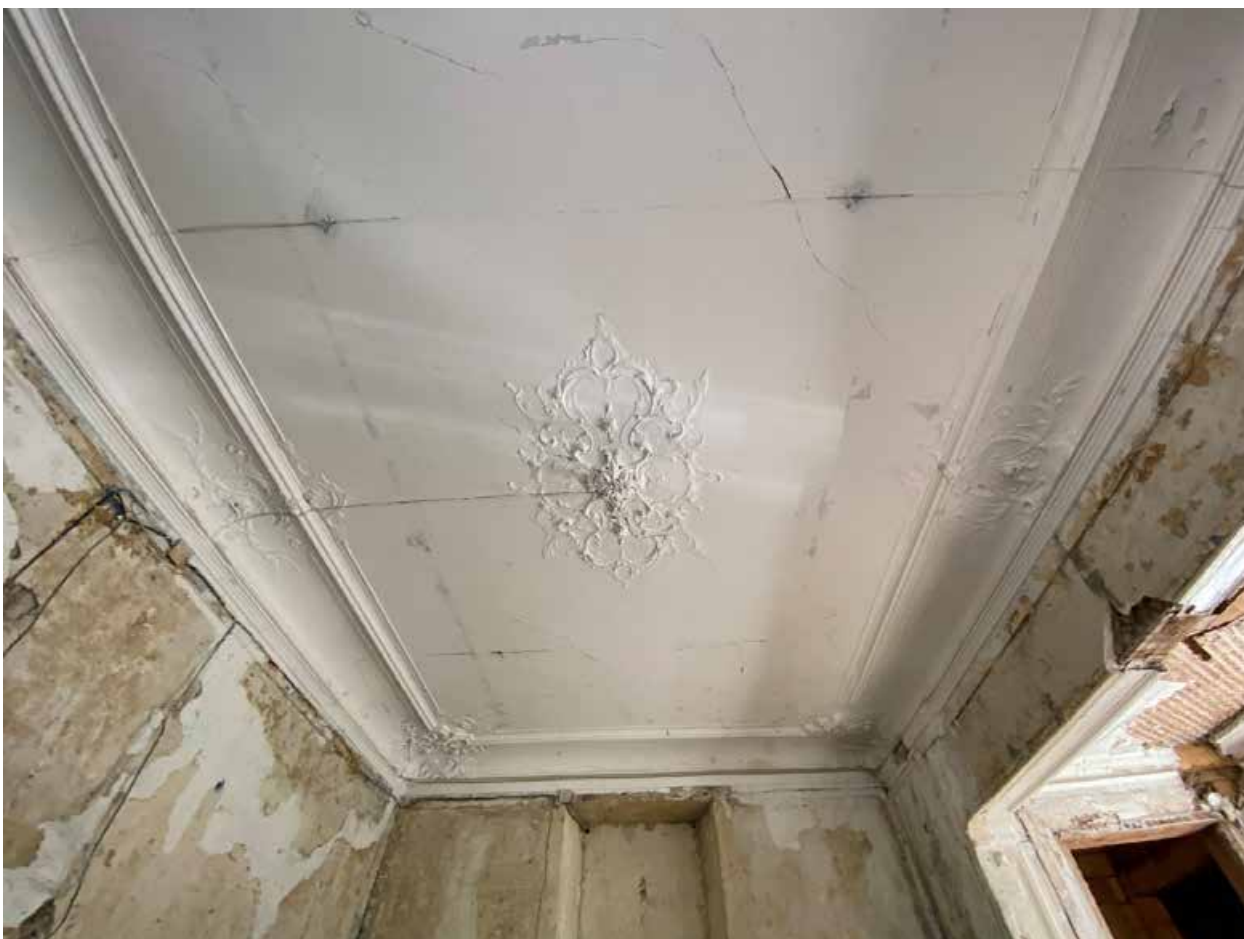
Фото 61. Оформление потолка. Помещение 1-Н(11).
