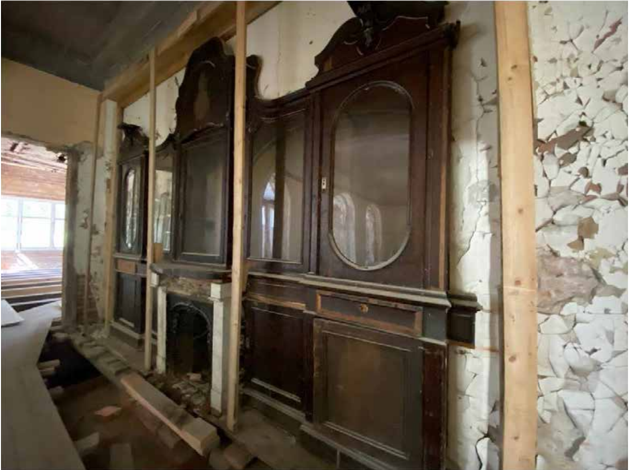
Фото 79. Встроенный шкаф. Помещение 1-Н(20).
