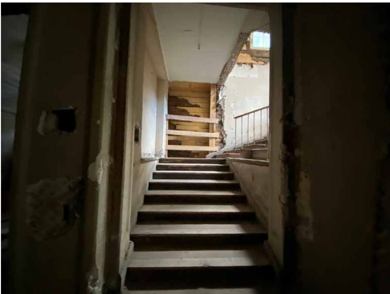
Фото 39. Лестничная клетка в западном объеме здания.
