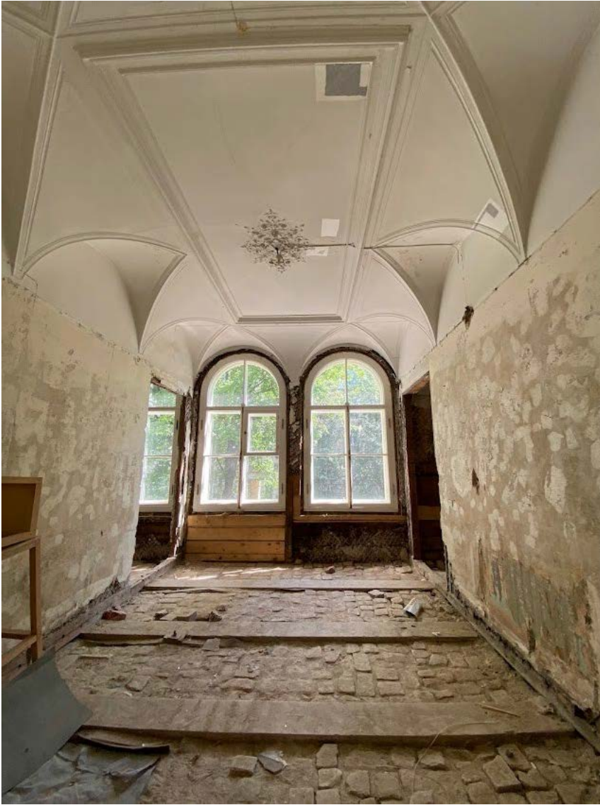
Фото 101. Помещение 1-Н(99). Оформление потолков.
