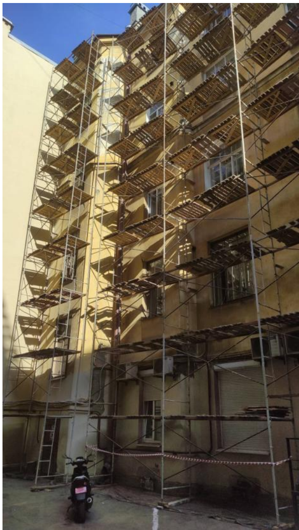
Фото 7. Фрагмент дворового фасада выявленного объекта культурного наследия «Дом Т.М. Любищевой»
