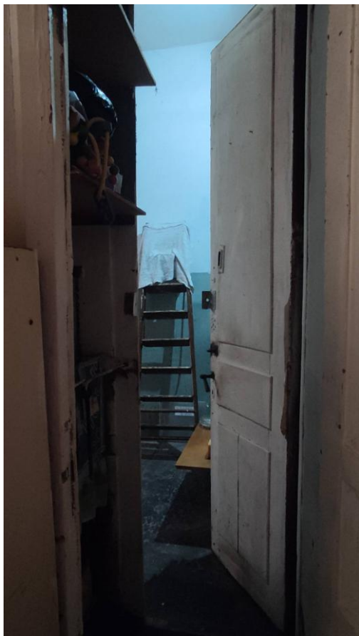
Фото 45. Интерьер квартиры №2, расположенной в выявленном объекте культурного наследия «Дом Т.М. Любищевой», ч.п.1, выход на лестничную площадку
