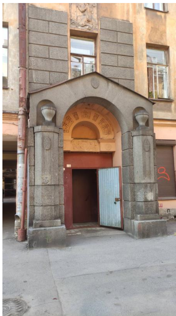
Фото 3. Входной портал выявленного объекта культурного наследия «Дом Т.М. Любищевой»
