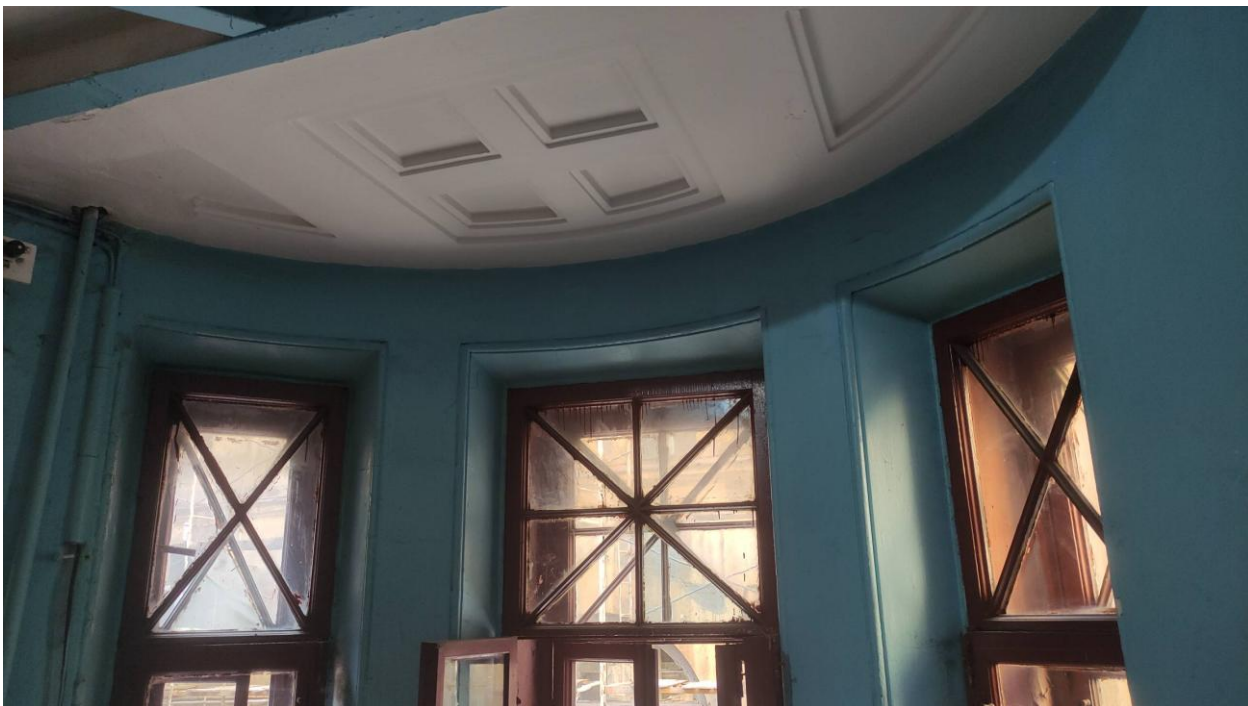
Фото 13. Оконные заполнения парадной лестничной клетки выявленного объекта культурного наследия «Дом Т.М. Любищевой»
