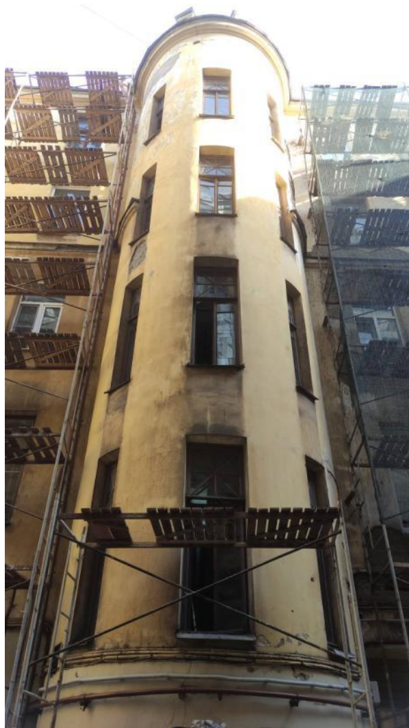
Фото 8. Фрагмент дворового фасада выявленного объекта культурного наследия «Дом Т.М. Любищевой», ризалит парадной лестничной клетки
