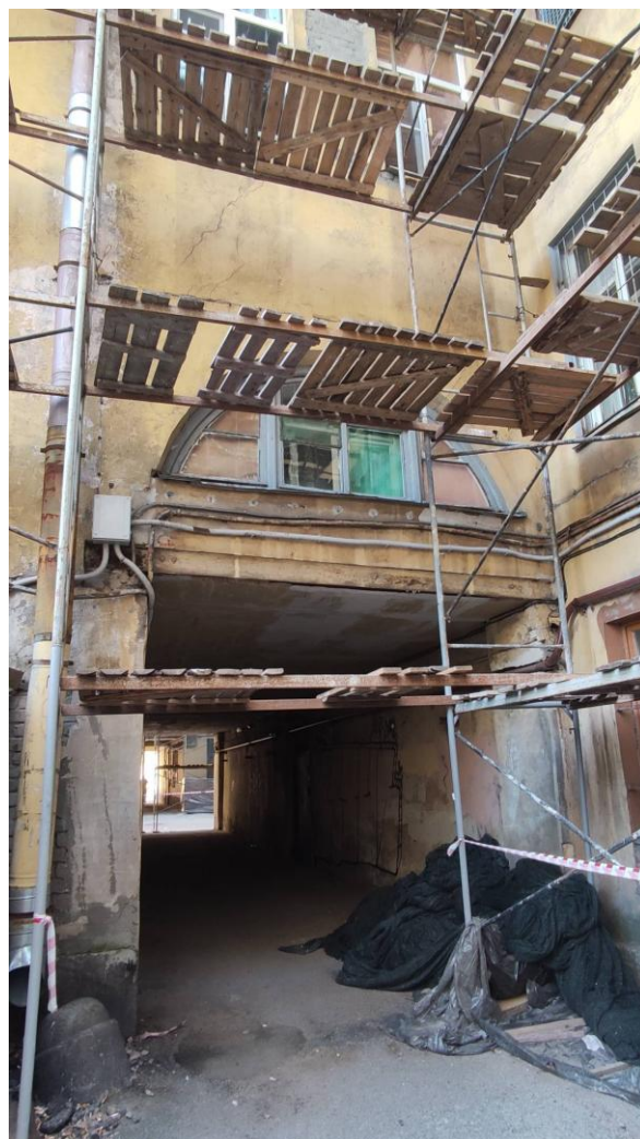
Фото 11. Воротный проезд лицевого корпуса выявленного объекта культурного наследия «Дом Т.М. Любичевой», вид со стороны двора
