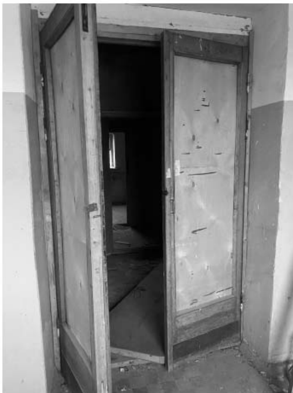
83. Вид на дверь в коридор;
