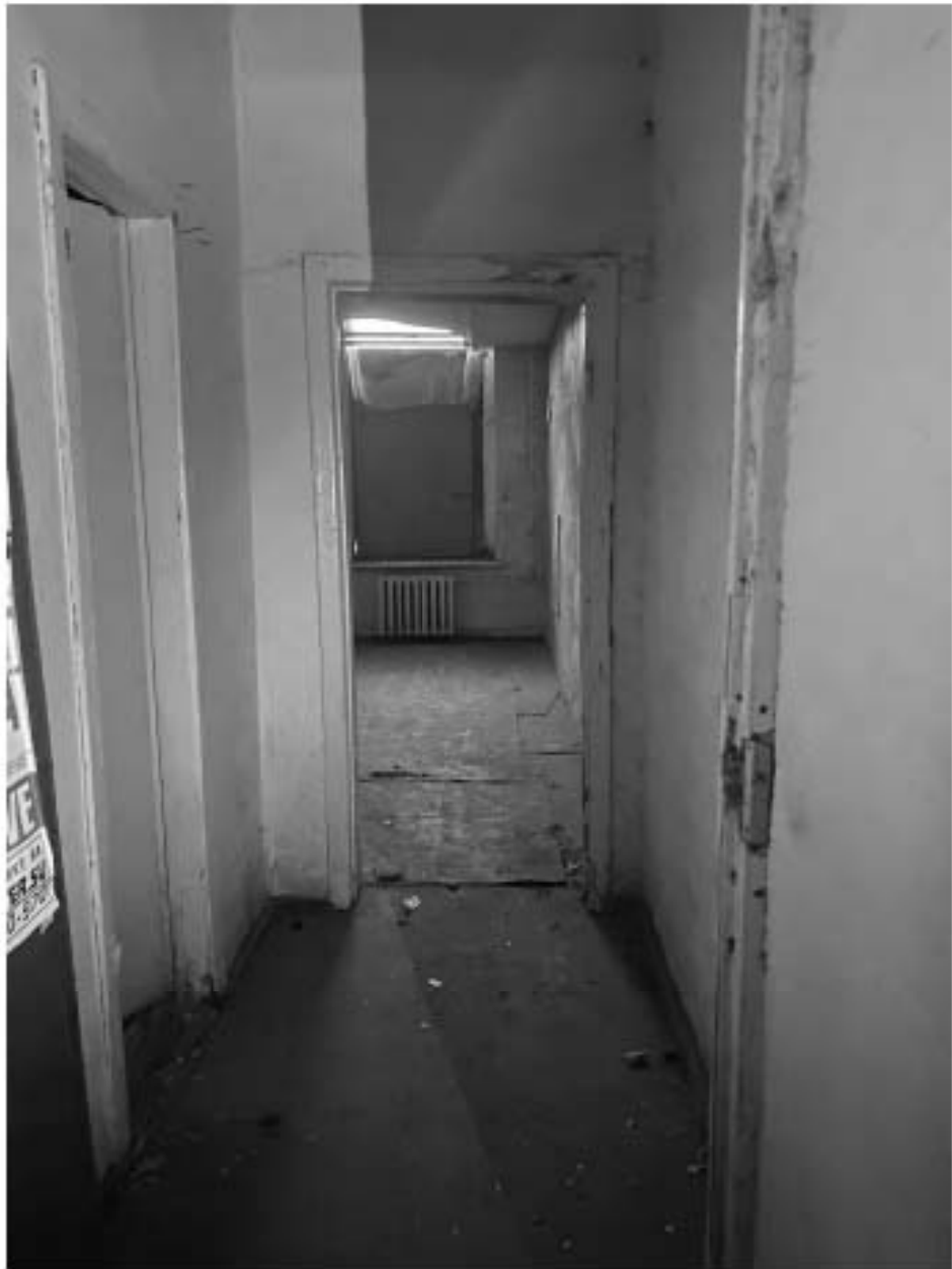
62. Помещение на втором этаже. Фрагмент интерьера;
