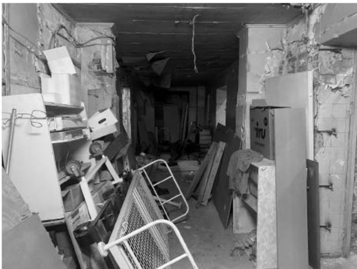
23. Фрагмент интерьера коридора;
