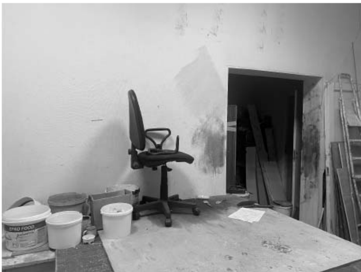
14. Помещение на первом этаже. Интерьер,
