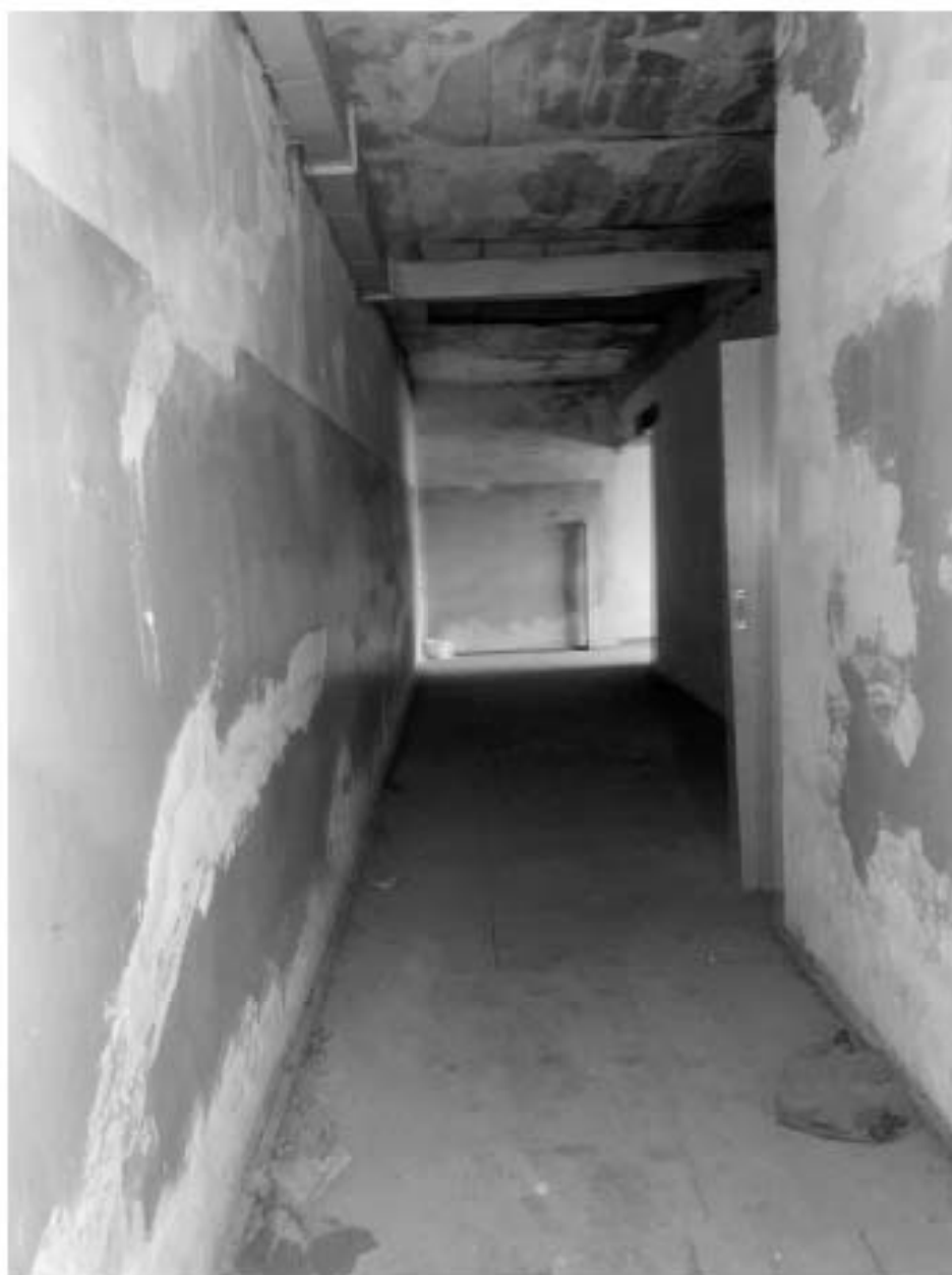
85. Фрагмент интерьера коридора на четвёртом этаже;
