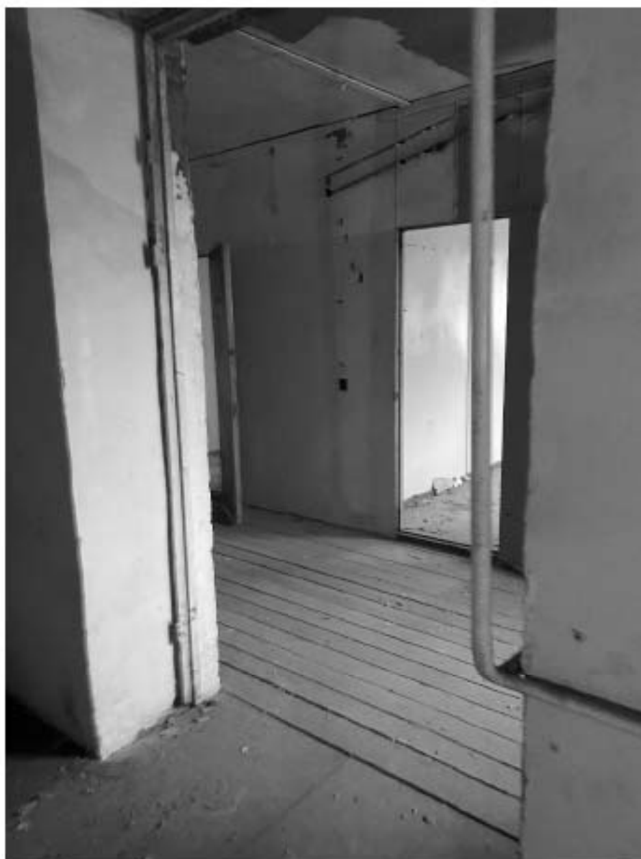
89. Фрагмент интерьера коридора;
