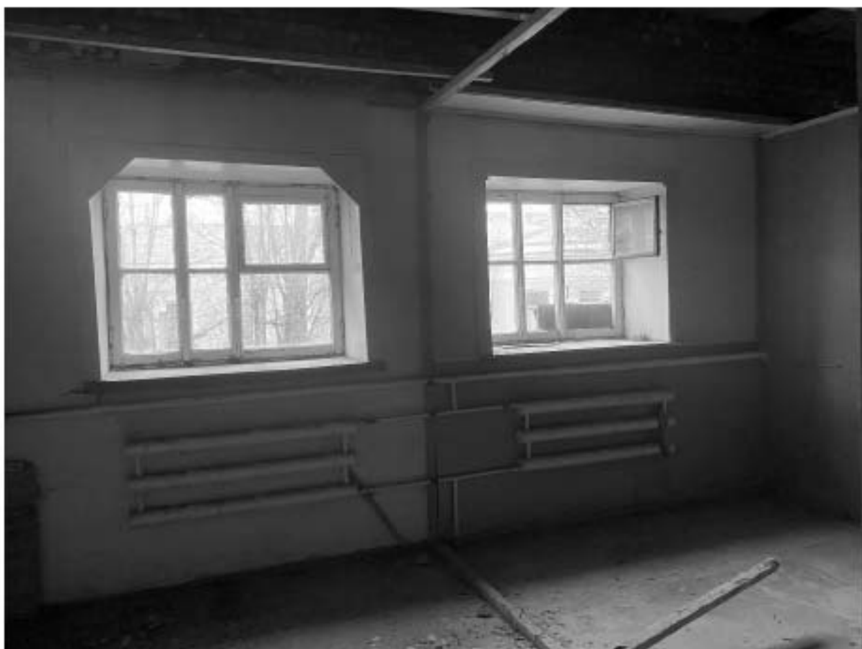
99. Помещение на четвёртом этаже. Фрагмент интерьера;
