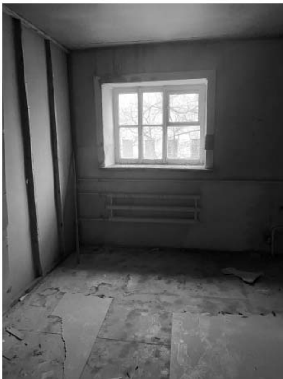
97. Помещение на четвёртом этаже. Фрагмент интерьера;
