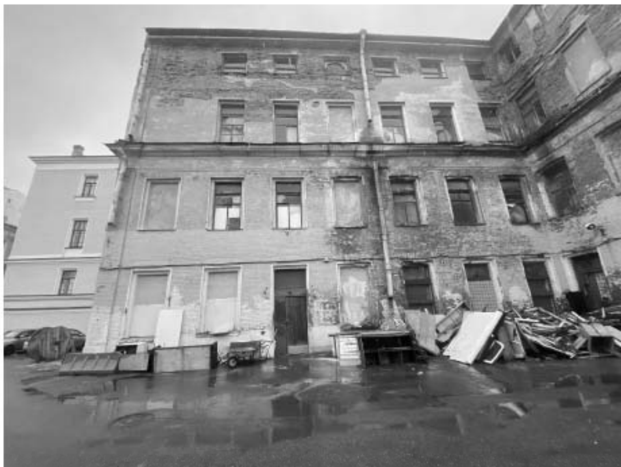
1. Вид на восточный фасад здания;
