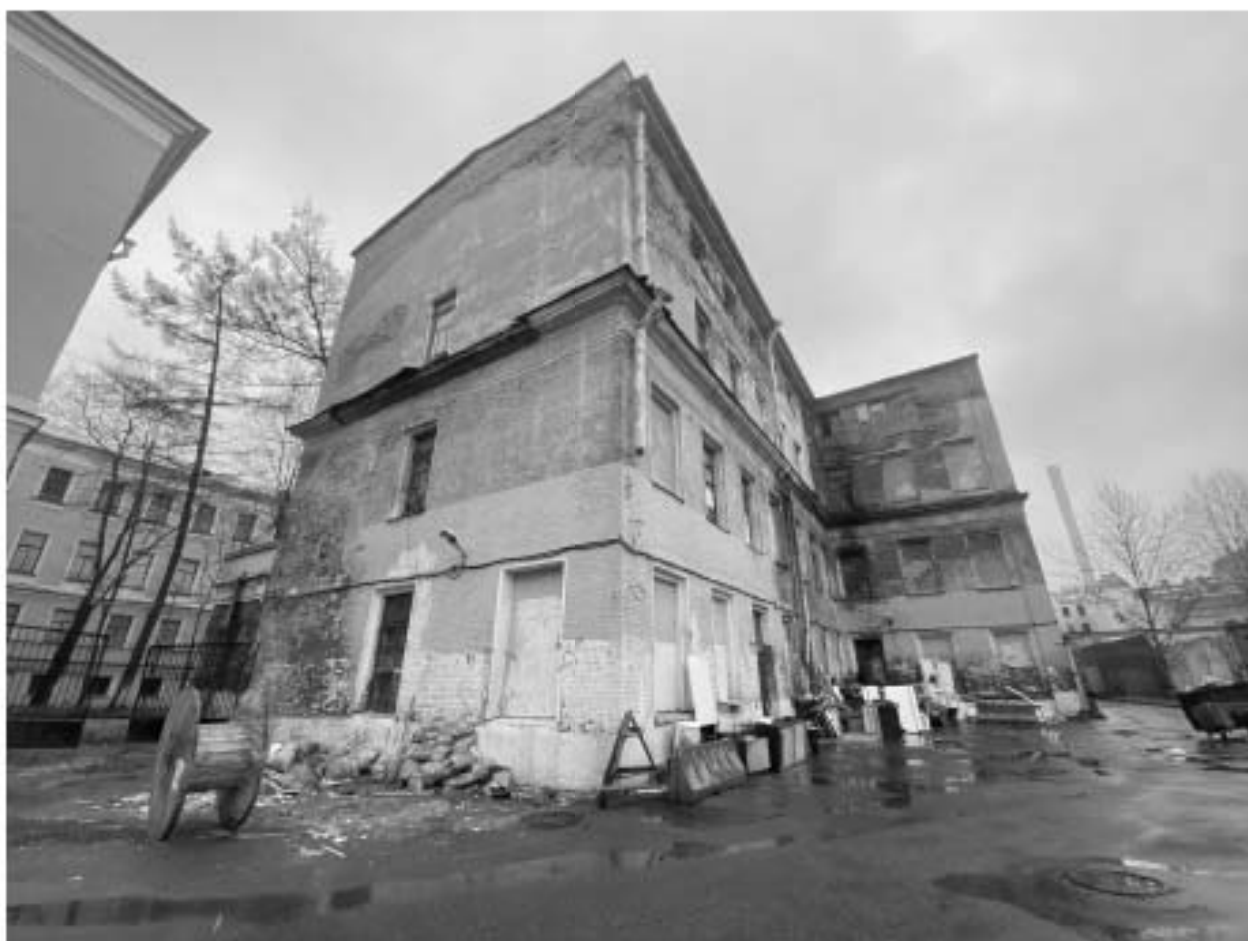
5. Общий вид на юго-восточный фасад здания,
