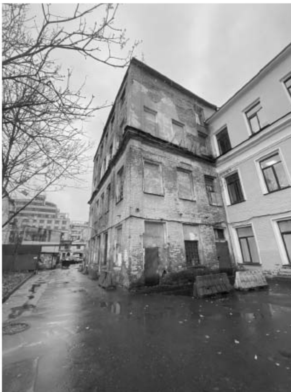
7. Общий вид на северный фасад здания;
