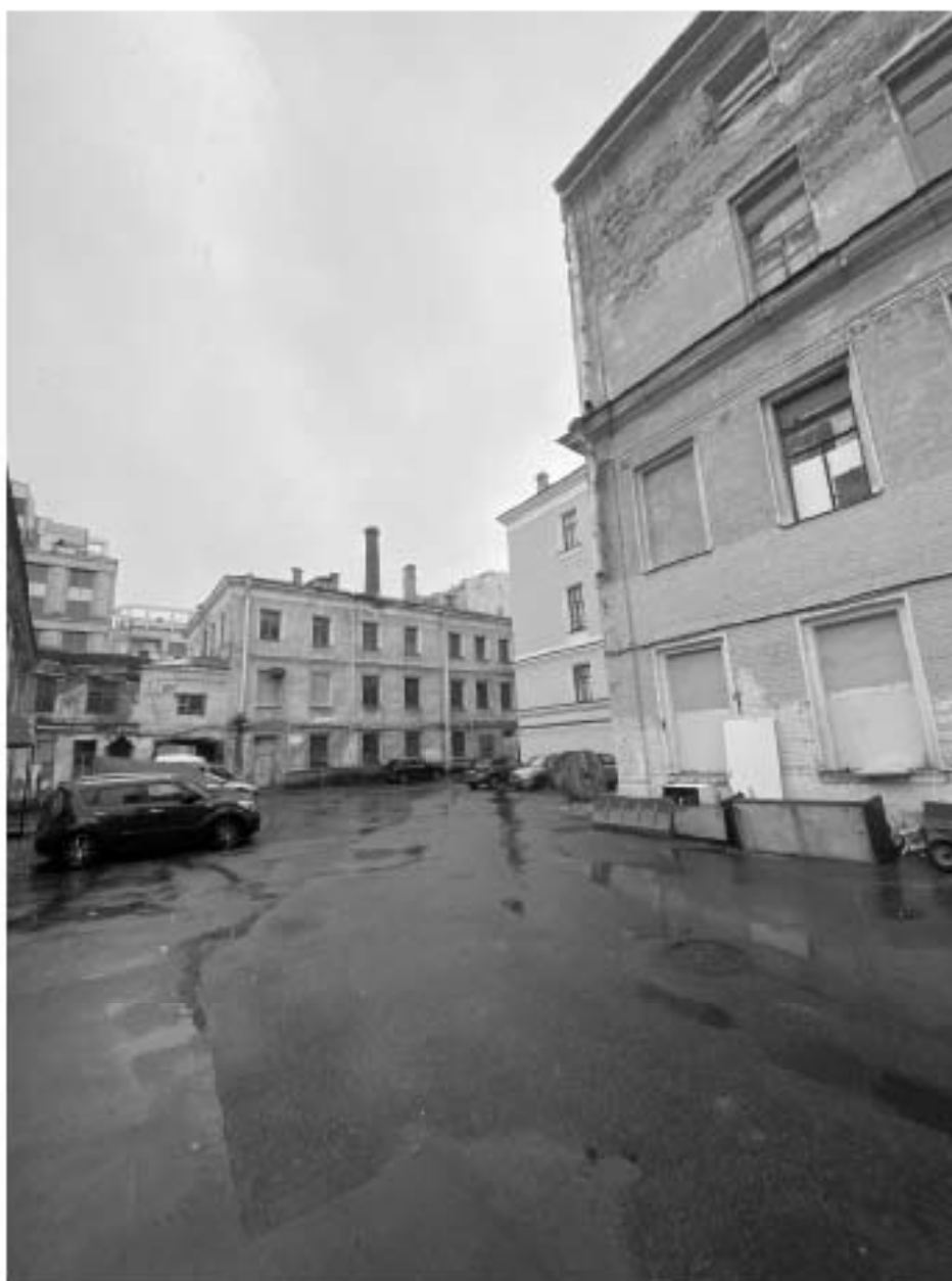
3. Вид на восточный фасад здания,
