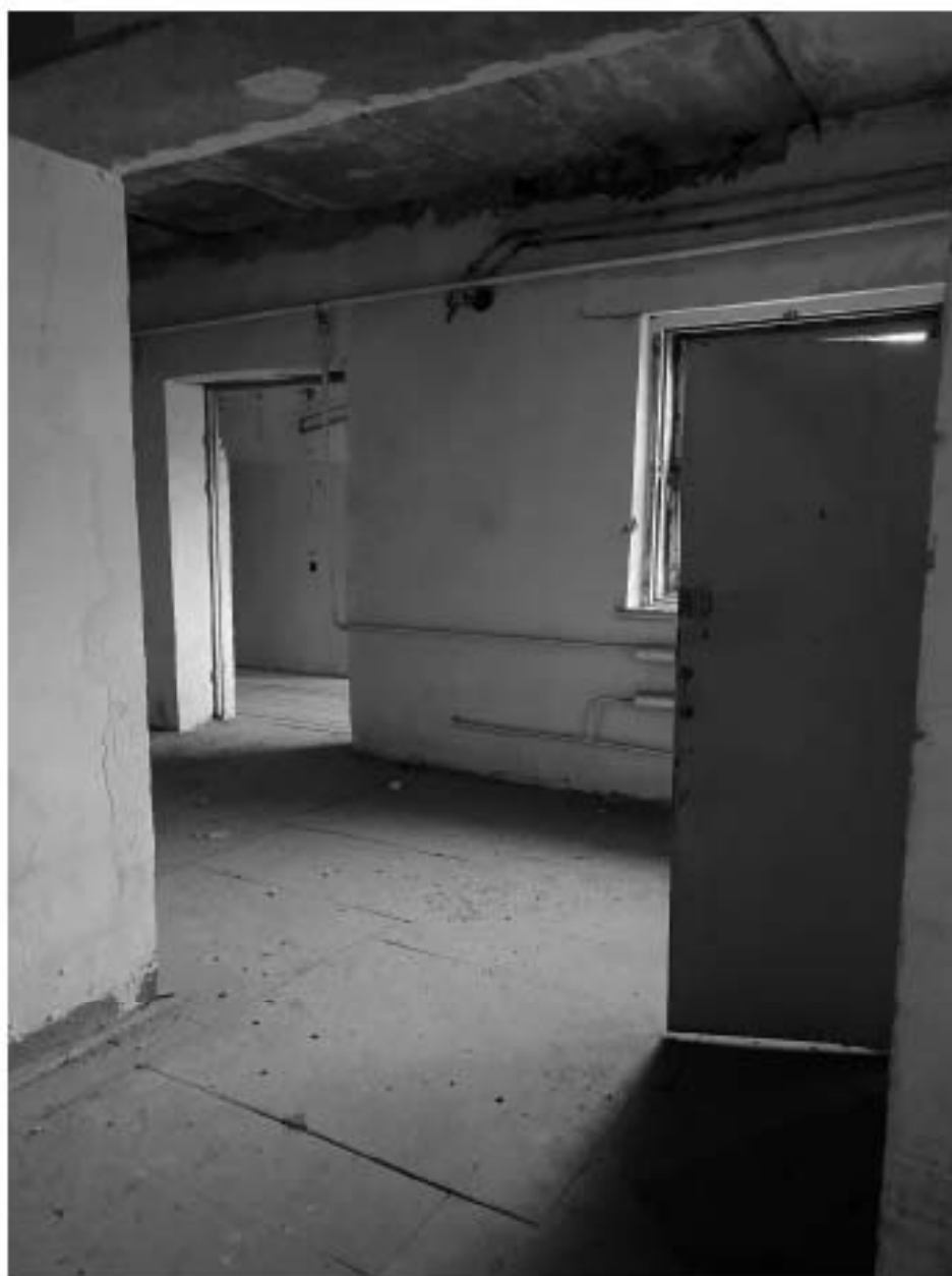
87. Фрагмент интерьера коридора;
