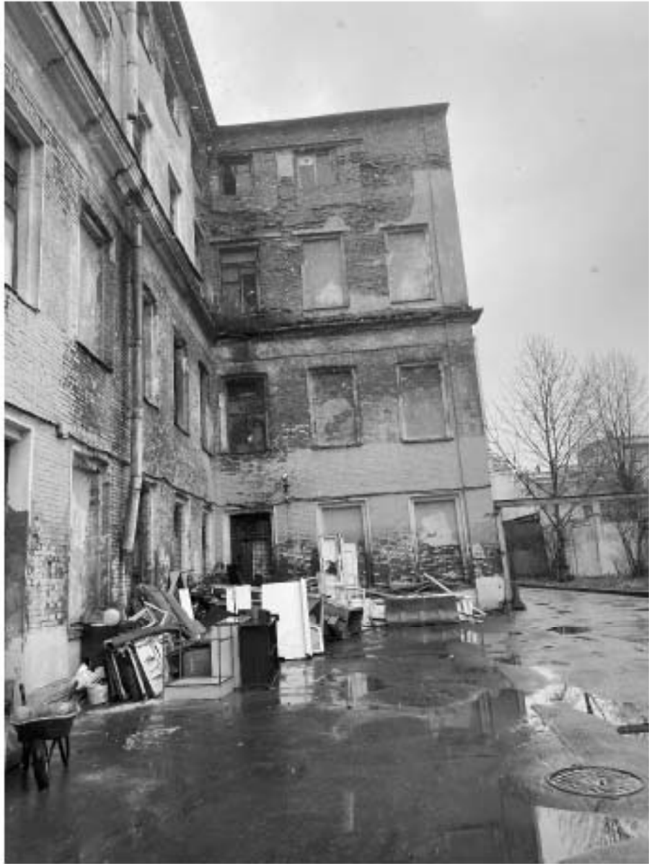
4. Вид на юго-восточный фасад здания;
