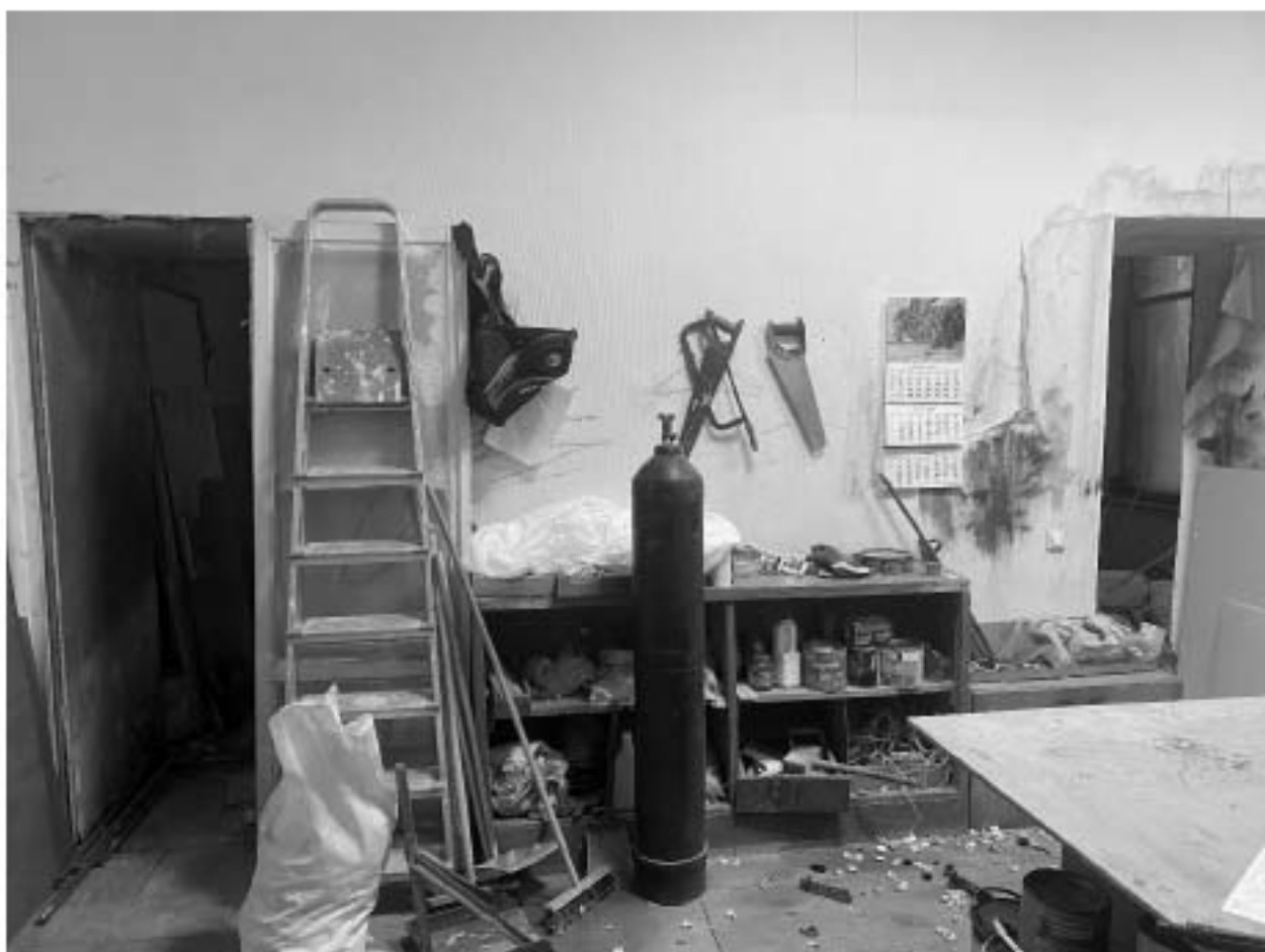
13. Помещение на первом этаже. Интерьер,
