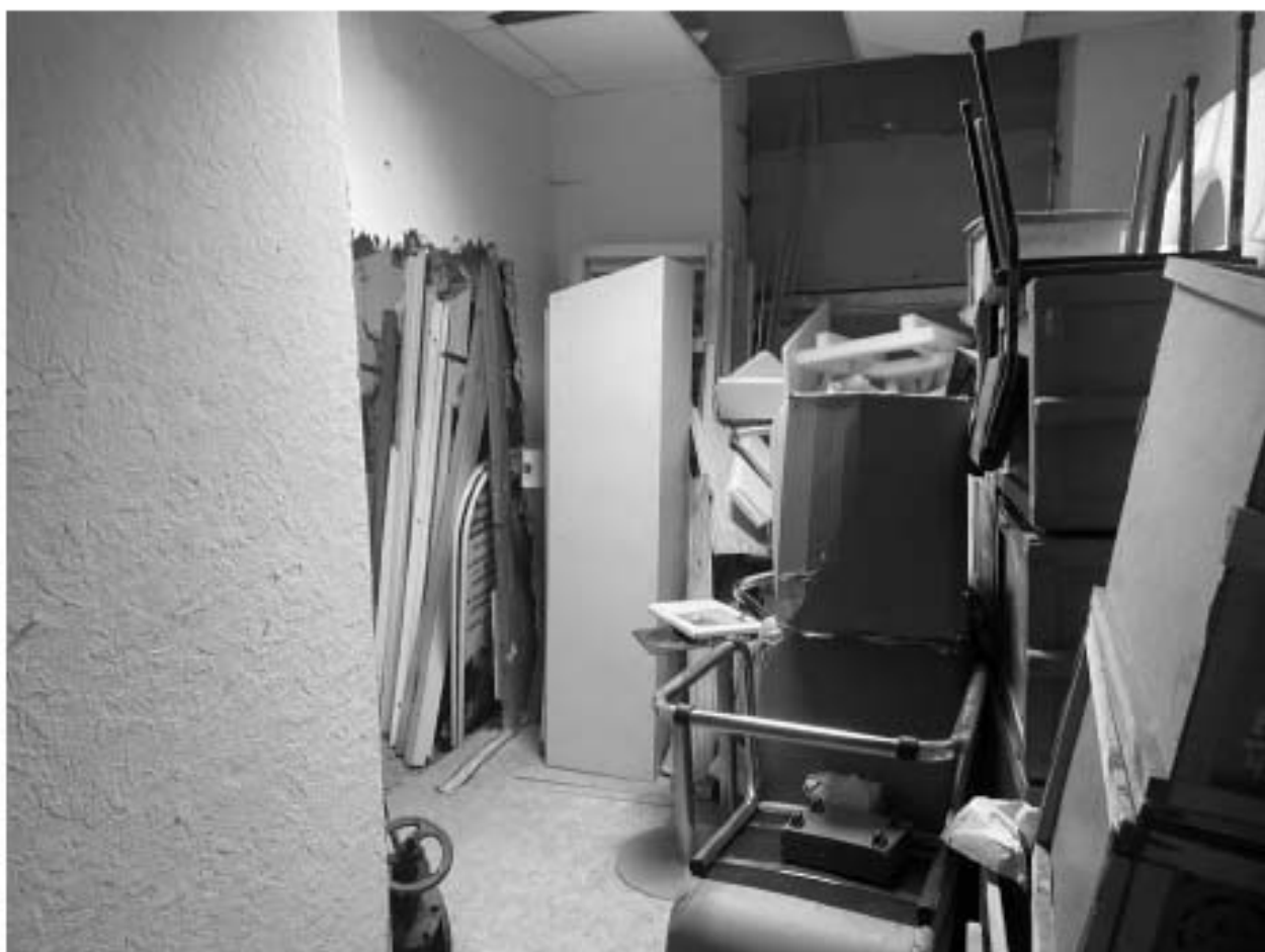
22. Фрагмент интерьера коридора;
