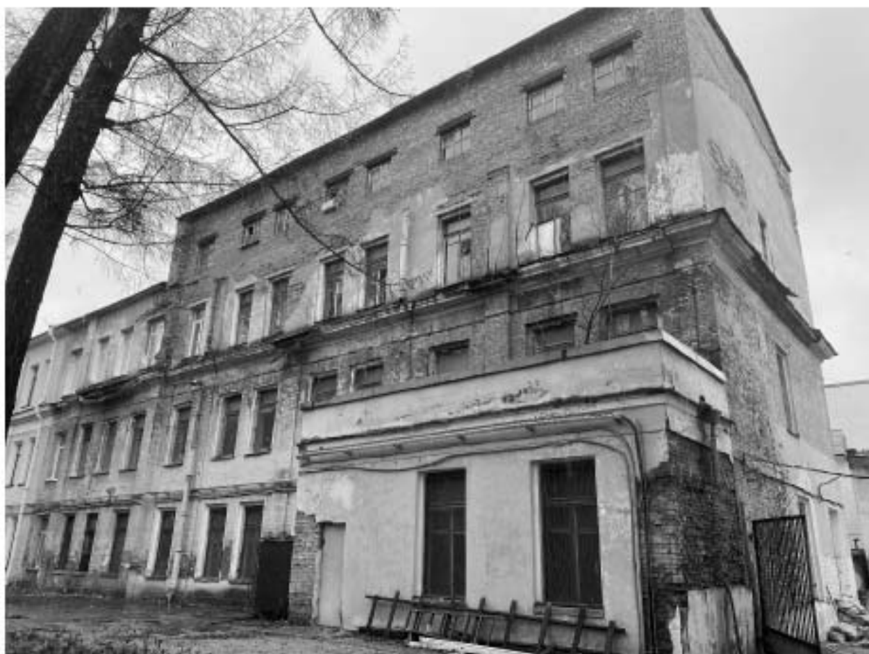
6. Общий вид на западный фасад здания,
