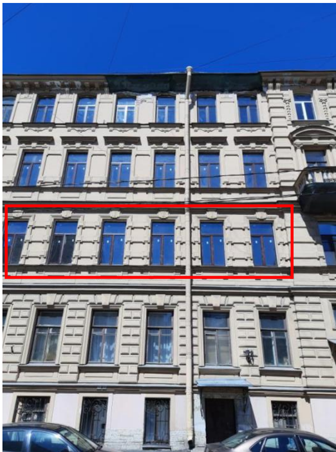
Фото 5 Фрагмент лицевого фасада выявленного объекта культурного наследия «Дом Ф.Ф. Шпринга» расположенного по адресу: Санкт-Петербург, пер. Тучков, дом 11/5, литера А (Тучков пер., 11; Волховский пер., 5), окна квартиры №31
