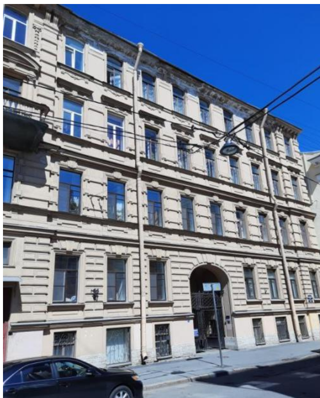
Фото 6 Фрагмент лицевого фасада выявленного объекта культурного наследия «Дом Ф.Ф. Шпринга» расположенного по адресу: Санкт-Петербург, пер. Тучков, дом 11/5, литера А (Тучков пер., 11; Волховский пер., 5)
