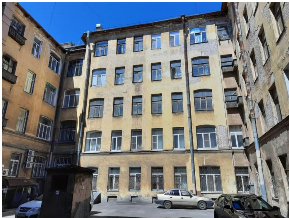
Фото 10 Фрагмент дворового фасада выявленного объекта культурного наследия «Дом Ф.Ф. Шпринга» расположенного по адресу: Санкт-Петербург, пер. Тучков, дом 11/5, литера А (Тучков пер., 11; Волховский пер., 5)
