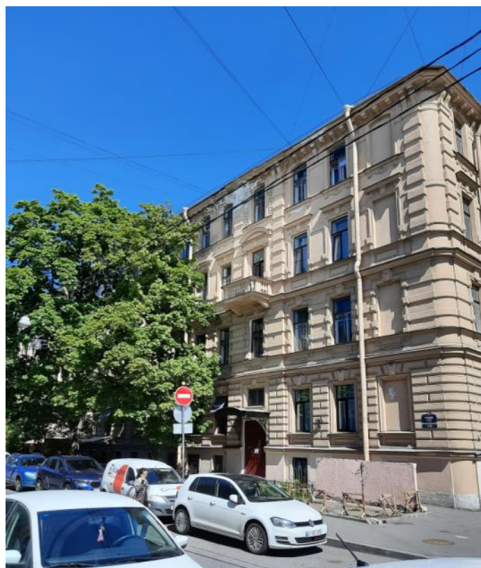
Фото 2 Фрагмент лицевого фасада выявленного объекта культурного наследия «Дом Ф.Ф. Шпринга» расположенного по адресу: Санкт-Петербург, пер. Тучков, дом 11/5, литера А (Тучков пер., 11; Волховский пер., 5)
