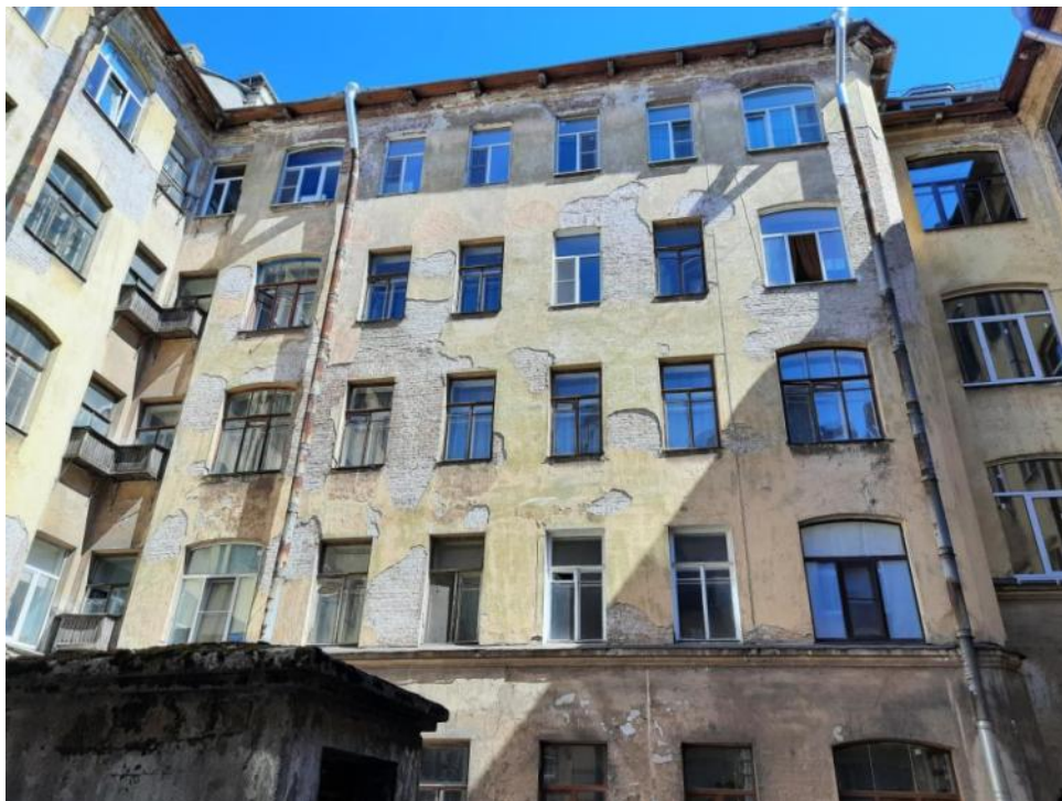
Фото 11 Фрагмент дворового фасада выявленного объекта культурного наследия «Дом Ф.Ф. Шпринга» расположенного по адресу: Санкт-Петербург, пер. Тучков, дом 11/5, литера А (Тучков пер., 11; Волховский пер., 5)
