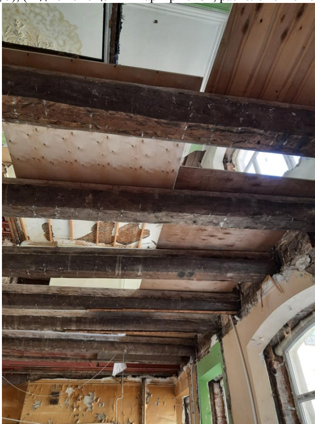
Фото 16 Интерьер квартиры №35 выявленного объекта культурного наследия «Дом Ф.Ф. Шпринга» расположенного по адресу: Санкт-Петербург, пер. Тучков, дом 11/5, литера А (Тучков пер., 11; Волховский пер., 5); (вид из помещений квартиры №31, расположенной снизу)
