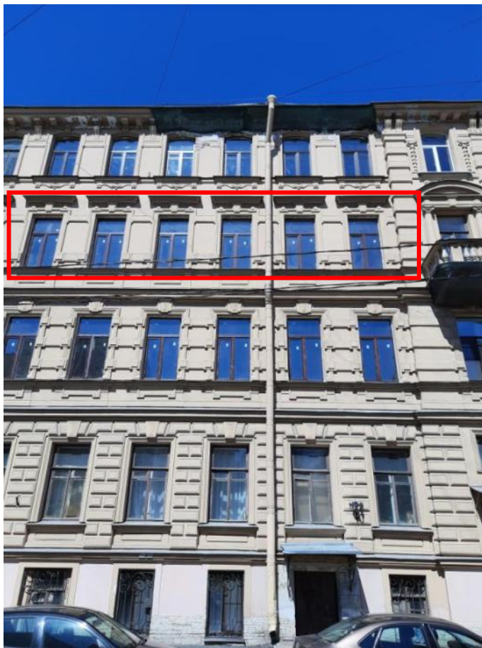
Фото 5 Фрагмент лицевого фасада выявленного объекта культурного наследия «Дом Ф.Ф. Шпринга» расположенного по адресу: Санкт-Петербург, пер. Тучков, дом 11/5, литера А (Тучков пер., 11; Волховский пер., 5), окна квартиры №35
