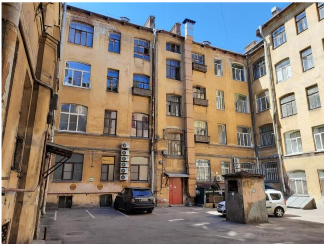
Фото 9 Фрагмент дворового фасада выявленного объекта культурного наследия «Дом Ф.Ф. Шпринга» расположенного по адресу: Санкт-Петербург, пер. Тучков, дом 11/5, литера А (Тучков пер., 11; Волховский пер., 5)
