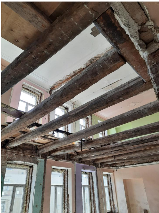
Фото 17 Интерьер квартиры №35 выявленного объекта культурного наследия «Дом Ф.Ф. Шпринга» расположенного по адресу: Санкт-Петербург, пер. Тучков, дом 11/5, литера А (Тучков пер., 11; Волховский пер., 5); (вид из помещений квартиры №31, расположенной снизу)
