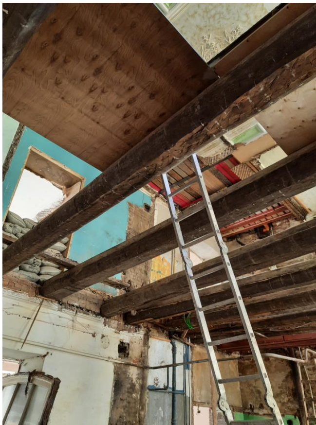
Фото 15 Интерьер квартиры №35 выявленного объекта культурного наследия «Дом Ф.Ф. Шпринга» расположенного по адресу: Санкт-Петербург, пер. Тучков, дом 11/5, литера А (Тучков пер., 11; Волховский пер., 5); (вид из помещений квартиры №31, расположенной снизу)
