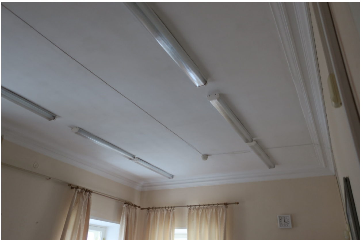
32. Помещения №3-4 (2-Н) в уровне 2-го этажа объекта культурного наследия федерального значения «Дача Чернышева И.Г. «Александрино», расположенного по адресу: г. Санкт-Петербург, пр. Стачек, д. 226, литера А. 11.03.2022
