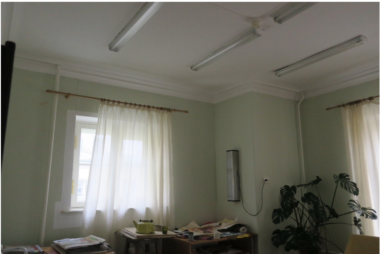
16. Помещения № 1, 2 (2-Н) в уровне 1-го этажа объекта культурного наследия федерального значения «Дача Чернышева И.Г. «Александрино», расположенного по адресу: г. Санкт-Петербург, пр. Стачек, д. 226, литера А. 11.03.2022
