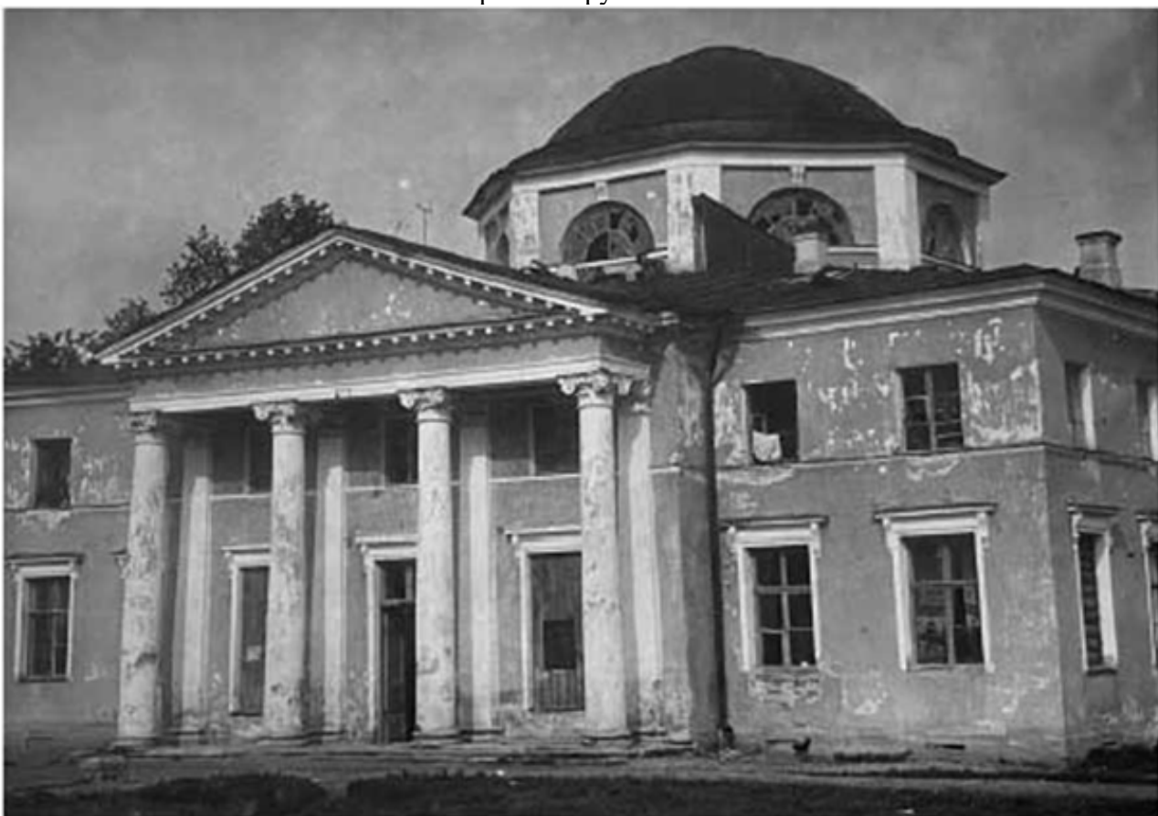
10. Вид главного корпуса усадьбы с юго-востока. 1930-е гг. // КГИОП. Инв. №: Н-13880
