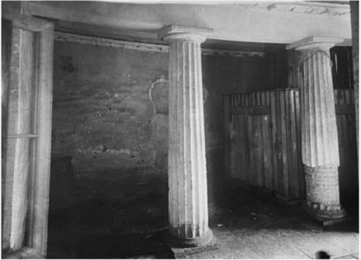
11. Нижний вестибюль. 1930-е гг. // КГИОП. Инв. №: Н-13880
