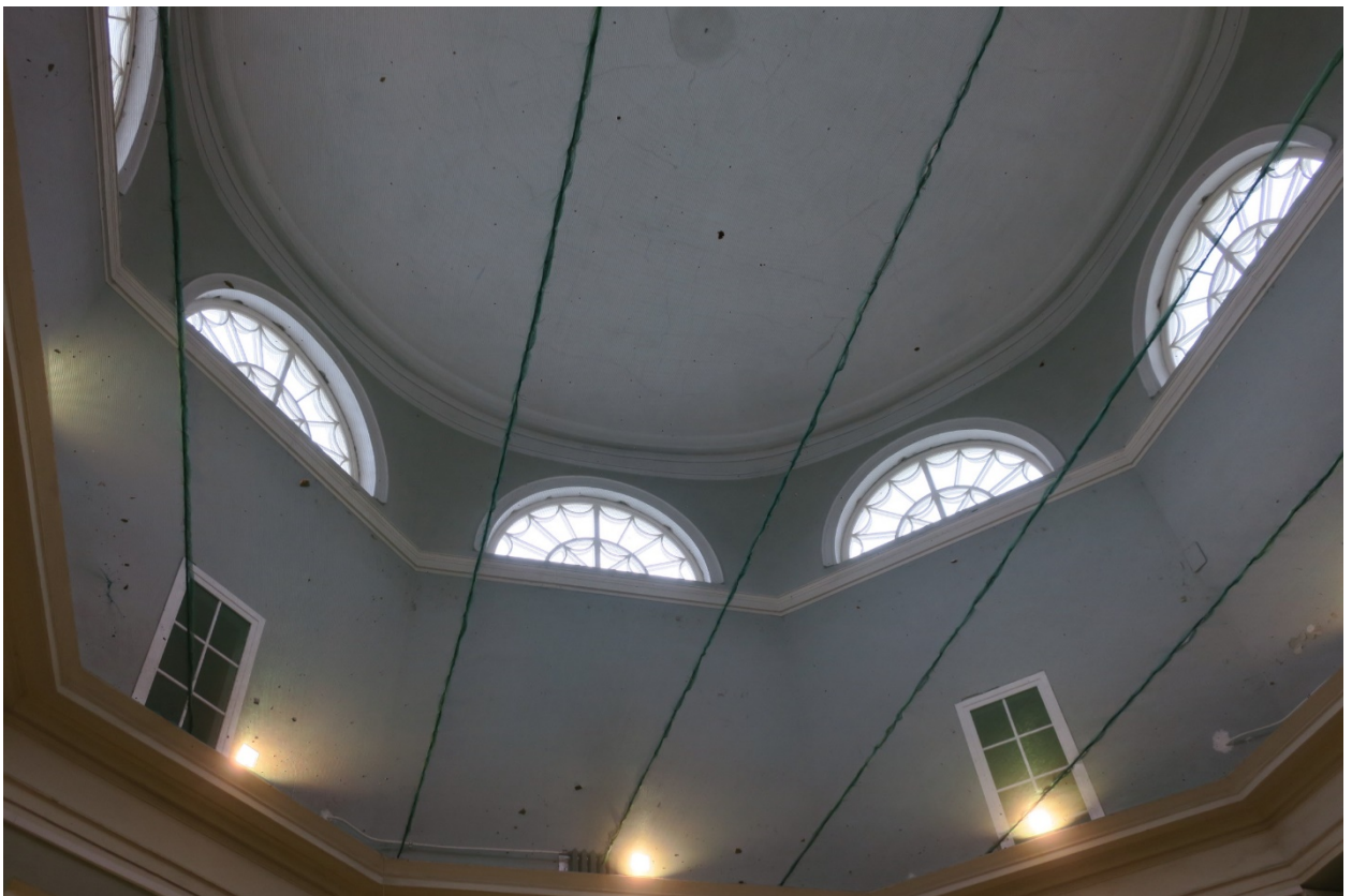
б. Помещение № 31 (2-Н) в уровне 1-го этажа объекта культурного наследия федерального значения «Дача Чернышева И.Г. «Александрино», расположенного по адресу: г. Санкт-Петербург, пр. Стачек, д. 226, литера А. 11.03.2022
