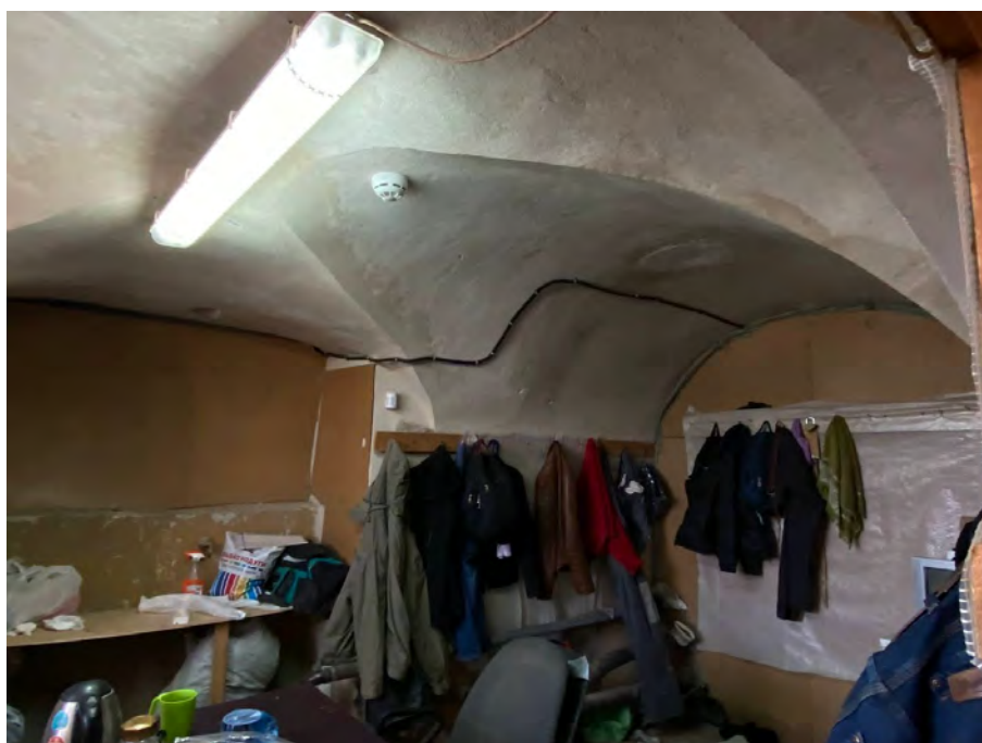
Фото №8. Подвал, помещение 0.6.
