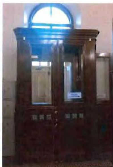
3. Тамбур главного входа.
