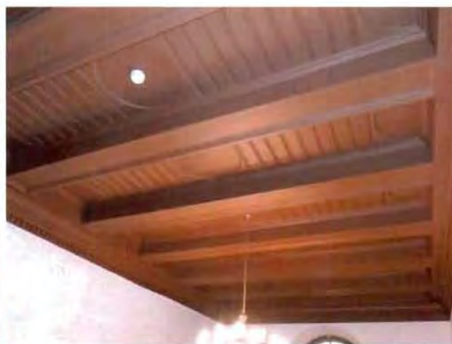
8. Оформление потолка над лестничной клеткой.
