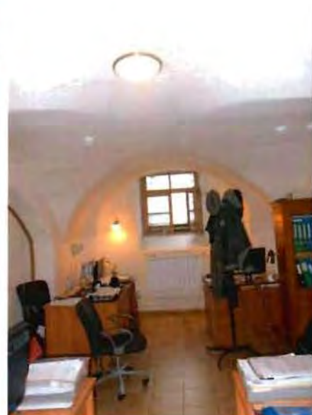
4. Свод цокольного этажа.
