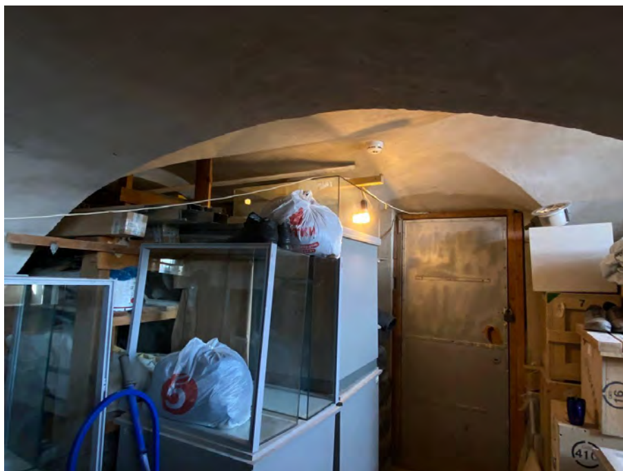
Фото №9. Подвал, помещение 0.5, дверь в помещение 0.1.
