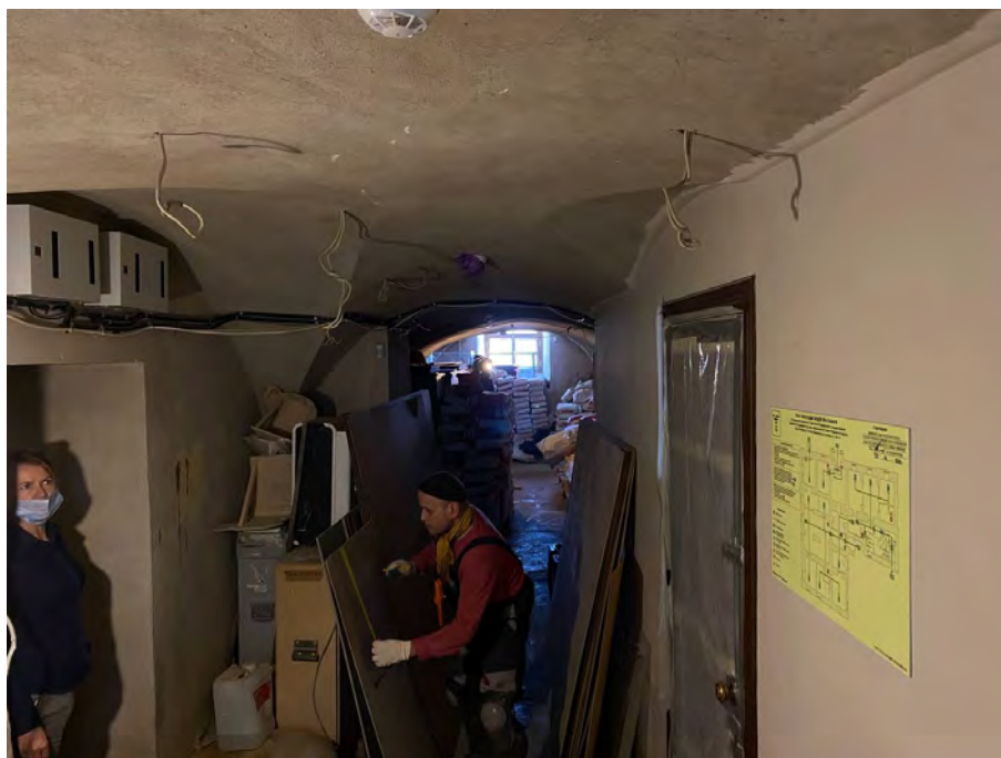
Фото №5. Подвал, помещение 0.17.
