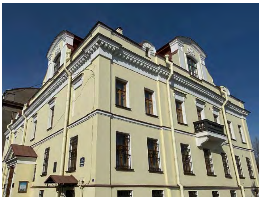
Фото №2. Общий вид объекта со стороны перекрестка наб. Лейтенанта Шмидта и 18-й линии Васильевского Острова.
