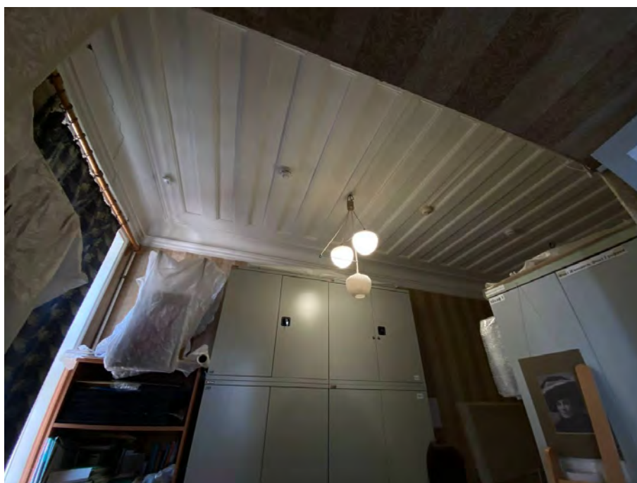
Фото №26. 1 этаж, помещение 113.
