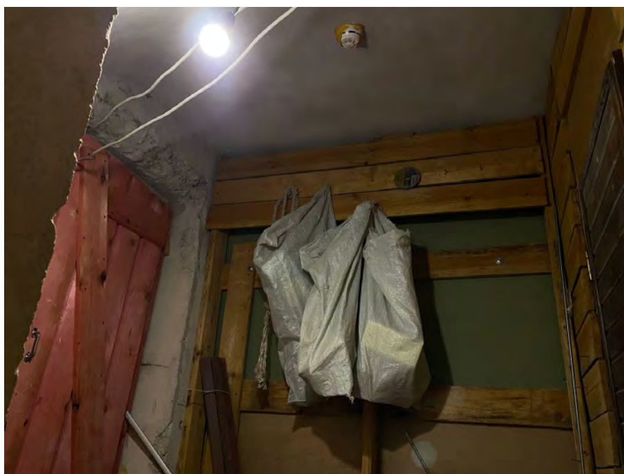
Фото №10. Подвал, помещение 0.19.
