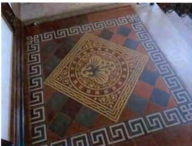
5. Покрытие пола верхнего уровня вестибюля.
