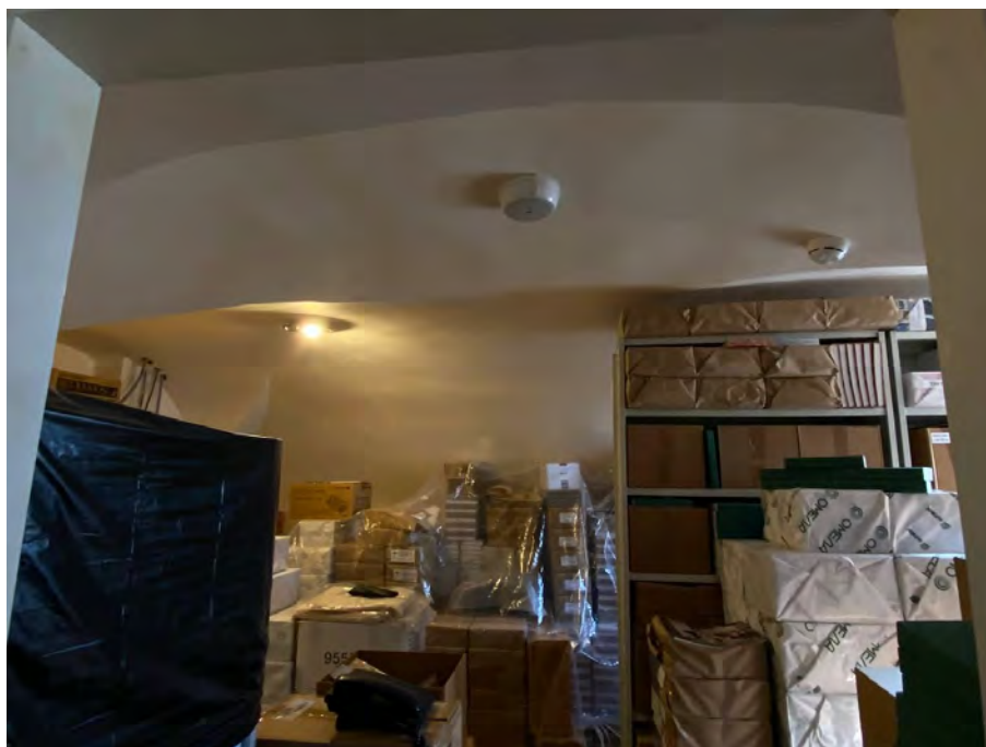
Фото №13. Подвал, помещение 0.12.
