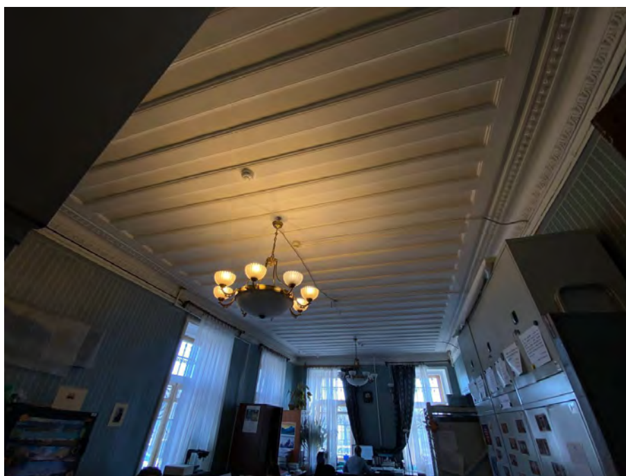
Фото №24. 1 этаж, помещение 112.
