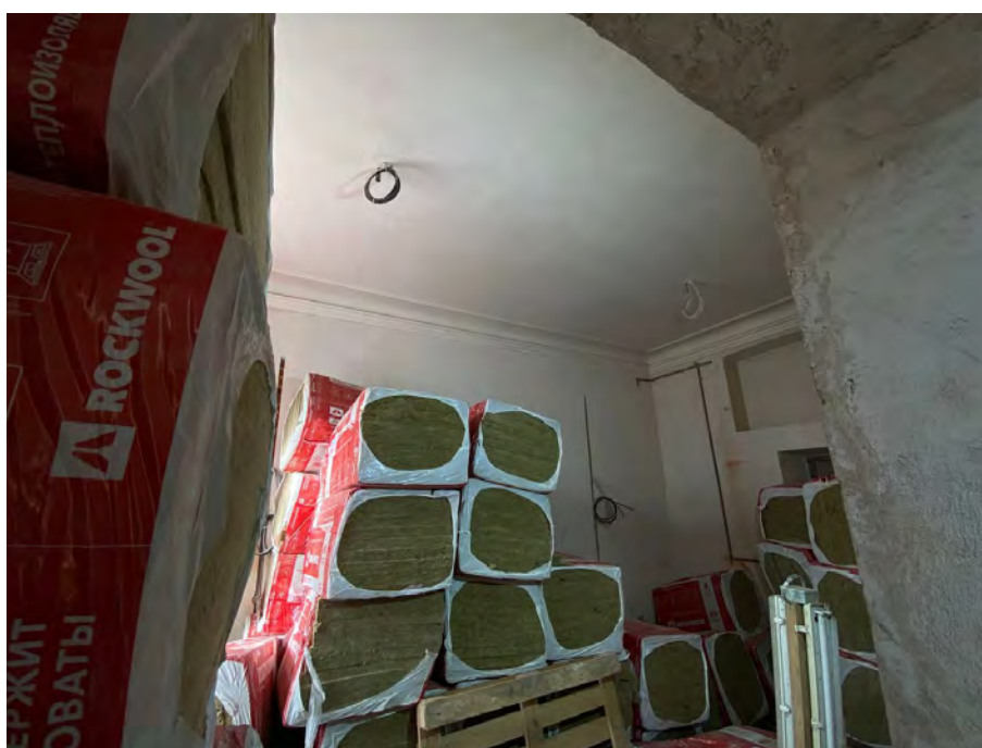
Фото №30. 1 этаж, помещение 102.
