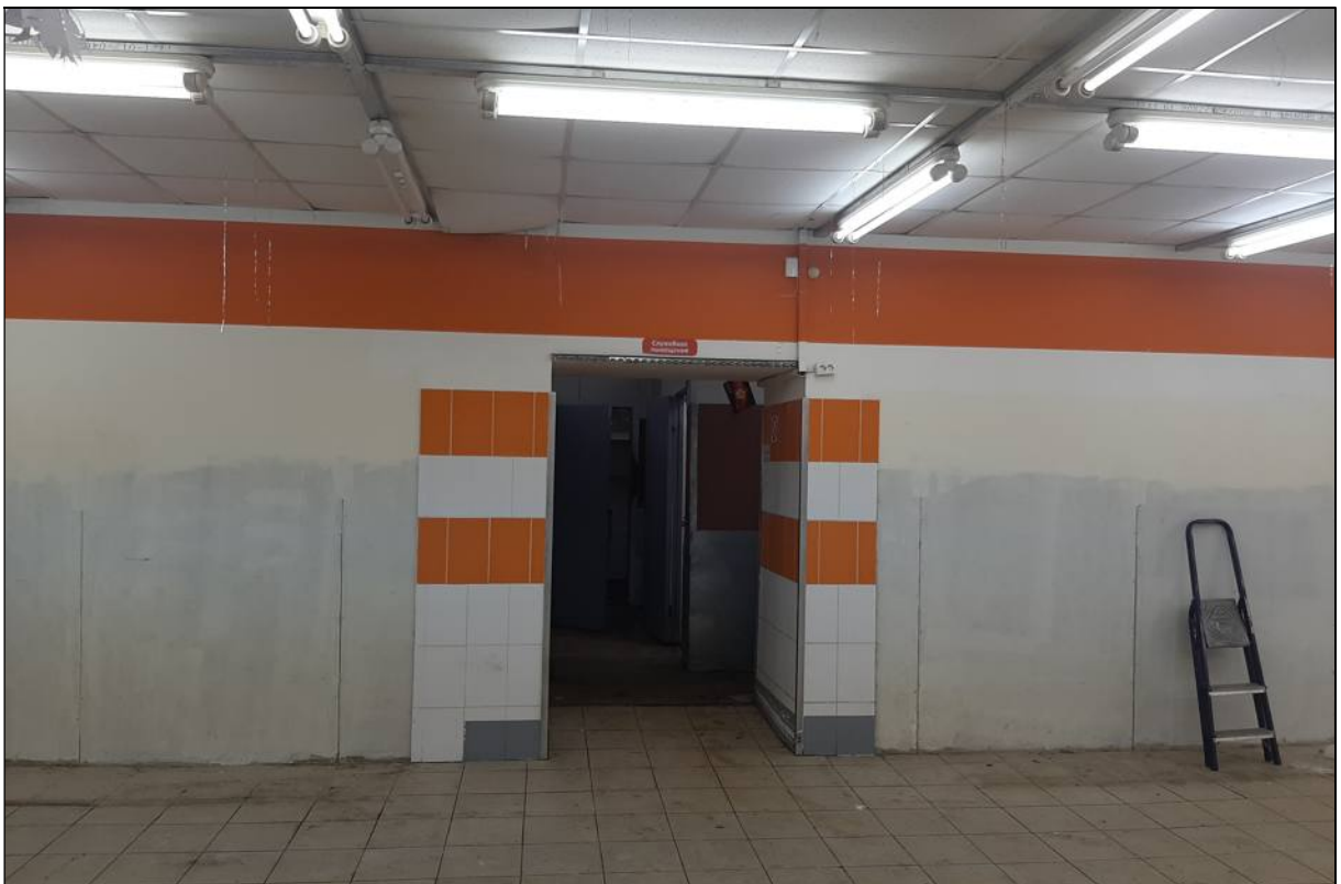
18. Объект культурного наследия «Дом, где в 1912-1913 гг. проходили заседания объединенной социал-демократической фракции IV Государственной думы». Помещения 15-Н. Западная часть помещения № 2. Проем в капитальной стене между помещениями №№ 2, 3. 25.01.2020 г.
