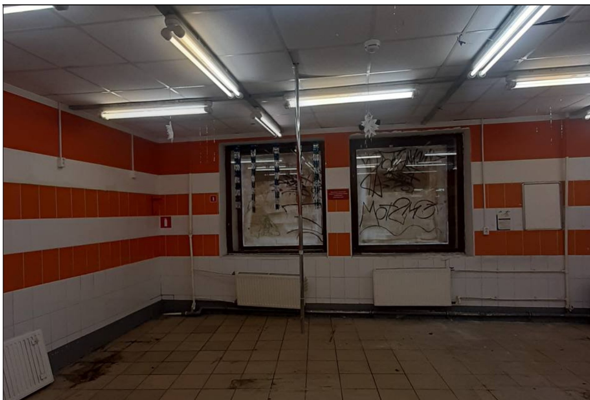
14. Объект культурного наследия «Дом, где в 1912-1913 гг. проходили заседания объединенной социал-демократической фракции IV Государственной думы». Помещения 15-Н. Северо-западная часть помещения № 1. Оконные проемы. 25.01.2020 г.
