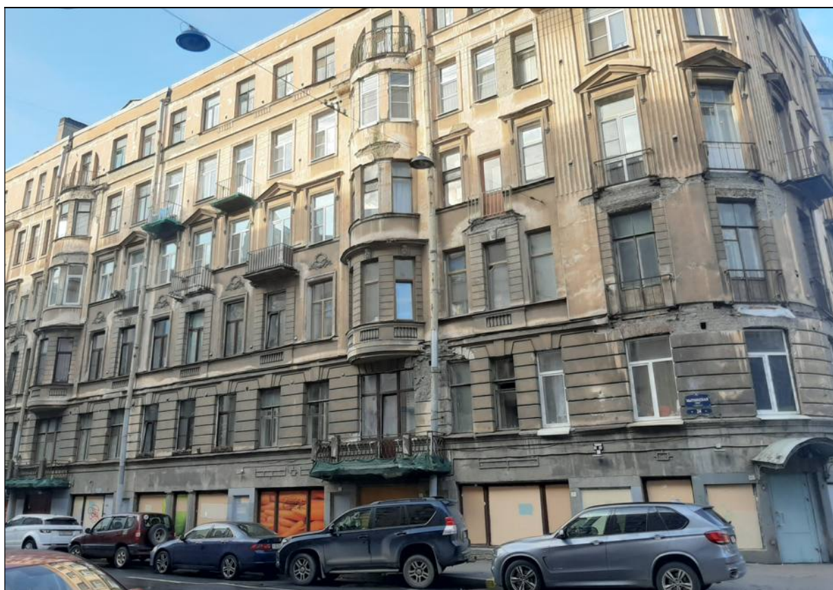
3. Объект культурного наследия «Дом, где в 1912-1913 гг. проходили заседания объединенной социал-демократической фракции IV Государственной думы». Фрагмент фасада по Мытнинской улице. Вид на юго-запад от Мытнинской улицы. 25.01.2020 г.
