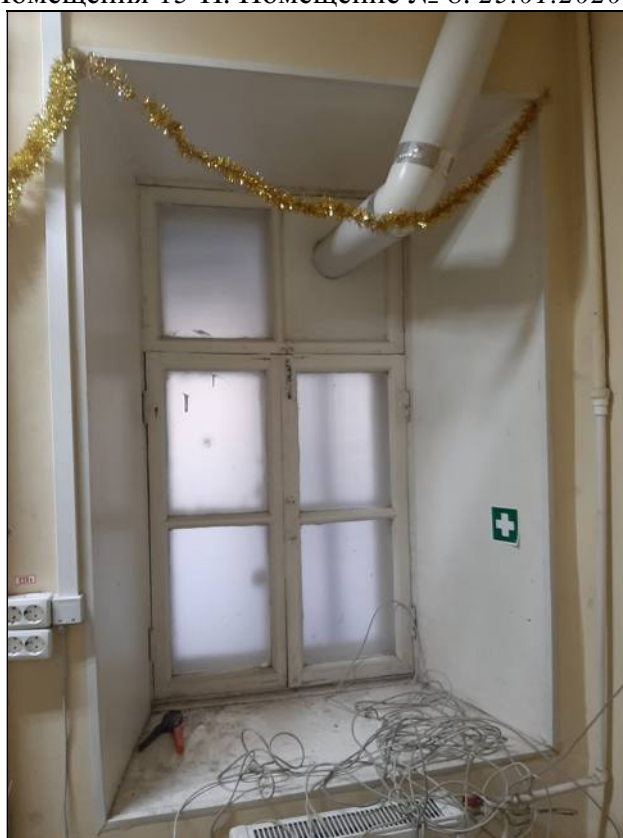
28. Объект культурного наследия «Дом, где в 1912-1913 гг. проходили заседания объединенной социал-демократической фракции IV Государственной думы». Помещения 15-Н. Помещение № 8. Оконный проем. 25.01.2020 г.
