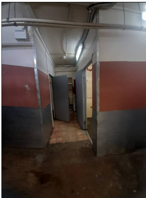
21. Объект культурного наследия «Дом, где в 1912-1913 гг. проходили заседания объединенной социал-демократической фракции IV Государственной думы». Помещения 15-Н. Помещение № 3. Коридор между помещениями № 7, 9. 25.01.2020 г.
