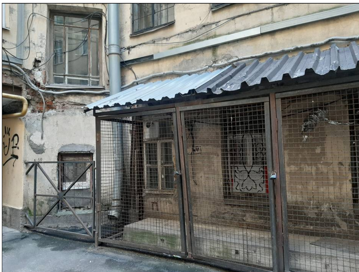
8. Объект культурного наследия «Дом, где в 1912-1913 гг. проходили заседания объединенной социал-демократической фракции IV Государственной думы». Фрагмент южного дворового фасада. Оконные проемы и вход в помещение 15-Н. 25.01.2020 г.
