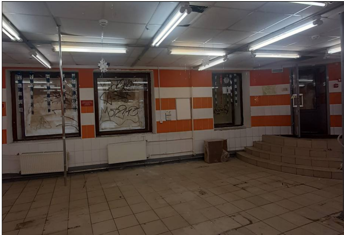
10. Объект культурного наследия «Дом, где в 1912-1913 гг. проходили заседания объединенной социал-демократической фракции IV Государственной думы». Помещения 15-Н. Северная часть помещения № 1. Оконные проемы. 25.01.2020 г.
