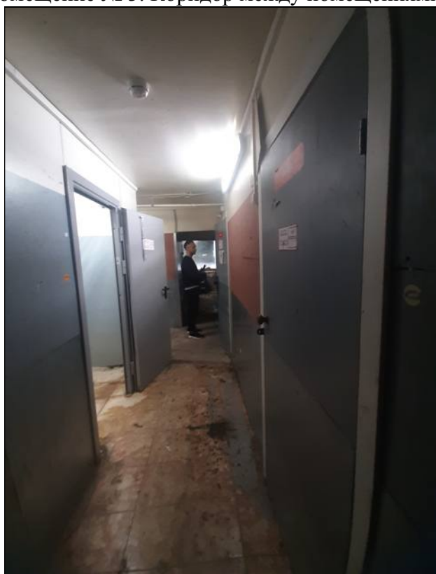
22. Объект культурного наследия «Дом, где в 1912-1913 гг. проходили заседания объединенной социал-демократической фракции IV Государственной думы». Помещения 15-Н. Помещение № 11. Коридор между помещениями №№ 1, 13, 14. 25.01.2020 г.
