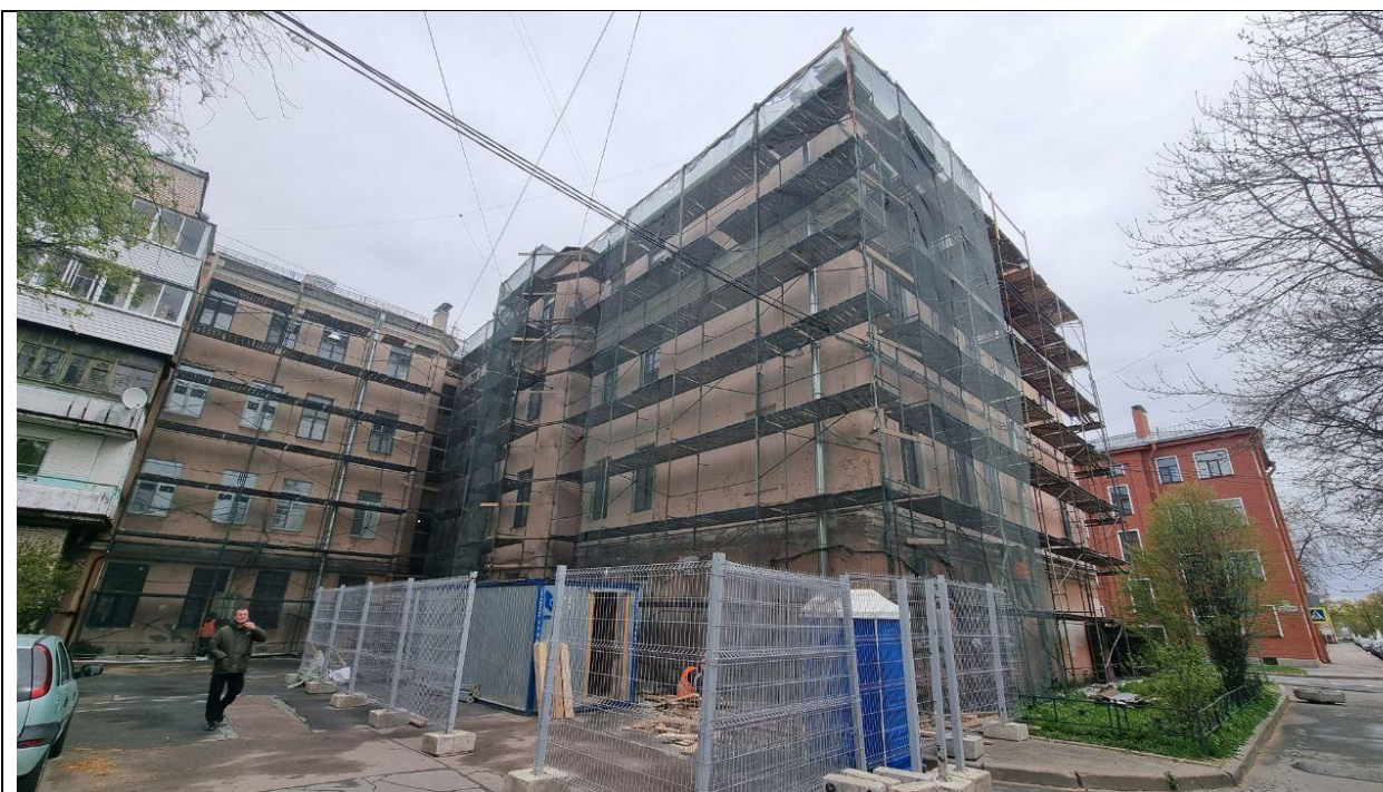
Фото 4. Общий вид дворовых фасадов.
