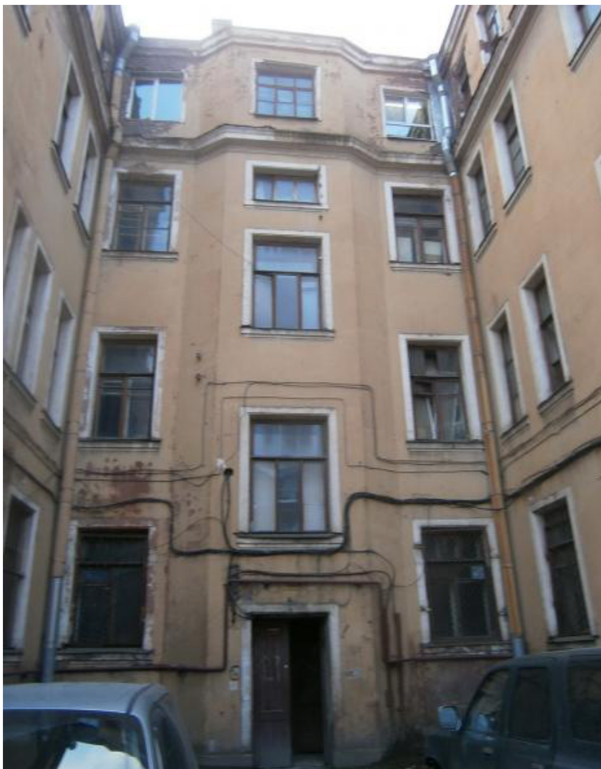
Фото 1. Общий вид дворового северо-восточного фасада здания.
