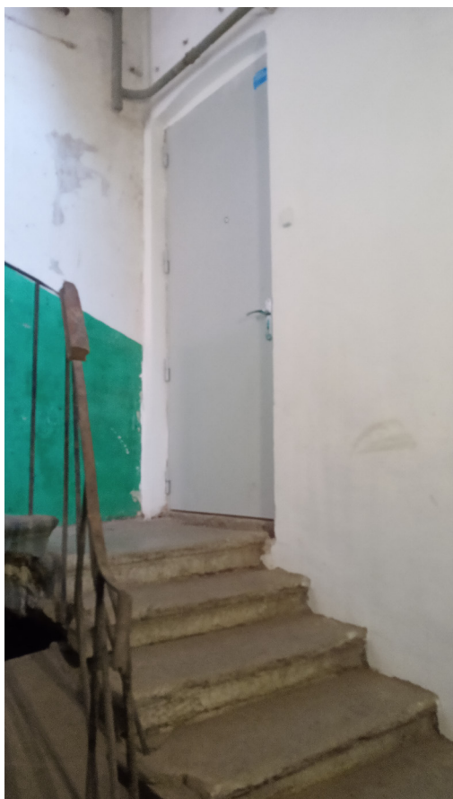
Фото 5. Входная дверь в помещение 2-Н со стороны правой лестничной клетки.
