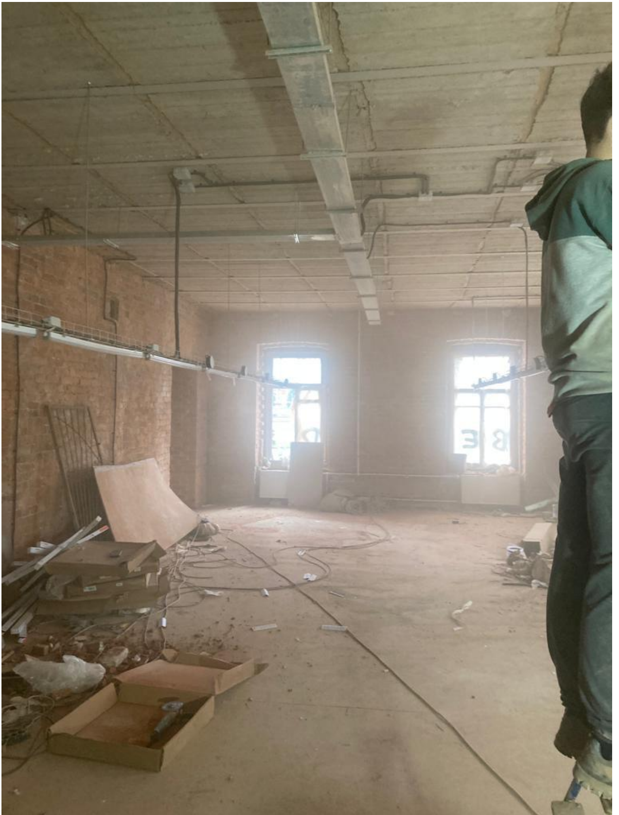
Фото 14. Комната 21 в помещении 2-Н.
