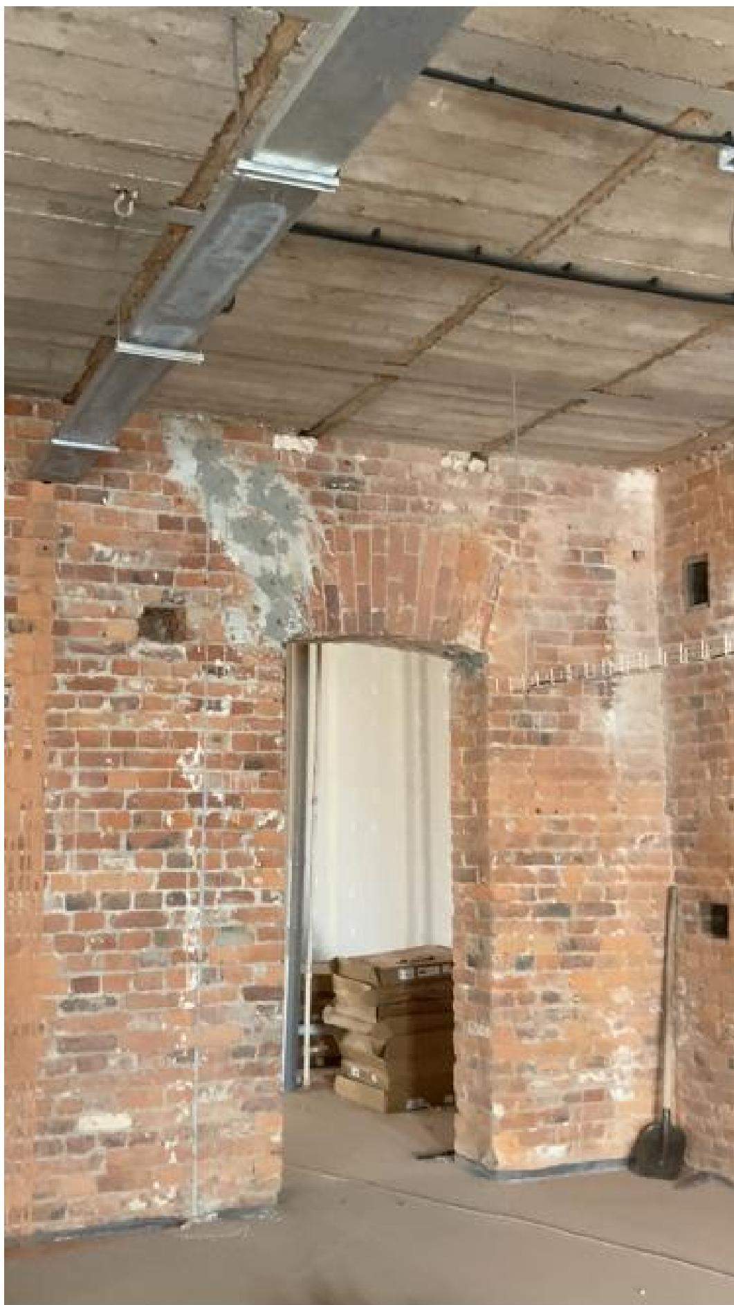
Фото 15. Комната 14 в помещении 2-Н.
