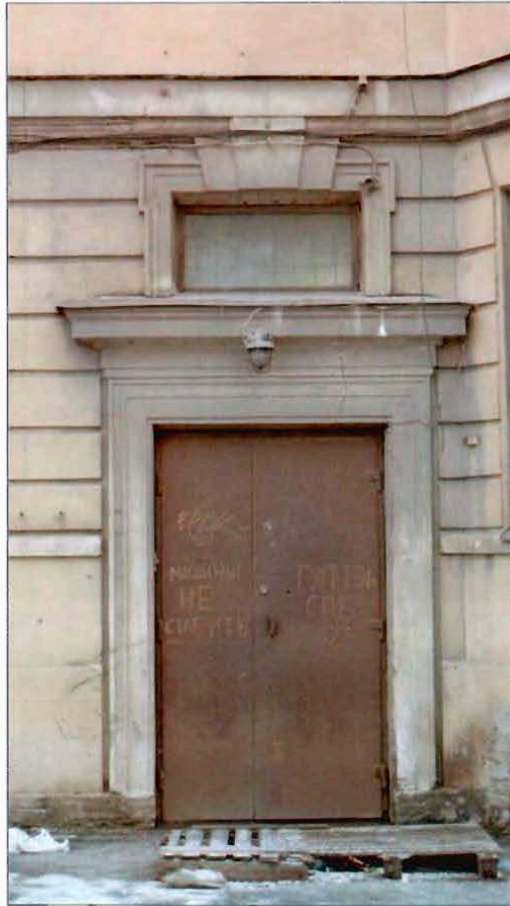
6. Оформление дверного проема. Юго-восточный фасад. Фрагмент.
