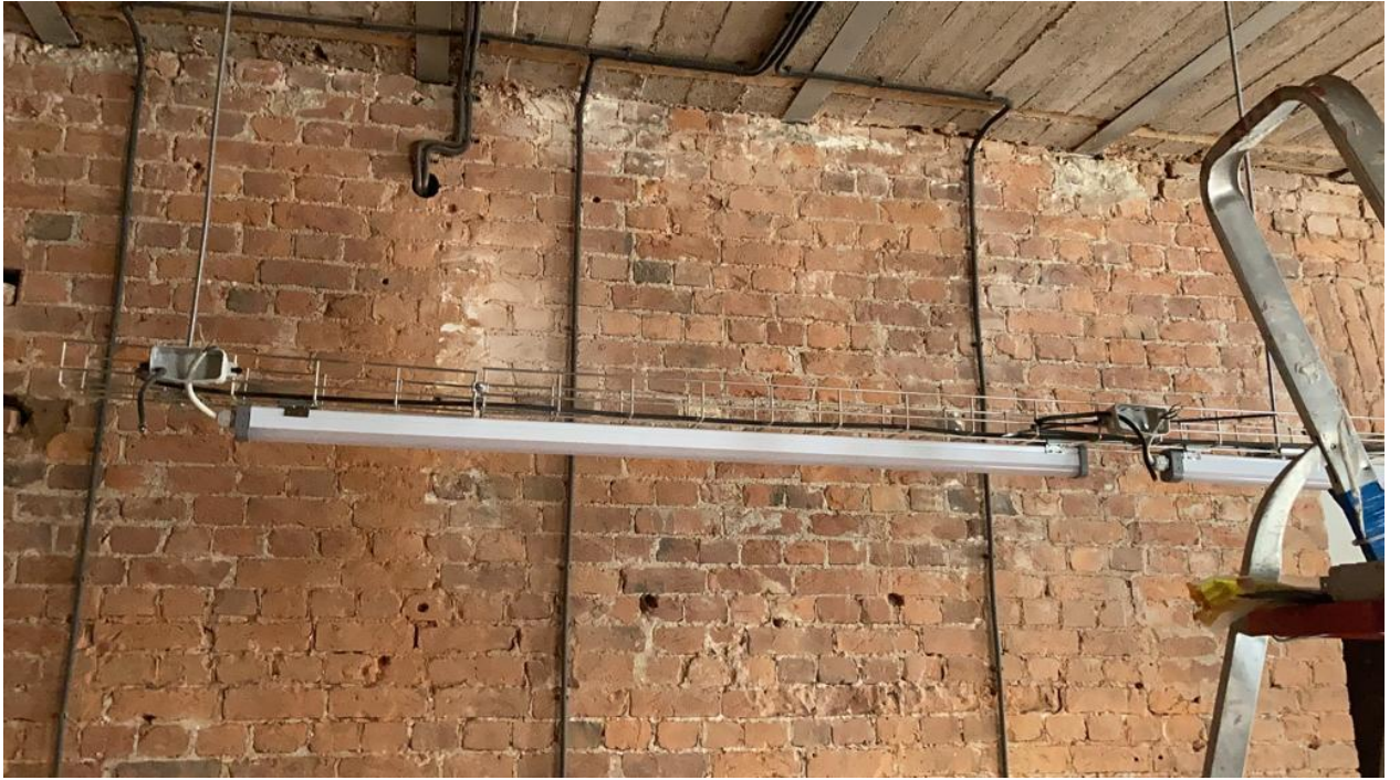
Фото 13. Несущая стена комнаты 17 в помещении 2-Н.
