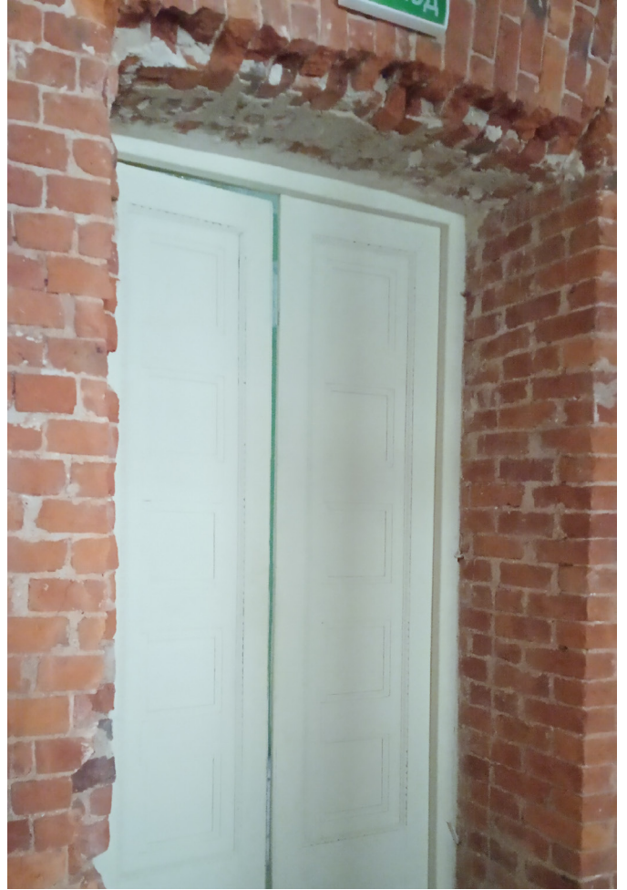
Фото 18. Входная дверь в вестибюль главного входа со стороны помещения 2-Н.
