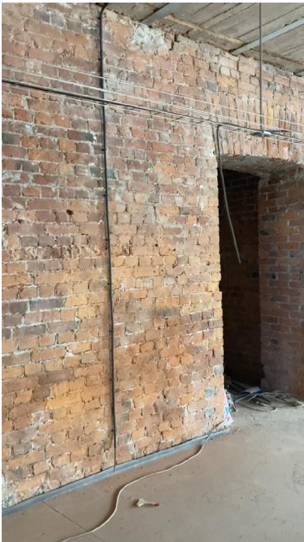
Фото 16. Комната 19 в помещении 2-Н.
