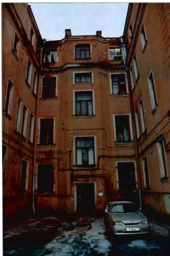
5. Северо-восточный дворовый фасад.
