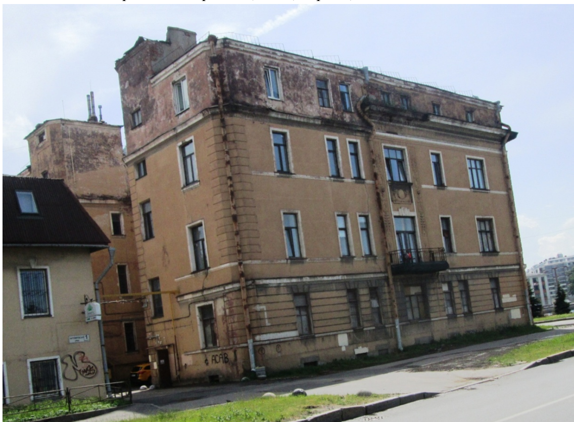
Илл. 12. Объект культурного наследия регионального значения «Жилой дом бумагопрядильной и трикотажной Николаевской мануфактуры акционерного общества мануфактур И. А. Воронин, Лютш и Чешер». Санкт-Петербург, Выборгский район, Выборгская набережная, д. 59, корп. 1, Лит. А. Фото 2021г.
