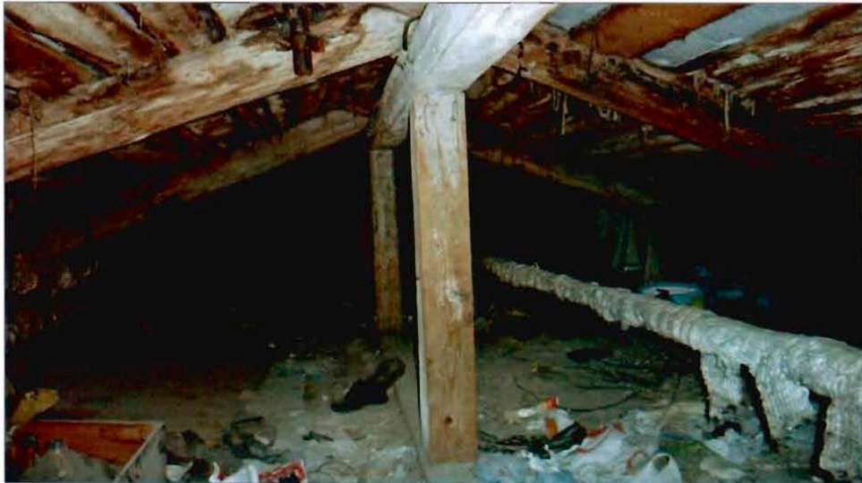
7. Стропильная система. Чердак.
