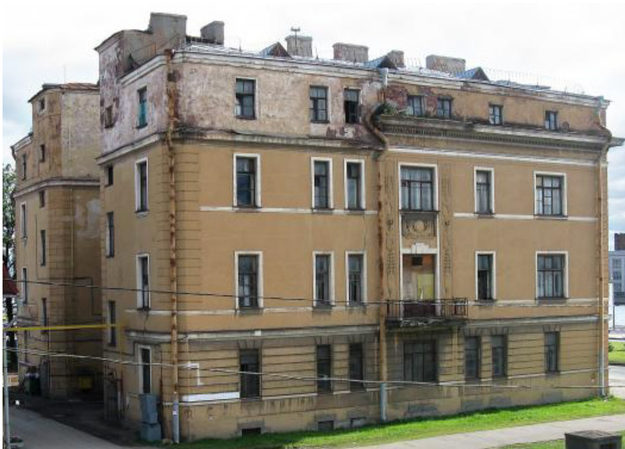
Фото 3. Общій вид бокового северо-западного фасада здания.
