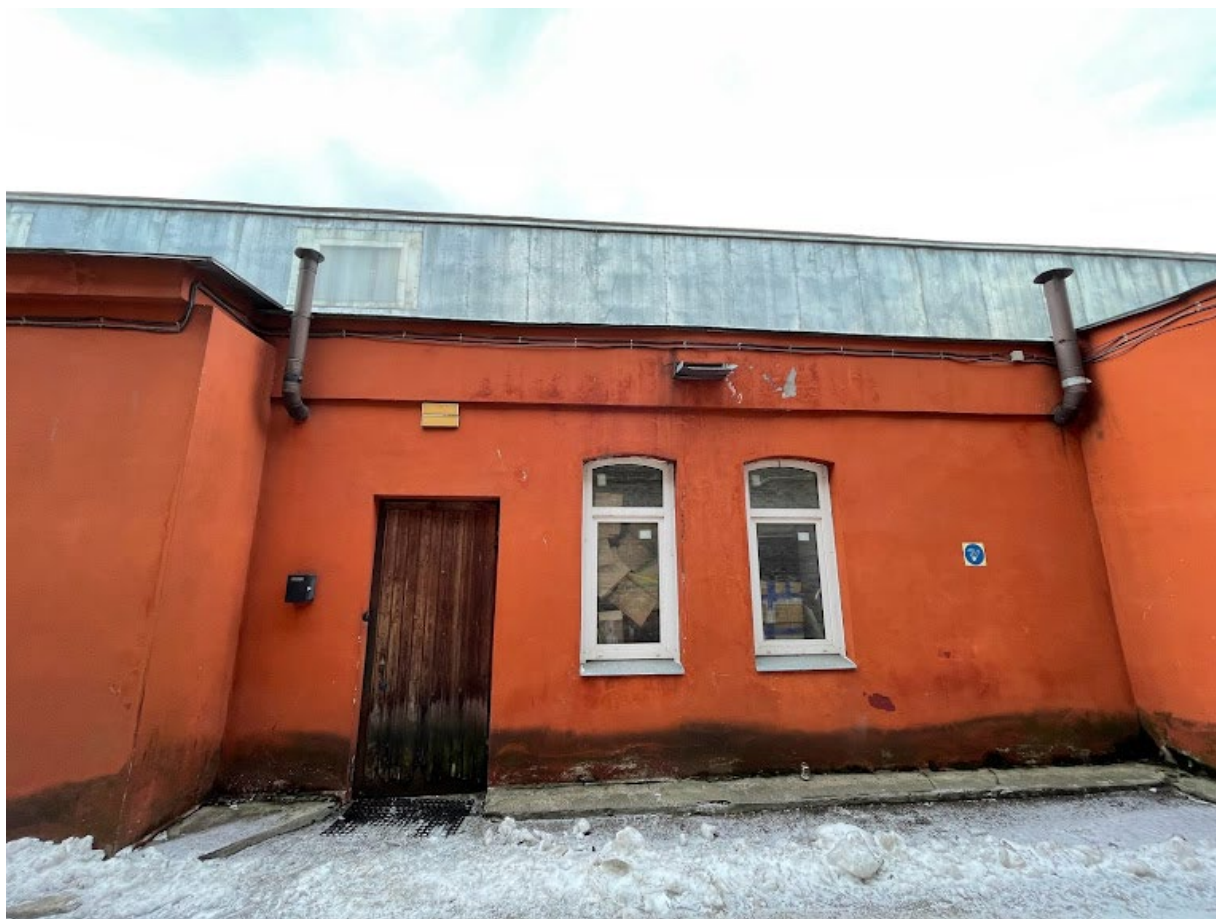
11. Фрагмент северного фасада шедового корпуса
