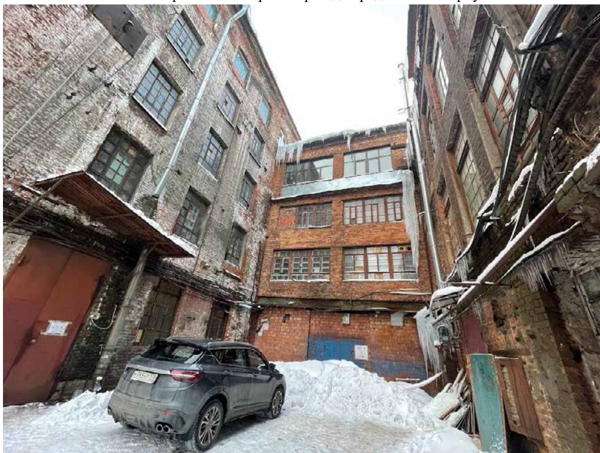
42. Вид на переход между корпусами
