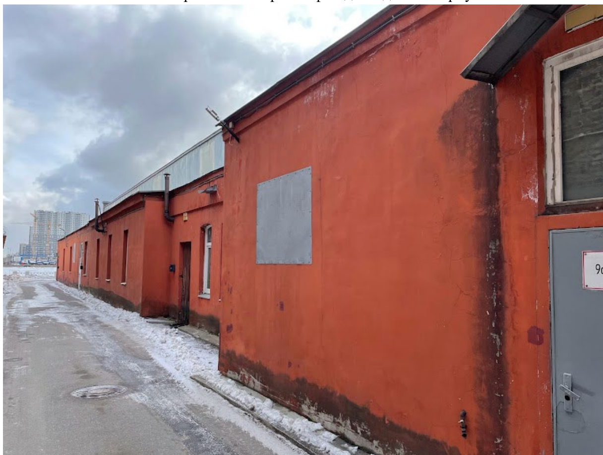
12. Фрагмент северного фасада шедового корпуса
