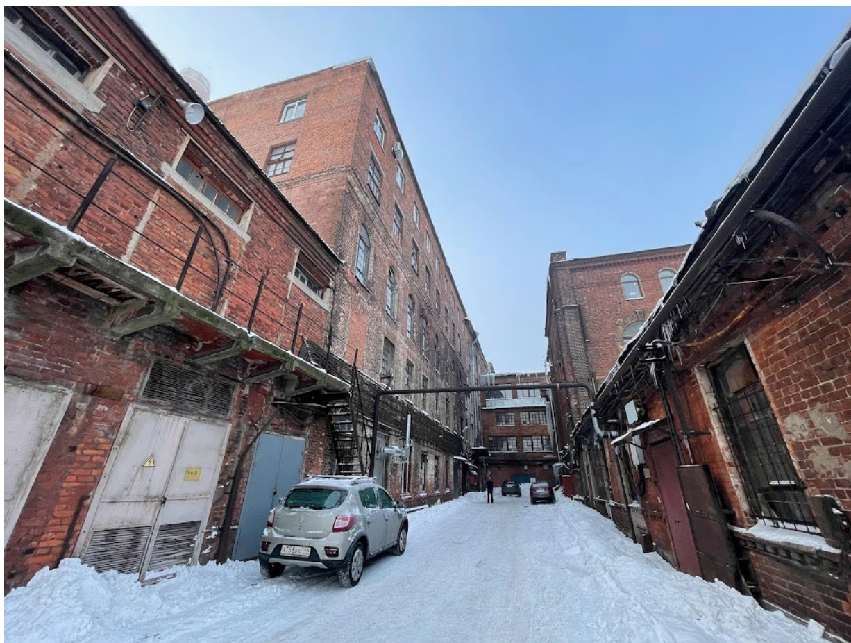
49. Вид на проход между корпусами
