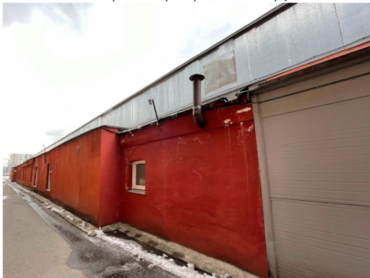
14. Фрагмент северного фасада шедового корпуса
