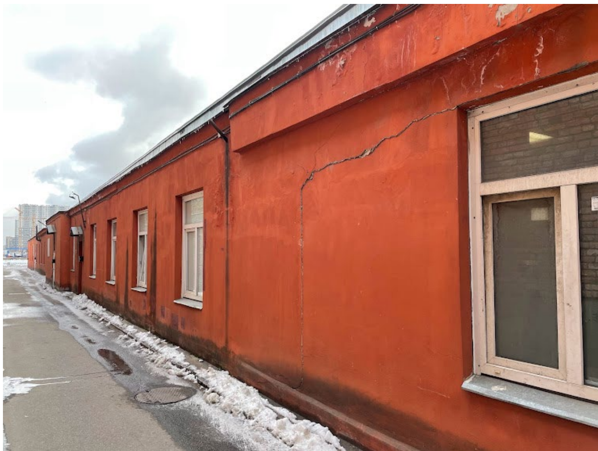
13. Фрагмент северного фасада шедового корпуса
