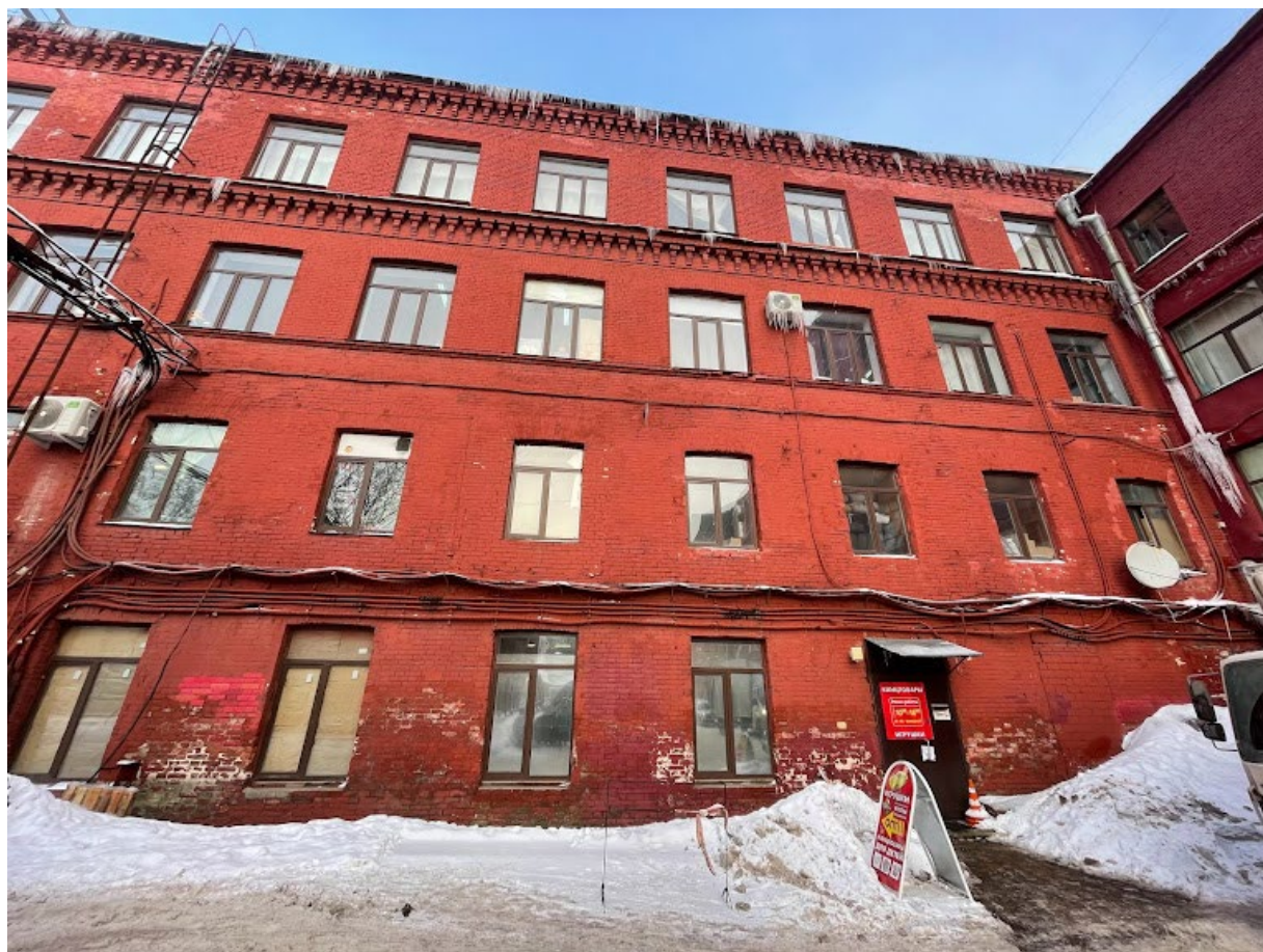
23. Фрагмент южного фасада ткацкого корпуса
