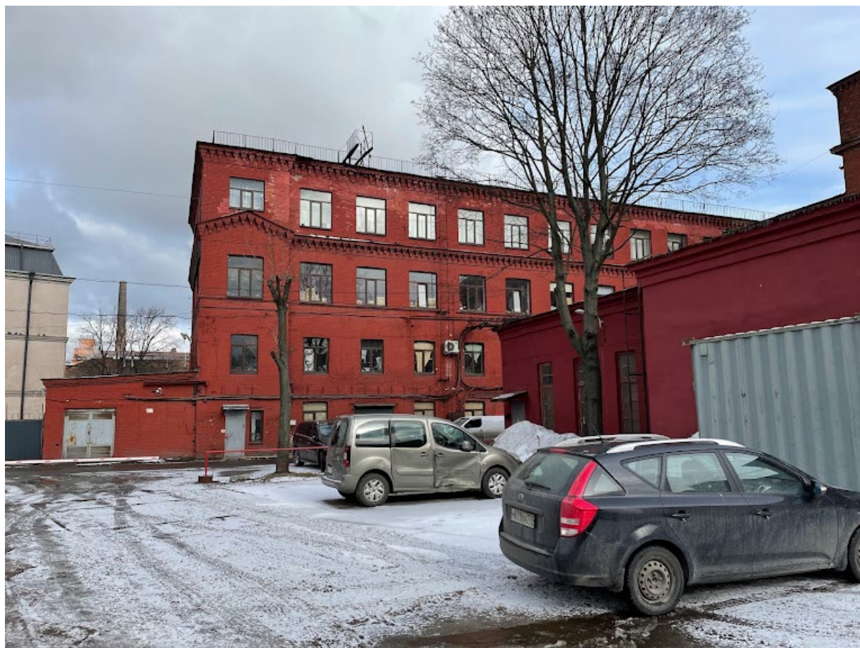
21. Фрагмент южного фасада ткацкого корпуса
