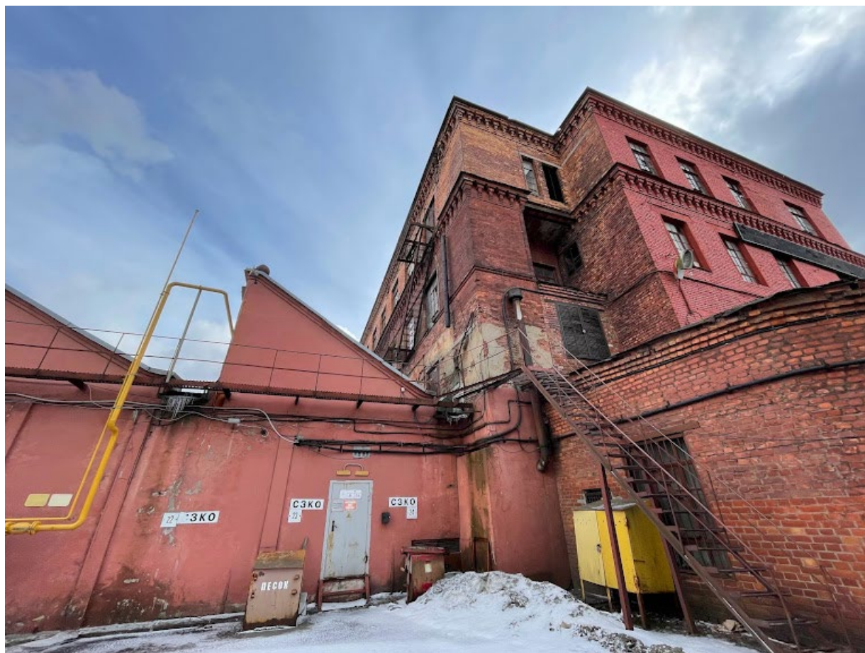
19. Вид на северо-западный угол ткацкого корпуса
