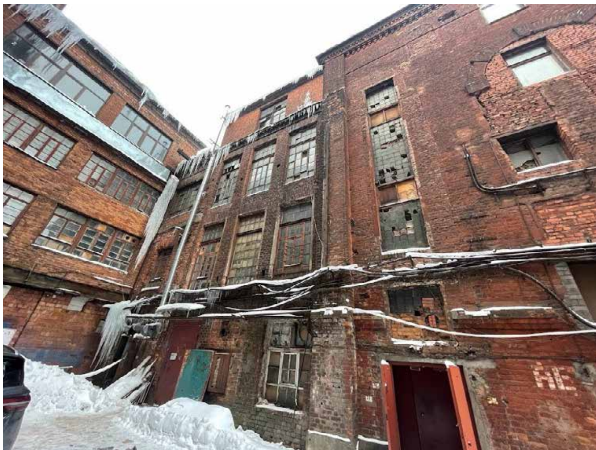
43. Фрагмент южного фасада прядильного корпуса
