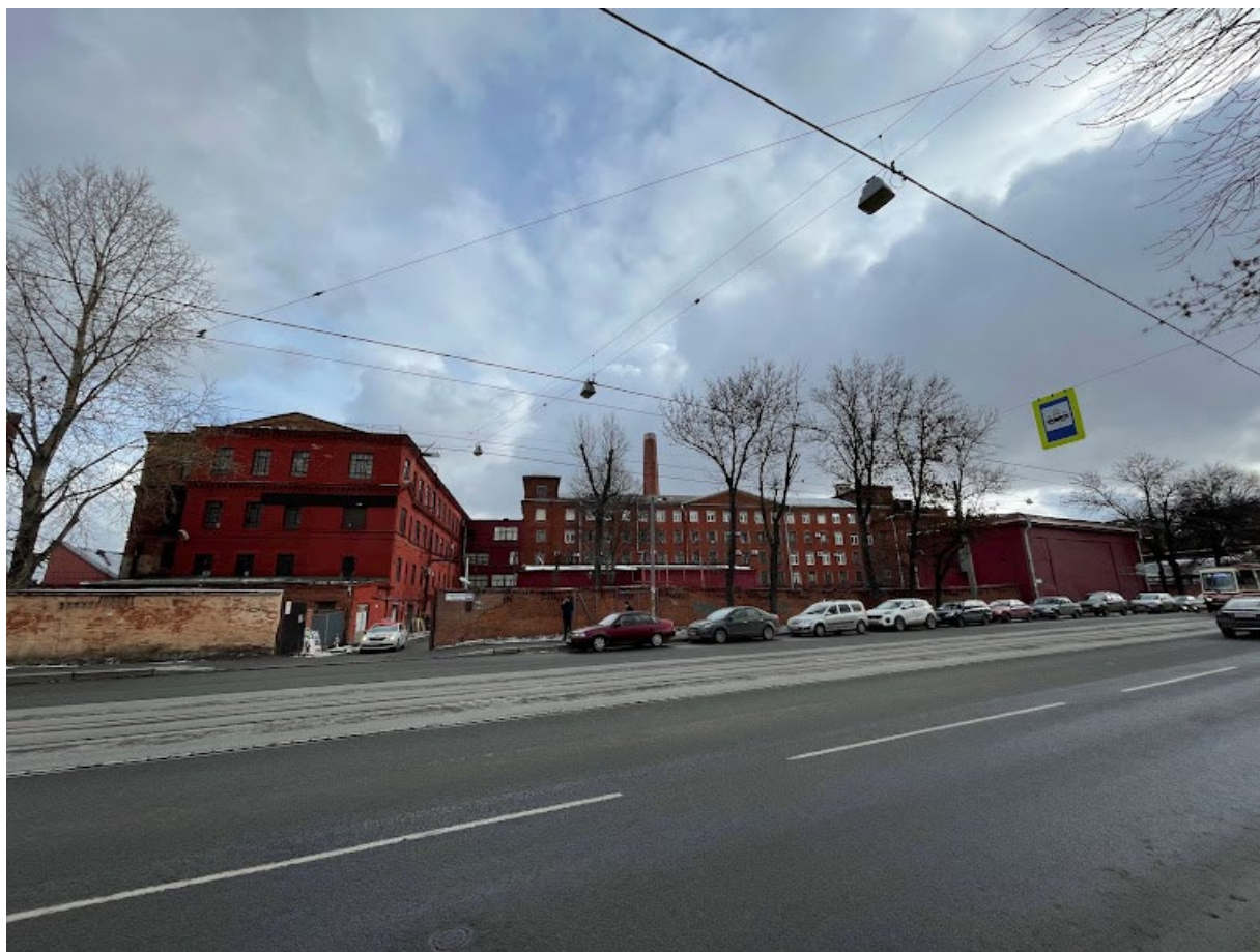
1. Общий вид с проспекта Обуховской обороны
