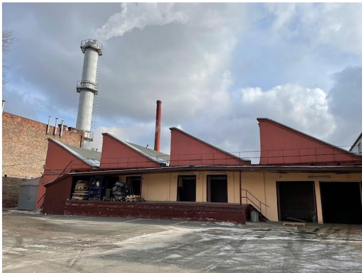
5. Фрагмент западного фасада шедового корпуса
