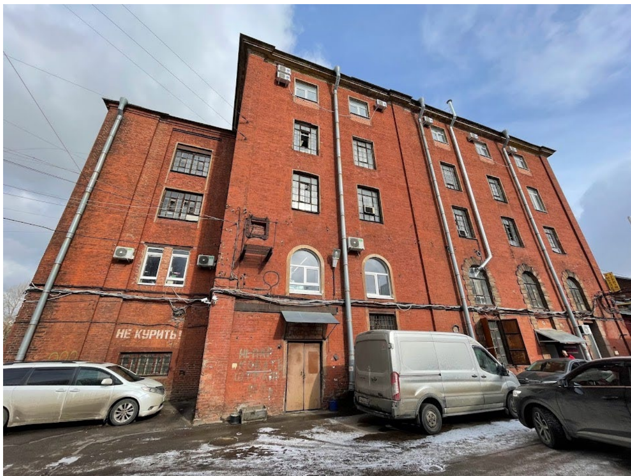
27. Фрагмент южного фасада прядильного корпуса
