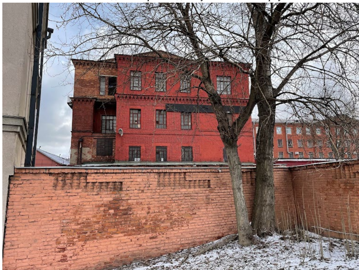
20. Вид на торцевой фасад ткацкого корпуса с проспекта Обуховской обороны
