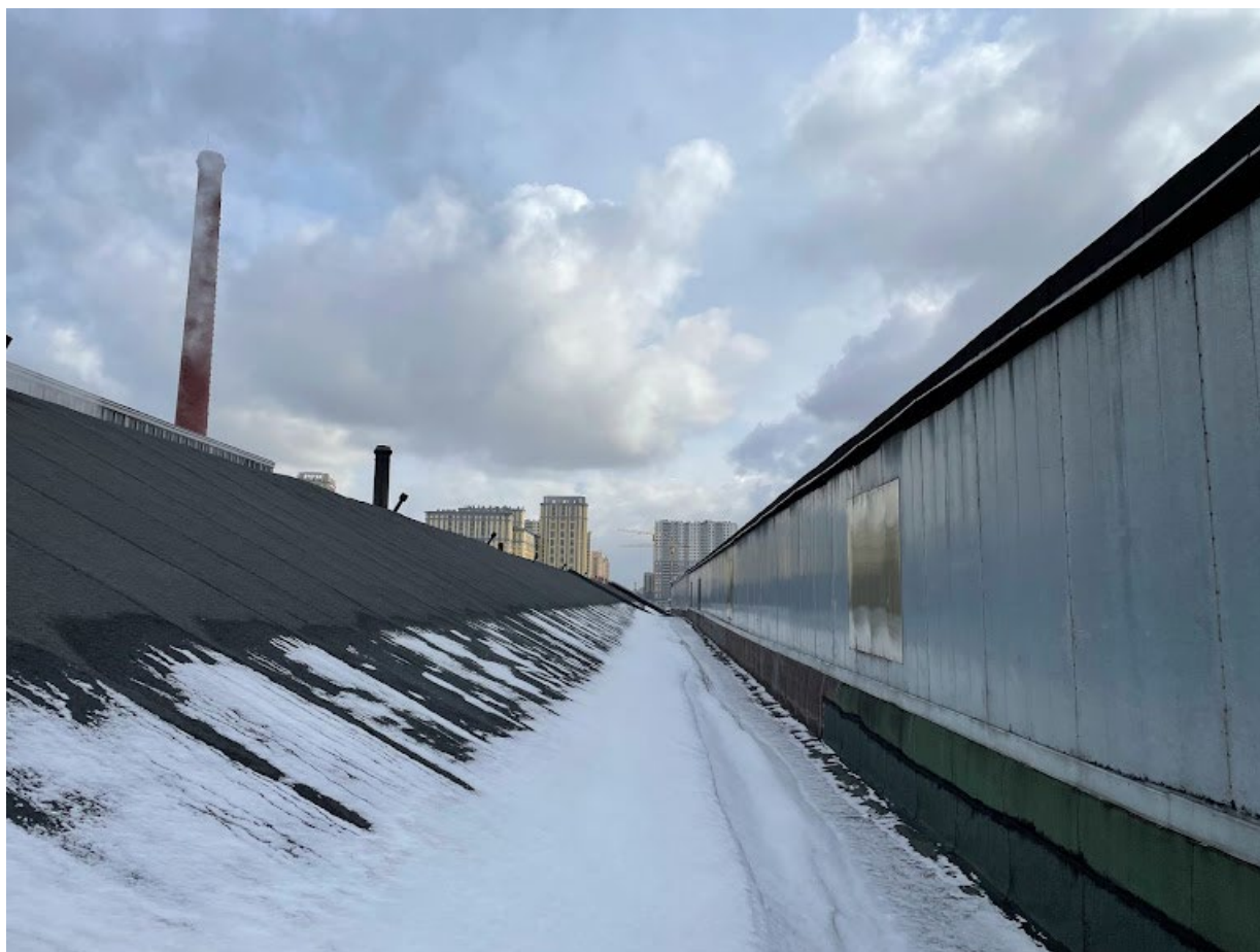
17. Фрагмент крыши шедового корпуса
