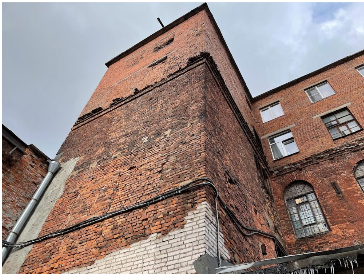
39. Фрагмент южного фасада ткацкого корпуса
