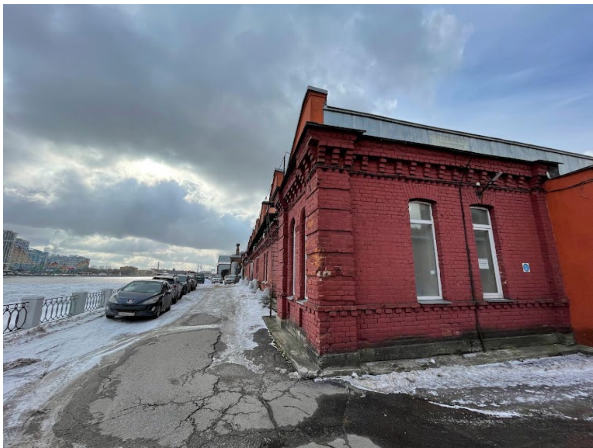
9. Вид на северо-восточный угол шедового корпуса
