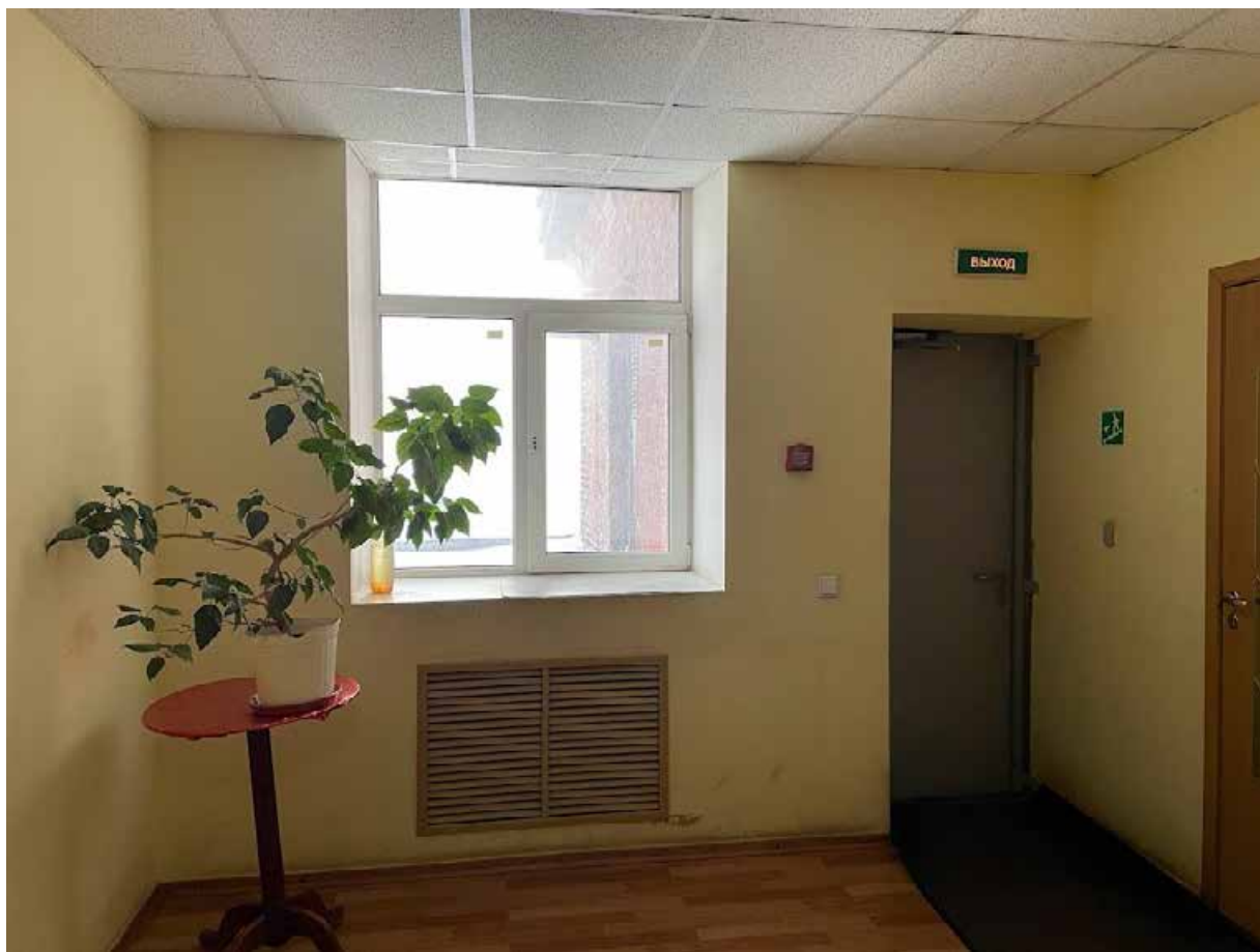
152. Фрагмент интерьера пятого этажа
