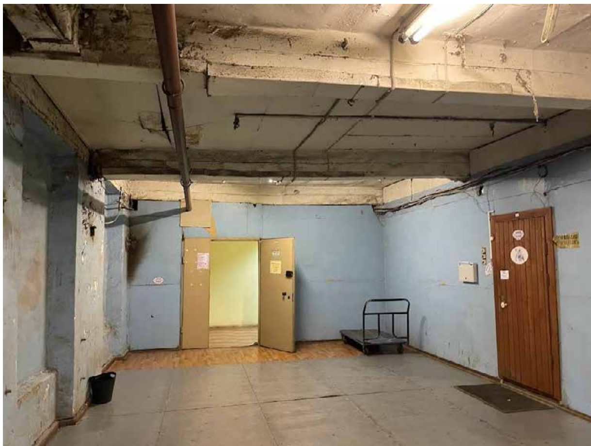
166. Фрагмент интерьера пятого этажа
