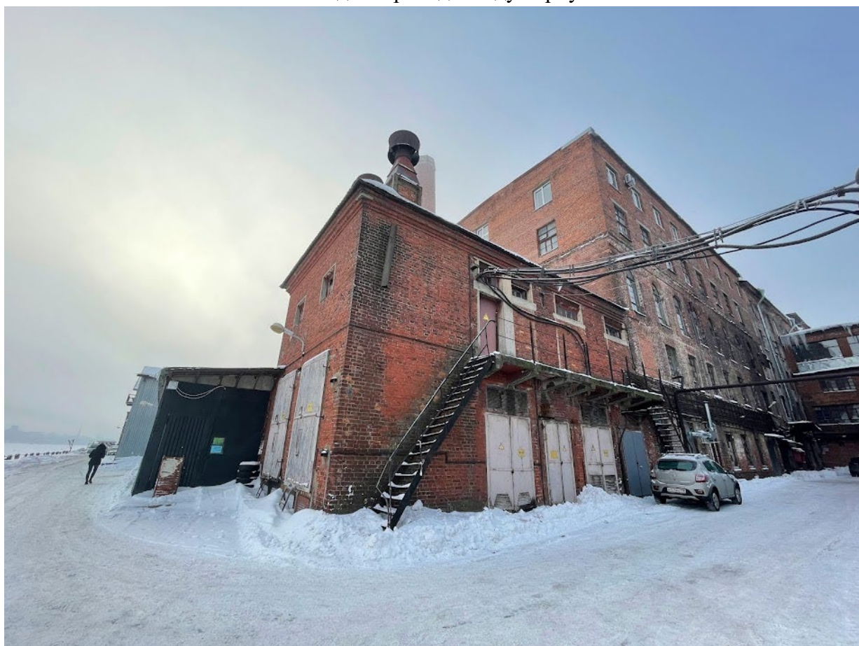
50. Вид на северо-восточный угол прядильного корпуса
