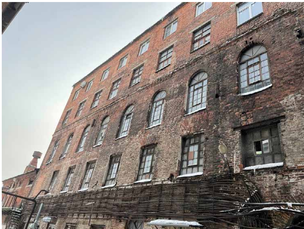
45. Фрагмент северного фасада прядильного корпуса
