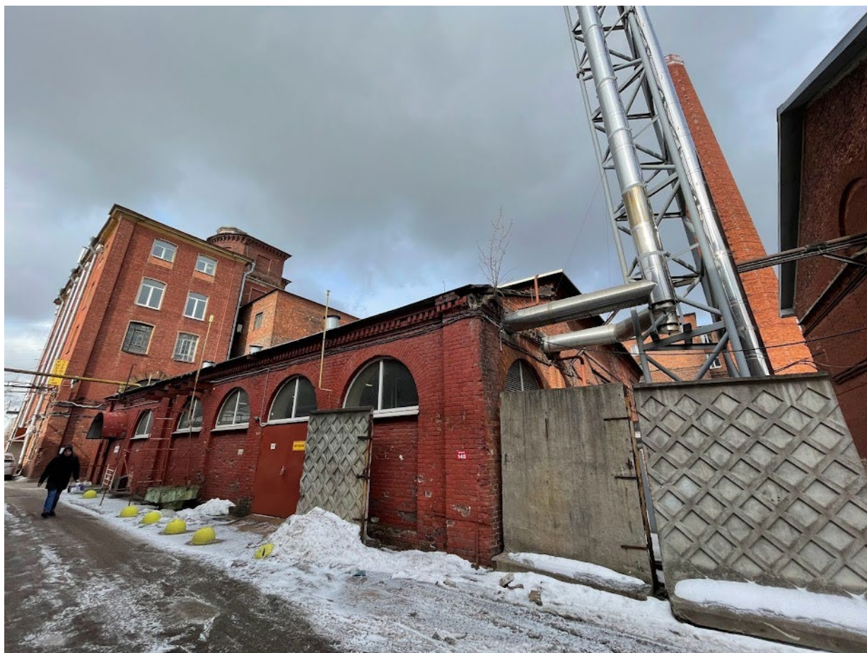
29. Фрагмент южного фасада прядильного корпуса
