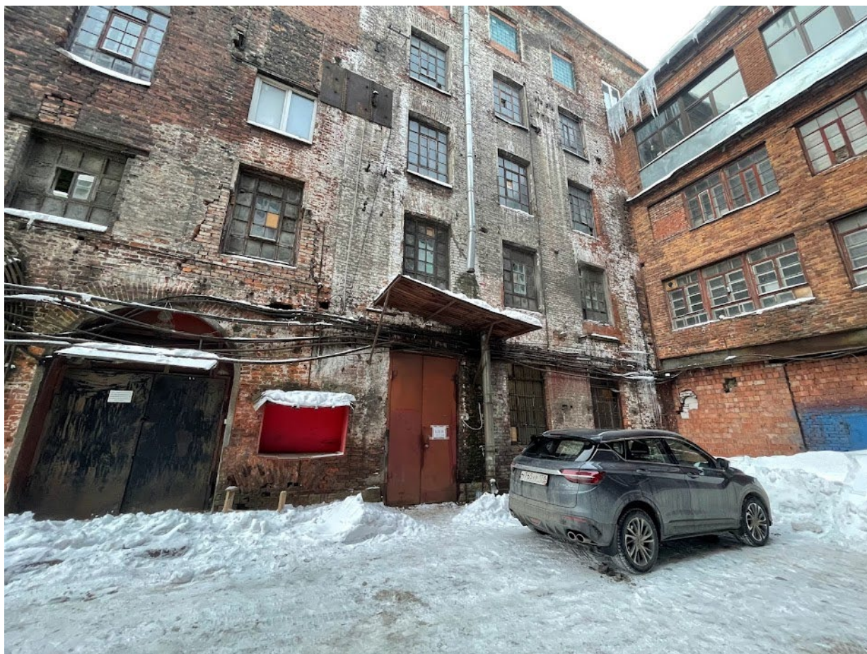
41. Фрагмент северного фасада прядильного корпуса
