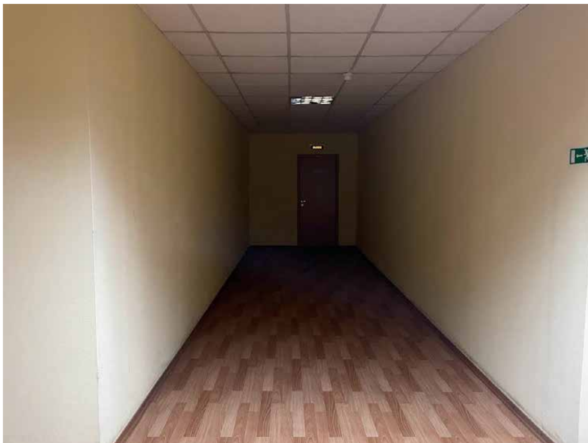
160. Фрагмент интерьера пятого этажа
