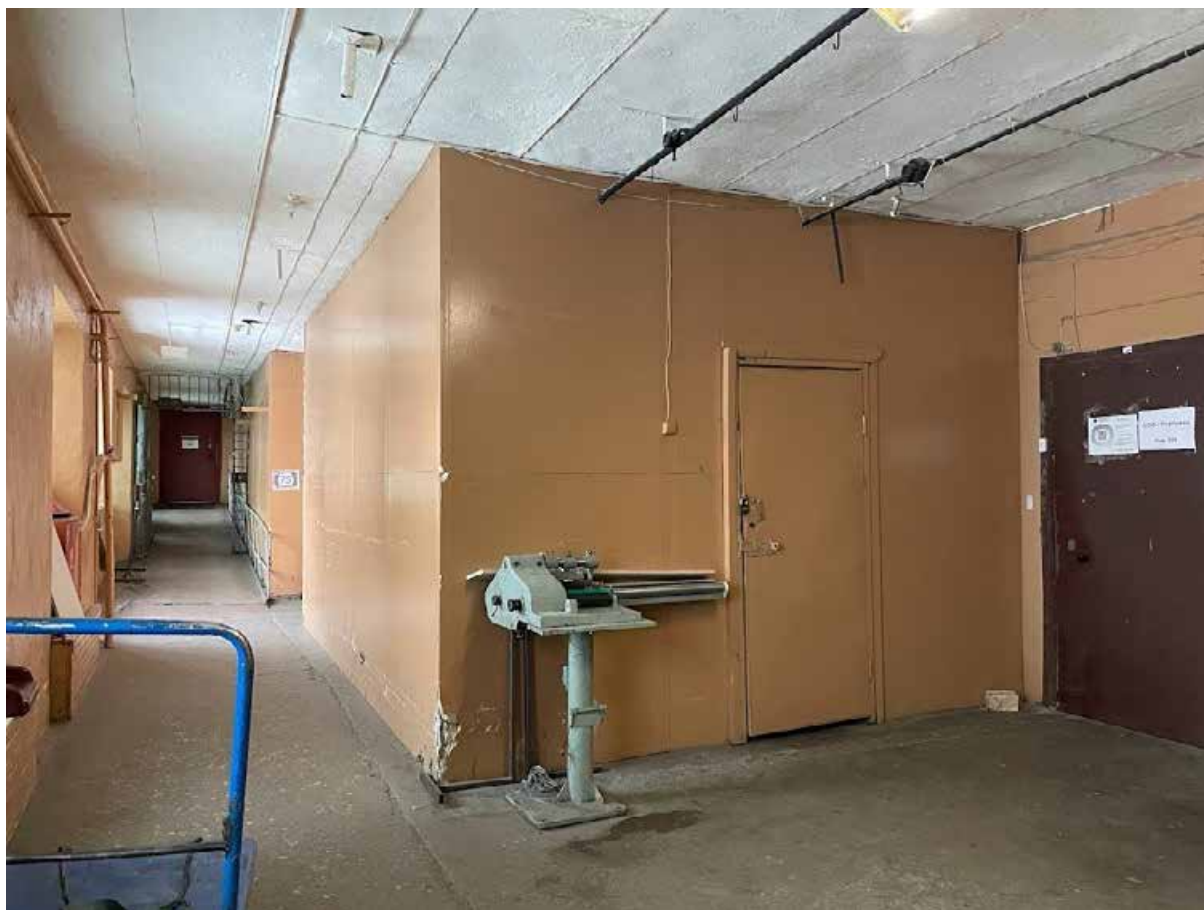
170. Фрагмент интерьера пятого этажа
