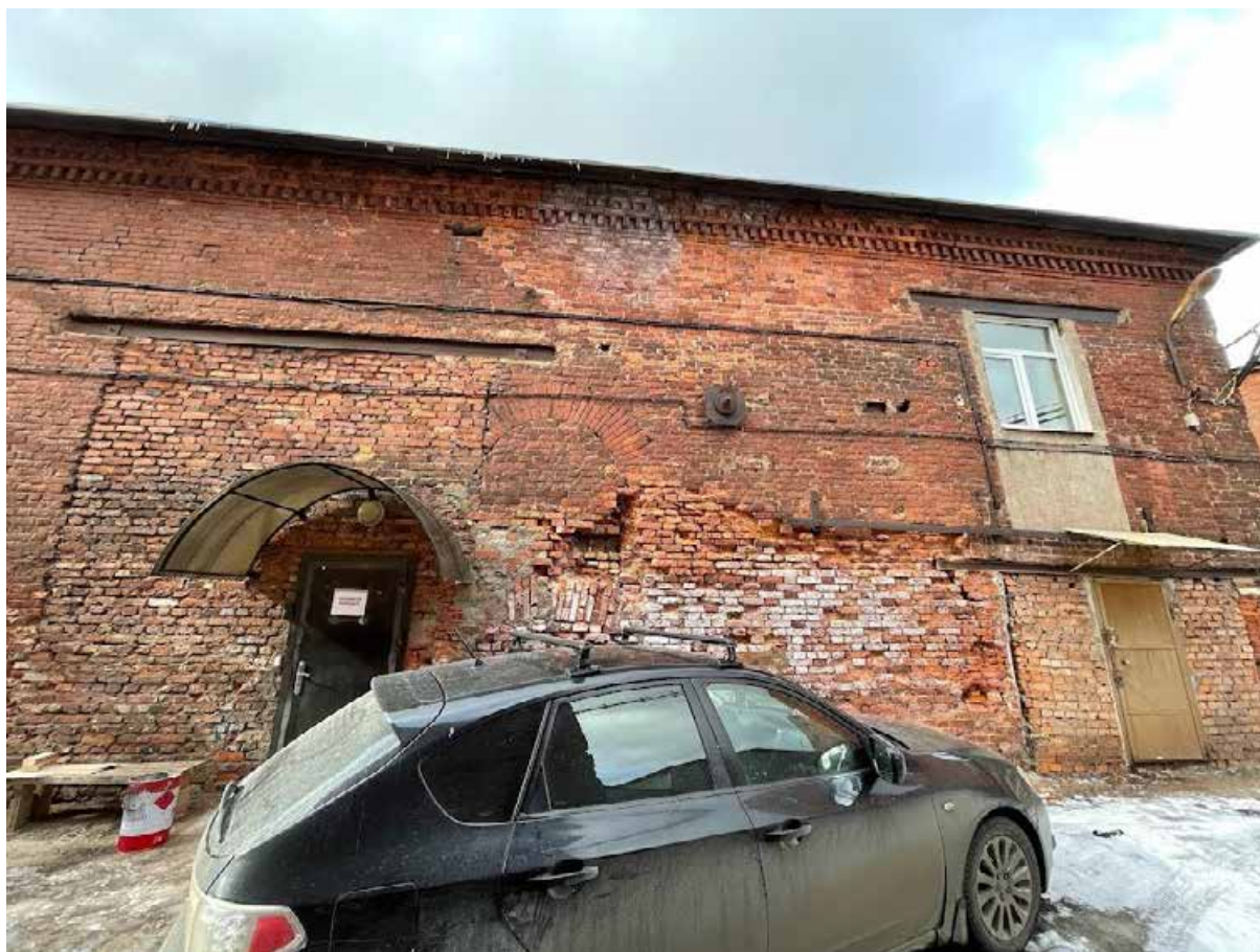
31. Фрагмент восточного фасада
