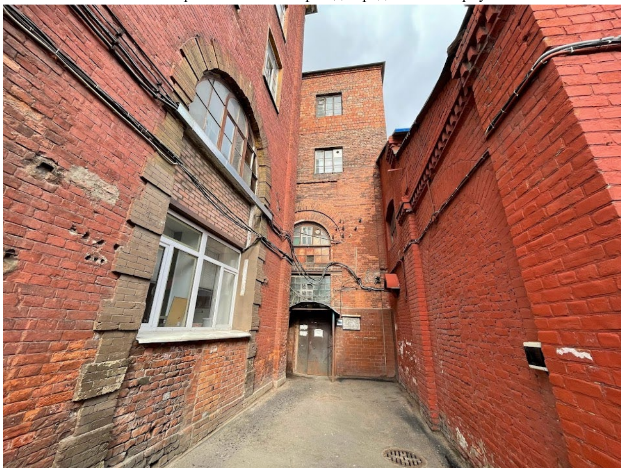
28. Фрагмент южного фасада прядильного корпуса
