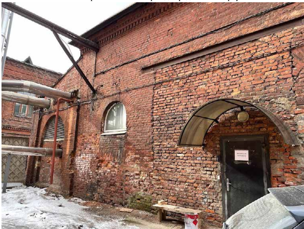
30. Фрагмент восточного фасада
