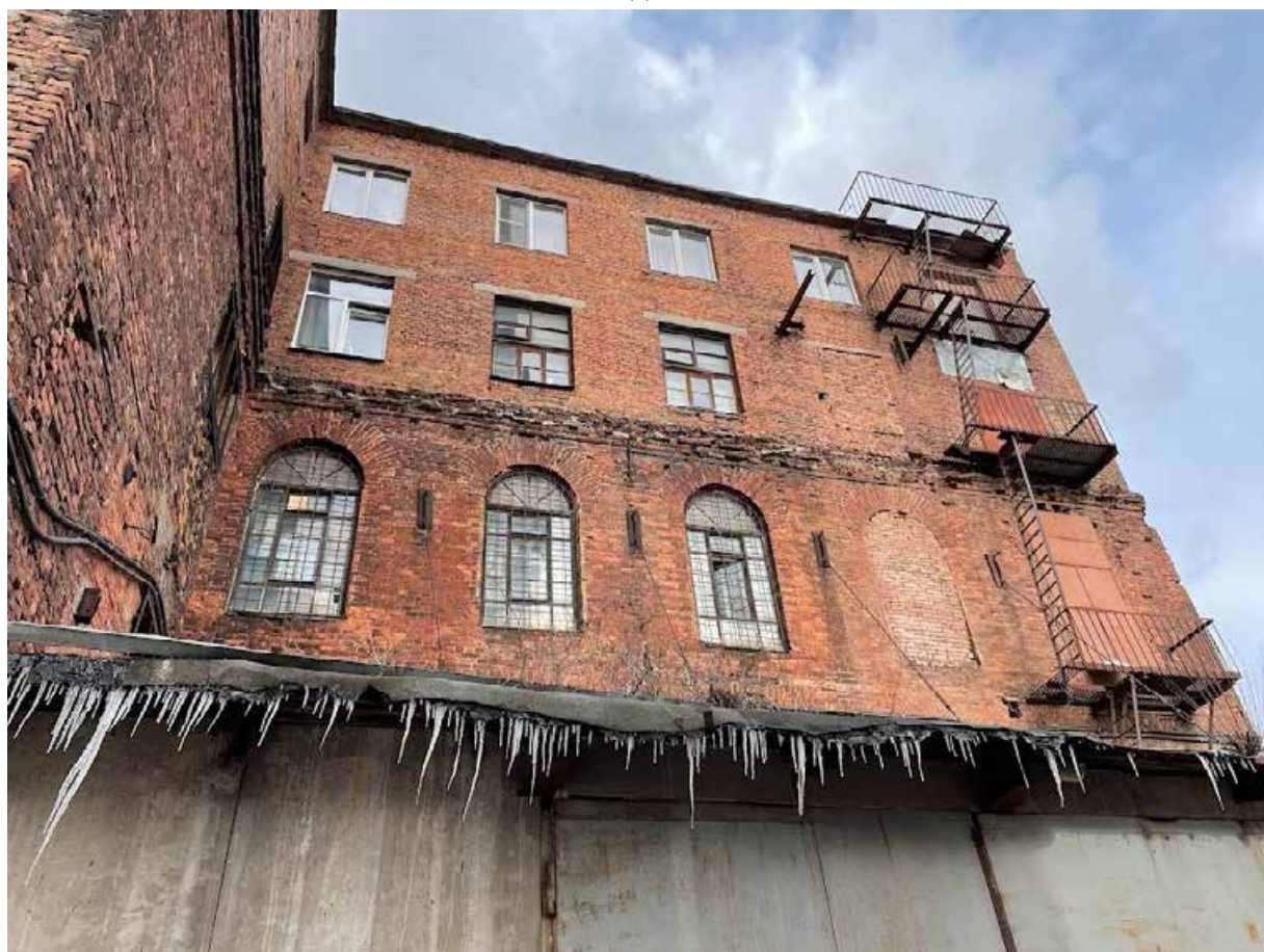
38. Фрагмент южного фасада ткацкого корпуса
