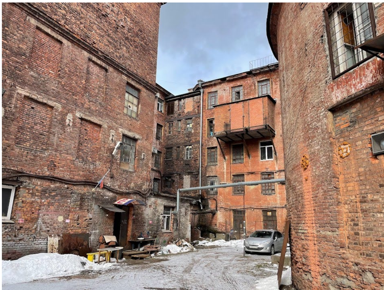
35. Фрагмент восточного фасада
