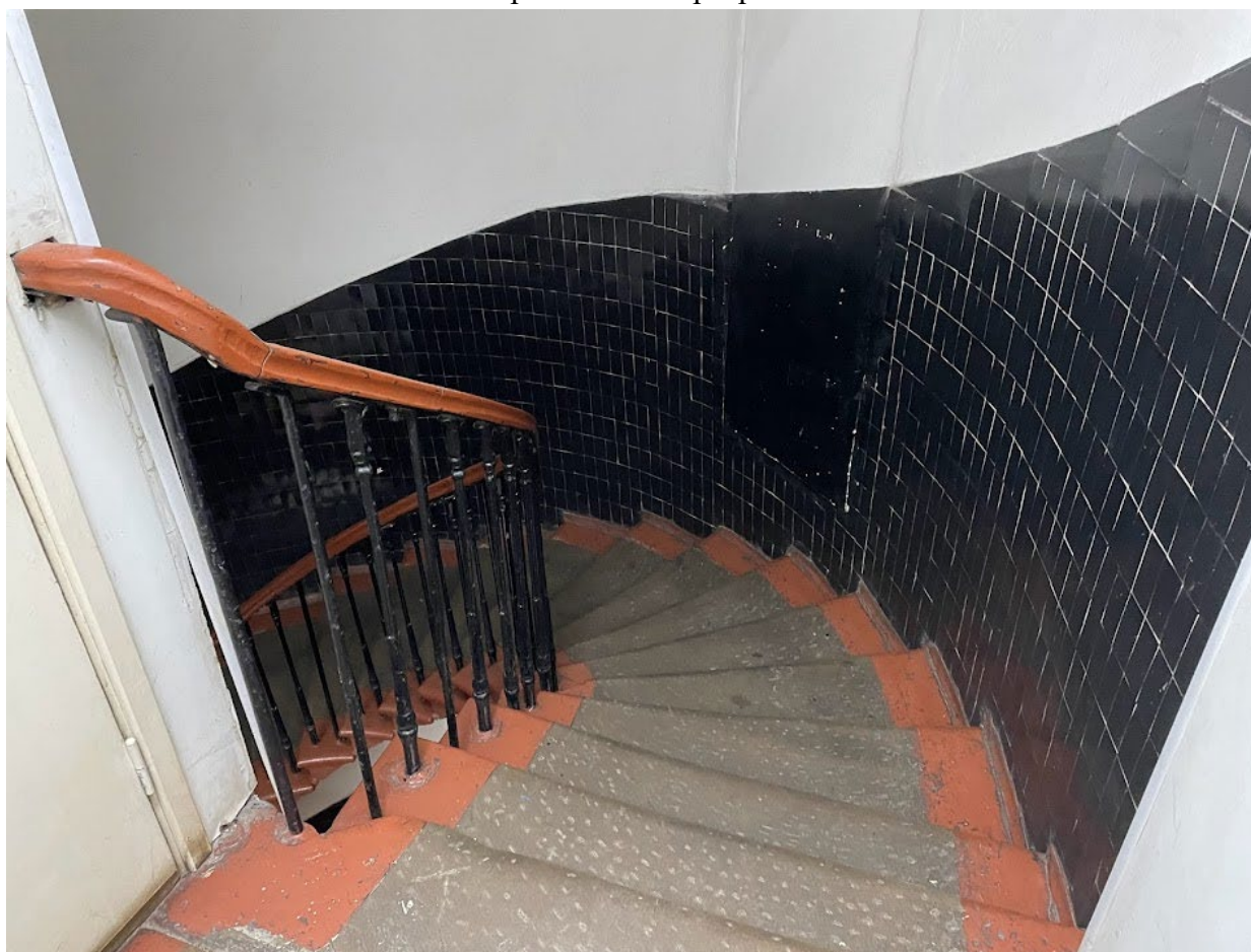
153. Фрагмент интерьера пятого этажа
