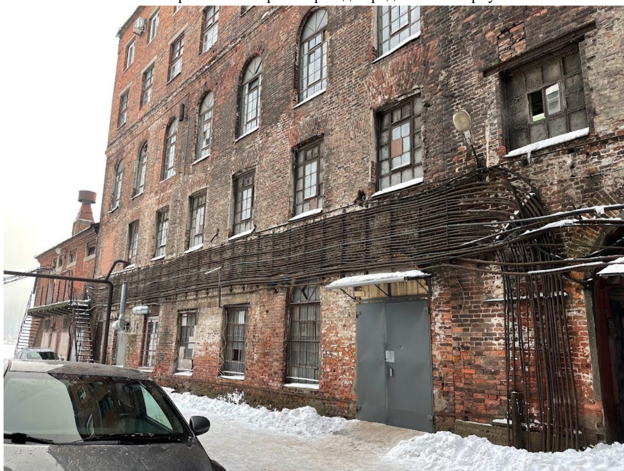
46. Фрагмент северного фасада прядильного корпуса
