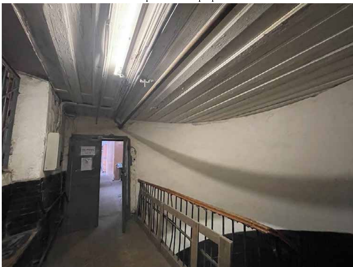
169. Фрагмент интерьера пятого этажа
