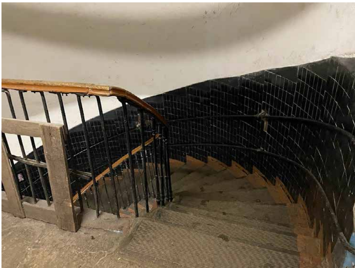
168. Фрагмент интерьера пятого этажа
