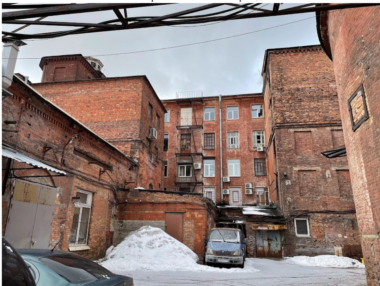
36. Фрагмент восточного фасада
