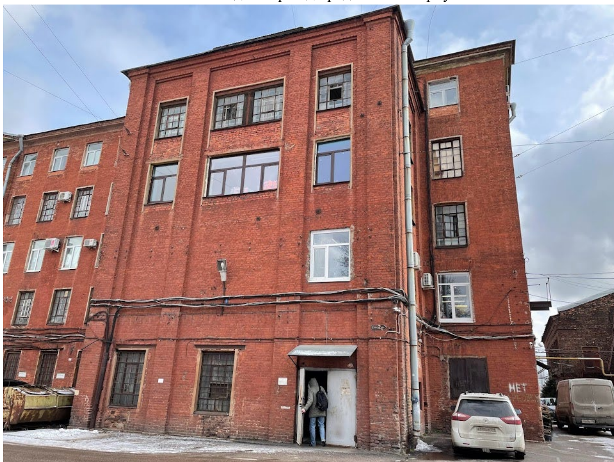
26. Фрагмент западного фасада прядильного корпуса
