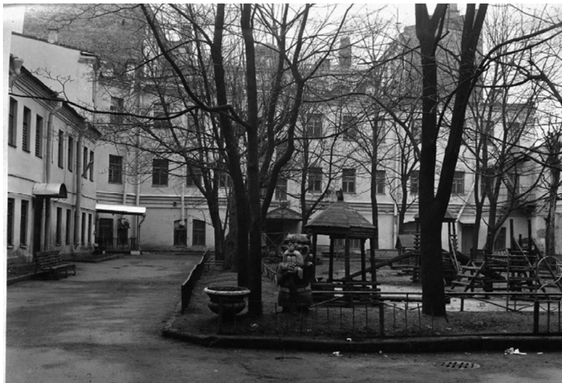
60. 2-й хоз. двор. западный фасад замыкающего восточного флигеля 1895. Фото 1995. Архив КГИОП.
