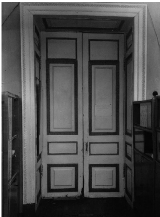
71. Дверь в золотую гостиную. Фото 1995. Архив КГИОП.
