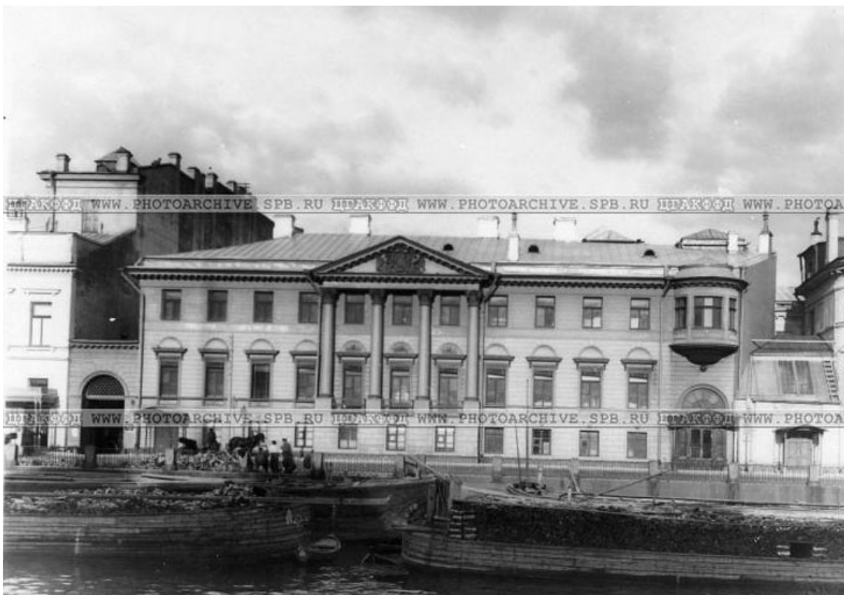
31. Дом № 18 по наб. р Фонтанки. Справа: фрагмент фасада дома №20. ЦГАКФФД СПб. ШифрЕ 7193. 1909 г.
