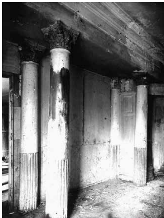
64. Колонны в главном парадном вестибюле. Фото 1946. Архив КГИОП.
