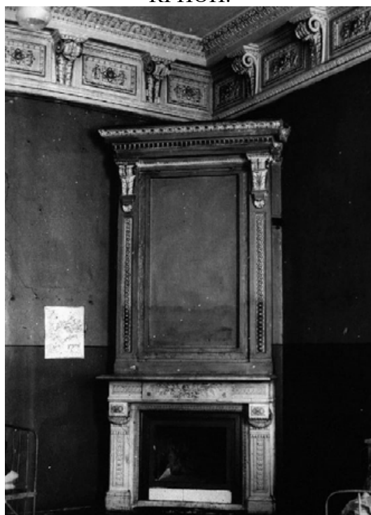
68. Главный корпус. Камин в золотой гостиной. Фото 1978. Архив КГИОП.
