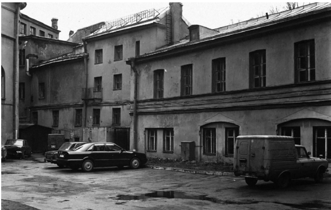
57. 1-й двор, церковный и кухонный флигель. Фото 1995 С. Архив КГИОП.
