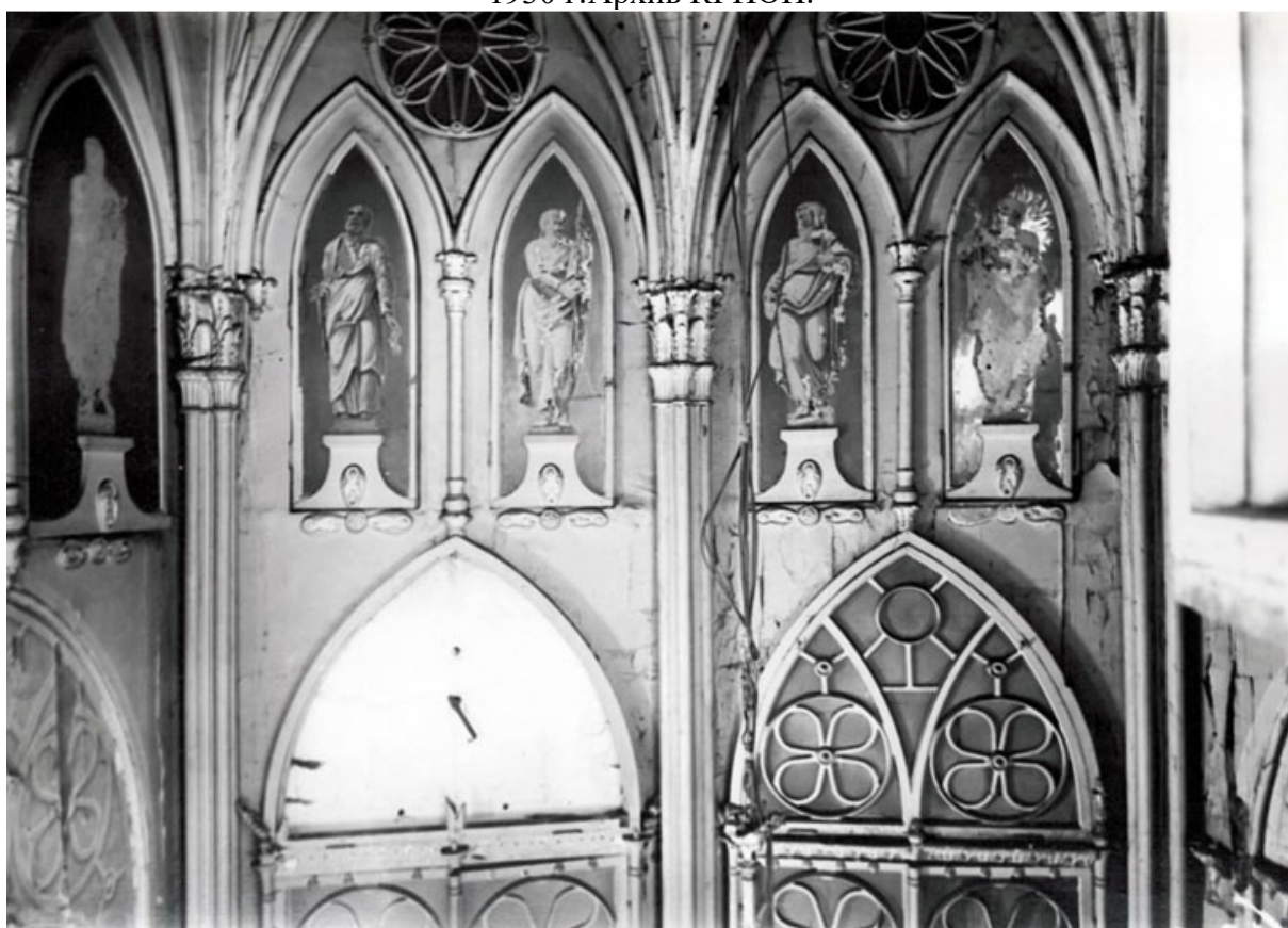
45. Бывшая домовая церковь. Верхний ярус притвора. Фотография 1930 г. Архив КГИОП
