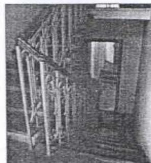
двухмаршевая лестница (помещения 1-Н (38,39,51)) с маршами по косярам, с известняковыми ступенями, с металлическим ограждением из секций с вертикальными стойками, с деревянными профилированными поручнями.
