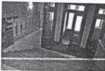
двухмаршевые лестницы дворового корпуса (литера В) с маршами по косярам, с известняковыми ступенями с валиком, с металлическим ограждением лестницы из секций с рисунком из полуovalов и завитков в стиле модерн, с деревянными профилированными поручнями; с площадками, облицованными метлахской плиткой с рисунком «соты» белого и черного цветов;
