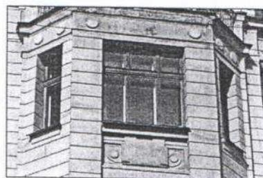
перемычки оконных проемов в виде открытых металлических балок с накладными коваными розетками;
