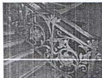
двухмаршевые лестницы (Л-3, Л-4) с маршами по косоурам, с известняковыми ступенями, с металлическим ограждением лестницы из секций с рисунком из полуovalов и завитков в стиле модерн, с деревянными профилированными поручнями;
