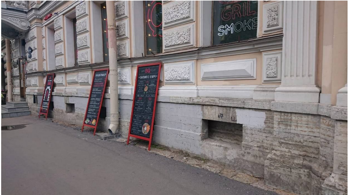
2. Фрагмент лицевого фасада. Вид со стороны ул. Ломоносова. Дата съемки 05.04.2021 г.
