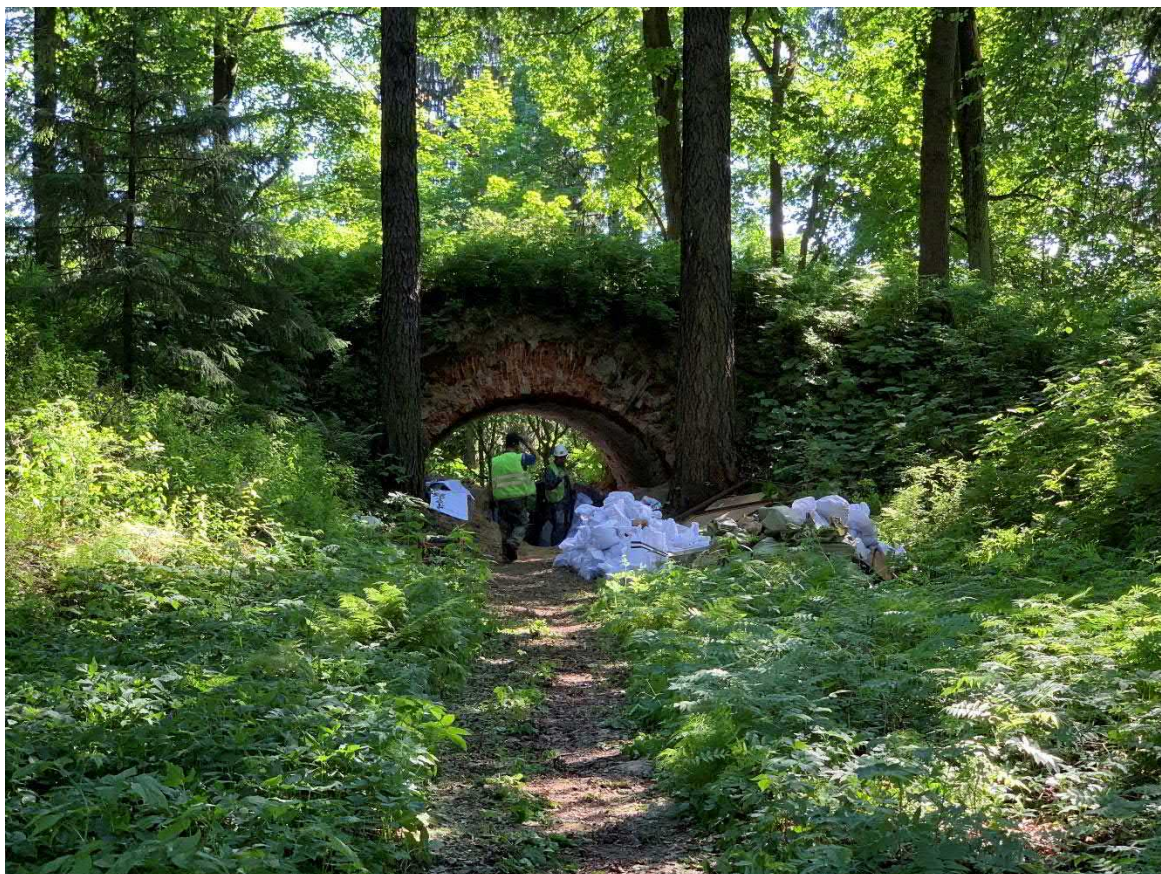
Фото 1. Туфовая арка. Северный вход
