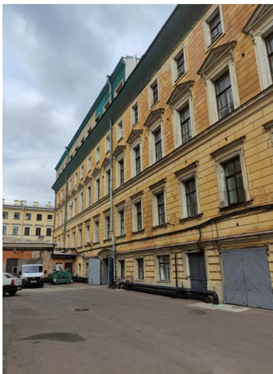
Фото 6. Фрагмент дворового фасада объекта культурного наследия федерального значения «Корпус для прислуги», входящего в состав объекта культурного наследия федерального значения «Дворец Великого князя Николая Николаевича (Ксенинский институт)» (дата фотофиксации: 08.10.2021)
