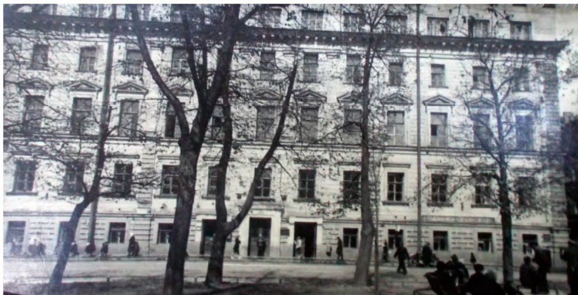
42. Фасад корпуса для прислуги со стороны бульвара Профсоюзов. 1951 г. — Архив КГИОП.
