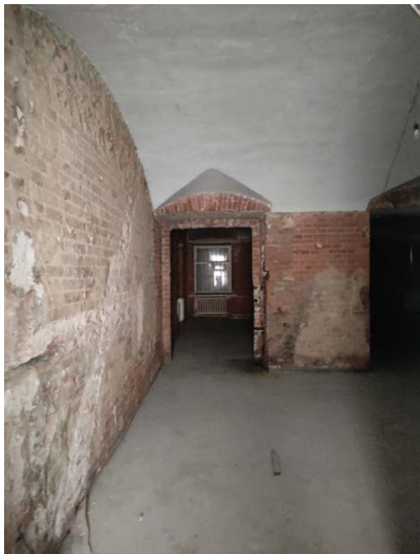
Фото 12. Интерьер квартиры №11, ч.п.№1, вид на ч.п.№3(дата фотофиксации: 08.10.2021)
