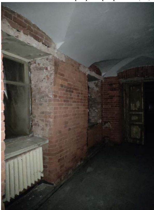
Фото 15. Интерьер квартиры 12, ч.п.№ 4, вид на ч.п.№ 7(дата фотофиксации: 08.10.2021)
