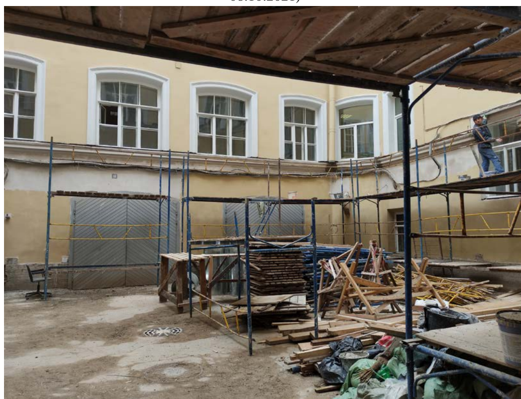
Фото 10. Фрагмент дворового фасада объекта культурного наследия федерального значения «Корпус для прислуги», входящего в состав объекта культурного наследия федерального значения «Дворец Великого князя Николая Николаевича (Ксенинский институт)» (дата фотофиксации: 08.10.2021))
