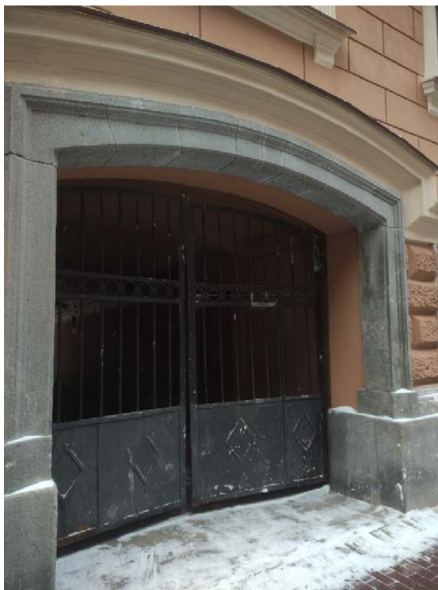
Фото 3. Воротный проезд лицевого фасада объекта культурного наследия федерального значения «Корпус для прислуги», входящего в состав объекта культурного наследия федерального значения «Дворец Великого князя Николая Николаевича (Ксенинский институт)», вид со стороны Замятина переулка (дата фотофиксации: 10.12.2021)
