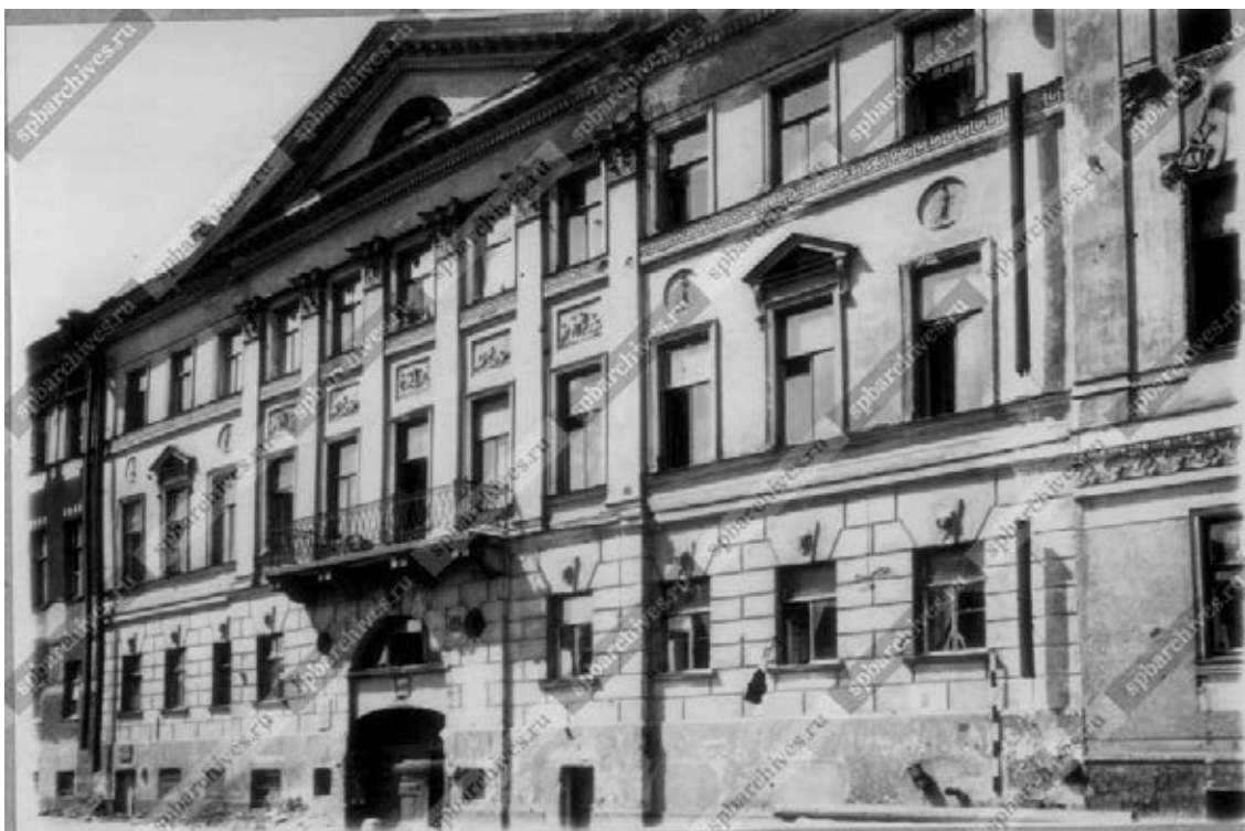
14. Фасад дома №87 на набережной реки Фонтанки. Дата съемки: 1949 г. Архив: ЦГАКФФД СПб. Архивный шифр: ЦГАКФФД СПб Гр 71621.
