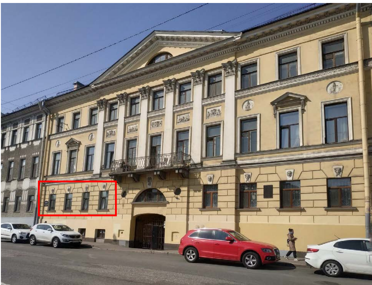
Фото 2. Лицевой фасад объекта культурного наследия «Дом Х.Г. Лебедева». Окна кв. № 1. Вид с набережной реки Фонтанки.
