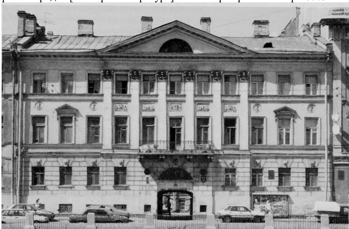
19. Дом Галашевских (Дом В. Я. Лебедева). Дата съемки: 1980-е гг. Книга: «Памятники архитектуры и истории Санкт-Петербурга. Адмиралтейский район. Барокко и классицизм», С. 233.
