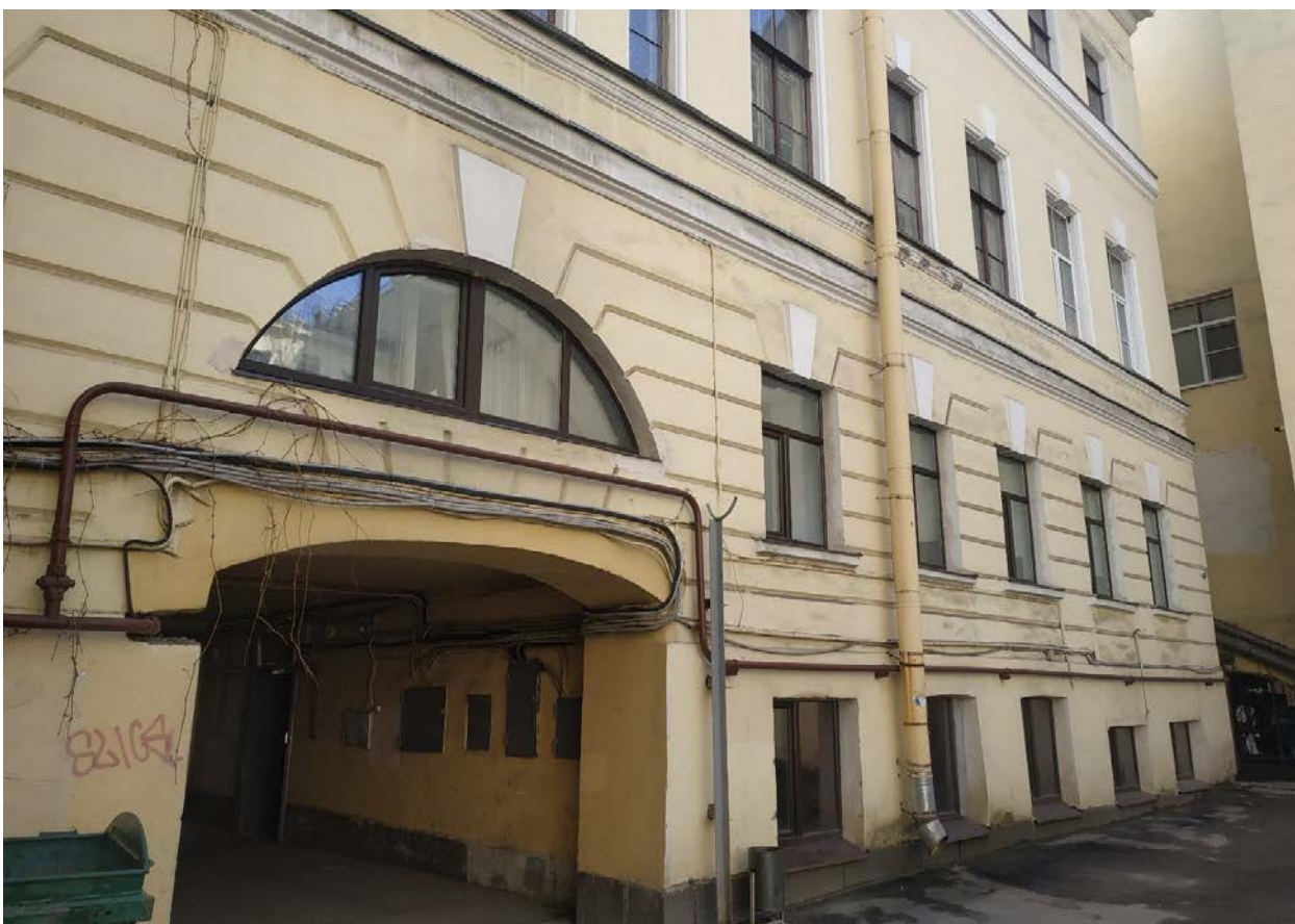
Фото 6. Фрагмент дворового фасада. Воротный проезд, ведущий на наб.реки Фонтанки.
