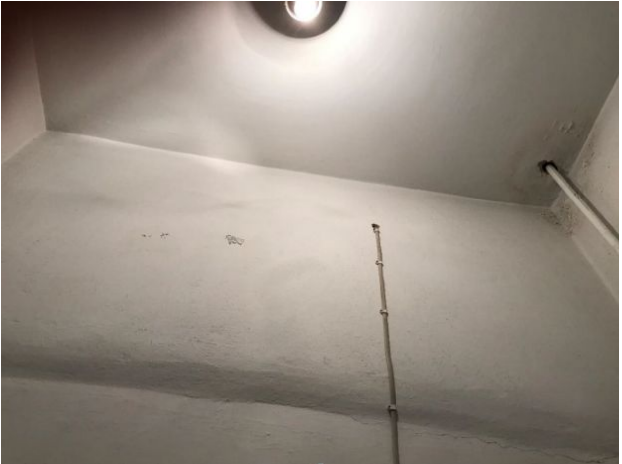
Фотография 24. Дефекты окрасочного слоя. Следы протечек.
