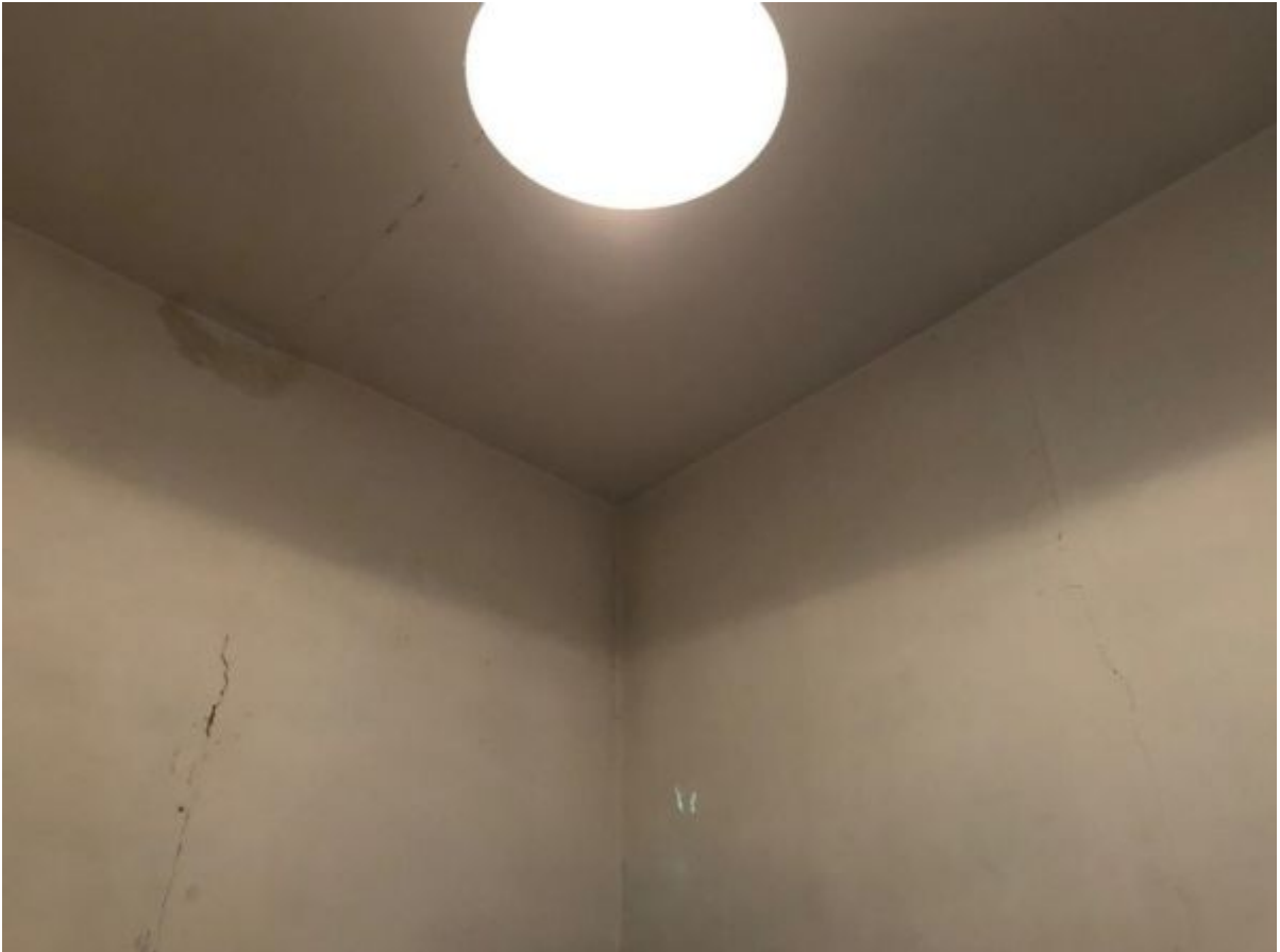
Фотография 29. Трещина на потолке кухни. Следы протечек. Дефекты окрасочного слоя.
