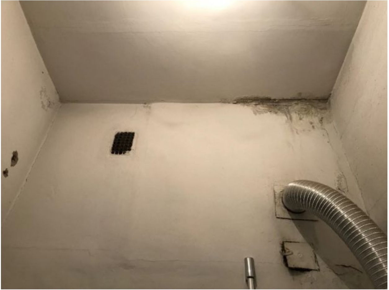
Фотография 23. Дефекты окрасочного слоя на потолке ванной. Следы протечек.
