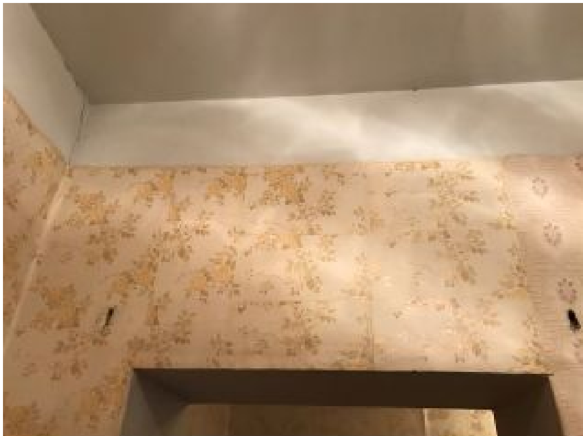
Фотография 45. Фрагмент комнаты (помещение №2). Трещина на потолке. Дефекты окрасочного слоя.
