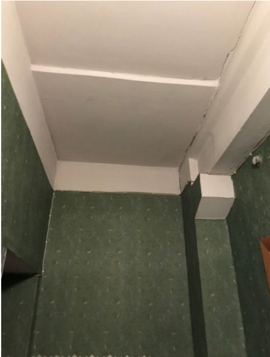
Фотография 12. Трещина на потолке в коридоре
