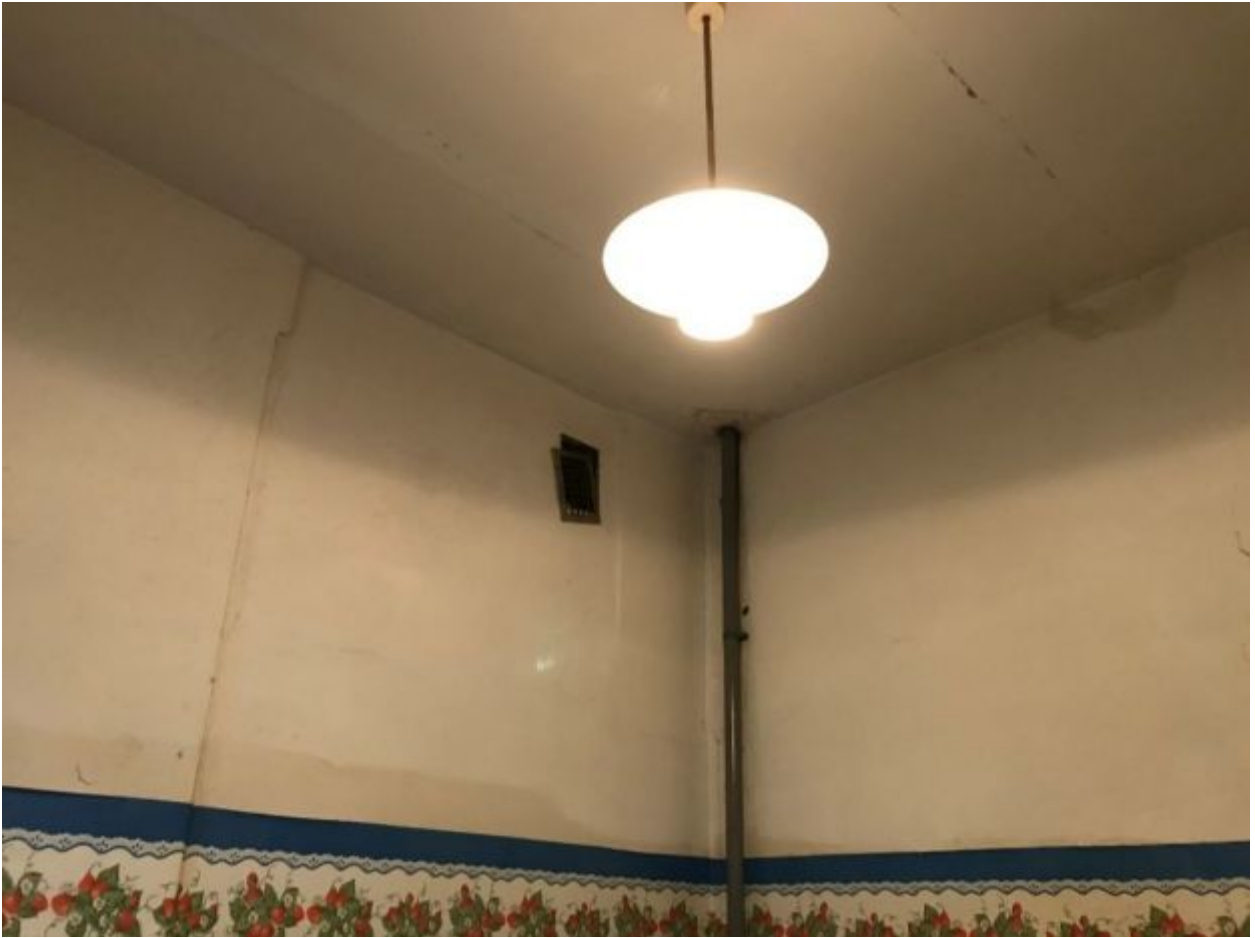
Фотография 28. Трещина на потолке кухни. Следы протечек. Дефекты окрасочного слоя.
