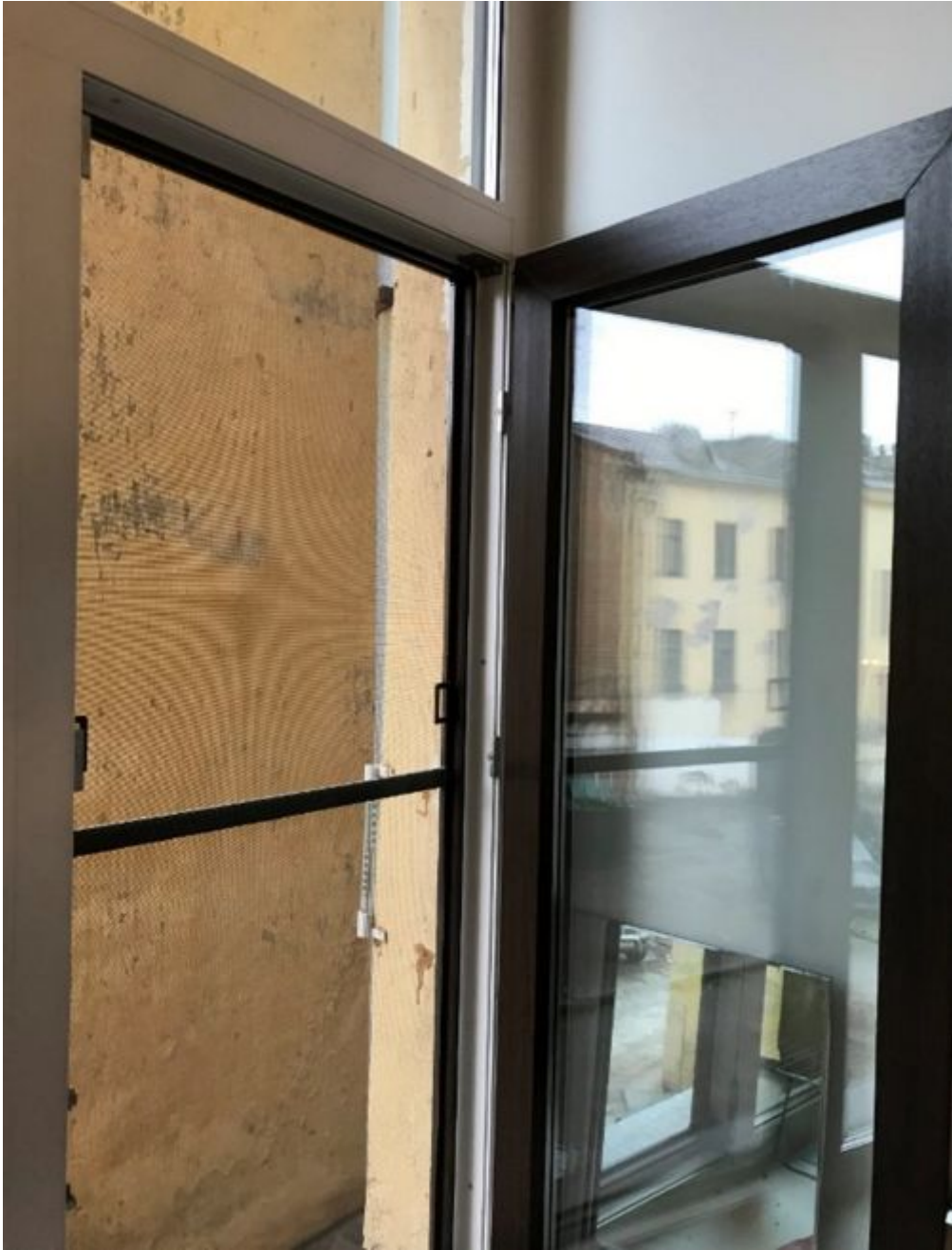
Фотография 27. Заполнение оконных проемов (металлопластик)
