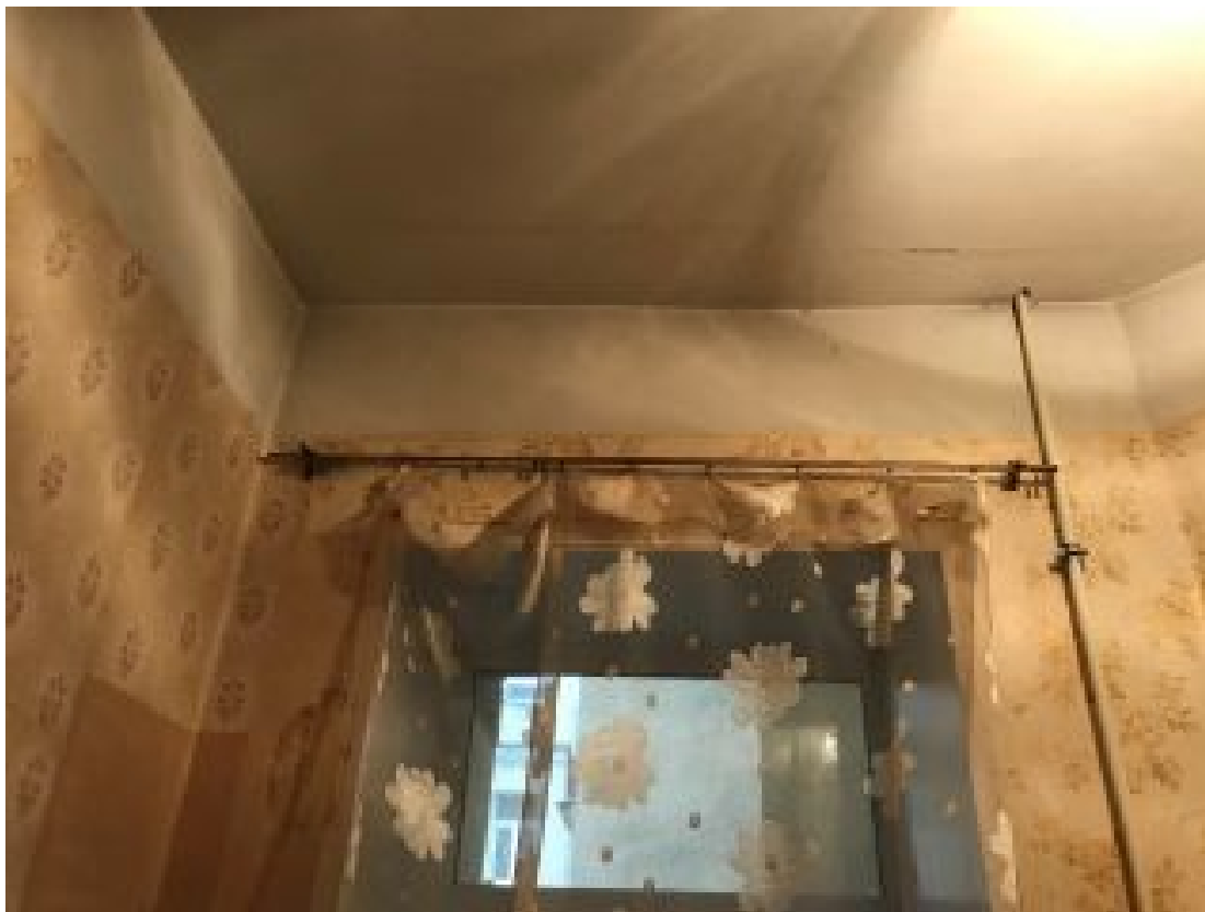
Фотография 43. Фрагмент комнаты (помещение №2). Трещина на потолке. Дефекты окрасочного слоя.
