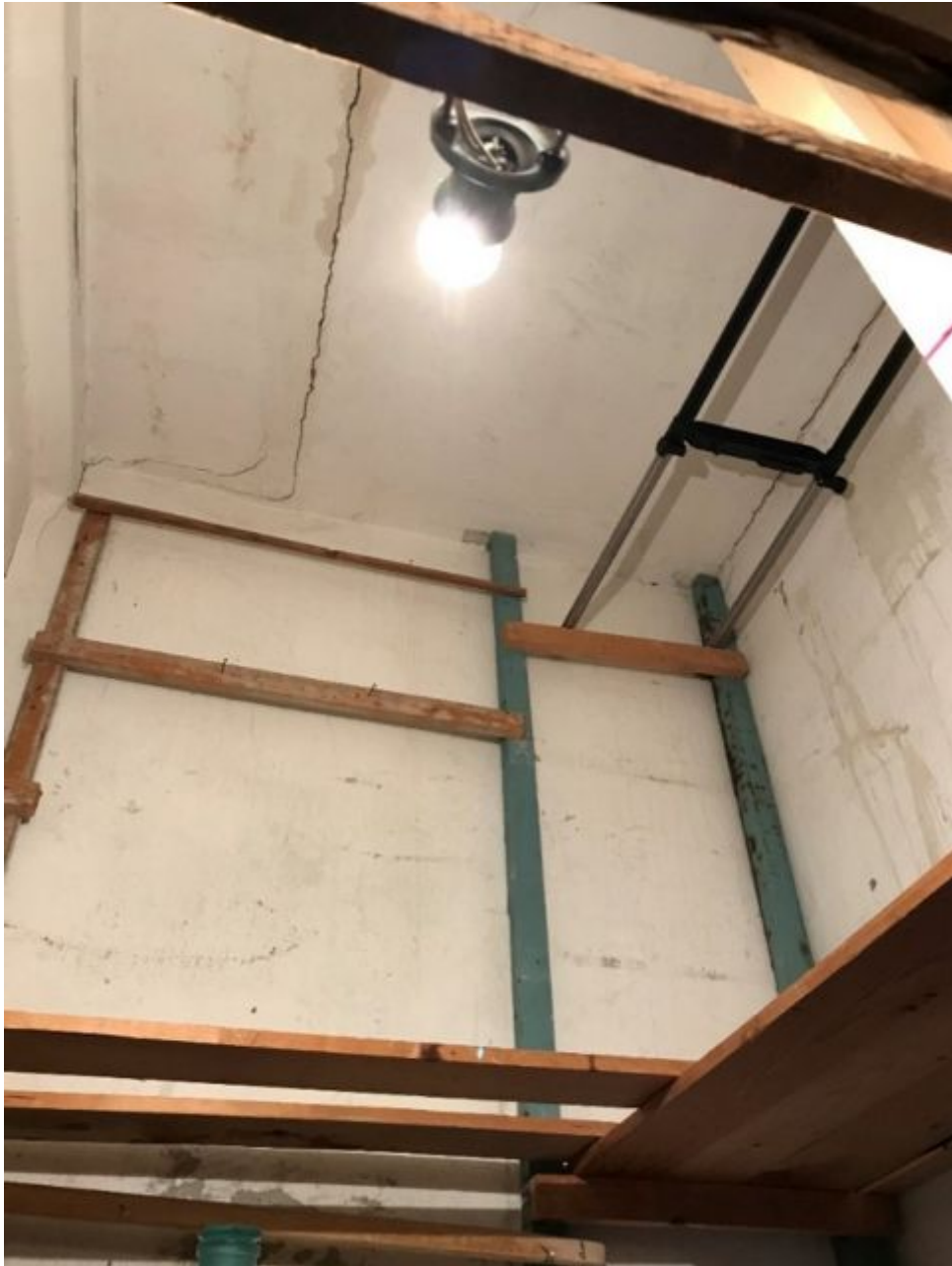
Фотография 19. Трещина на потолке кладовой. Следы протечек, замокания.
