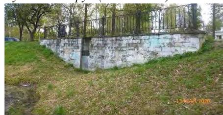
*Водосливная плотина на пруду*
