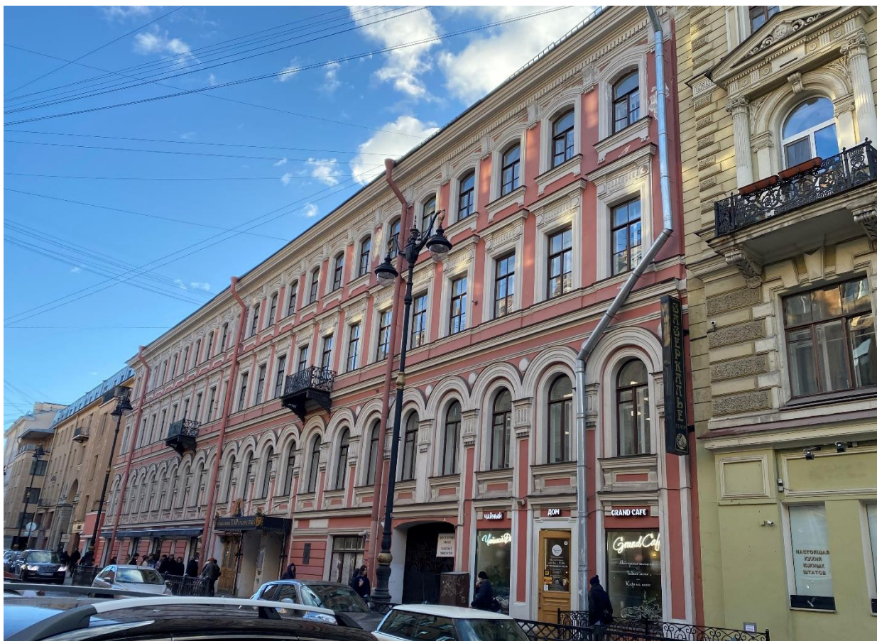
Фото 1. Общий вид на лицевой фасад с северо-востока
