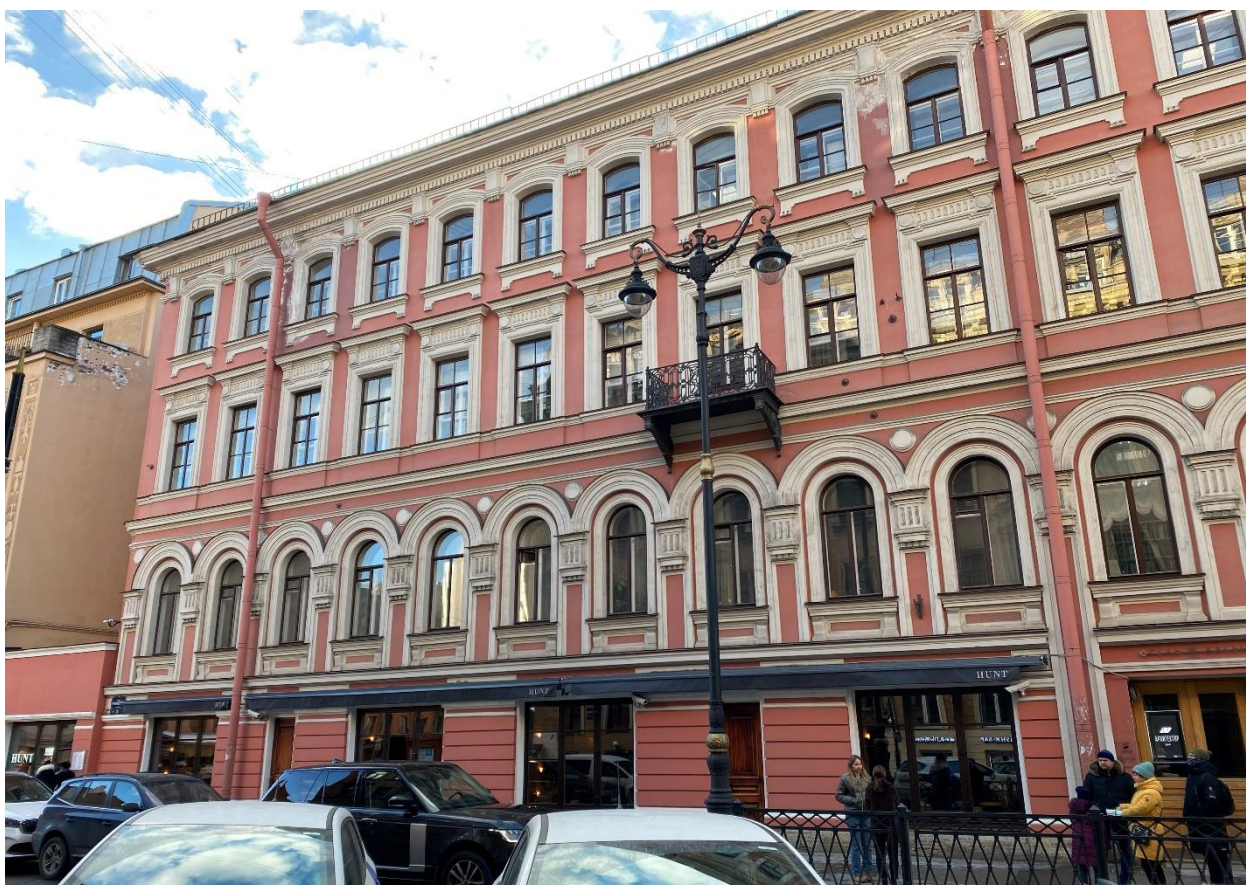
Фото 3. Южная часть лицевого фасада. Вид с востока
