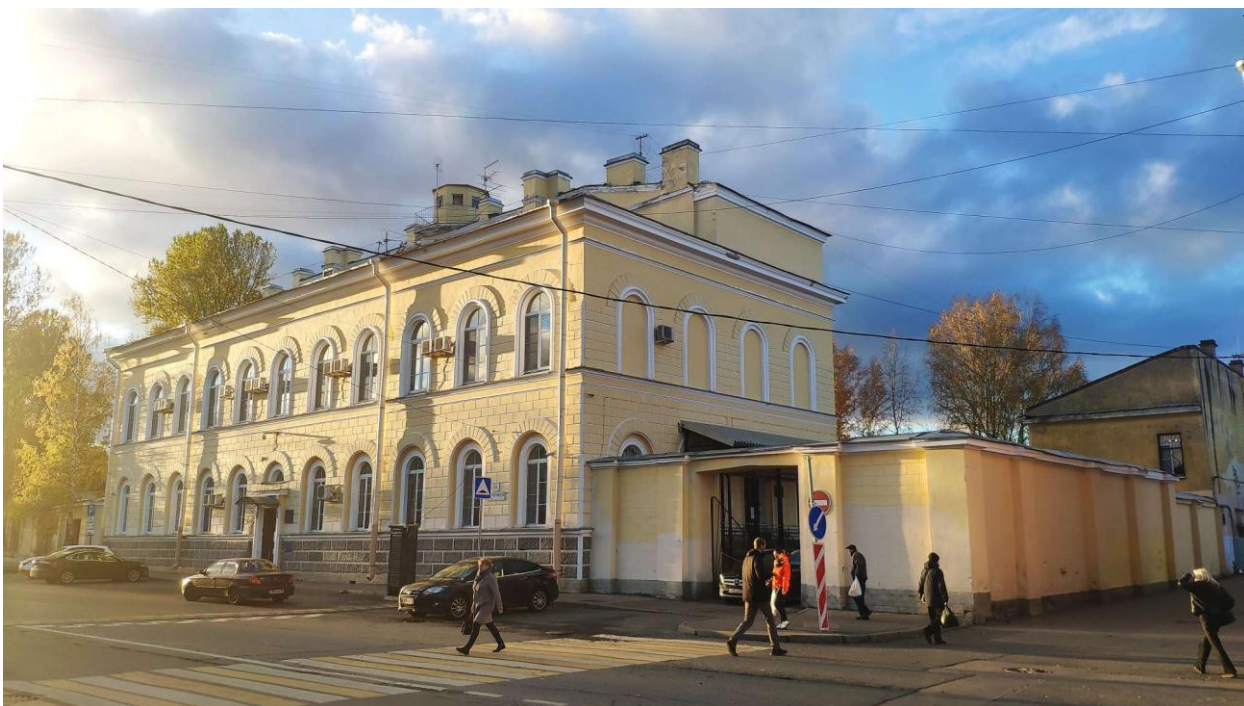
Фото 1. Общий вид объекта культурного наследия регионального значения «б.Здание Уездных присутственных мест»
