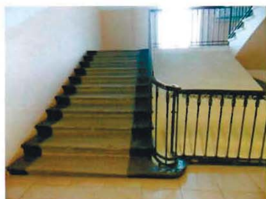
7, 8, 9. Внутренняя лестница по сводам.
