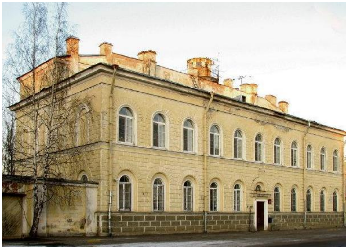
10. Бывшее здание уездных присутственных мест по адресу: г. Петергоф, Петергофская ул., д. 11. Лицевой фасад — Здание уездных присутственных мест / Citywalls.ru – архитектурный сайт Петербурга [Электронный ресурс]. URL: https://www.citywalls.ru/house19405.html .
