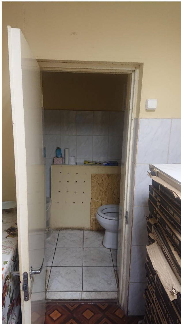
10. Объекта культурного наследия регионального значения «Дом А.И. Кракау» по адресу: Санкт-Петербург, 8-я линия В.О., д. 43, лит. А, Б. Главный (лицевой) фасад. Первый этаж. Фрагмент. Помещение 2-Н. Санузел. Общий вид.
