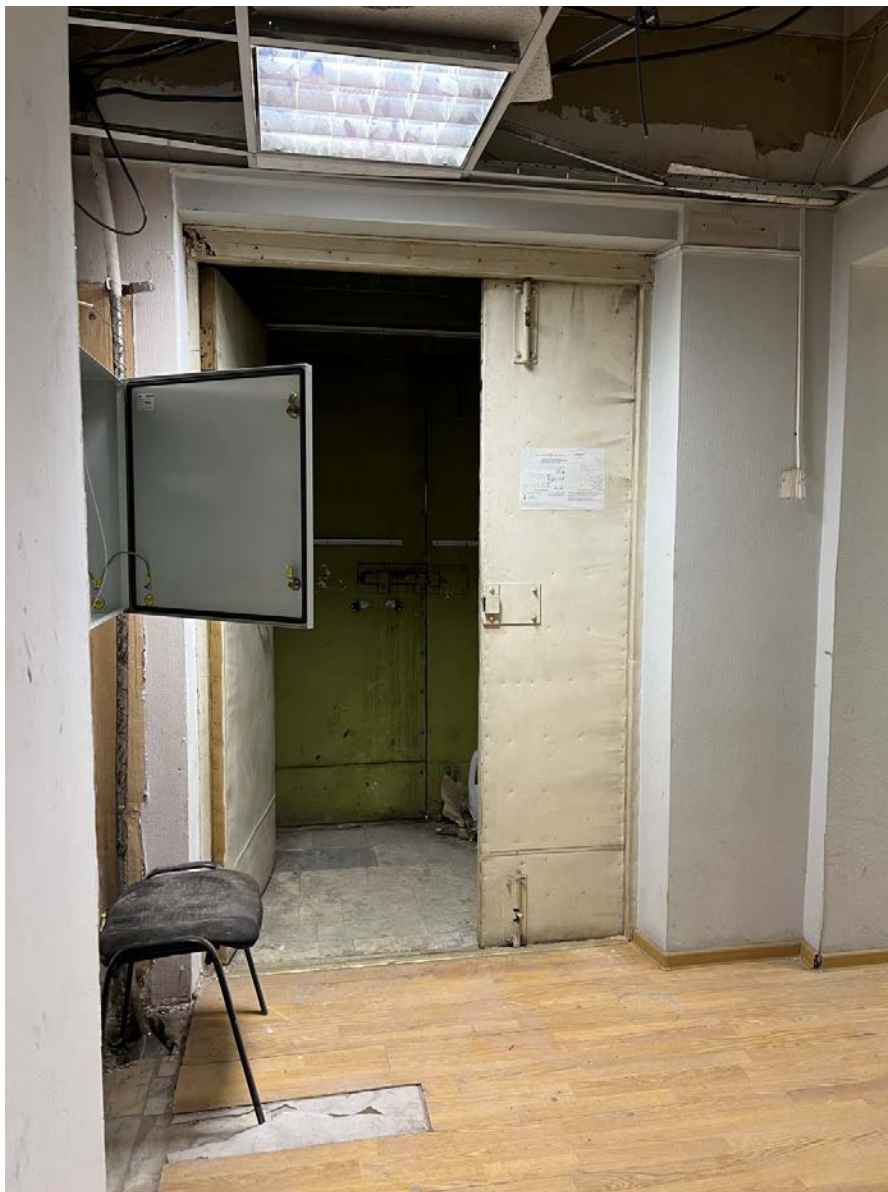
13. Помещение 1-Н. Вид из коридора пом. 4 на входную дверь со стороны двора в помещении коридора пом. 7.
