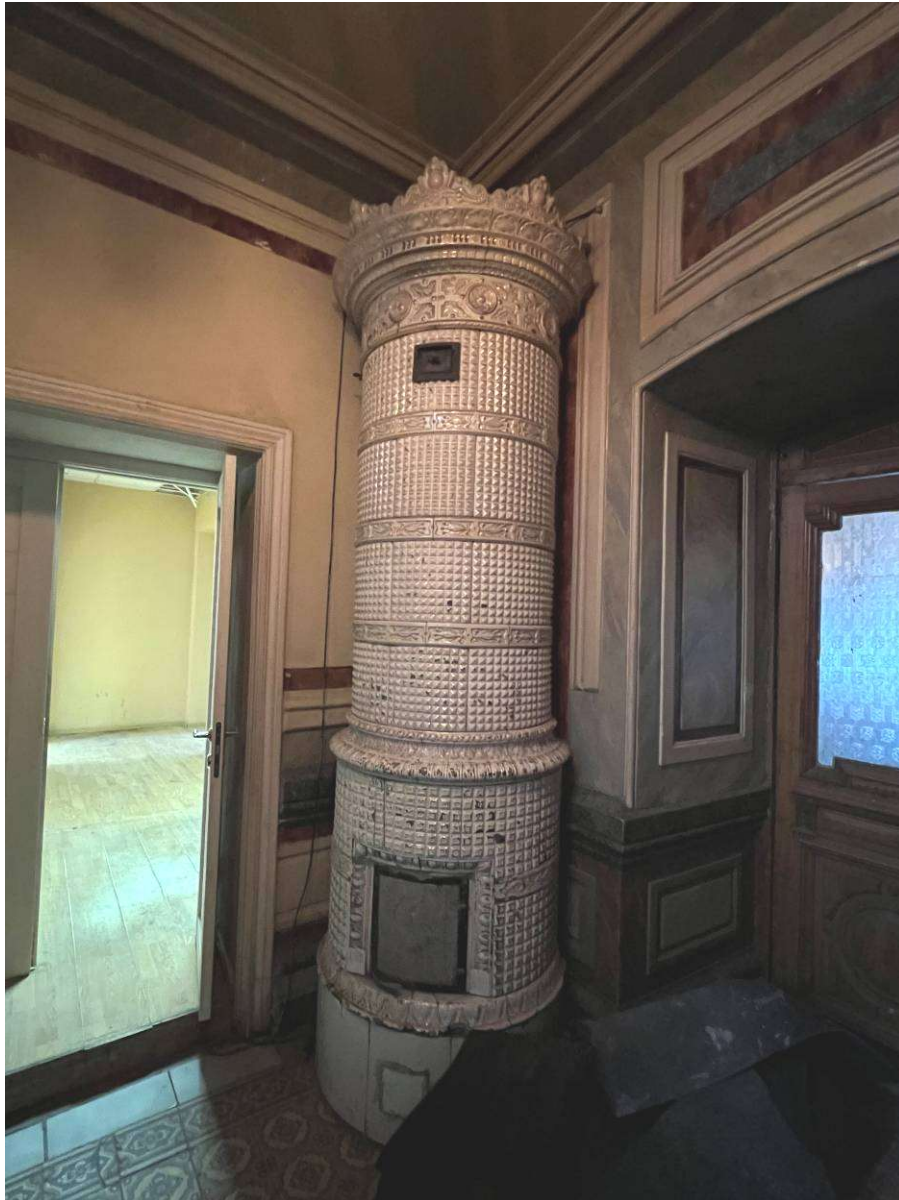
9. Выявленный объект культурного наследия «Д Особняк Г.П. Петрова». Фрагмент интерьера вестибюля парадной лестницы (1 ЛК) с исторической печью и входом в обособленное помещение 1-Н.
