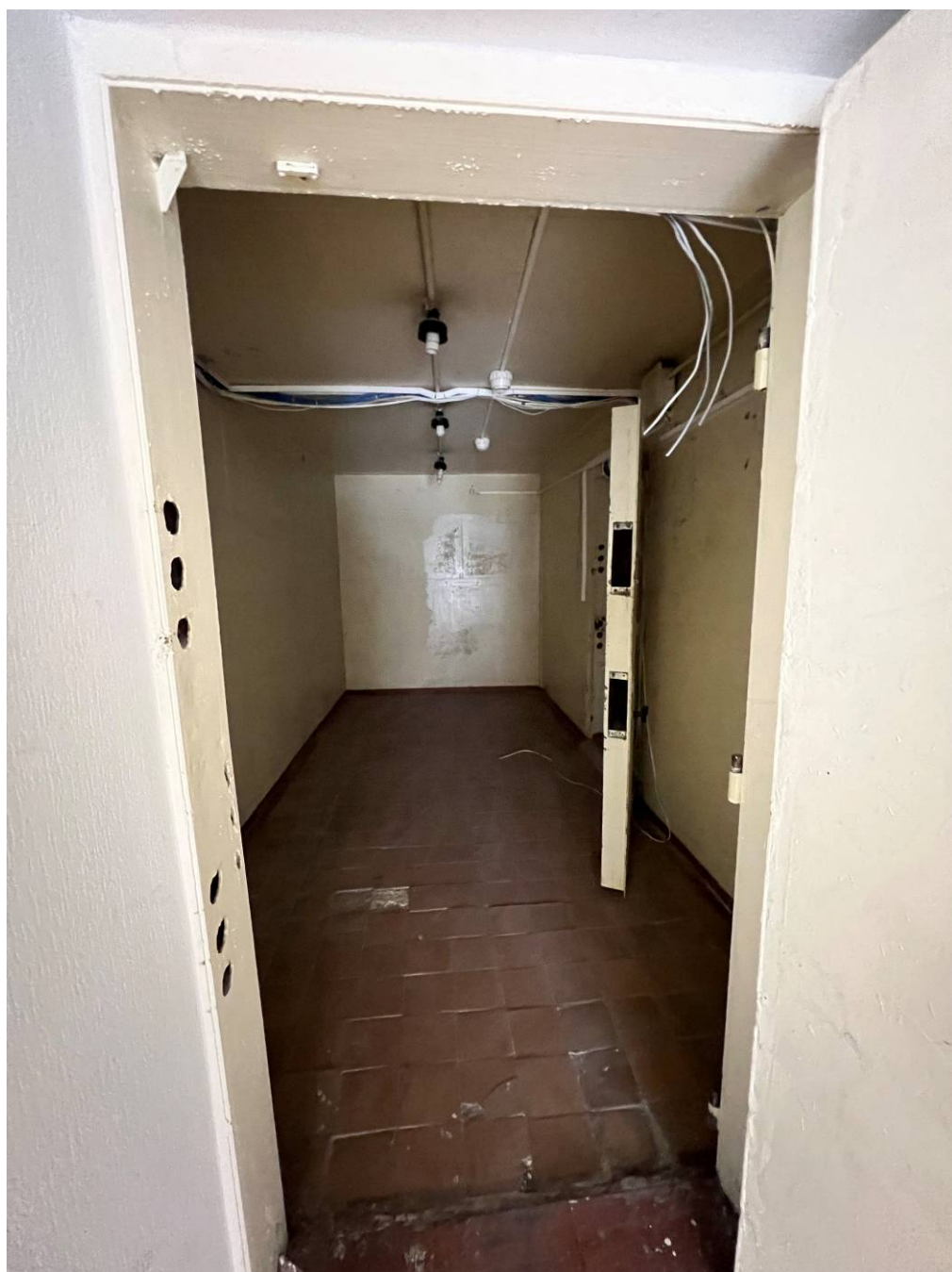
19. Помещение 1-Н. Вид на техпомещение пом. 14.
