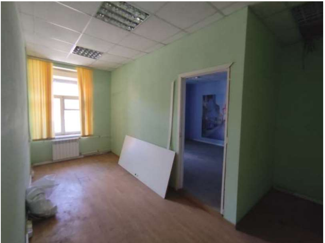
23. Помещение 1-Н. Коридор пом. 17. Общий вид.
