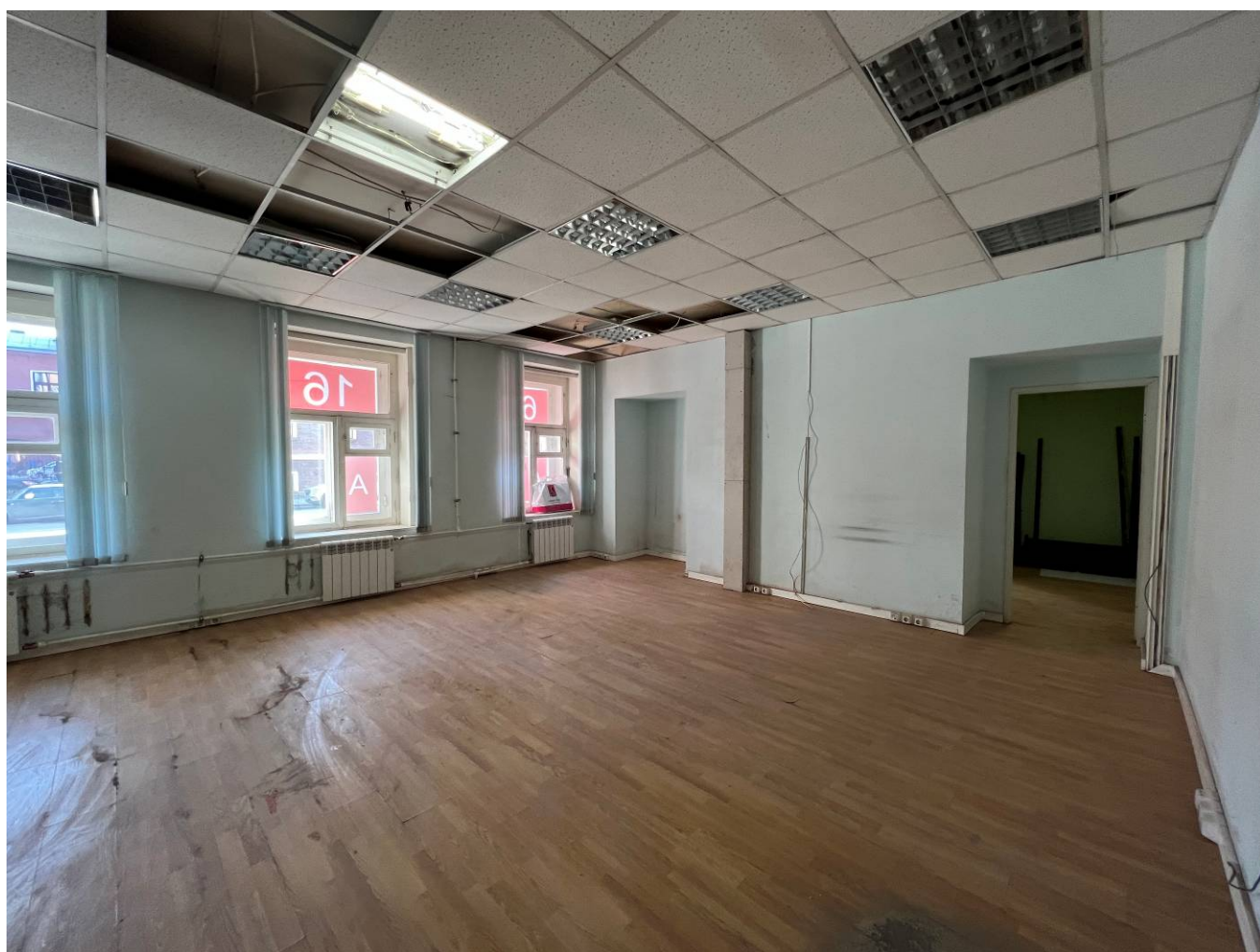
20. Помещение 1-Н. Общий вид кабинета пом. 16.
