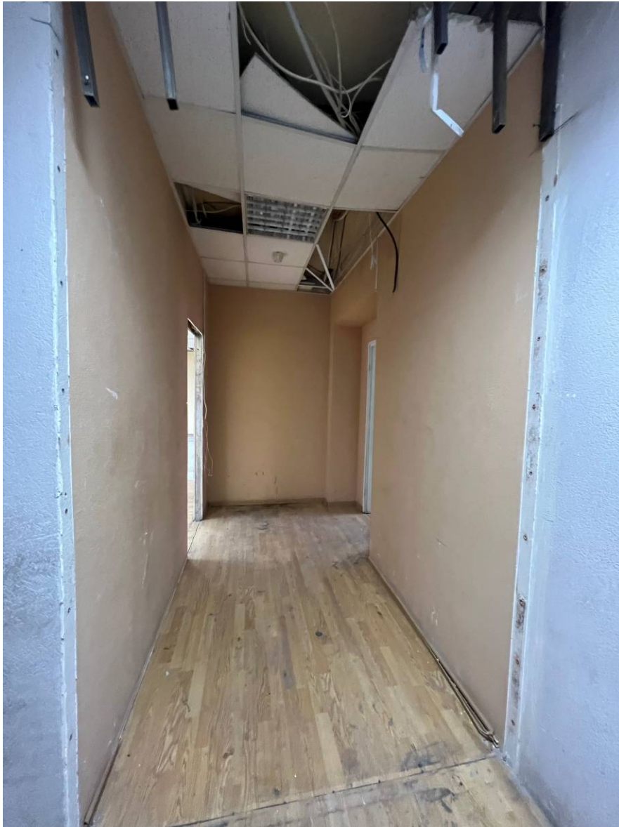
11. Помещение 1-Н. Вид на коридор пом. 2 из коридора пом. 1.
