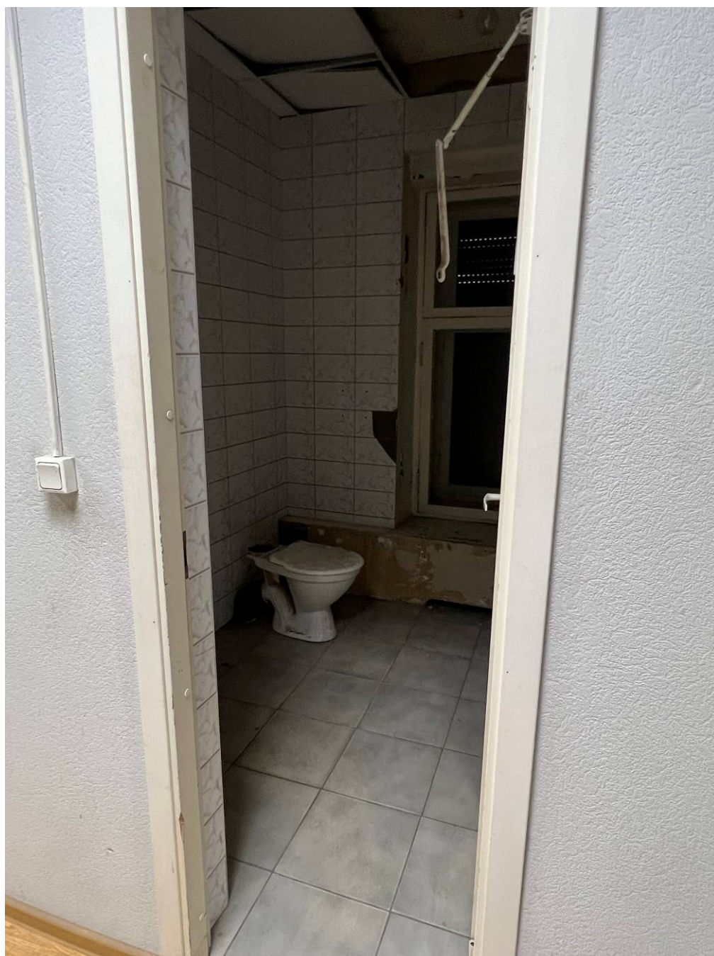
16. Помещение 1-Н. Вид на помещение туалета пом. 11.
