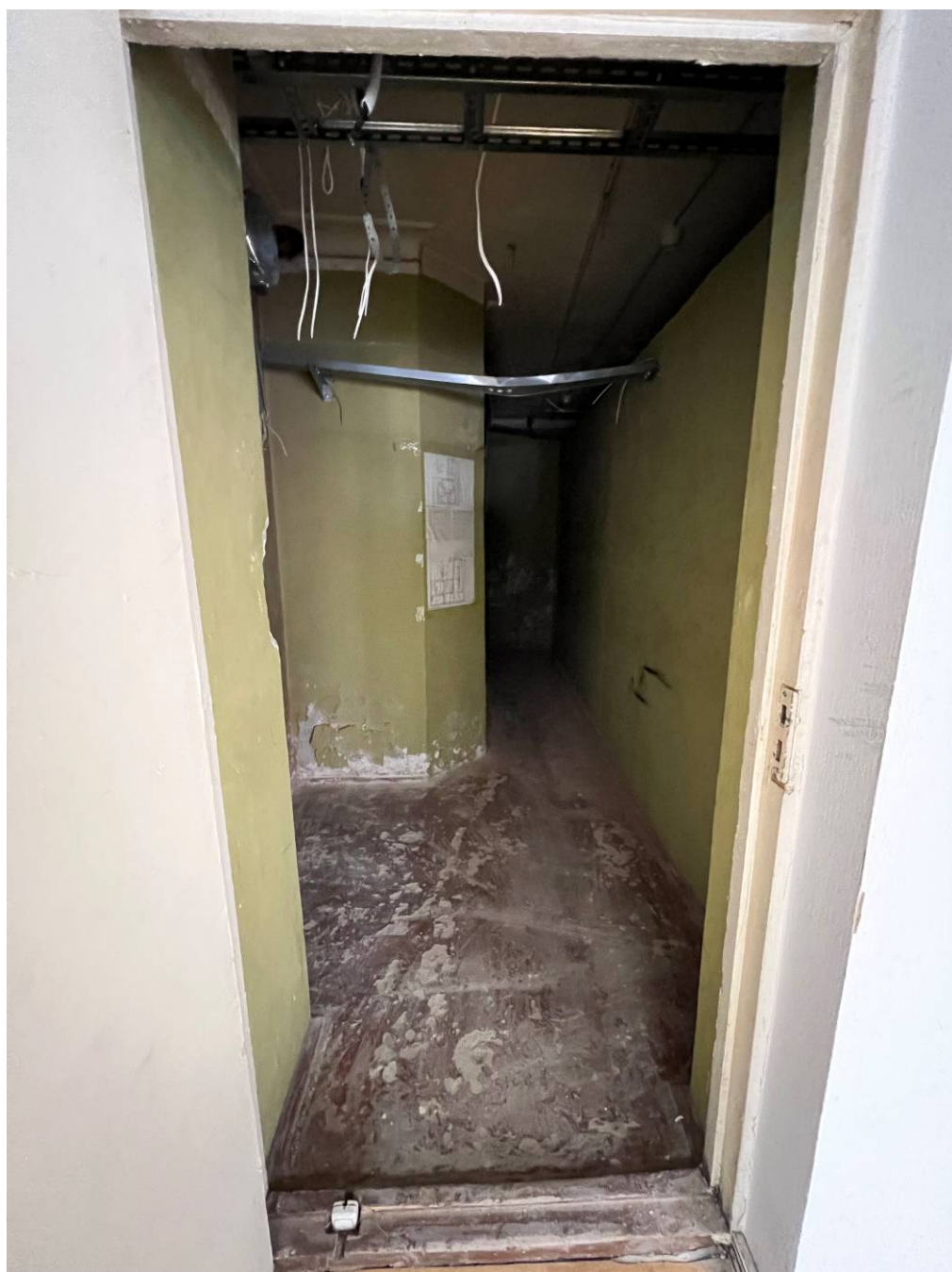
18. Помещение 1-Н. Вид на помещение коридора пом. 13.
