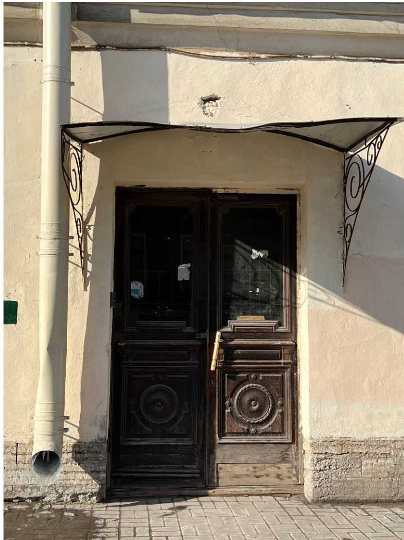
2. Выявленный объект культурного наследия «Особняк Г.П. Петрова». Вход со стороны улицы в вестибюль на общую лестничную клетку (1 ЛК).
