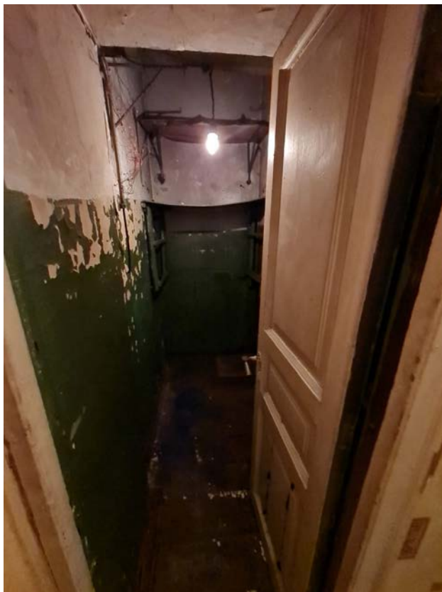
18. Выявленный объект культурного наследия «Дом М.Д. Усова» по адресу: г. Санкт-Петербург, ул. Смоленская, д. 1, лит. Д. Квартира 9 (помещение 10)
