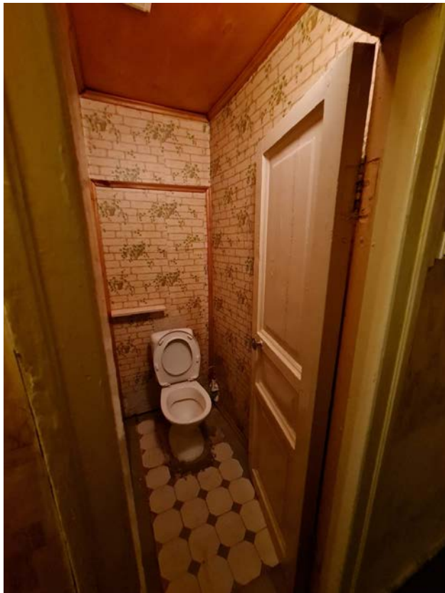
10. Выявленный объект культурного наследия «Дом М.Д. Усова» по адресу: г. Санкт-Петербург, ул. Смоленская, д. 1, лит. Д. Квартира 9 (помещение санузла)
