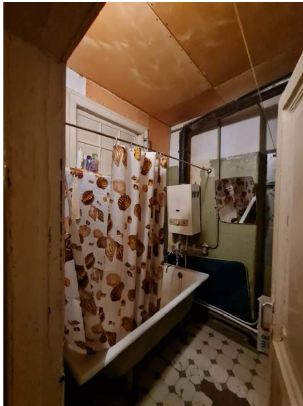
11. Выявленный объект культурного наследия «Дом М.Д. Усова» по адресу: г. Санкт-Петербург, ул. Смоленская, д. 1, лит. Д. Квартира 9 (помещение ванной)
