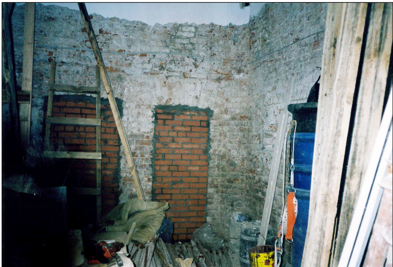
50. Часовня в ходе восстановления. Интерьер. Восточная стена с заложенными дверными проемами (входы в пристройку). 1998 г. / Архив Троицкого собора.
