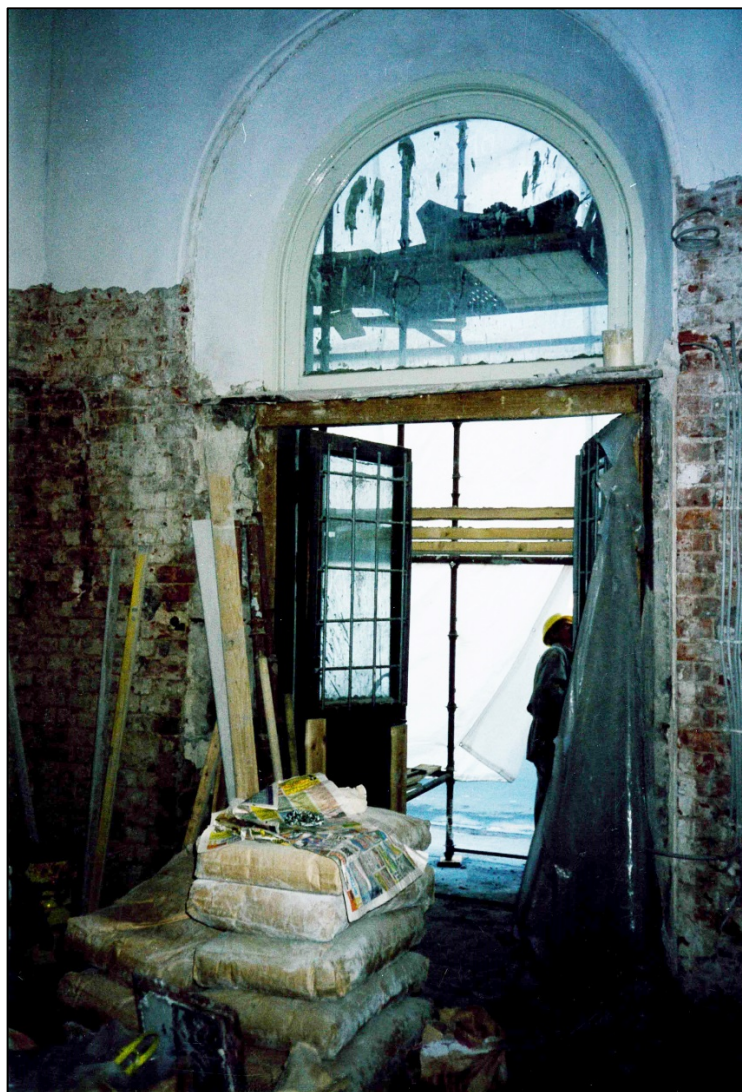
48. Часовня в ходе восстановления. Дверное заполнение. Вид изнутри. 1998 г. / Архив Троицкого собора.
