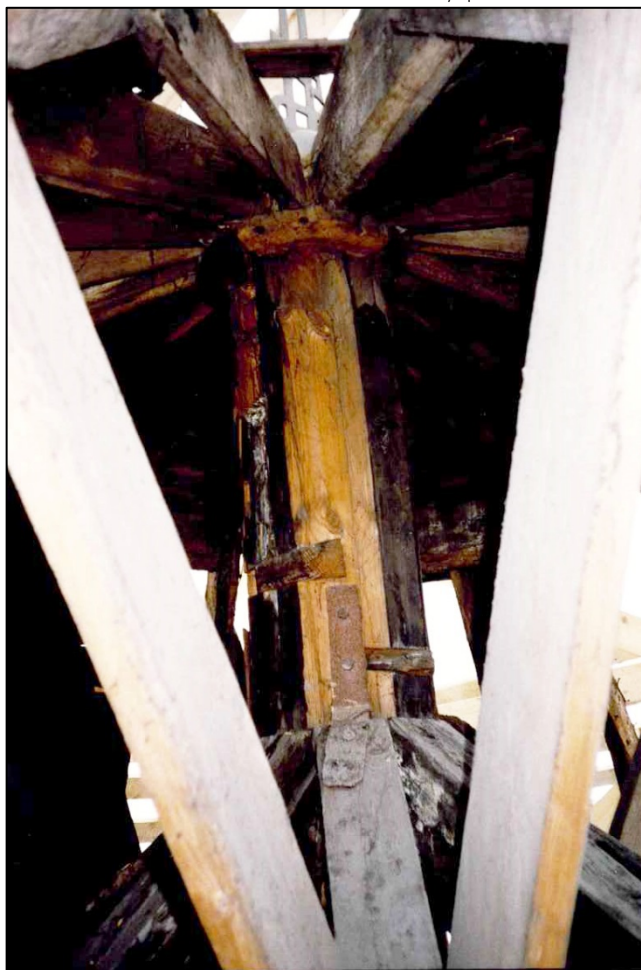
45. Часовня в ходе восстановления. Вид купола изнутри. Верхняя часть столба, на который опираются кружала. / Заключение о техническом состоянии часовни собора Святой Животворящей Троицы Лейб-Гвардии Измайловского полка. ПК «СТРОЙДИАГНОЗ». - СПб, 1998.
