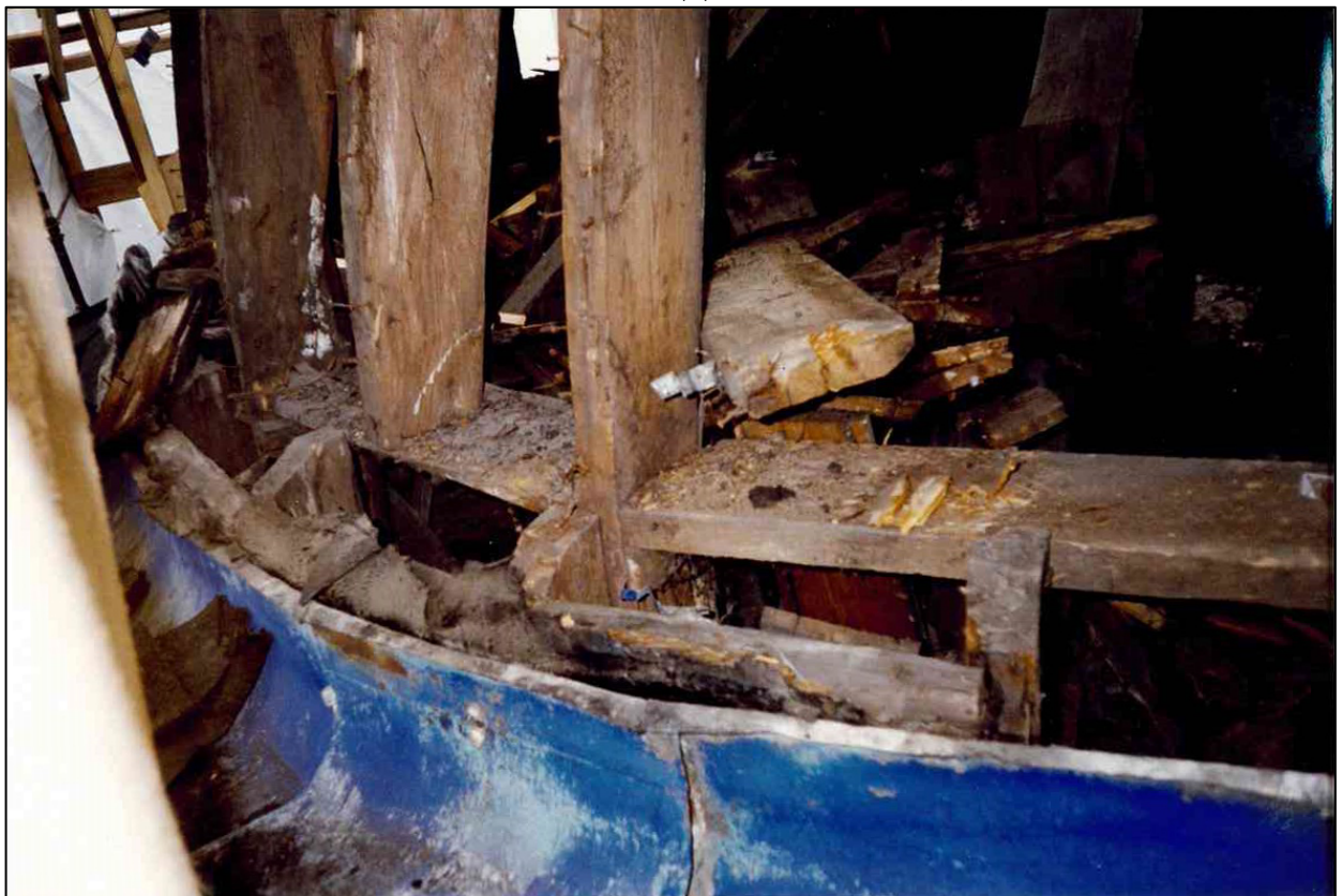
41. Часовня в ходе восстановления. Остатки каркаса профилированного пояса в основании купола. / Заключение о техническом состоянии часовни собора Святой Животворящей Троицы Лейб-Гвардии Измайловского полка. ПК «СТРОЙДИАГНОЗ». - СПб, 1998.
