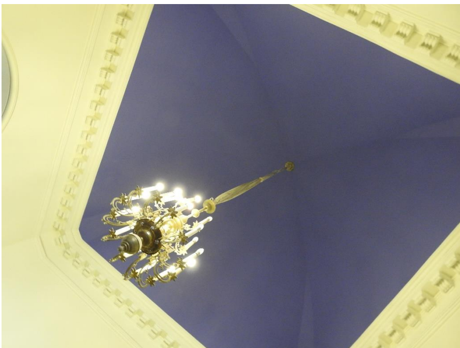
17. «Часовня, 1894 г., гражд. инж. Кондратьев С.П.», входящая в состав объекта культурного наследия федерального значения «Собор Троицкий (Измайловский)», Измайловский пр., д.4-а, лит. А, д.7-а, лит. А. Интерьер. Фрагмент. Фото 26.04.2022г.
