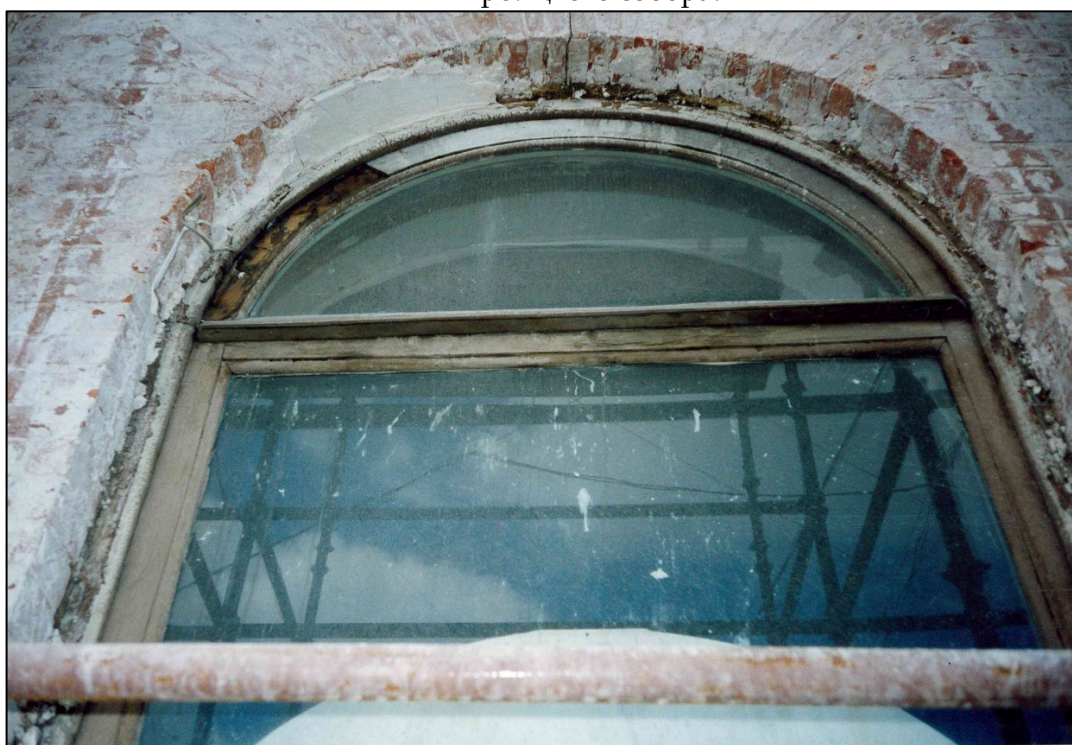
49. Часовня в ходе восстановления. Оконное заполнение. Вид снаружи. 1998 г. / Архив Троицкого собора.
