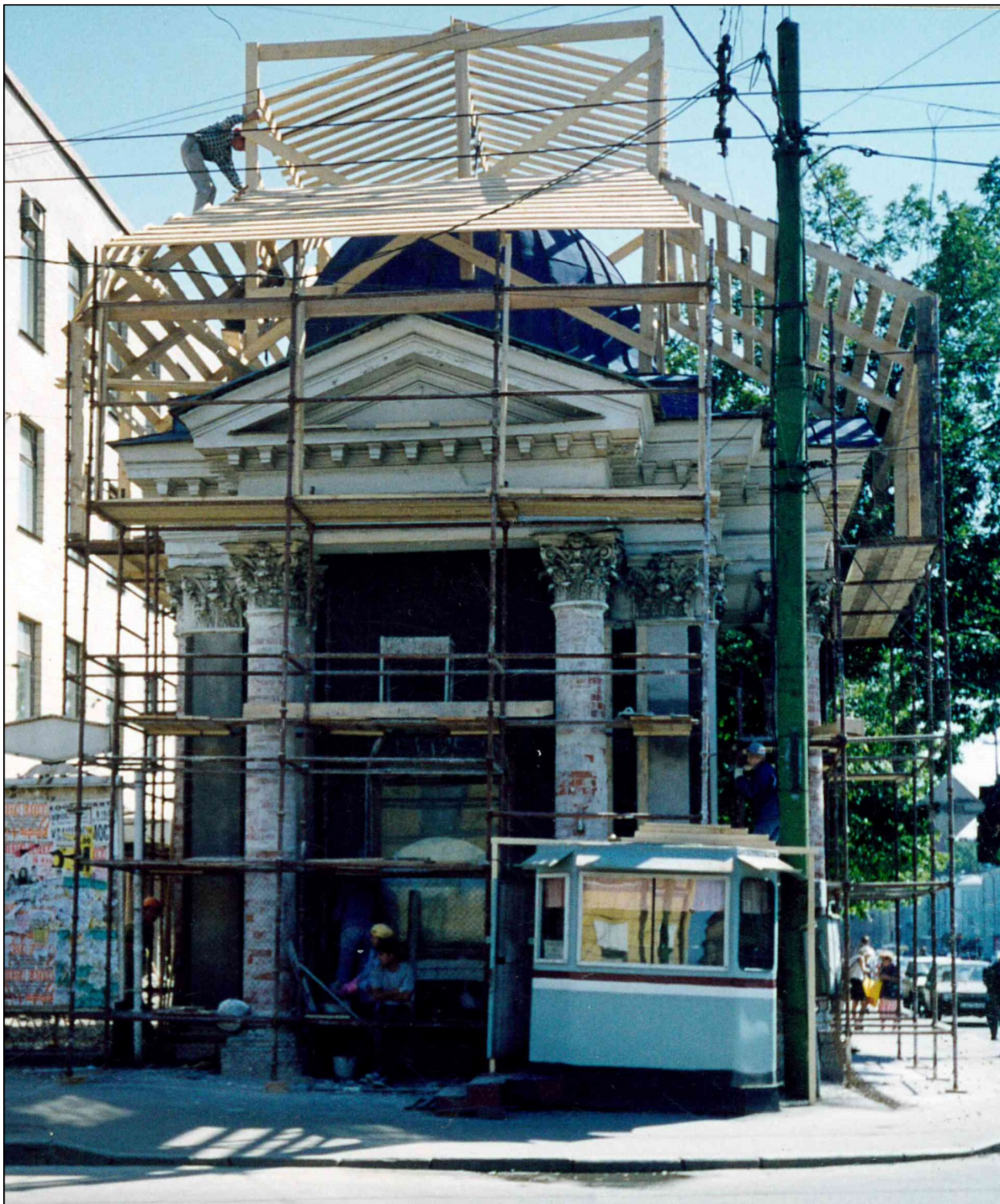
37. Часовня в ходе восстановления. Вид с севера. 1998г. / Архив Троицкого собора.
