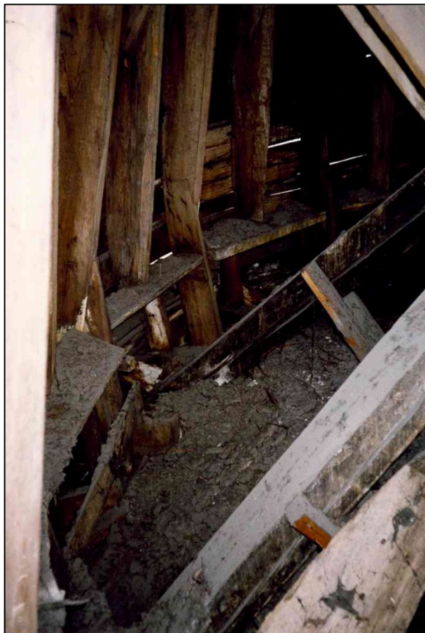
46. Часовня в ходе восстановления. Вид купола изнутри. Кружала в нижней части купола. / Заключение о техническом состоянии часовни собора Святой Животворящей Троицы Лейб-Гвардии Измайловского полка. ПК «СТРОЙДИАГНОЗ». - СПб, 1998.
