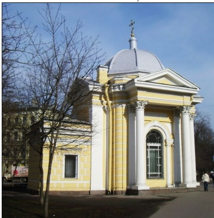
54. Южный фасад часовни Спиридона Тримифунтского. Видна восточная пристройка. 2011 г. /Citywalls.ru: [Электронный ресурс]. URL: https://www.citywalls.ru/house2992.html (Дата обращения: 10.10.2020).
