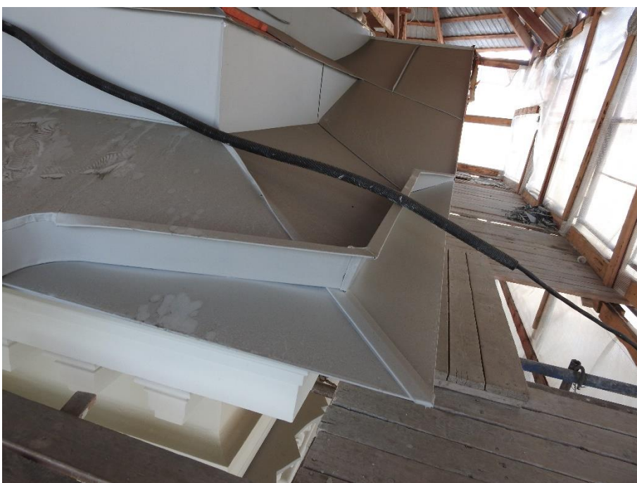
4. «Часовня, 1894 г., гражд. инж. Кондратьев С.П.», входящая в состав объекта культурного наследия федерального значения «Собор Троицкий (Измайловский)», Измайловский пр., д.4-а, лит. А, д.7-а, лит. А. Кровля. Фрагмент. Фото 26.04.2022г.
