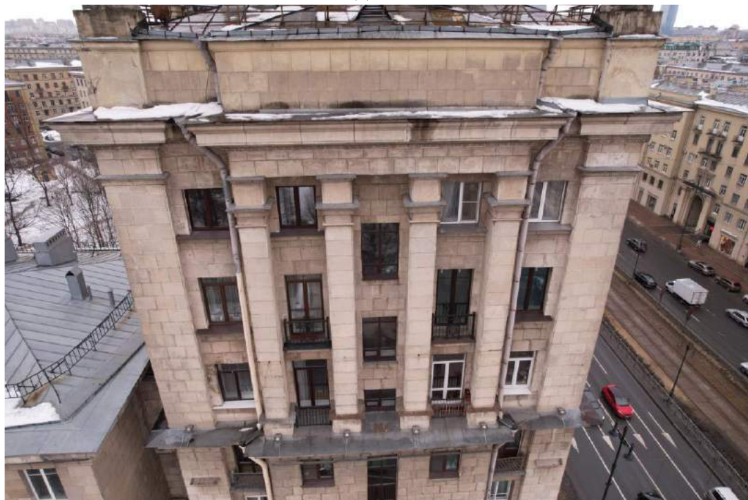
Фото 26. Фасад Г-А (фото с квадрокоптера). Деструкция штукатурного слоя, Трещины, высолы, биопоражения, коррозия линейных окрытий, коррозия кровельного окрытия, следы ржавчины, поздние цементные вставки и докомпоновки
