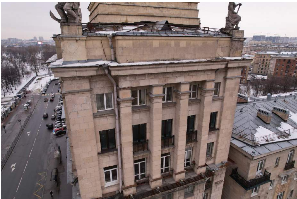
Фото 26. Фасад Г-А (фото с квадрокоптера). Деструкция штукатурного слоя, Трещины, высолы, биопоражения, коррозия линейных окрытий, коррозия кровельного окрытия, следы ржавчины, поздние цементные вставки и докомпоновки
