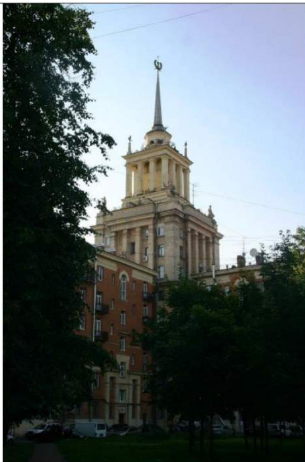
Фото 2. Вид здания – башни со стороны внутреннего двора.
