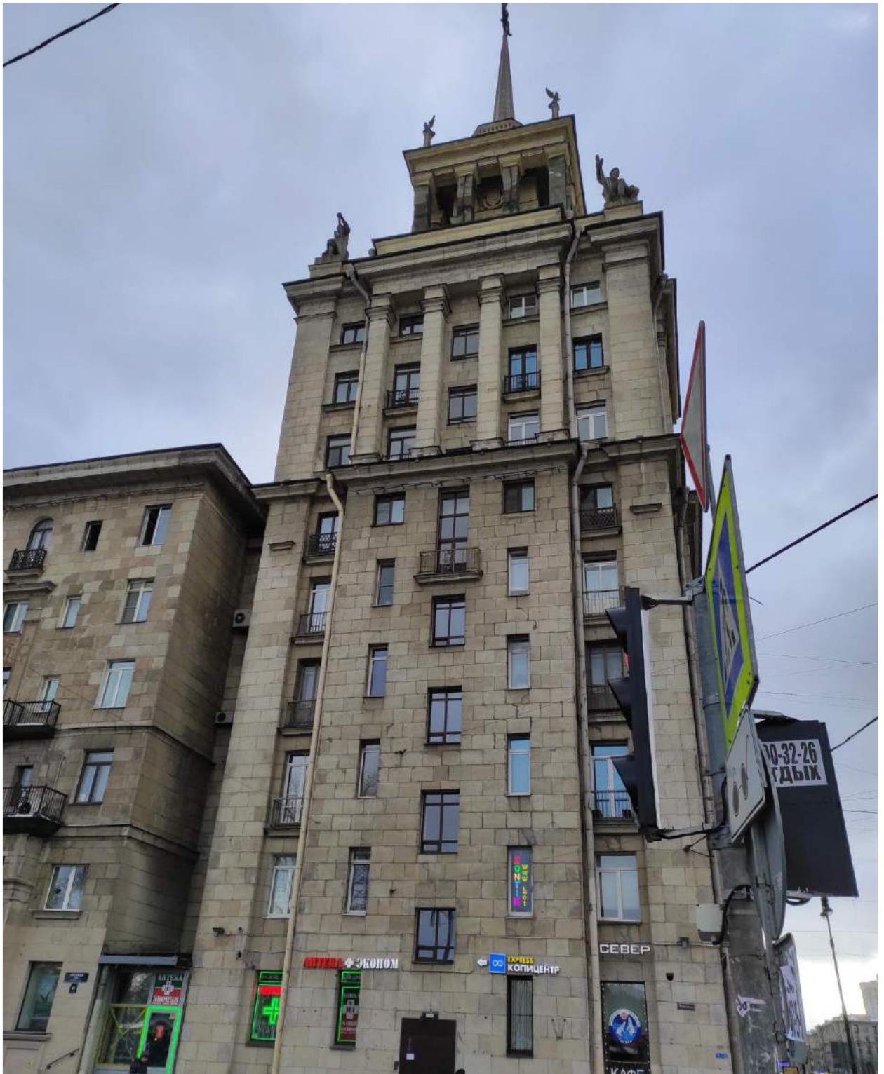
Фото 1. Фасад Г-А. Общий вид
