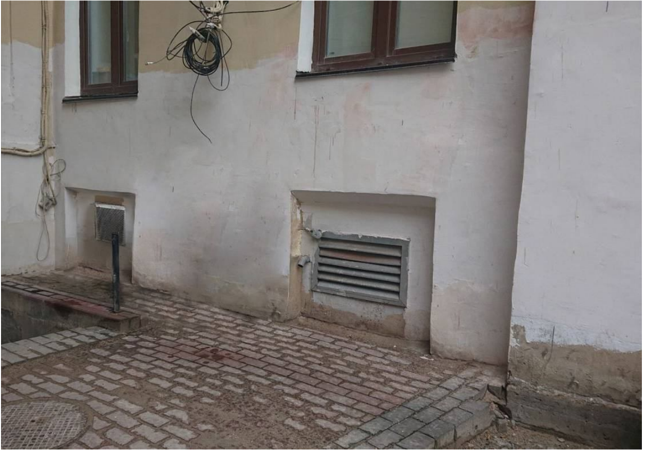
8. Фрагмент дворового (северного) фасада лицевого корпуса. Вид на заложенные оконные проемы с вент. решетками в пом. 4-Н.
