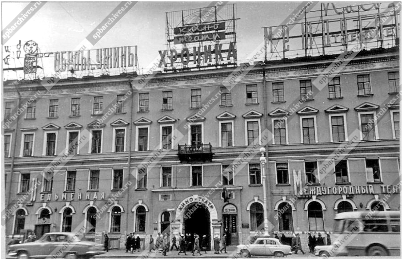
Илл.19. Общий вид дома №88 на Невском проспекте (построен во 2-й четверти XIX в.), в котором находился кинотеатр "Хроника". Дата съемки: середина 1960-х гг. ЦГАКФФД СПб. Фотодокумент Ар 135536.
