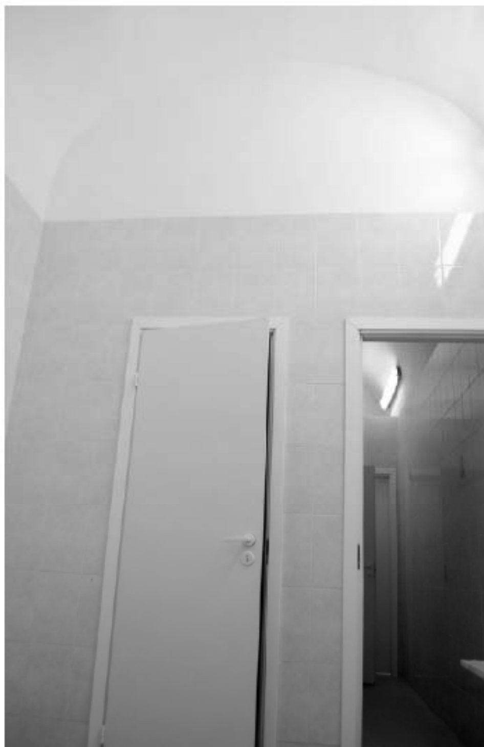
Фото 25. ОКН федерального значения «Корпус семинарский с южными воротами главного двора» (г. Санкт-Петербург, набережная реки Монастырки, дом 1, лит. Г). Первый этаж. Помещение 3-Н (37). Фрагмент расчисток. Съёмка 08.11.2021 г.
