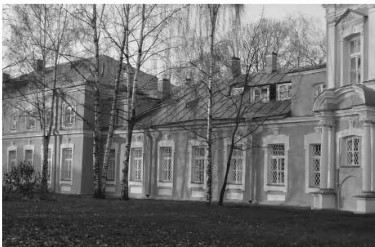
Фото 03. ОКН федерального значения «Корпус семинарский с южными воротами главного двора» (г. Санкт-Петербург, набережная реки Монастырки, дом 1, лит. Г). Юго-восточный фасад. Крыша. Фрагмент. Съёмка 08.11.2021 г.
