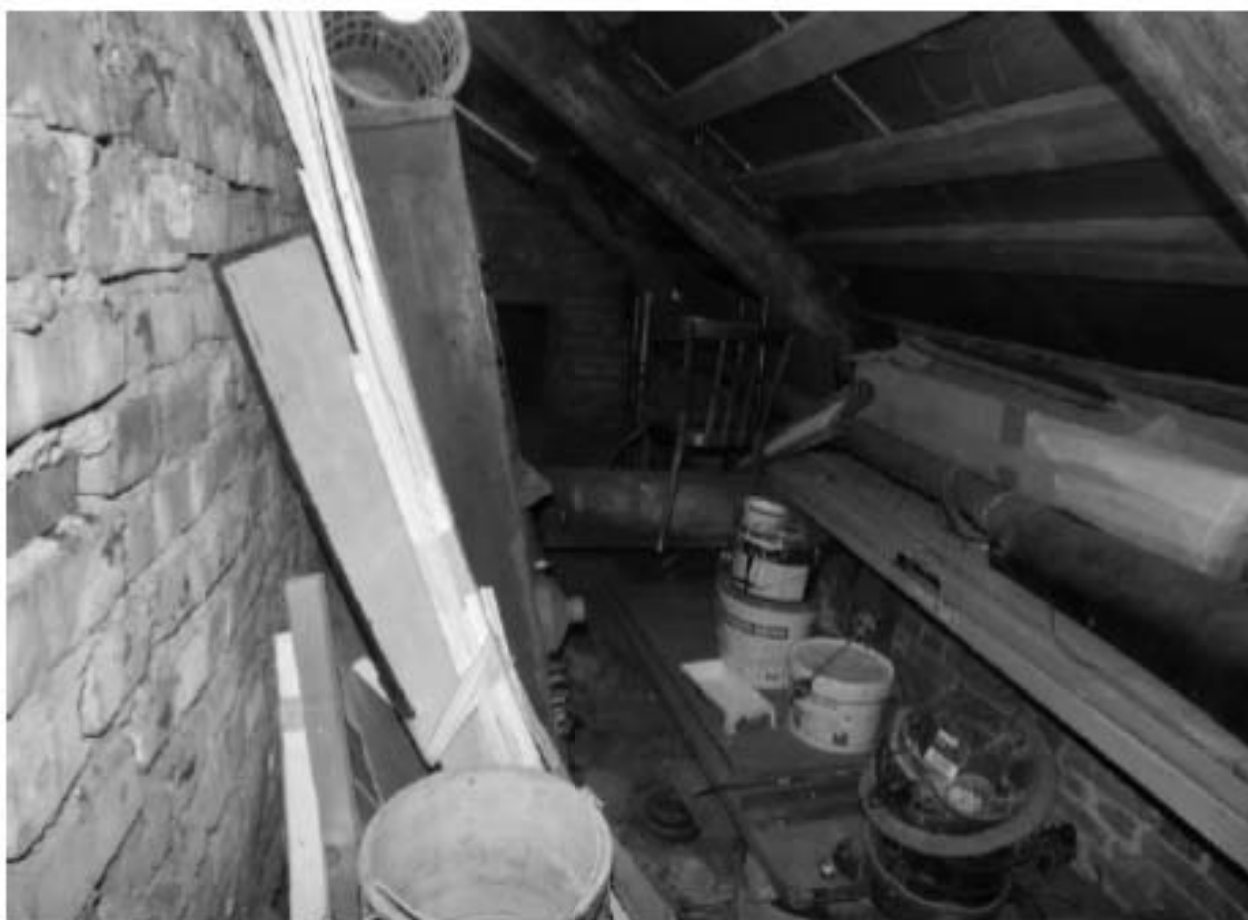
Фото 54. ОКН федерального значения «Корпус семинарский с южными воротами главного двора» (г. Санкт-Петербург, набережная реки Монастырки, дом 1, лит. Г). Чердак в осях В-Г/16-17. Съёмка 08.11.2021 г.
