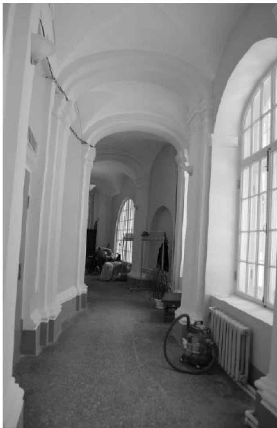
Фото 33. ОКН федерального значения «Корпус семинарский с южными воротами главного двора» (г. Санкт-Петербург, набережная реки Монастырки, дом 1, лит. Г). Галерея первого этажа. Съёмка 08.11.2021 г.
