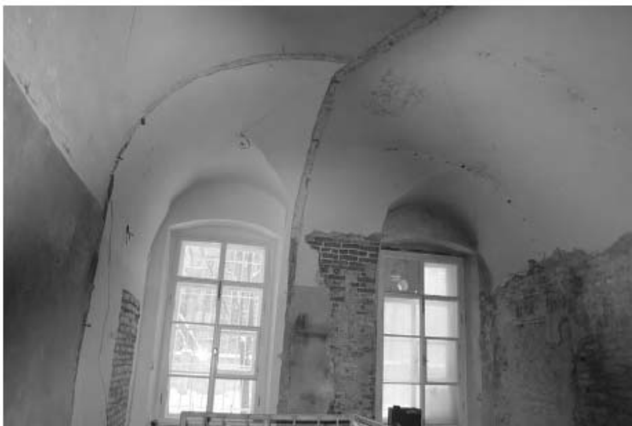
Фото 43. ОКН федерального значения «Корпус семинарский с южными воротами главного двора» (г. Санкт-Петербург, набережная реки Монастырки, дом 1, лит. Г). Галерея первого этажа. Помещение 3-Н (3,4,6). Съёмка 08.11.2021 г.
