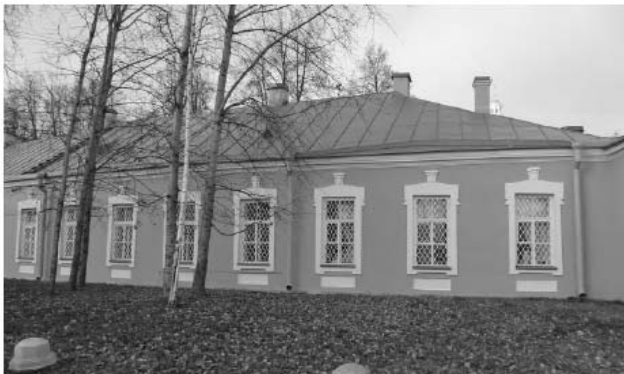
Фото 01. ОКН федерального значения «Корпус семинарский с южными воротами главного двора» (г. Санкт-Петербург, набережная реки Монастырки, дом 1, лит. Г). Юго-восточный фасад. Крыша. Фрагмент. Съёмка 08.11.2021 г.
