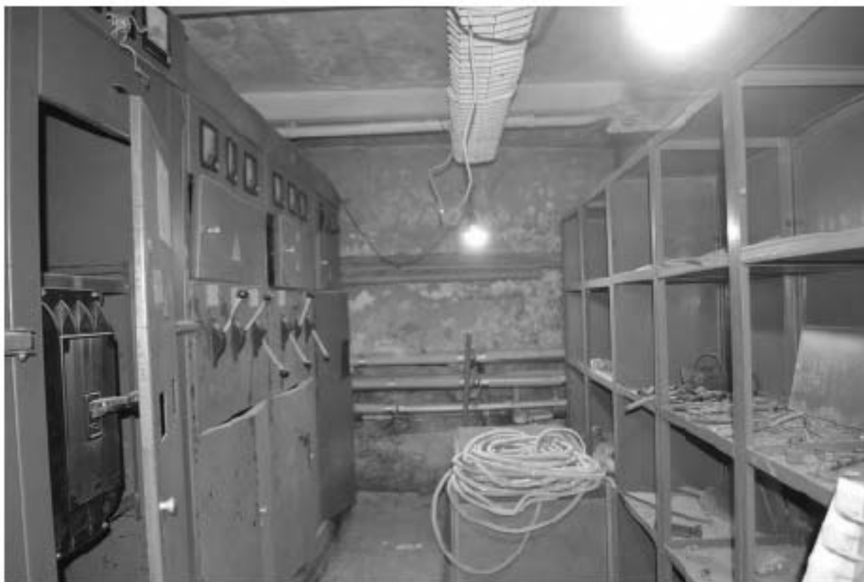
Фото 61. ОКН федерального значения «Корпус семинарский с южными воротами главного двора» (г. Санкт-Петербург, набережная реки Моастырки, дом 1, лит. Г). Подвал. Помещение в осях В-Г/9-10. Съёмка 08.11.2021 г.
