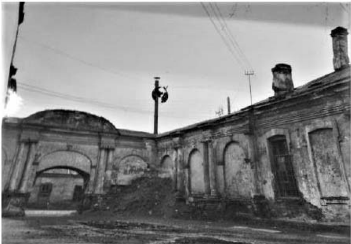
Илл. 11. Южные (Феодоровские) ворота. Вид с лаврского двора. 1940-е // Архив КГИОП. П. 155-4. Н-1262.
