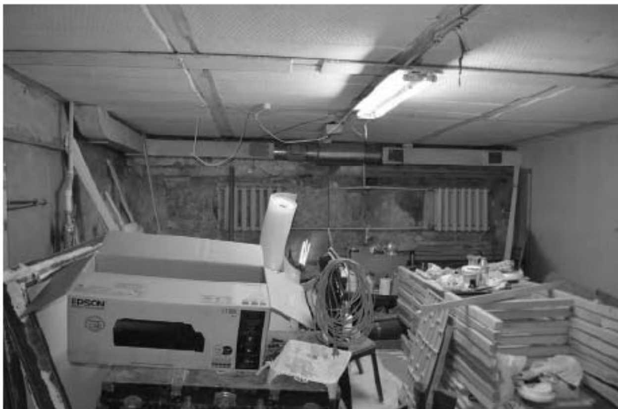
Фото 63. ОКН федерального значения «Корпус семинарский с южными воротами главного двора» (г. Санкт-Петербург, набережная реки Монастырки, дом 1, лит. Г). Подвал. Помещение в осях Б-Г/18-22. Съёмка 08.11.2021 г.
