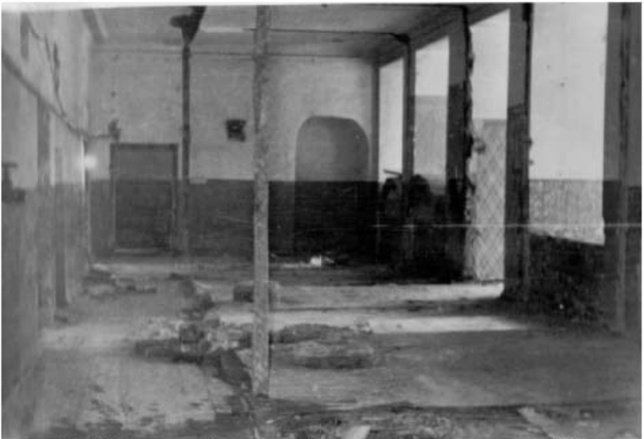
Илл.32. Помещение в двухэтажном флигеле в процессе реконструкции. 1960.
