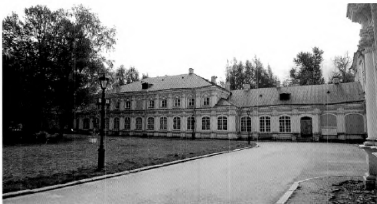
1.Общий вид с северо-запада.
