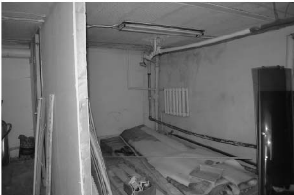
Фото 65. ОКН федерального значения «Корпус семинарский с южными воротами главного двора» (г. Санкт-Петербург, набережная реки Монастырки, дом 1, лит. Г). Подвал. Помещение в осях Б-Г/18-22. Съёмка 08.11.2021 г.
