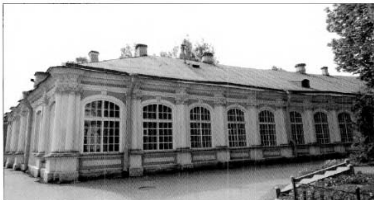
2 Восточная часть здания. Вид с севера.
