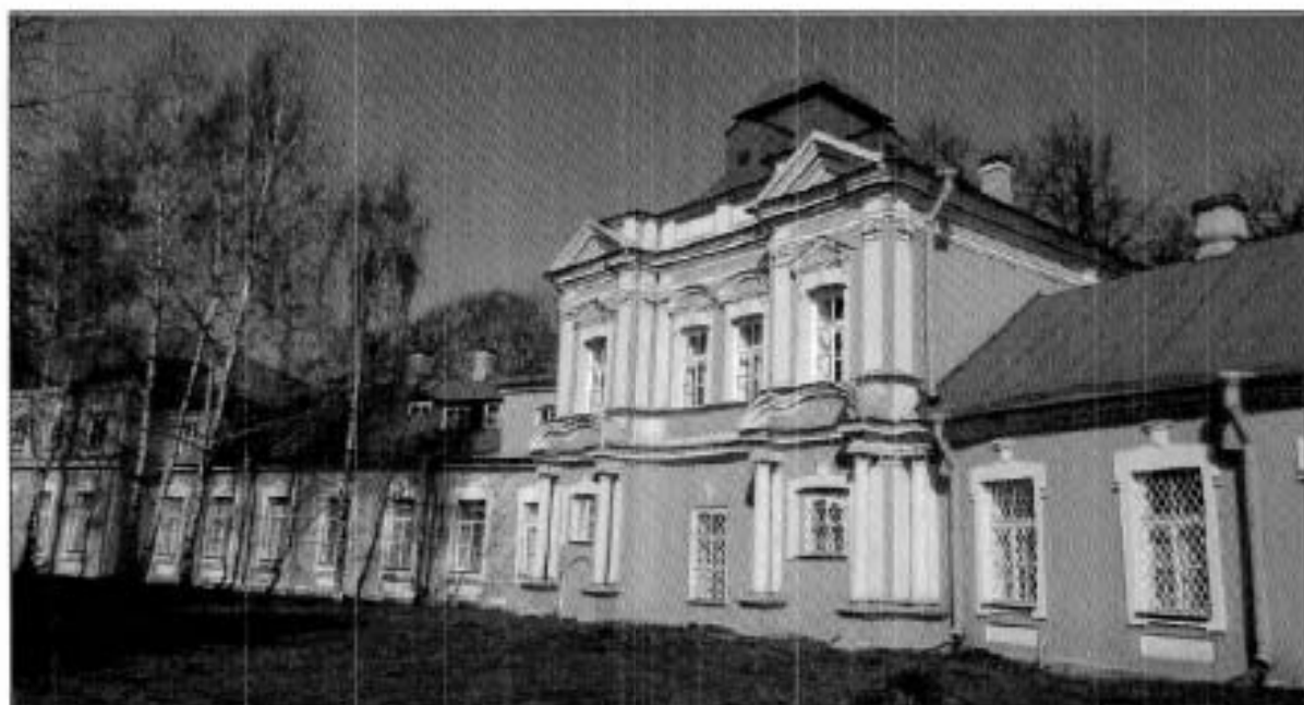
4. Южный фасад. Башенный объем. Вид с юго-востока.
