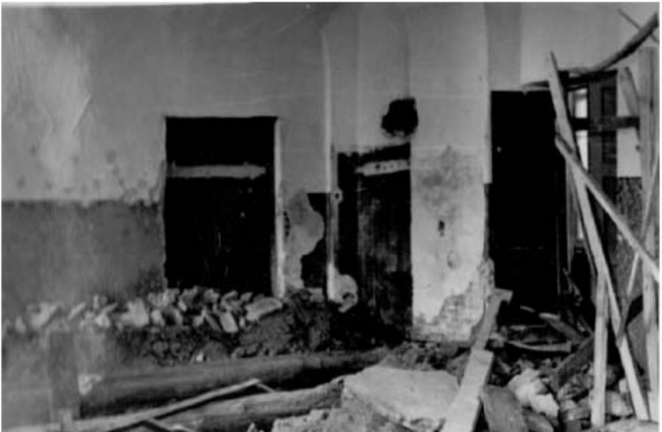
Илл.31. Помещение в одноэтажном флигеле в процессе реконструкции. 1960.
