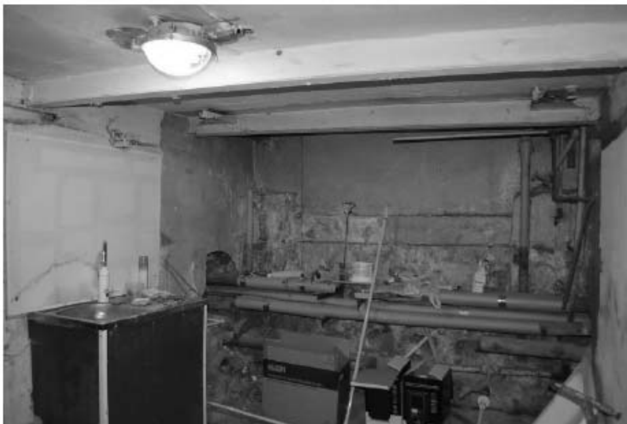
Фото 64. ОКН федерального значения «Корпус семинарский с южными воротами главного двора» (г. Санкт-Петербург, набережная реки Монастырки, дом 1, лит. Г). Подвал. Помещение в осях Б-Г/18-22. Съёмка 08.11.2021 г.
