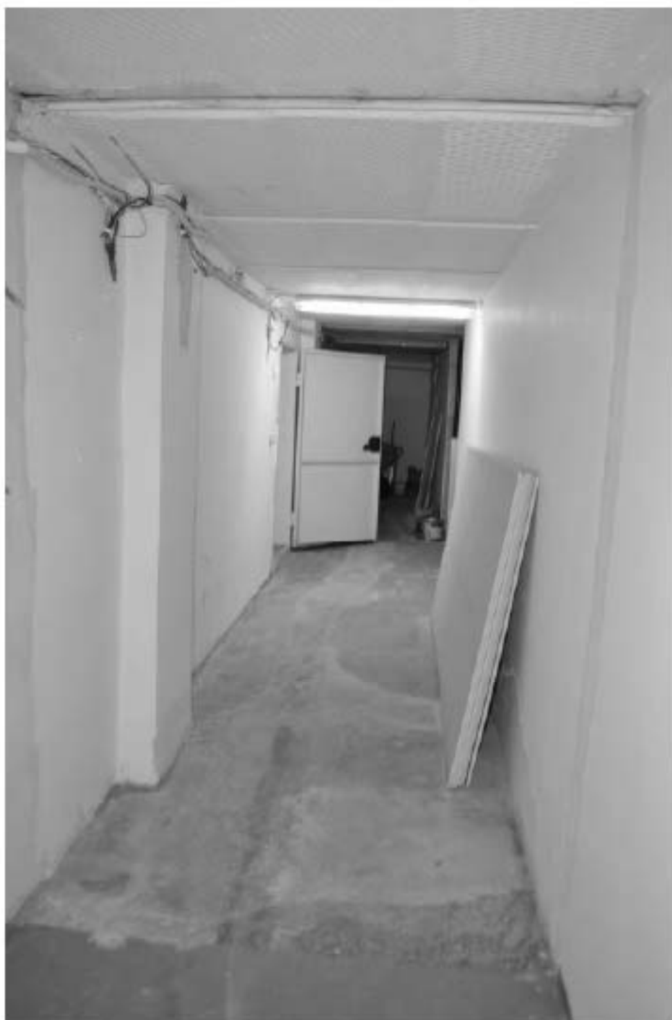
Фото 62. ОКН федерального значения «Корпус семинарский с южными воротами главного двора» (г. Санкт-Петербург, набережная реки Монастырки, дом 1, лит. Г). Подвал. Помещение в осях Б-Г/18-22. Съёмка 08.11.2021 г.
