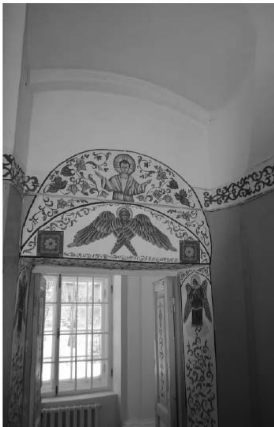
Фото 20. ОКН федерального значения «Корпус семинарский с южными воротами главного двора» (г. Санкт-Петербург, набережная реки Монастырки, дом 1, лит. Г). Первый этаж. Помещение 3-Н (45). Съёмка 08.11.2021 г.
