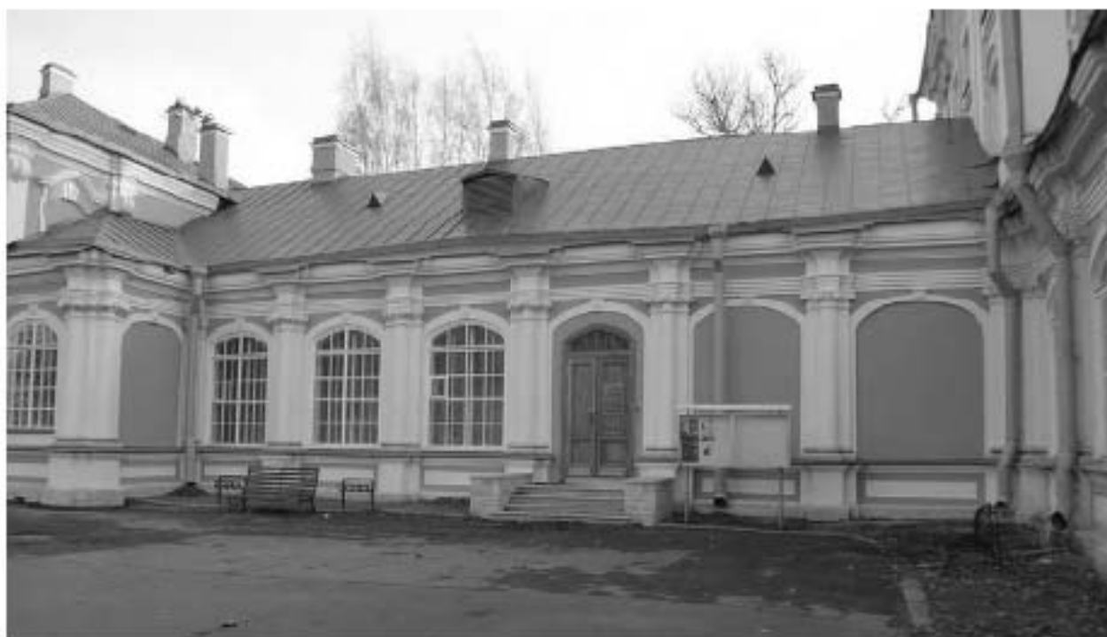
Фото 08. ОКН федерального значения «Корпус семинарский с южными воротами главного двора» (г. Санкт-Петербург, набережная реки Монастырки, дом 1, лит. Г). Северо-западный фасад. Крыша. Фрагмент. Съёмка 08.11.2021 г.
