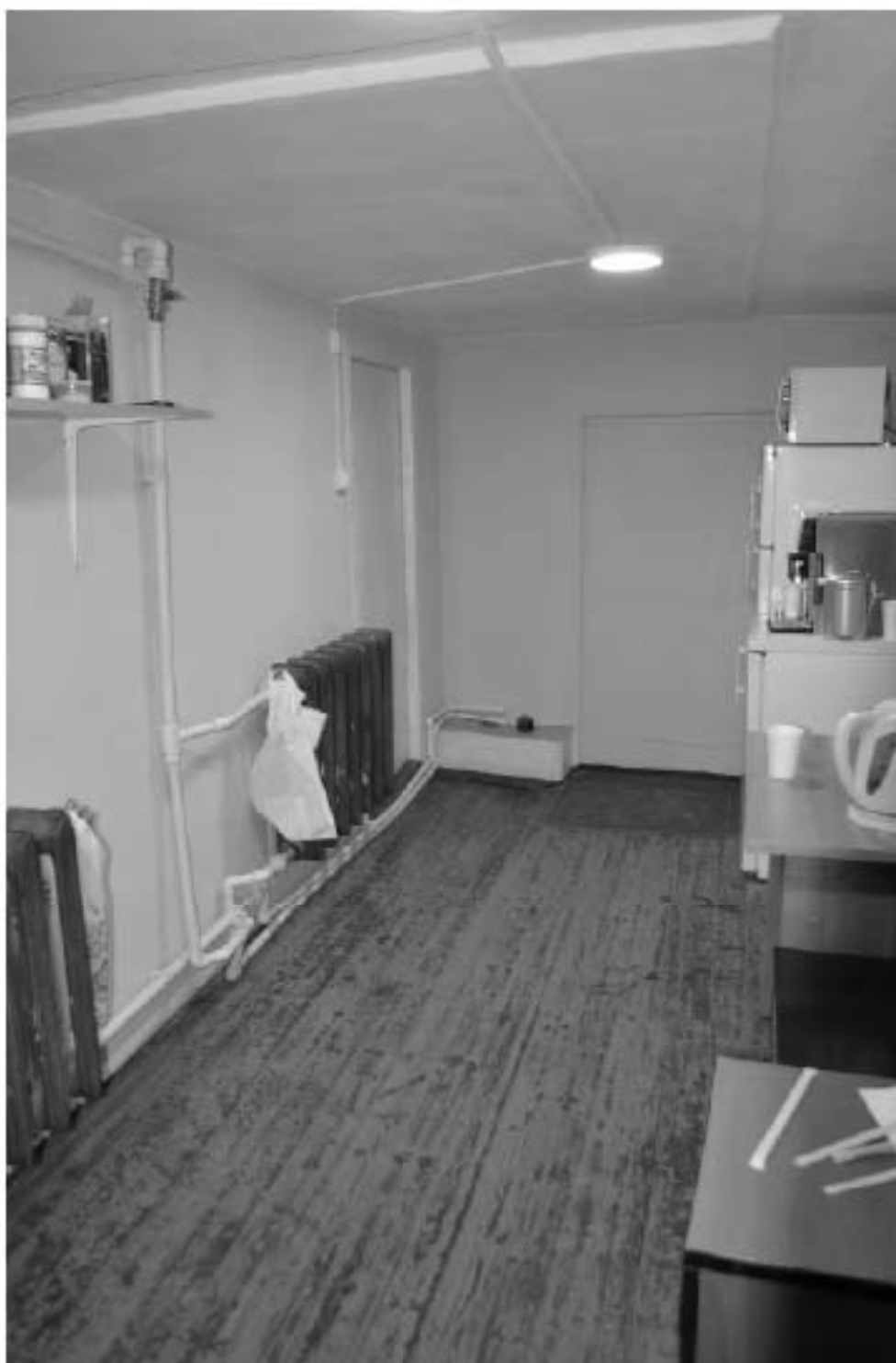
Фото 52. ОКН федерального значения «Корпус семинарский с южными воротами главного двора» (г. Санкт-Петербург, набережная реки Монастырки, дом 1, лит. Г). Чердак в осях В-Г/16-17. Съёмка 08.11.2021 г.
