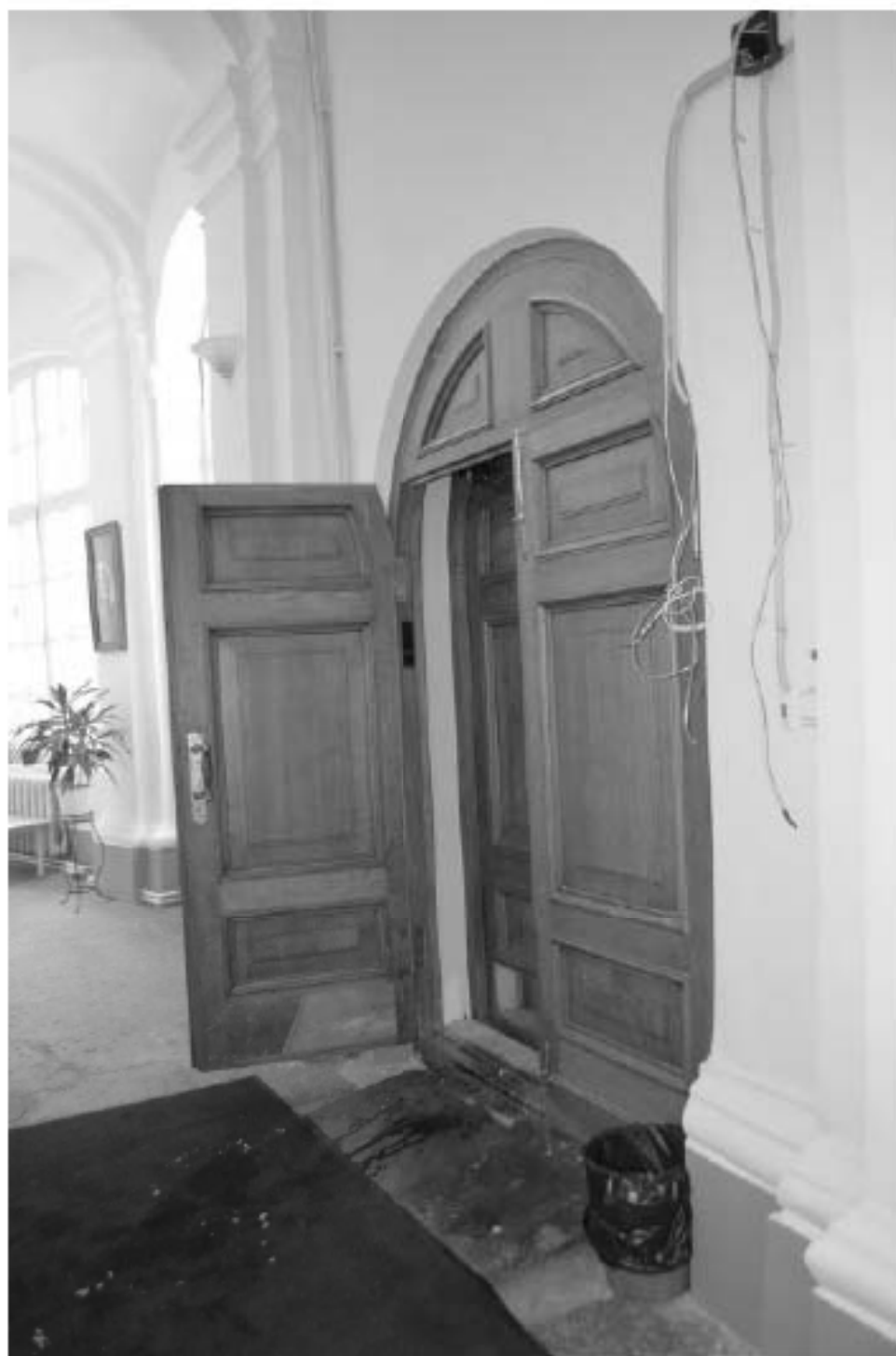
Фото 34. ОКН федерального значения «Корпус семинарский с южными воротами главного двора» (г. Санкт-Петербург, набережная реки Монастырки, дом 1, лит. Г). Галерея первого этажа. Дверной проём. Съёмка 08.11.2021 г.
