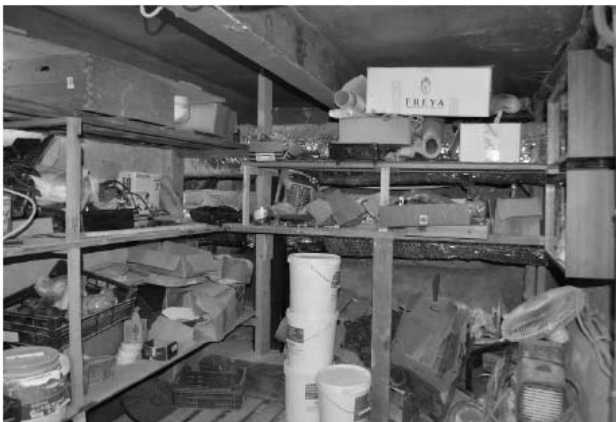
Фото 57. ОКН федерального значения «Корпус семинарский с южными воротами главного двора» (г. Санкт-Петербург, набережная реки Могаытырки, дом 1, лит. Г). Подвал. Помещение в осях В-Г/2-3. Съёмка 08.11.2021 г.
