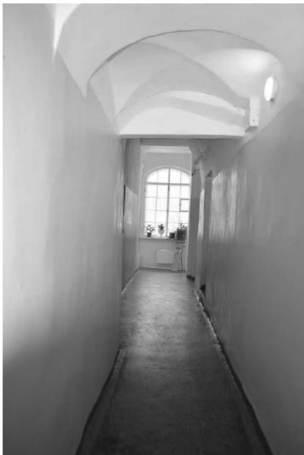
Фото 37. ОКН федерального значения «Корпус семинарский с южными воротами главного двора» (г. Санкт-Петербург, набережная реки Монастырки, дом 1, лит. Г). Первый этаж. Помещение 3-Н (12). Съёмка 08.11.2021 г.
