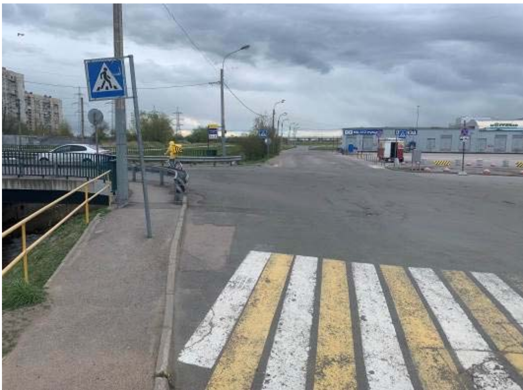
Рис. 392. Санкт-Петербург, Фрунзенский, Московский и Пушкинский р-ны. Точка съёмки 103. Общий вид участка обследования. Вид на ЮЮВ.
