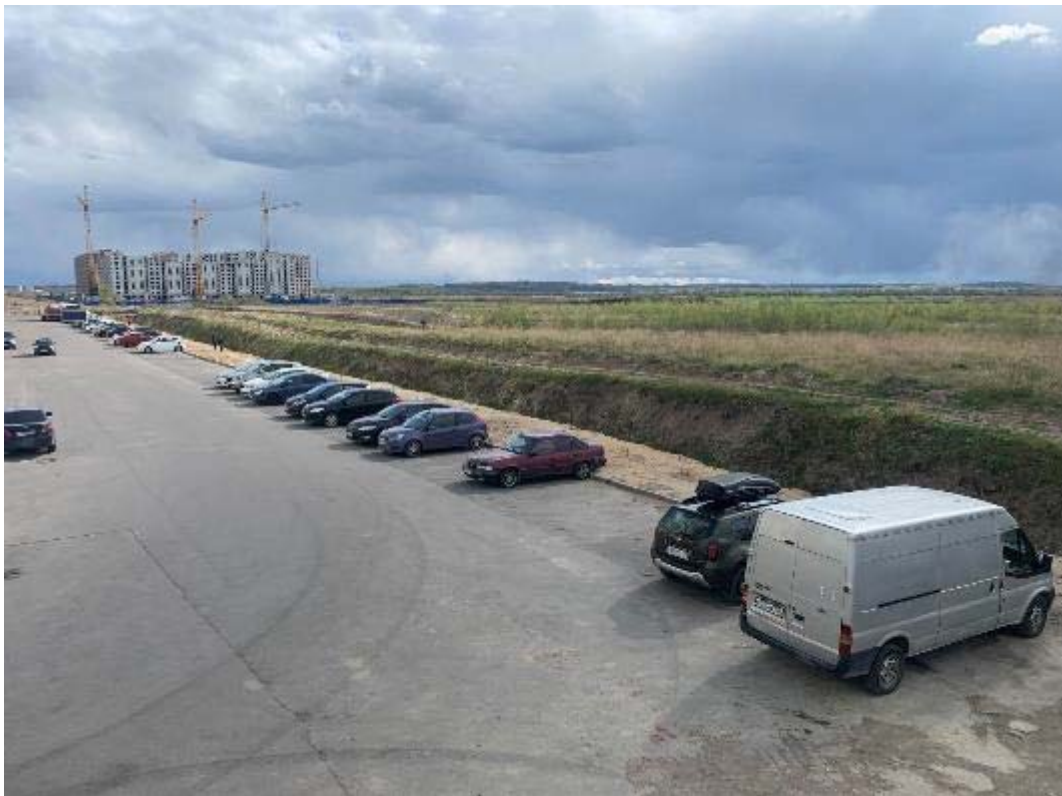
Рис. 286. Санкт-Петербург, Фрунзенский, Московский и Пушкинский р-ны. Точка съёмки 77. Общий вид участка обследования. Вид на ЮЮЗ.
