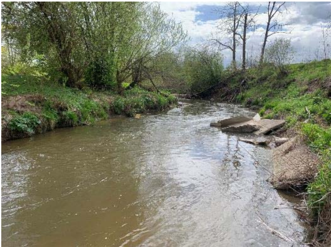
Рис. 163. Санкт-Петербург, Фрунзенский, Московский и Пушкинский р-ны. Точка съёмки 43. Общий вид участка обследования. Вид на Ю.
