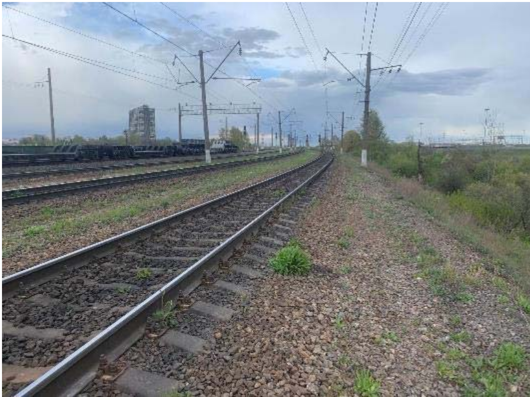
Рис. 317. Санкт-Петербург, Фрунзенский, Московский и Пушкинский р-ны. Точка съёмки 85. Общий вид участка обследования. Вид на В.
