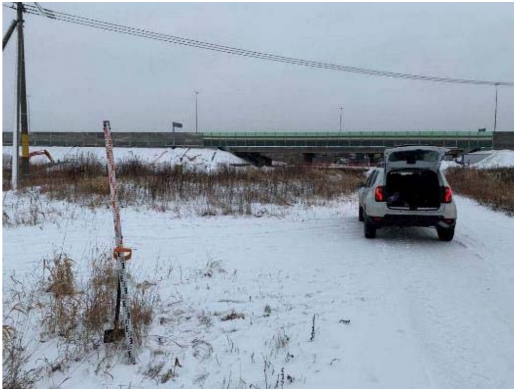
Рис. 26. Санкт-Петербург, Фрунзенский, Московский и Пушкинский р-ны. Точка съёмки 2. Общий вид участка обследования. Вид на ССВ.
