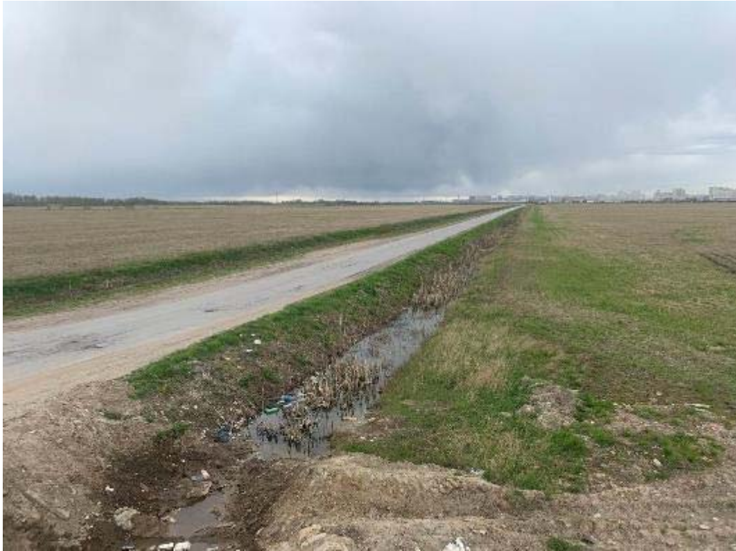
Рис. 255. Санкт-Петербург, Фрунзенский, Московский и Пушкинский р-ны. Точка съёмки 71. Общий вид участка обследования. Вид на СЗ.
