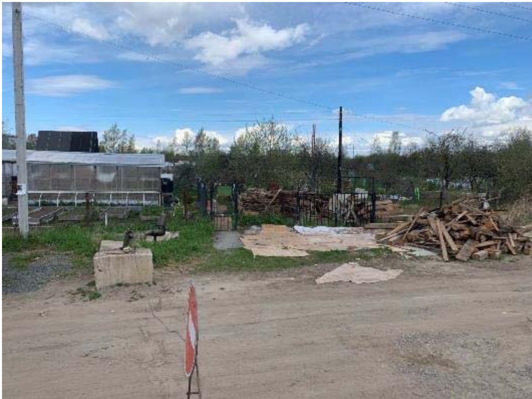
Рис. 213. Санкт-Петербург, Фрунзенский, Московский и Пушкинский р-ны. Точка съёмки 58. Общий вид участка обследования. Вид на С.
