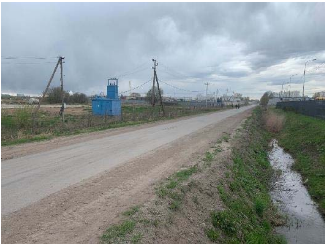
Рис. 264. Санкт-Петербург, Фрунзенский, Московский и Пушкинский р-ны. Точка съёмки 73. Общий вид участка обследования. Вид на ССЗ.
