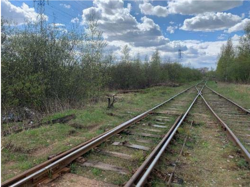
Рис. 211. Санкт-Петербург, Фрунзенский, Московский и Пушкинский р-ны. Точка съёмки 57. Общий вид участка обследования. Вид на ЮЗ.
