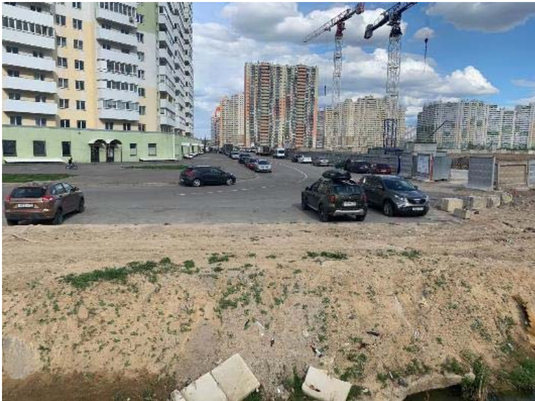
Рис. 279. Санкт-Петербург, Фрунзенский, Московский и Пушкинский р-ны. Точка съёмки 76. Общий вид участка обследования. Вид на В.
