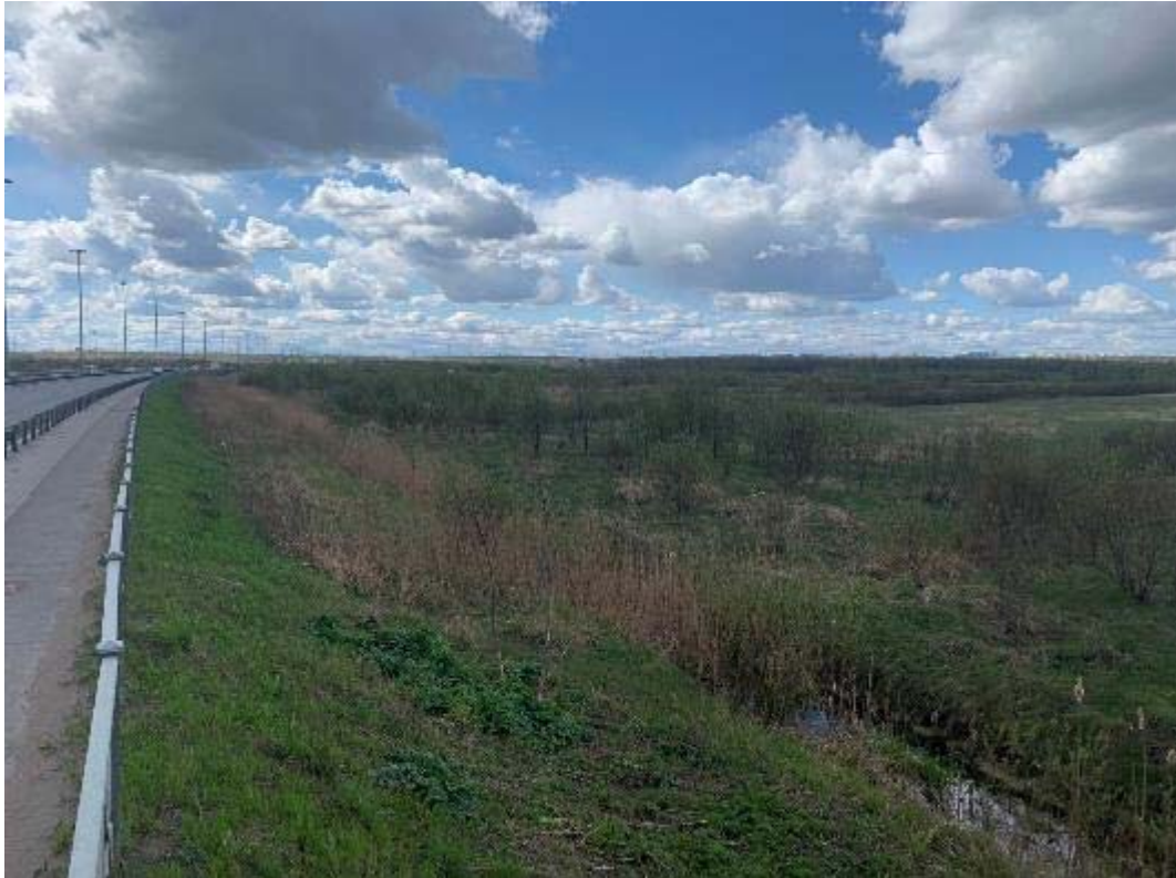
Рис. 251. Санкт-Петербург, Фрунзенский, Московский и Пушкинский р-ны. Точка съёмки 69. Общий вид участка обследования. Вид на ССВ.
