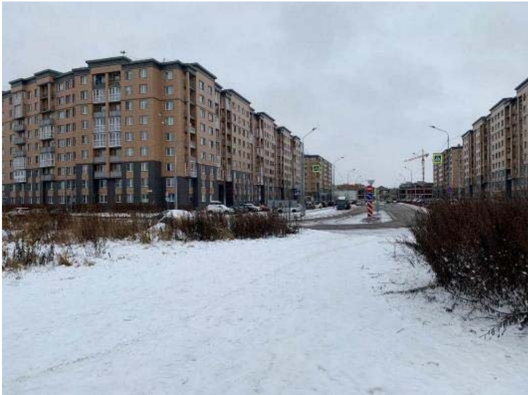
Рис. 48. Санкт-Петербург, Фрунзенский, Московский и Пушкинский р-ны. Точка съемки 9. Общий вид участка обследования. Вид на ВЮВ.
