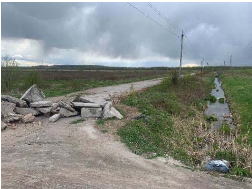
Рис. 270. Санкт-Петербург, Фрунзенский, Московский и Пушкинский р-ны. Точка съёмки 74. Общий вид участка обследования. Вид на ЗЮЗ.
