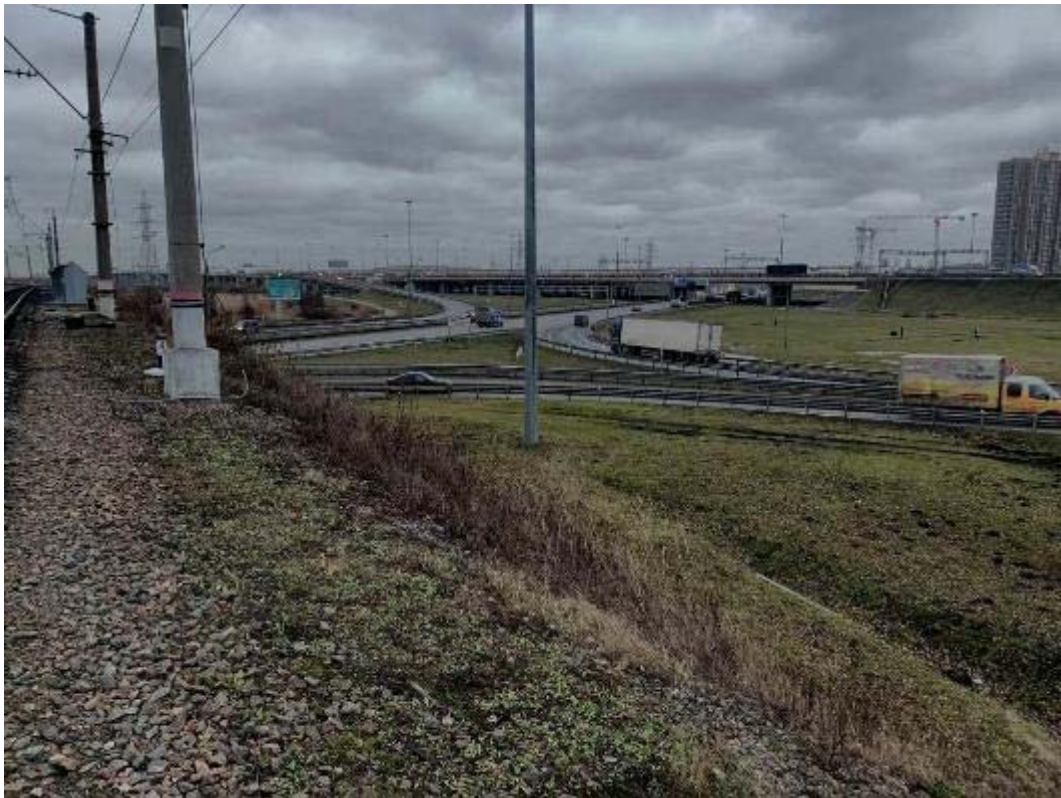
Рис. 99. Санкт-Петербург, Фрунзенский, Московский и Пушкинский р-ны. Точка съемки 26. Общий вид участка обследования. Вид на В.
