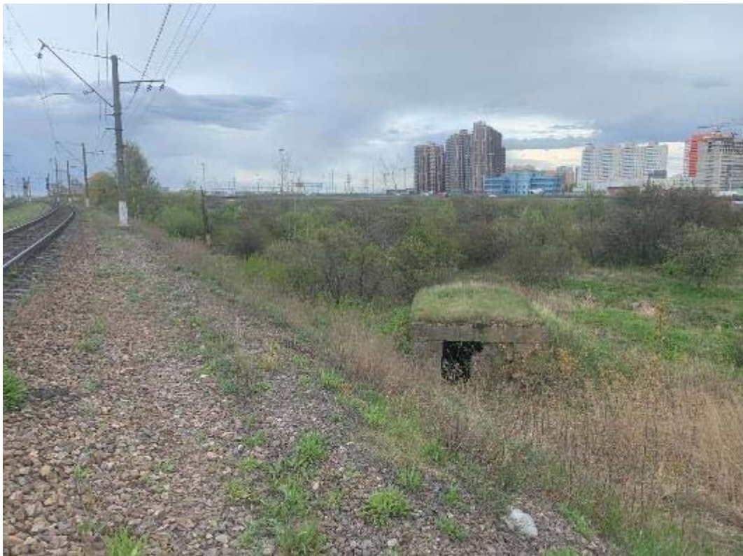
Рис. 318. Санкт-Петербург, Фрунзенский, Московский и Пушкинский р-ны. Точка съёмки 85. Общий вид участка обследования. Вид на ВЮВ.
