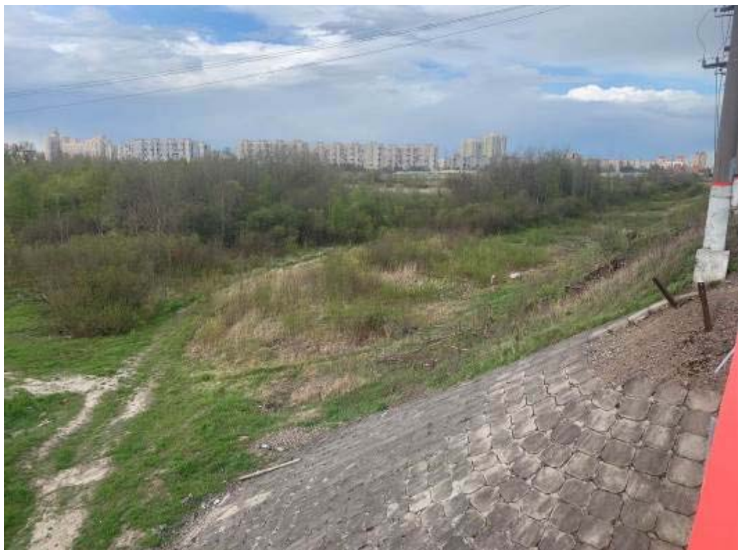
Рис. 352. Санкт-Петербург, Фрунзенский, Московский и Пушкинский р-ны. Точка съёмки 94. Общий вид участка обследования. Вид на СВ.
