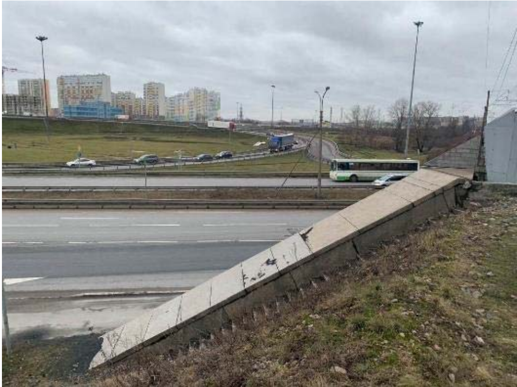
Рис. 102. Санкт-Петербург, Фрунзенский, Московский и Пушкинский р-ны. Точка съёмки 27. Общий вид участка обследования. Вид на ЗЮЗ.
