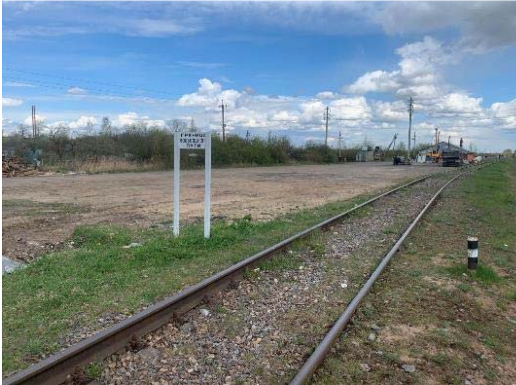
Рис. 209. Санкт-Петербург, Фрунзенский, Московский и Пушкинский р-ны. Точка съёмки 57. Общий вид участка обследования. Вид на СВ.
