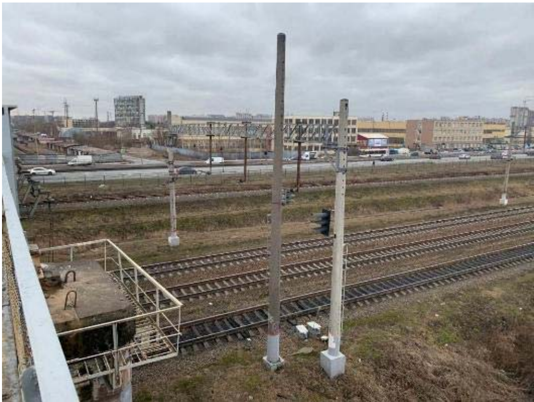
Рис. 113. Санкт-Петербург, Фрунзенский, Московский и Пушкинский р-ны. Точка съёмки 30. Общий вид участка обследования. Вид на СЗ.
