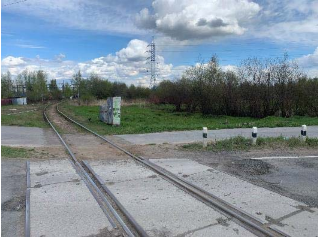
Рис. 219. Санкт-Петербург, Фрунзенский, Московский и Пушкинский р-ны.9 Точка съёмки 60. Общий вид участка обследования. Вид на СВ.
