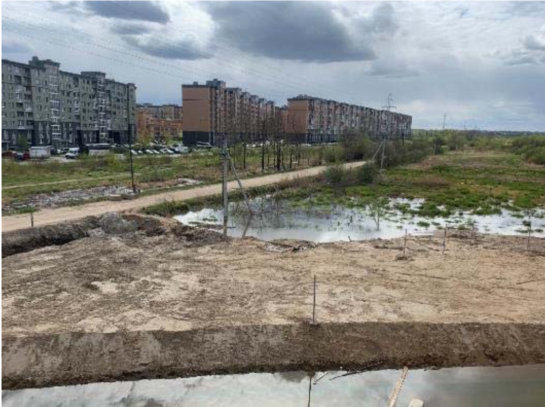
Рис. 188. Санкт-Петербург, Фрунзенский, Московский и Пушкинский р-ны. Точка съёмки 51. Общий вид участка обследования. Вид на ЮЗ.
