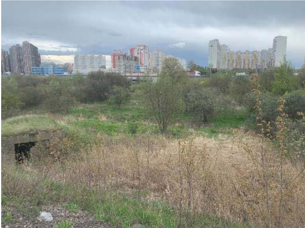
Рис. 319. Санкт-Петербург, Фрунзенский, Московский и Пушкинский р-ны. Точка съёмки 85. Общий вид участка обследования. Вид на ЮЮВ.
