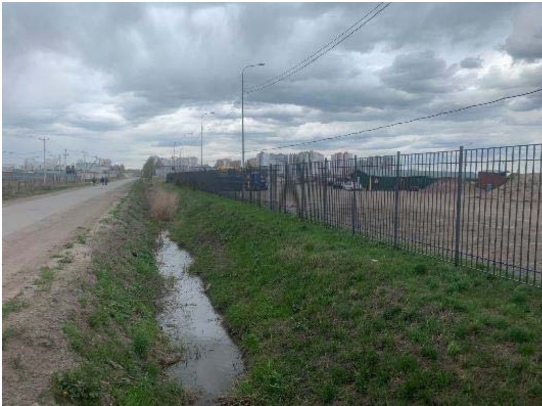
Рис. 263. Санкт-Петербург, Фрунзенский, Московский и Пушкинский р-ны. Точка съёмки 73. Общий вид участка обследования. Вид на С.
