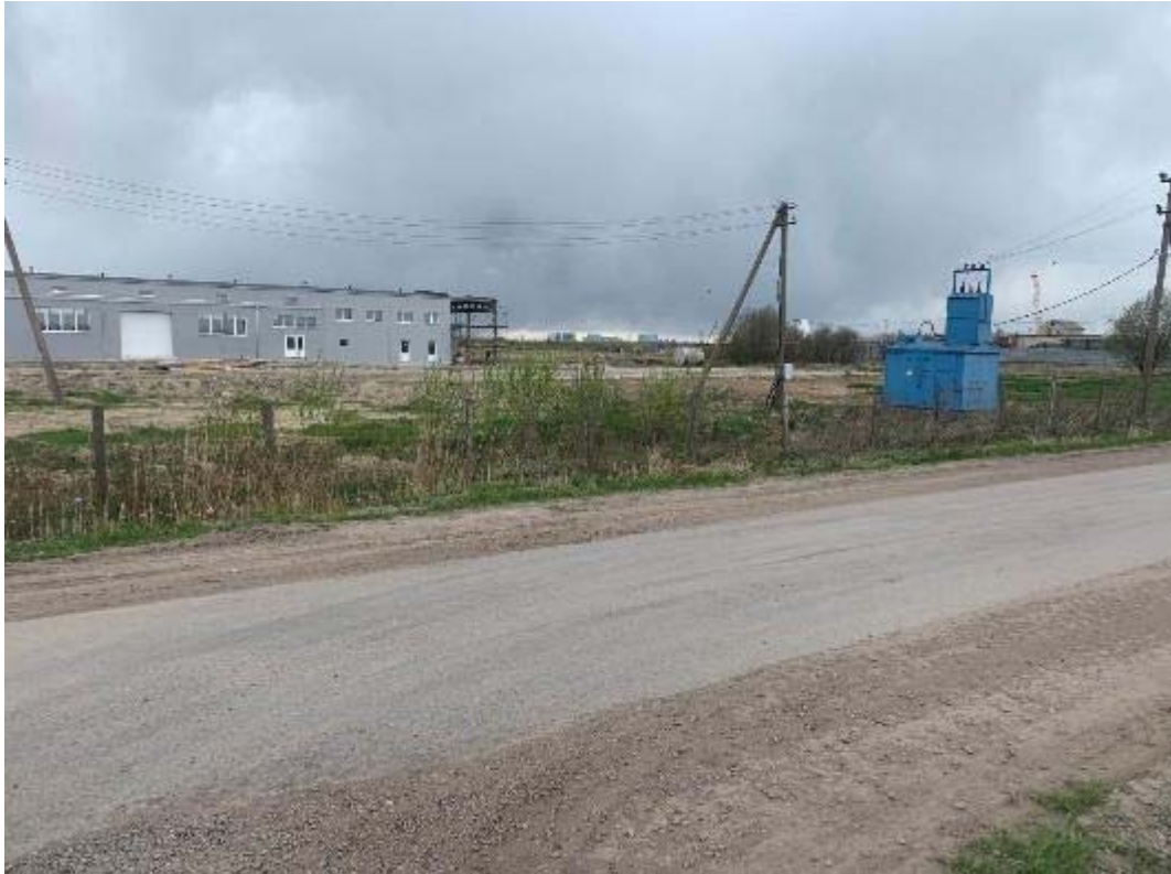
Рис. 265. Санкт-Петербург, Фрунзенский, Московский и Пушкинский р-ны. Точка съёмки 73. Общий вид участка обследования. Вид на СЗ.
