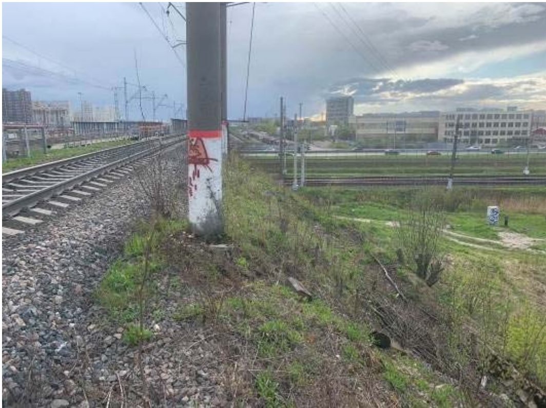
Рис. 353. Санкт-Петербург, Фрунзенский, Московский и Пушкинский р-ны. Точка съёмки 95. Общий вид участка обследования. Вид на ЗЮЗ.
