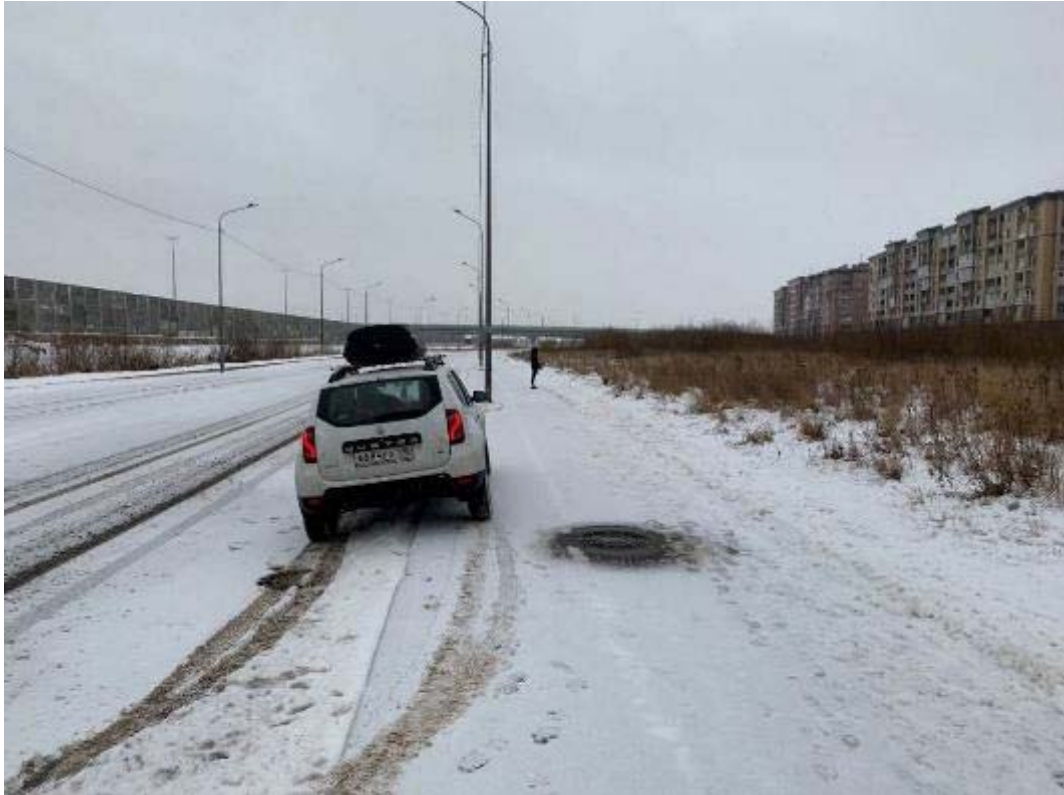
Рис. 40. Санкт-Петербург, Фрунзенский, Московский и Пушкинский р-ны. Точка съёмки 7. Общий вид участка обследования. Вид на ЮВ.
