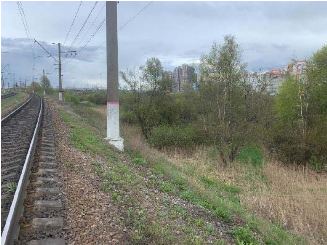
Рис. 311. Санкт-Петербург, Фрунзенский, Московский и Пушкинский р-ны. Точка съёмки 83. Общий вид участка обследования. Вид на ВЮВ.
