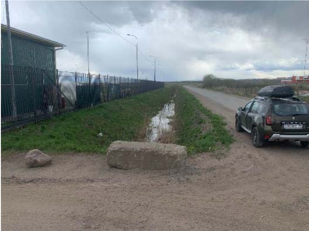
Рис. 267. Санкт-Петербург, Фрунзенский, Московский и Пушкинский р-ны. Точка съёмки 73. Общий вид участка обследования. Вид на Ю.
