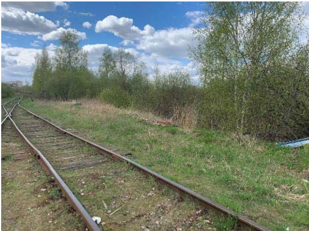
Рис. 210. Санкт-Петербург, Фрунзенский, Московский и Пушкинский р-ны. Точка съёмки 57. Общий вид участка обследования. Вид на ЗЮЗ.
