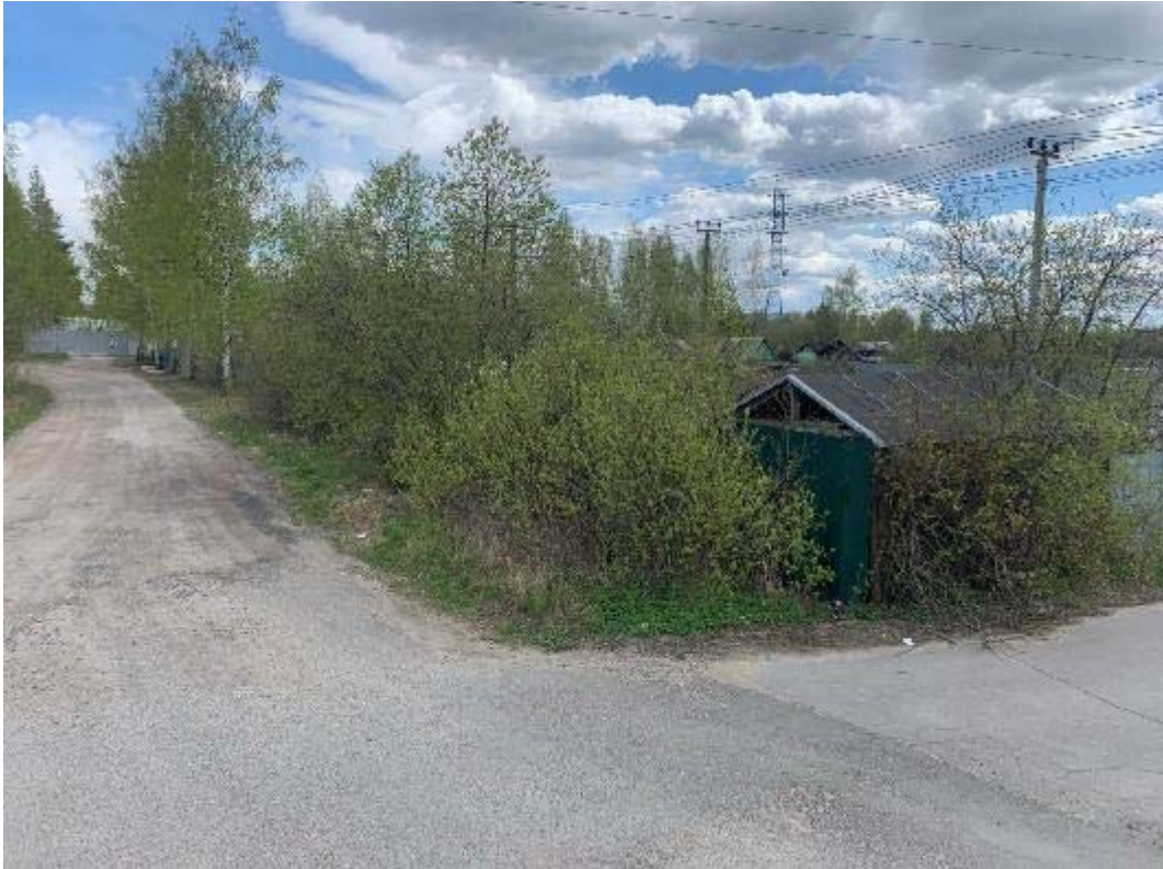
Рис. 227. Санкт-Петербург, Фрунзенский, Московский и Пушкинский р-ны. Точка съёмки 61. Общий вид участка обследования. Вид на ВЮВ.
