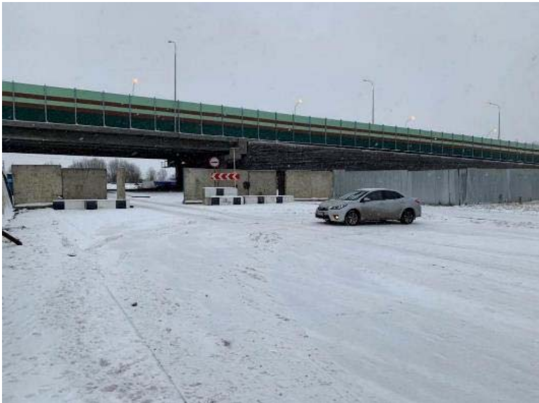
Рис. 35. Санкт-Петербург, Фрунзенский, Московский и Пушкинский р-ны. Точка съёмки 5. Общий вид участка обследования. Вид на Ю.
