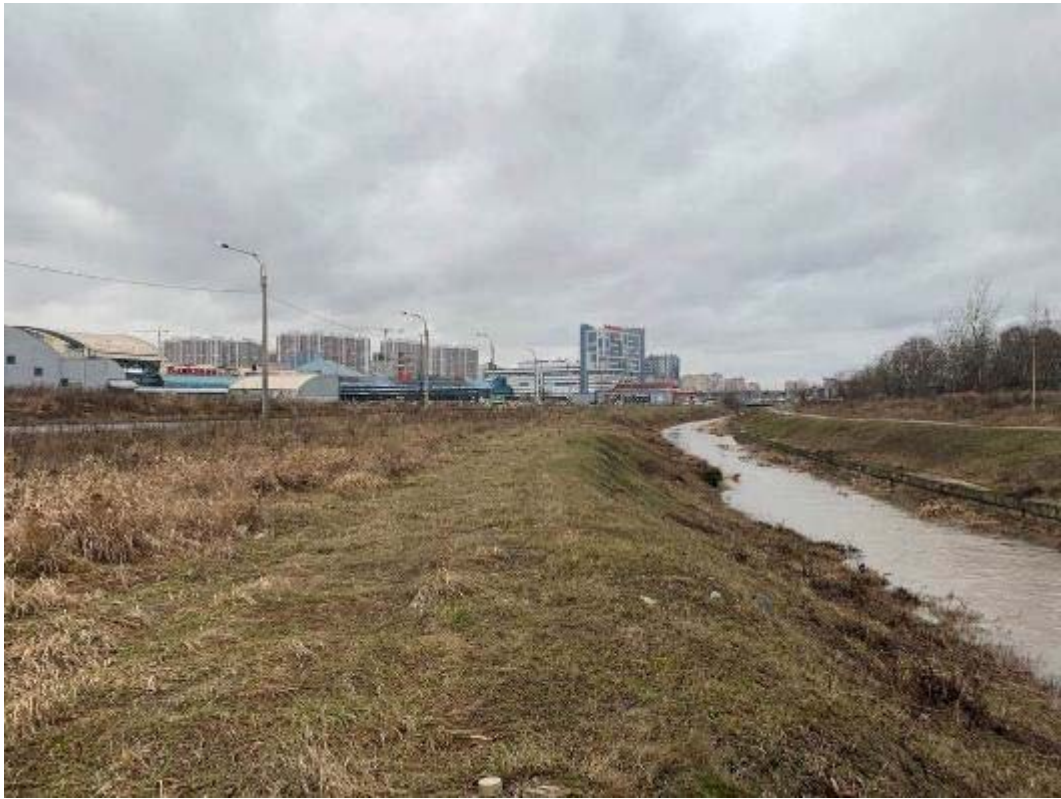
Рис. 124. Санкт-Петербург, Фрунзенский, Московский и Пушкинский р-ны. Точка съёмки 33. Общий вид участка обследования. Вид на СЗ
