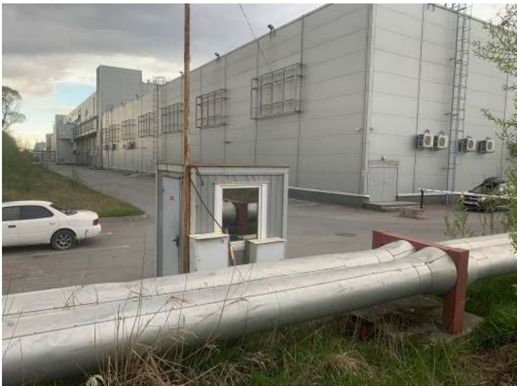
Рис. 358. Санкт-Петербург, Фрунзенский, Московский и Пушкинский р-ны. Точка съёмки 96. Общий вид участка обследования. Вид на ССВ.
