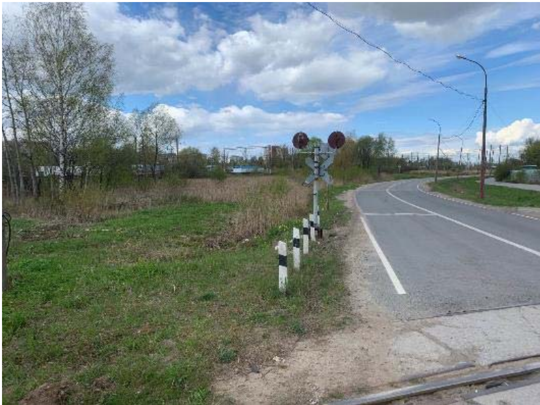
Рис. 221. Санкт-Петербург, Фрунзенский, Московский и Пушкинский р-ны. Точка съёмки 60. Общий вид участка обследования. Вид на ССЗ.
