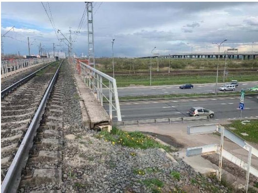
Рис. 346. Санкт-Петербург, Фрунзенский, Московский и Пушкинский р-ны. Точка съёмки 92. Общий вид участка обследования. Вид на В.
