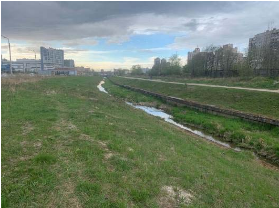
Рис. 384. Санкт-Петербург, Фрунзенский, Московский и Пушкинский р-ны. Точка съёмки 101. Общий вид участка обследования. Вид на С.
