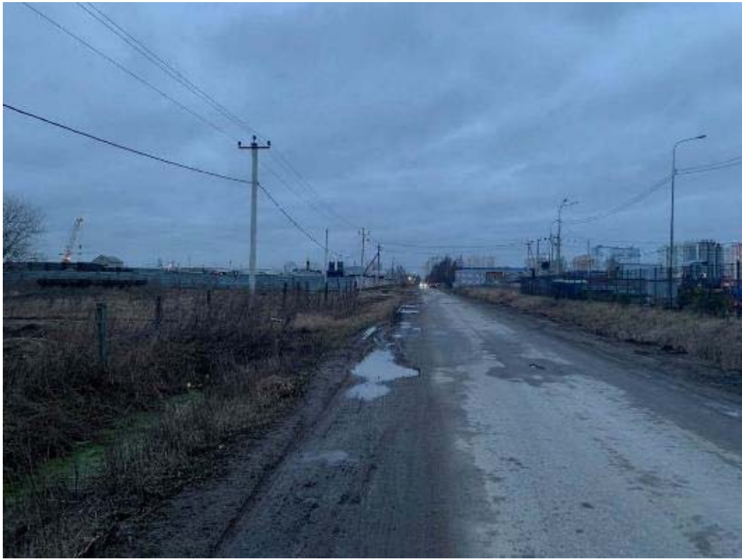
Рис. 72. Санкт-Петербург, Фрунзенский, Московский и Пушкинский р-ны. Точка съёмки 18. Общий вид участка обследования. Вид на С.
