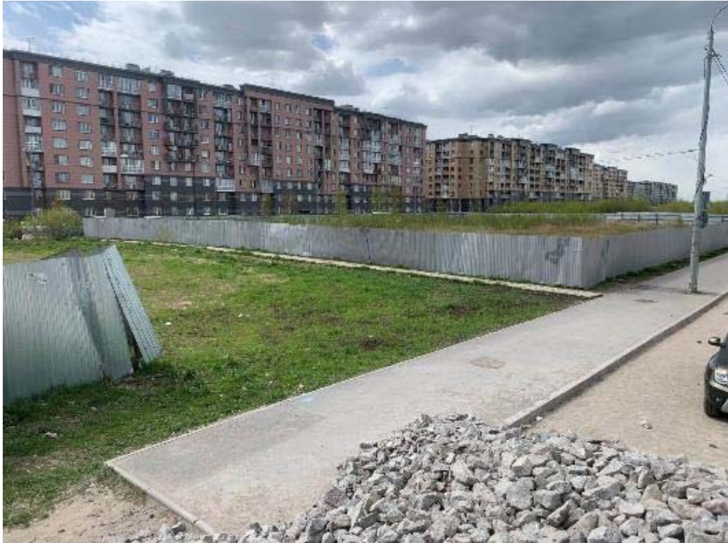
Рис. 174. Санкт-Петербург, Фрунзенский, Московский и Пушкинский р-ны. Точка съёмки 47. Общий вид участка обследования. Вид на ЗСЗ.
