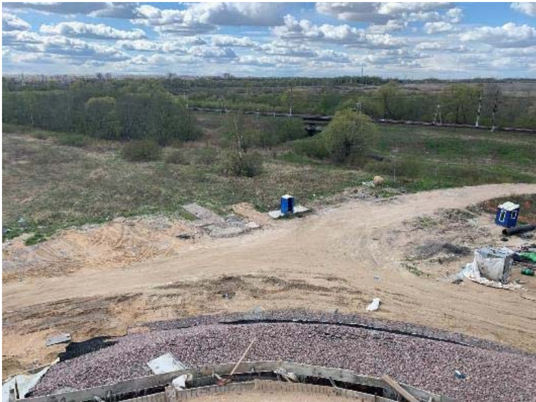
Рис. 241. Санкт-Петербург, Фрунзенский, Московский и Пушкинский р-ны. Точка съемки 66. Общий вид участка обследования. Вид на ЮЗ.
