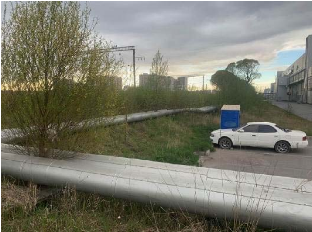
Рис. 357. Санкт-Петербург, Фрунзенский, Московский и Пушкинский р-ны. Точка съёмки 96. Общий вид участка обследования. Вид на ССЗ.
