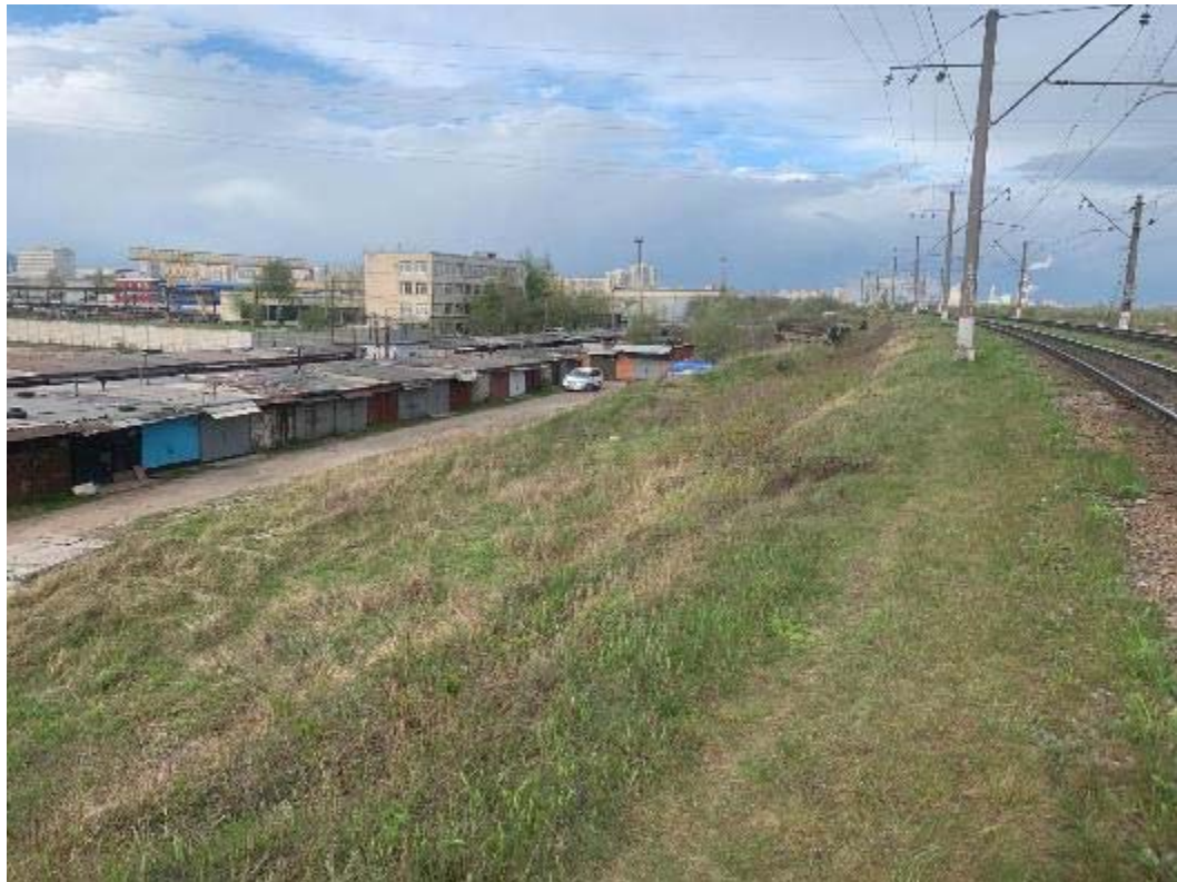
Рис. 340. Санкт-Петербург, Фрунзенский, Московский и Пушкинский р-ны. Точка съёмки 90. Общий вид участка обследования. Вид на СВ.
