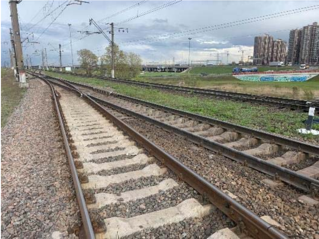
Рис. 325. Санкт-Петербург, Фрунзенский, Московский и Пушкинский р-ны. Точка съёмки 86. Общий вид участка обследования. Вид на ВЮВ.
