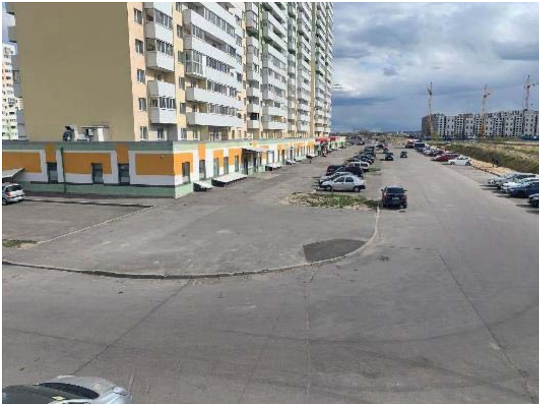
Рис. 285. Санкт-Петербург, Фрунзенский, Московский и Пушкинский р-ны. Точка съёмки 77. Общий вид участка обследования. Вид на ЮЮВ.
