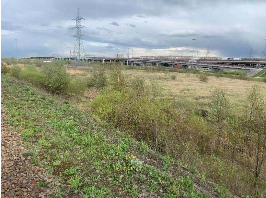
Рис. 343. Санкт-Петербург, Фрунзенский, Московский и Пушкинский р-ны. Точка съёмки 91. Общий вид участка обследования. Вид на ВЮВ.
