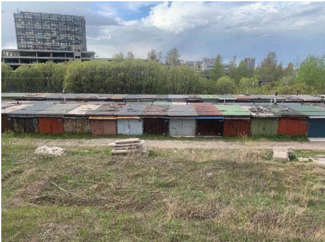
Рис. 338. Санкт-Петербург, Фрунзенский, Московский и Пушкинский р-ны. Точка съемки 90. Общий вид участка обследования. Вид на С.
