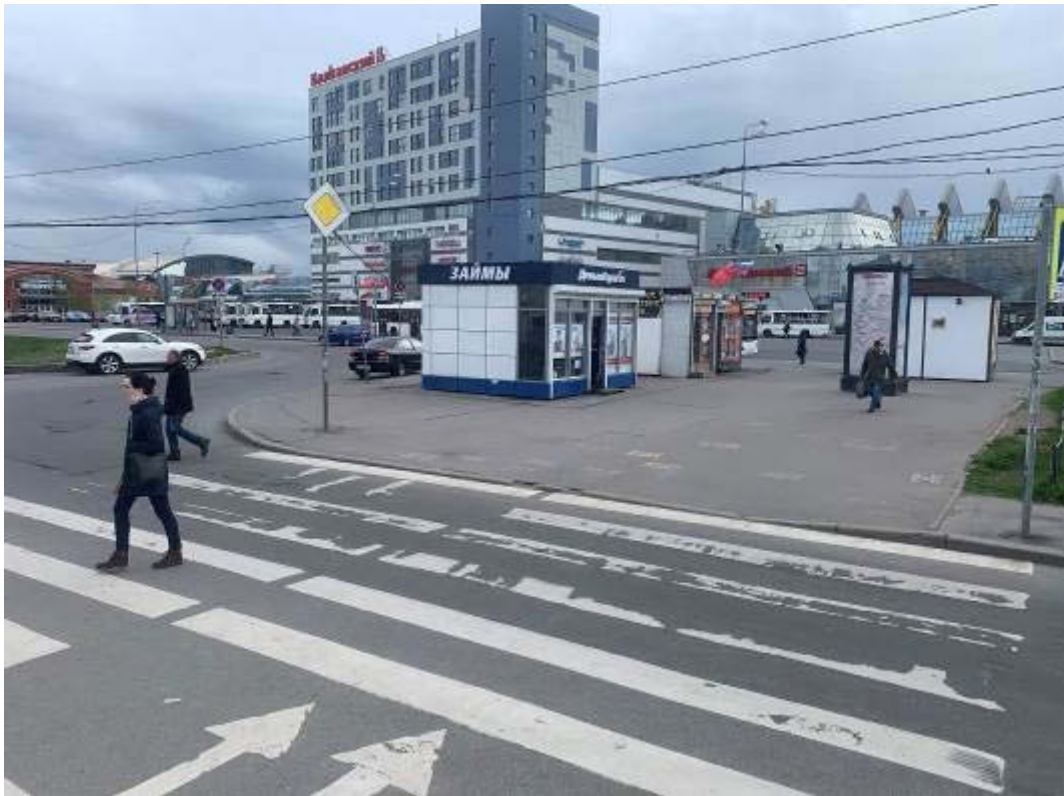
Рис. 401. Санкт-Петербург, Фрунзенский, Московский и Пушкинский р-ны. Точка съемки 105. Общий вид участка обследования. Вид на ЮЗ.
