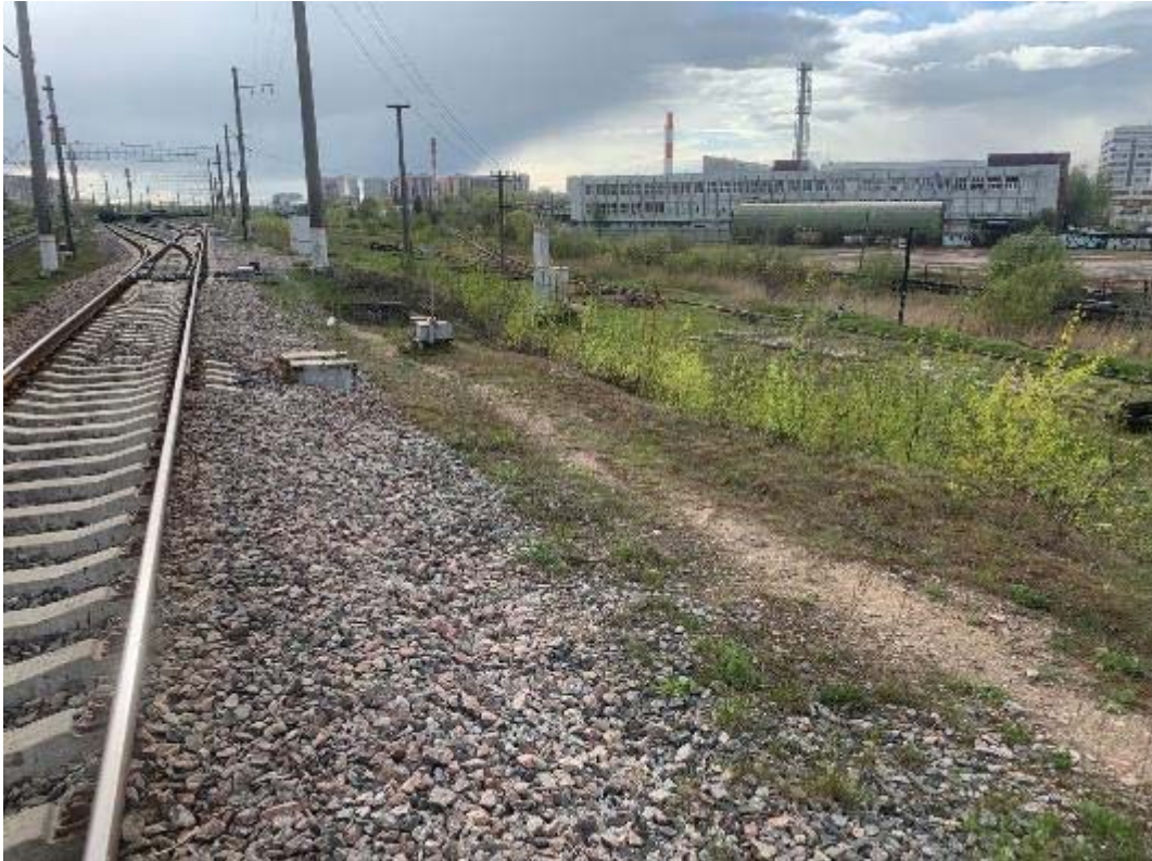
Рис. 323. Санкт-Петербург, Фрунзенский, Московский и Пушкинский р-ны. Точка съёмки 86. Общий вид участка обследования. Вид на ЗСЗ.
