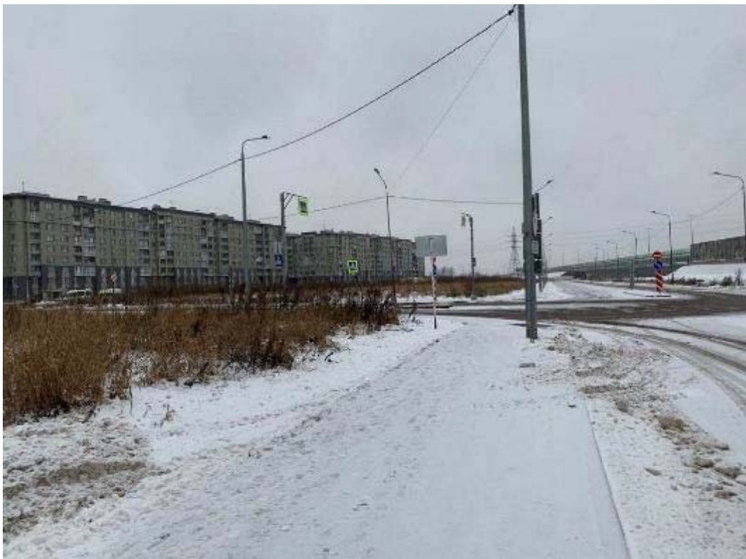
Рис. 43. Санкт-Петербург, Фрунзенский, Московский и Пушкинский р-ны. Точка съёмки 7. Общий вид участка обследования. Вид на СЗ.
