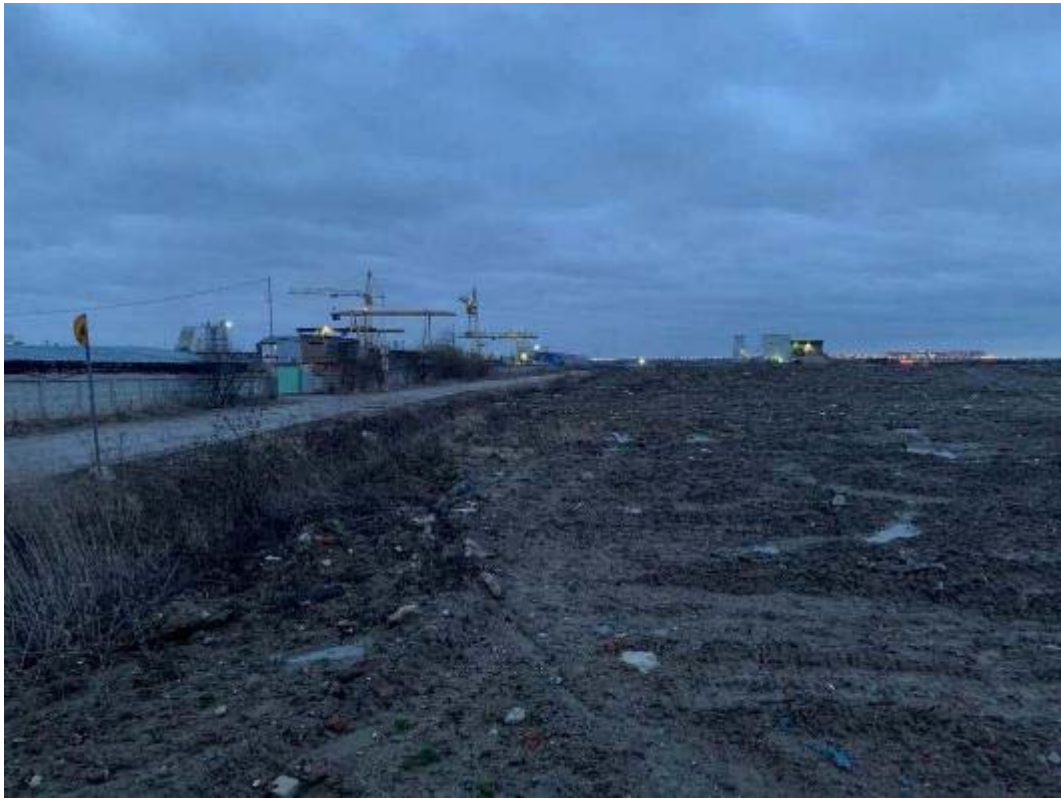
Рис. 76. Санкт-Петербург, Фрунзенский, Московский и Пушкинский р-ны. Точка съёмки 19. Общий вид участка обследования. Вид на Ю.
