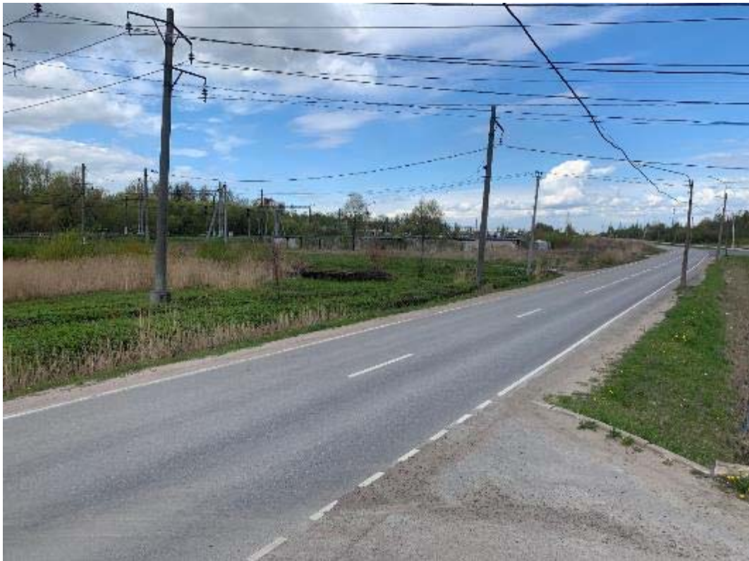
Рис. 223. Санкт-Петербург, Фрунзенский, Московский и Пушкинский р-ны. Точка съёмки 61. Общий вид участка обследования. Вид на ССЗ.
