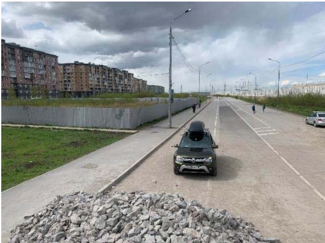
Рис. 175. Санкт-Петербург, Фрунзенский, Московский и Пушкинский р-ны. Точка съёмки 47. Общий вид участка обследования. Вид на СЗ.
