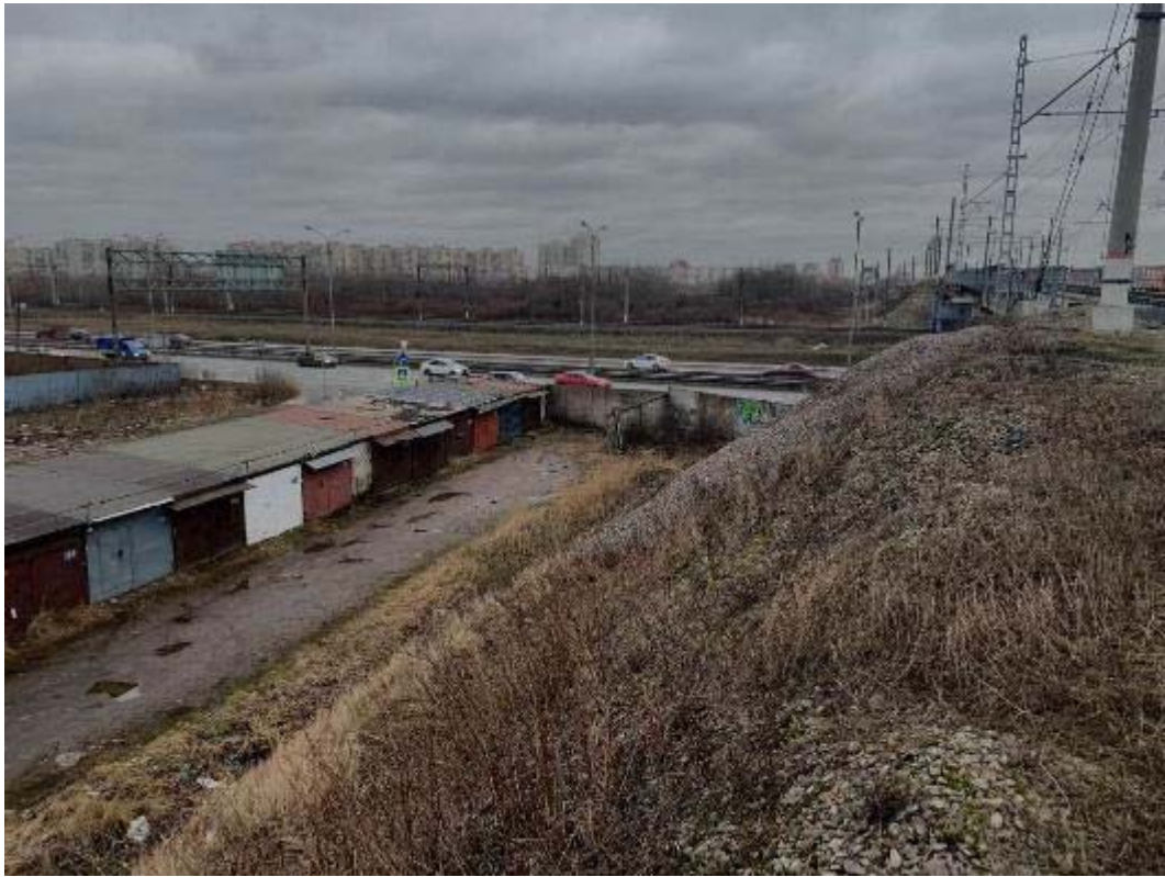
Рис. 112. Санкт-Петербург, Фрунзенский, Московский и Пушкинский р-ны. Точка съёмки 29. Общий вид участка обследования. Вид на СВ.
