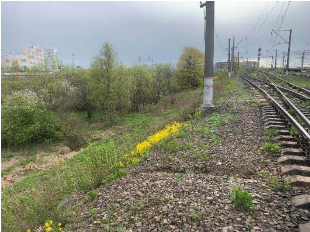
Рис. 329. Санкт-Петербург, Фрунзенский, Московский и Пушкинский р-ны. Точка съёмки 87. Общий вид участка обследования. Вид на ЗЮЗ.
