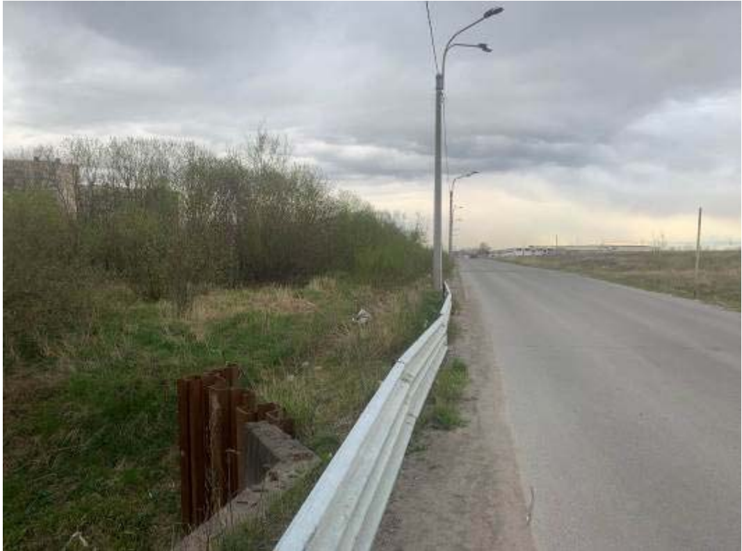
Рис. 371. Санкт-Петербург, Фрунзенский, Московский и Пушкинский р-ны. Точка съёмки 98. Общий вид участка обследования. Вид на ВЮВ.
