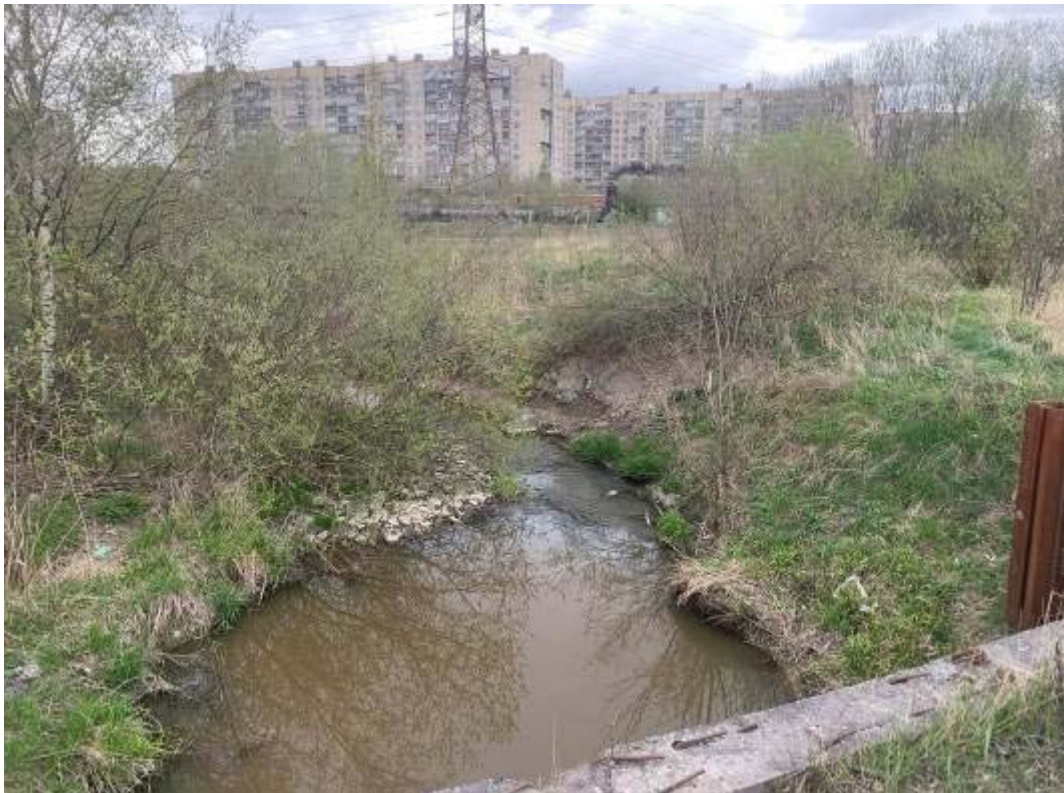
Рис. 370. Санкт-Петербург, Фрунзенский, Московский и Пушкинский р-ны. Точка съёмки 98. Общий вид участка обследования. Вид на ССВ.
