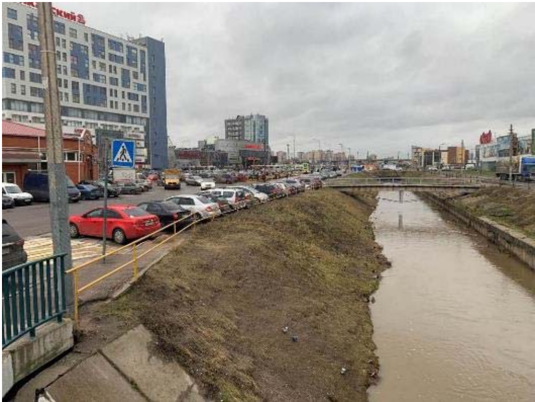
Рис. 126. Санкт-Петербург, Фрунзенский, Московский и Пушкинский р-ны. Точка съёмки 34. Общий вид участка обследования. Вид на СЗ.
