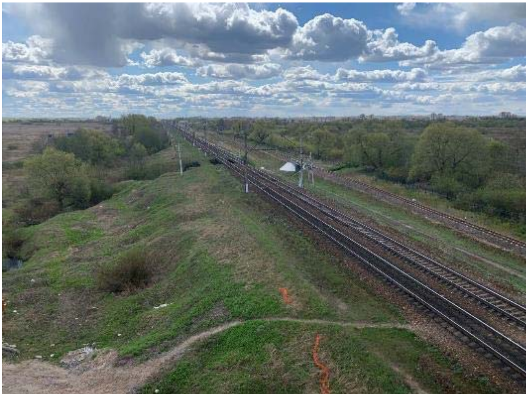
Рис. 238. Санкт-Петербург, Фрунзенский, Московский и Пушкинский р-ны. Точка съёмки 65. Общий вид участка обследования. Вид на Ю.
