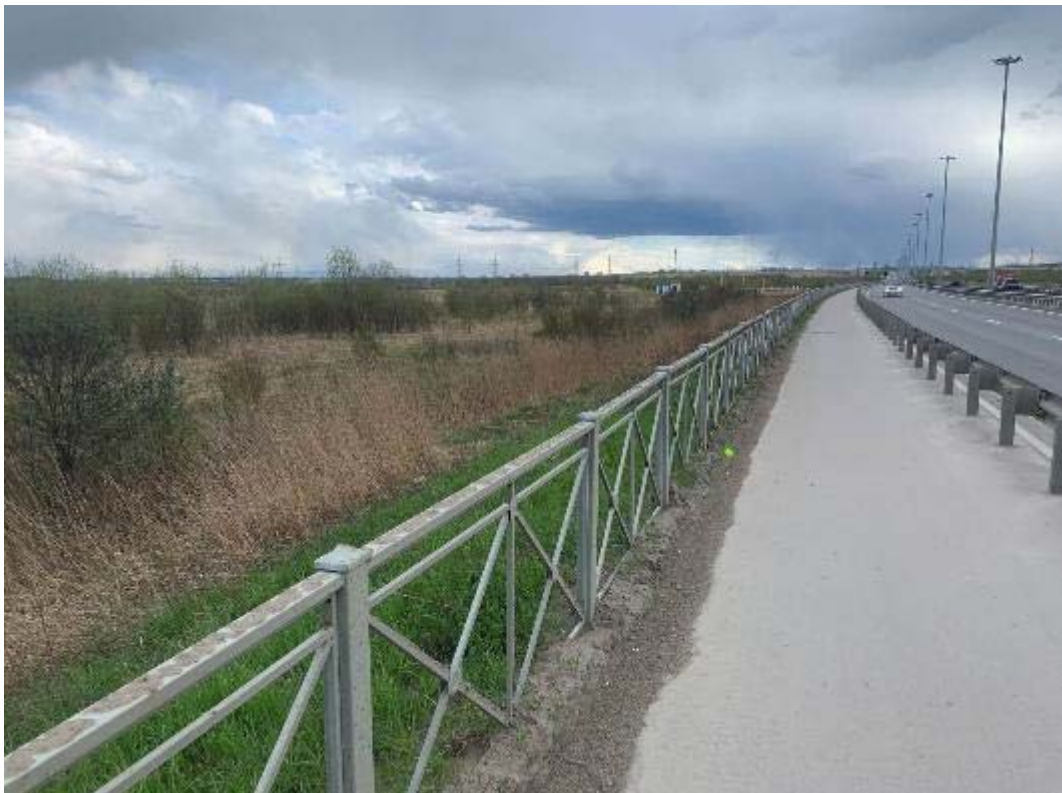
Рис. 252. Санкт-Петербург, Фрунзенский, Московский и Пушкинский р-ны. Точка съёмки 70. Общий вид участка обследования. Вид на С.
