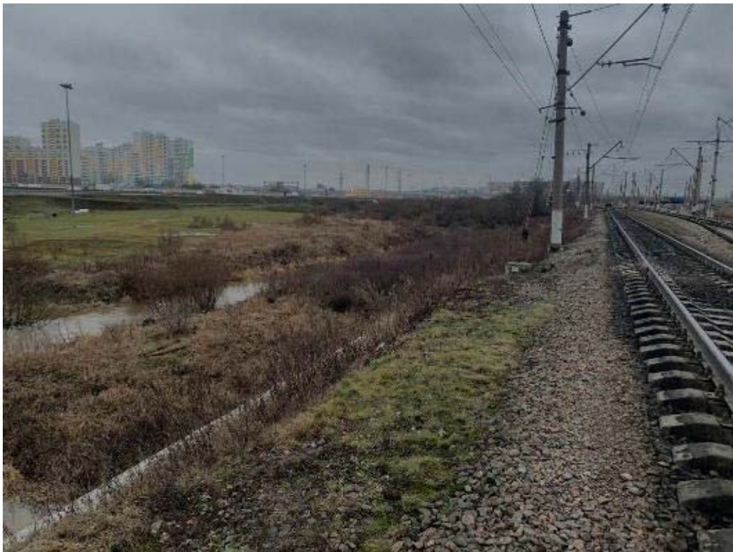
Рис. 101. Санкт-Петербург, Фрунзенский, Московский и Пушкинский р-ны. Точка съемки 26. Общий вид участка обследования. Вид на ЗЮЗ.
