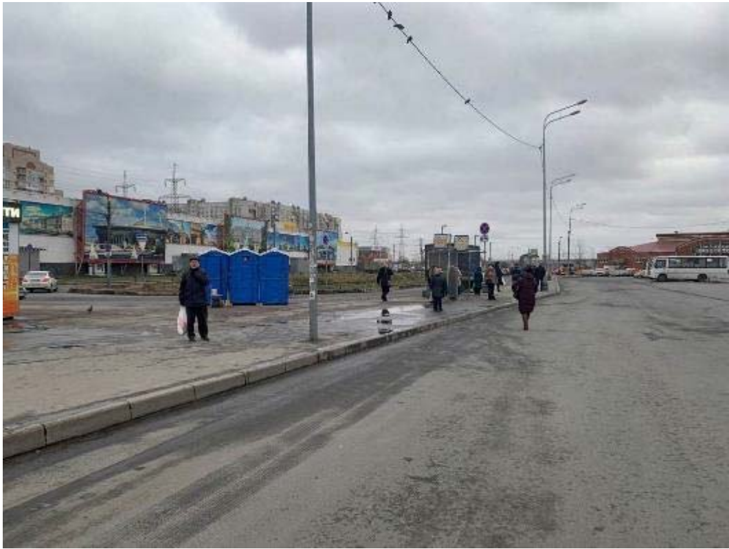
Рис. 128. Санкт-Петербург, Фрунзенский, Московский и Пушкинский р-ны. Точка съёмки 35. Общий вид участка обследования. Вид на ССЗ
