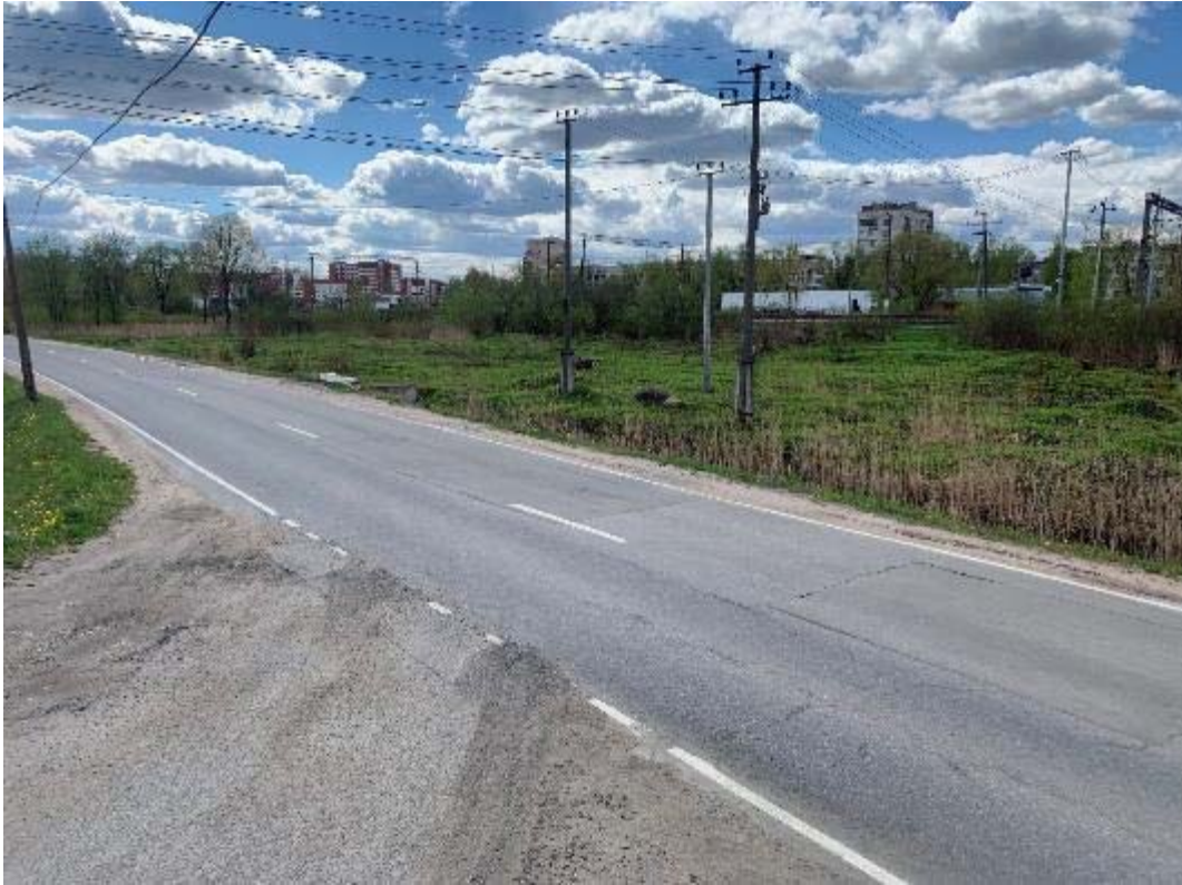
Рис. 225. Санкт-Петербург, Фрунзенский, Московский и Пушкинский р-ны. Точка съёмки 61. Общий вид участка обследования. Вид на ЮЮЗ.
