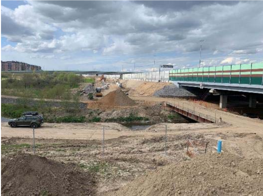
Рис. 144. Санкт-Петербург, Фрунзенский, Московский и Пушкинский р-ны. Точка съёмки 40. Общий вид участка обследования. Вид на СЗ.
