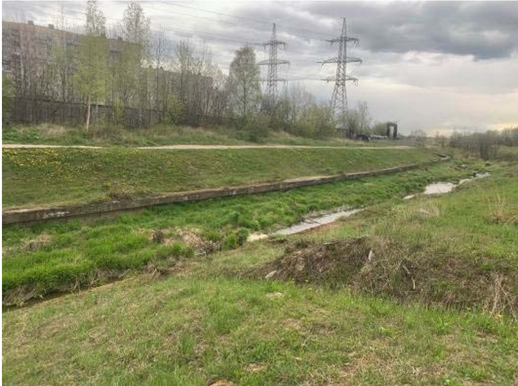
Рис. 385. Санкт-Петербург, Фрунзенский, Московский и Пушкинский р-ны. Точка съёмки 101. Общий вид участка обследования. Вид на ВЮВ.
