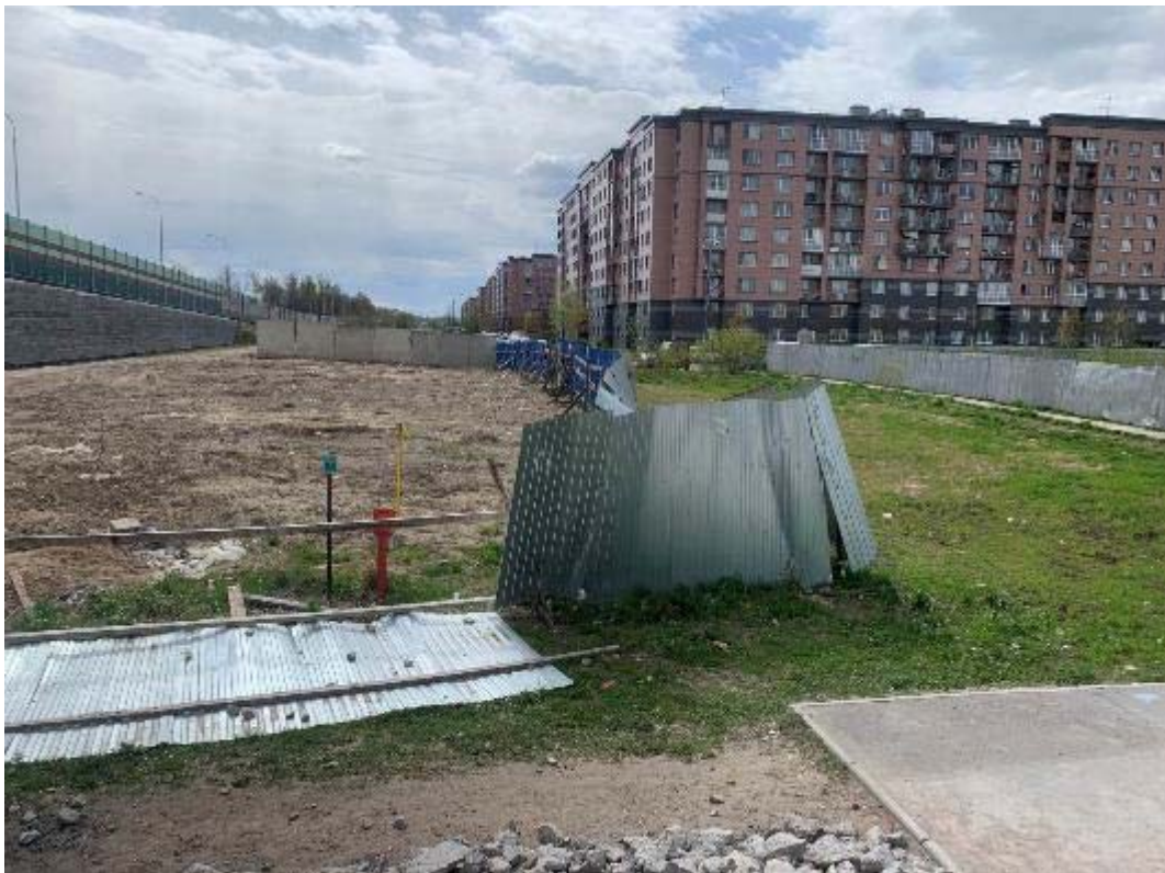
Рис. 173. Санкт-Петербург, Фрунзенский, Московский и Пушкинский р-ны. Точка съемки 47. Общий вид участка обследования. Вид на ЮЗ.
