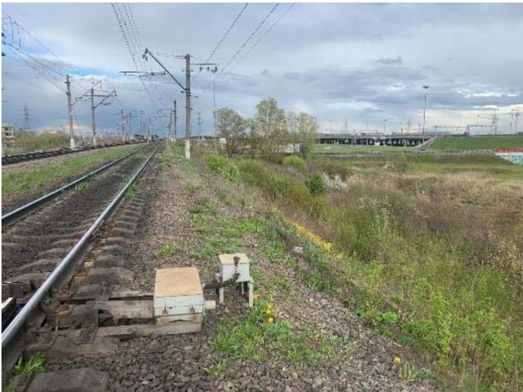
Рис. 326. Санкт-Петербург, Фрунзенский, Московский и Пушкинский р-ны. Точка съёмки 87. Общий вид участка обследования. Вид на В.
