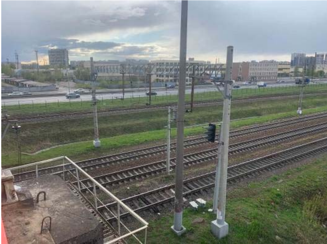
Рис. 349. Санкт-Петербург, Фрунзенский, Московский и Пушкинский р-ны. Точка съёмки 94. Общий вид участка обследования. Вид на ЗСЗ.
