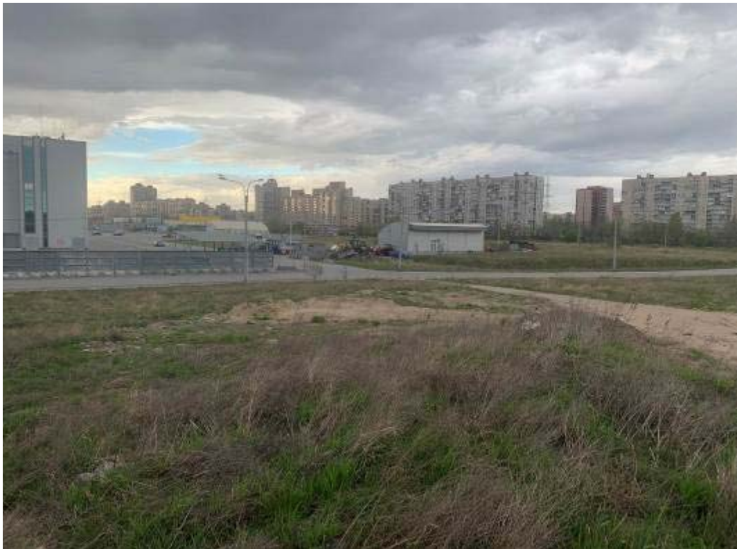
Рис. 364. Санкт-Петербург, Фрунзенский, Московский и Пушкинский р-ны. Точка съёмки 97. Общий вид участка обследования. Вид на ССВ.
