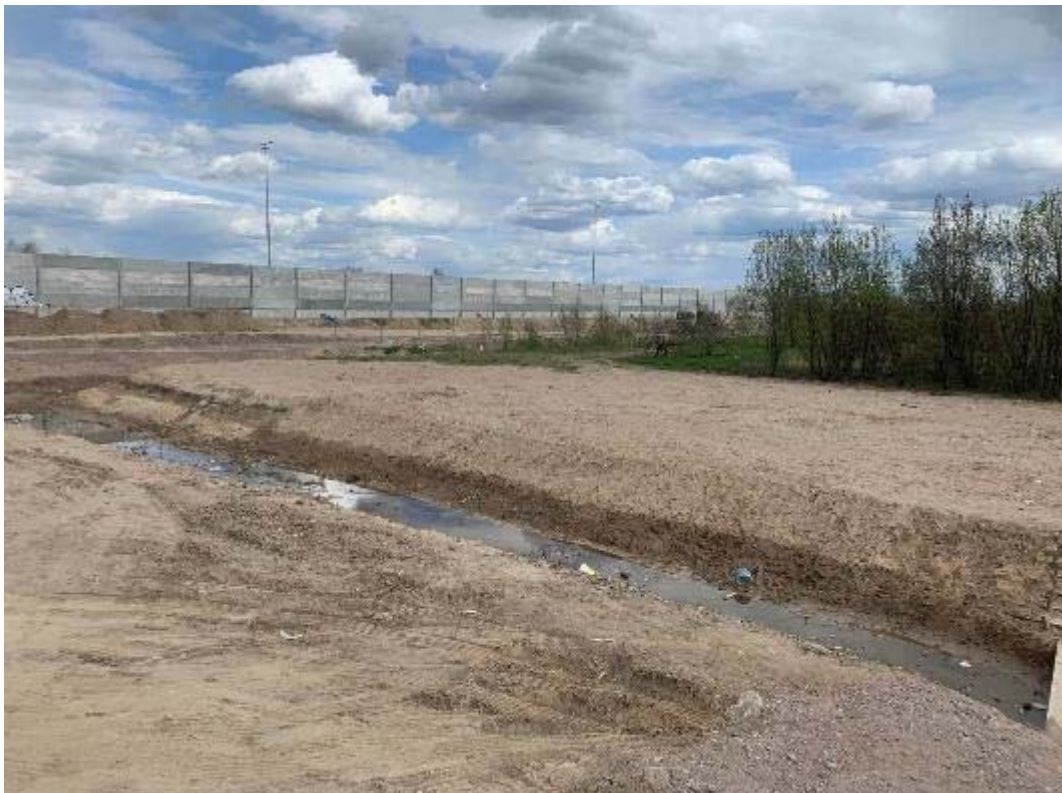
Рис. 169. Санкт-Петербург, Фрунзенский, Московский и Пушкинский р-ны. Точка съёмки 45. Общий вид участка обследования. Вид на В.
