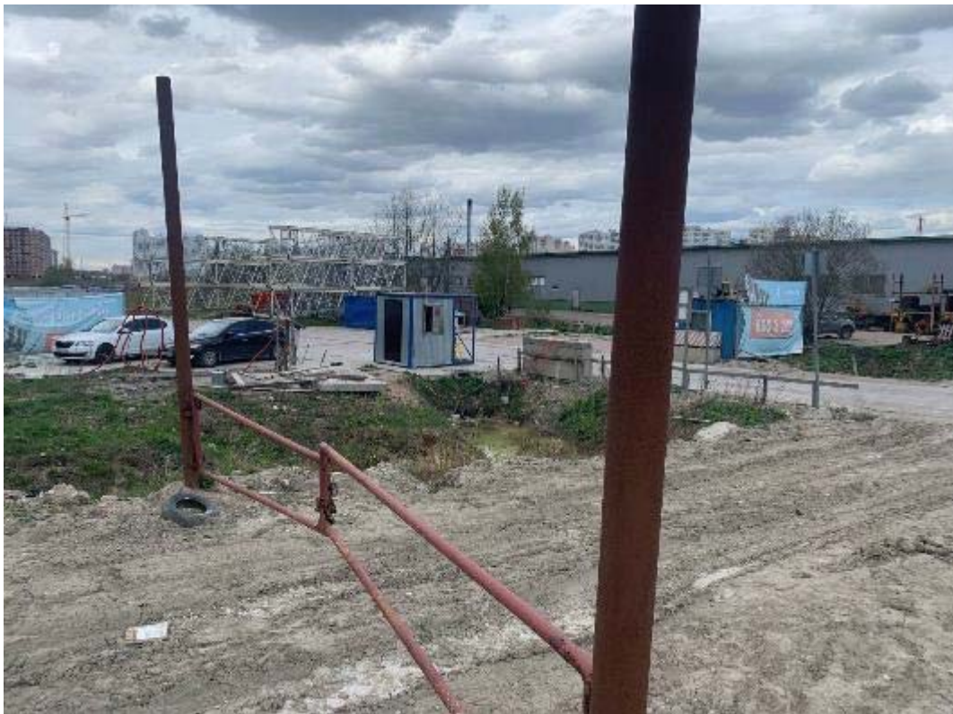
Рис. 274. Санкт-Петербург, Фрунзенский, Московский и Пушкинский р-ны. Точка съёмки 75. Общий вид участка обследования. Вид на ССВ.
