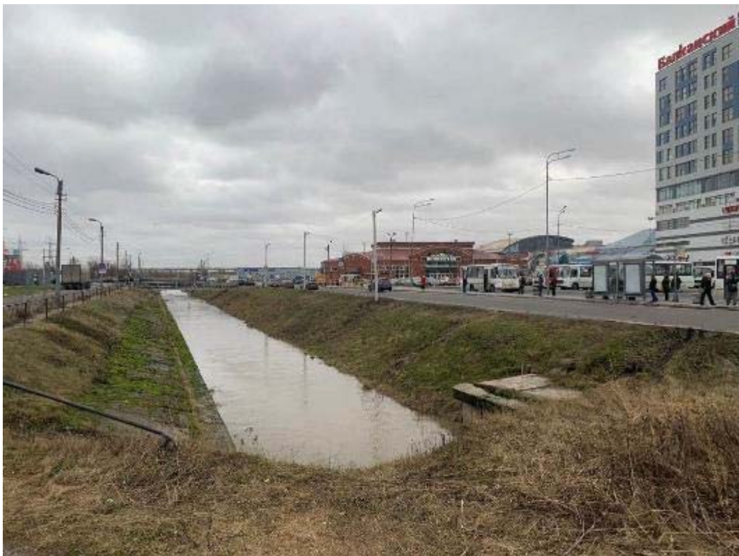
Рис. 127. Санкт-Петербург, Фрунзенский, Московский и Пушкинский р-ны. Точка съёмки 35. Общий вид участка обследования. Вид на Ю.
