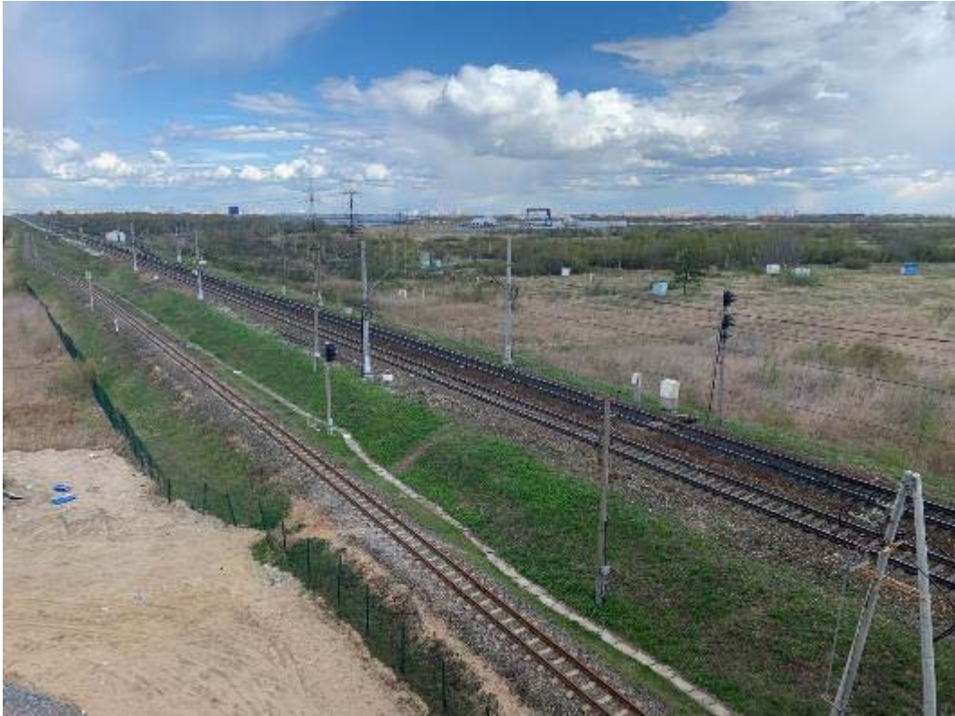
Рис. 247. Санкт-Петербург, Фрунзенский, Московский и Пушкинский р-ны. Точка съёмки 68. Общий вид участка обследования. Вид на С.
