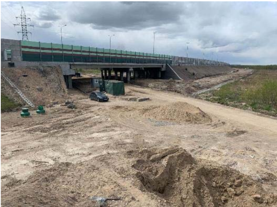
Рис. 183. Санкт-Петербург, Фрунзенский, Московский и Пушкинский р-ны. Точка съёмки 50. Общий вид участка обследования. Вид на З.
