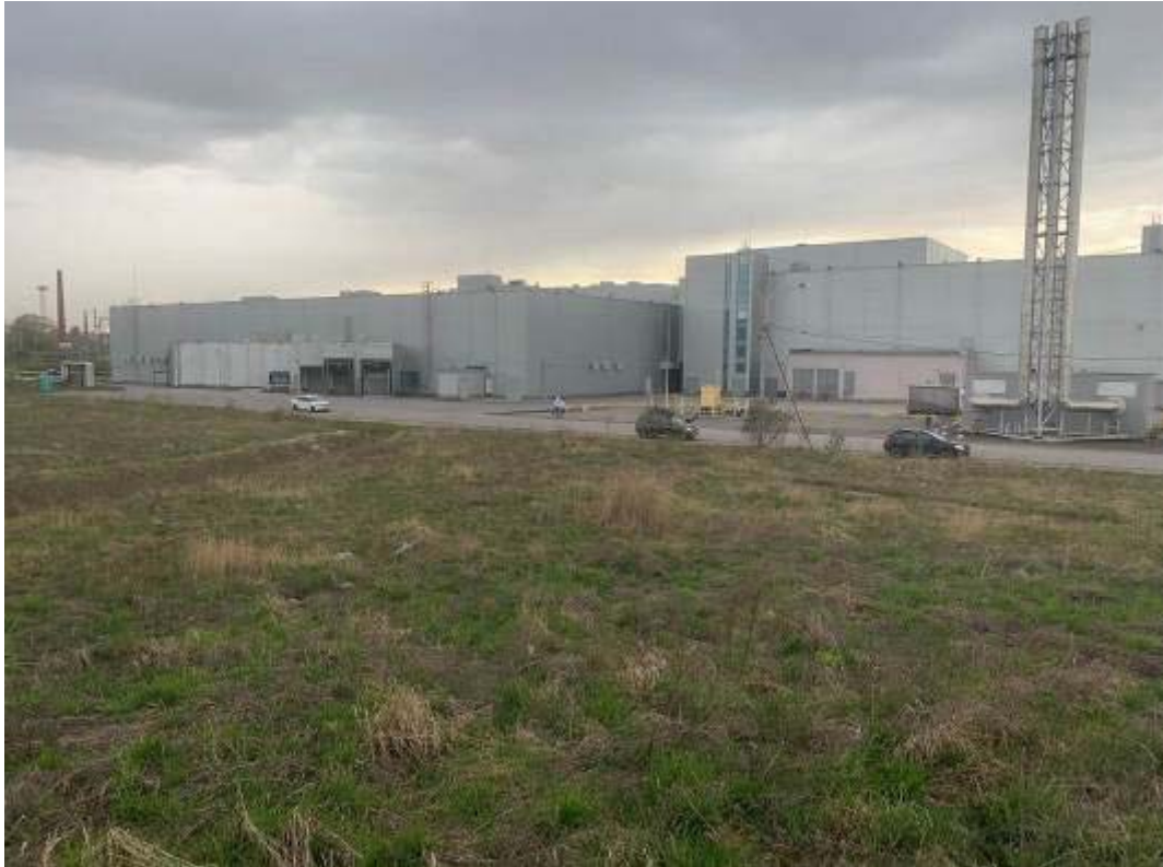
Рис. 363. Санкт-Петербург, Фрунзенский, Московский и Пушкинский р-ны. Точка съёмки 97. Общий вид участка обследования. Вид на СЗ.
