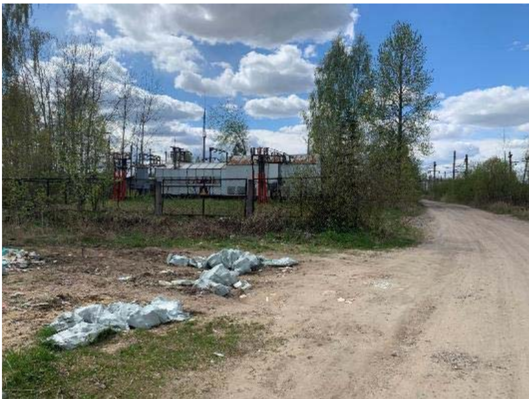
Рис. 216. Санкт-Петербург, Фрунзенский, Московский и Пушкинский р-ны. Точка съёмки 59. Общий вид участка обследования. Вид на ЗЮЗ.
