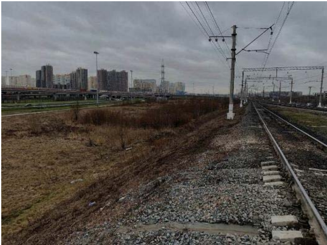
Рис. 110. Санкт-Петербург, Фрунзенский, Московский и Пушкинский р-ны. Точка съёмки 29. Общий вид участка обследования. Вид на ЮЗ.
