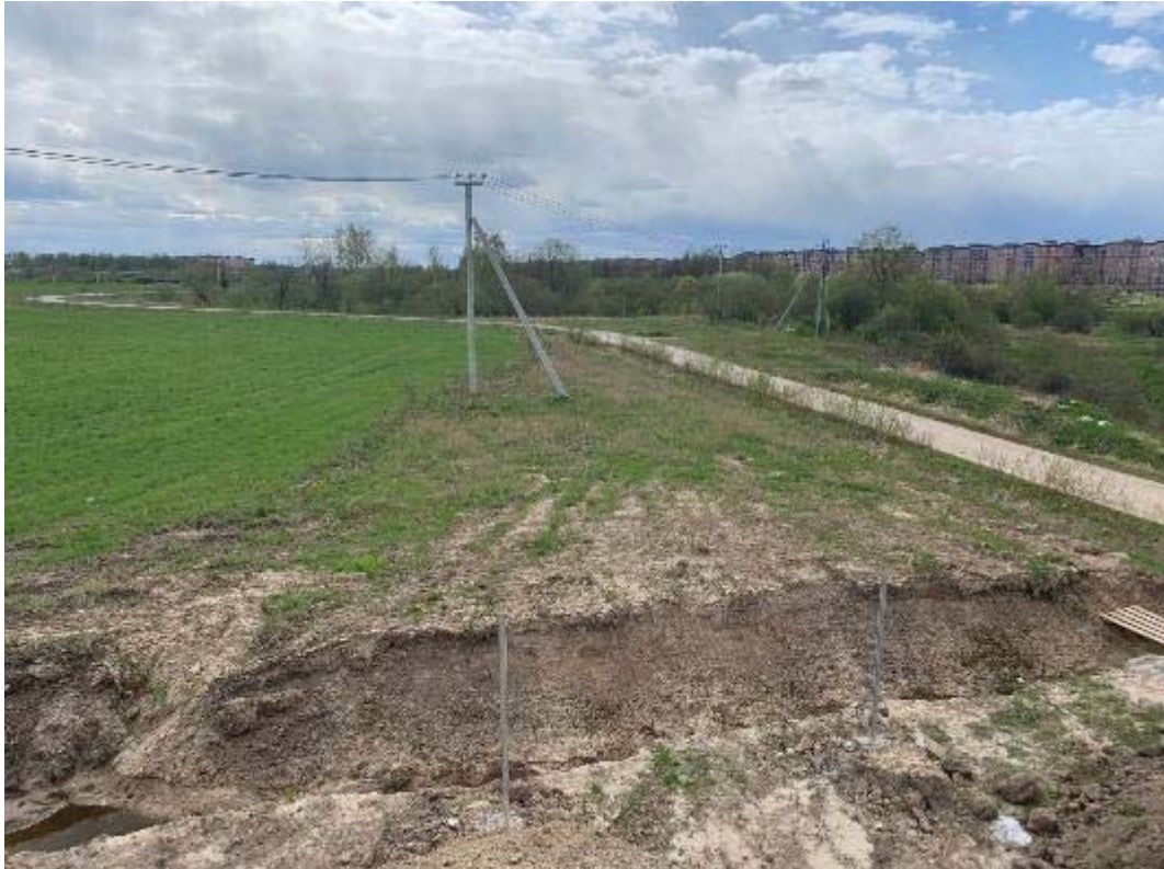
Рис. 146. Санкт-Петербург, Фрунзенский, Московский и Пушкинский р-ны. Точка съёмки 40. Общий вид участка обследования. Вид на ЗЮЗ.
