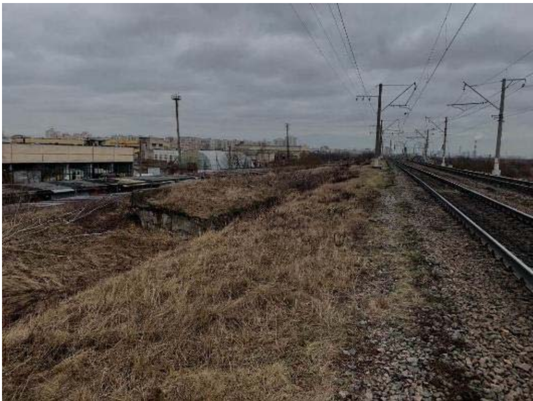
Рис. 107. Санкт-Петербург, Фрунзенский, Московский и Пушкинский р-ны. Точка съёмки 28. Общий вид участка обследования. Вид на ВСВ.
