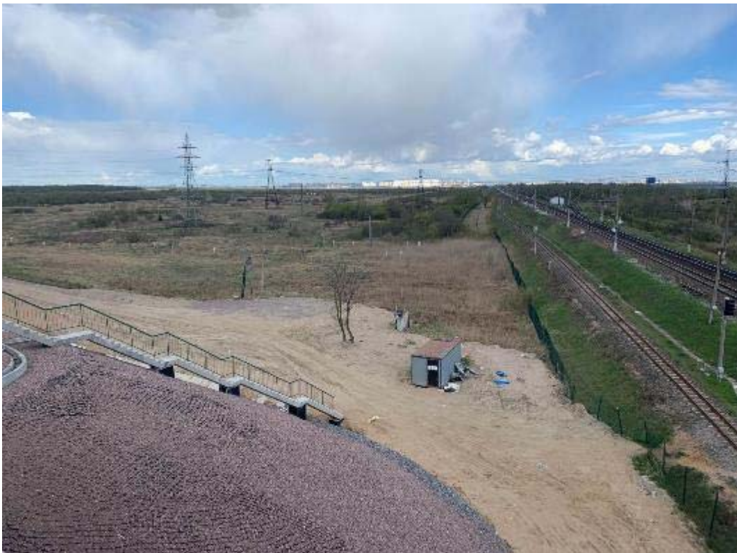
Рис. 248. Санкт-Петербург, Фрунзенский, Московский и Пушкинский р-ны. Точка съёмки 68. Общий вид участка обследования. Вид на ССЗ.
