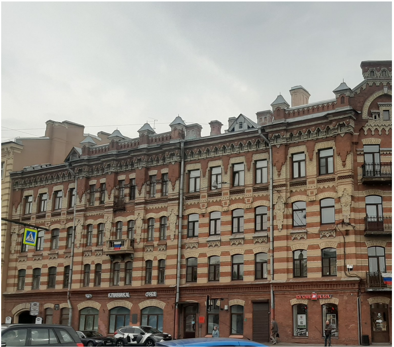
2. Объект культурного наследия регионального значения «Дом К.Я. Маевского» г. Санкт-Петербург, наб. реки Фонтанки, д. 110, лит. А. Вид северного фасада со стороны наб. реки Фонтанки.
