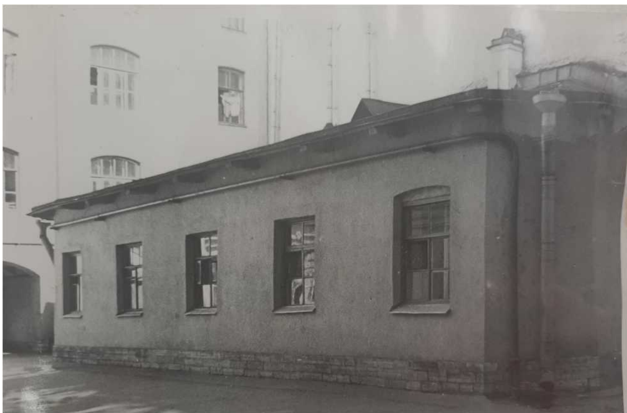
Илл. 8. Фасад одноэтажного флигеля во дворе. 1968 г. Архив института «ЛЕНЖИЛПРОЕКТ»
