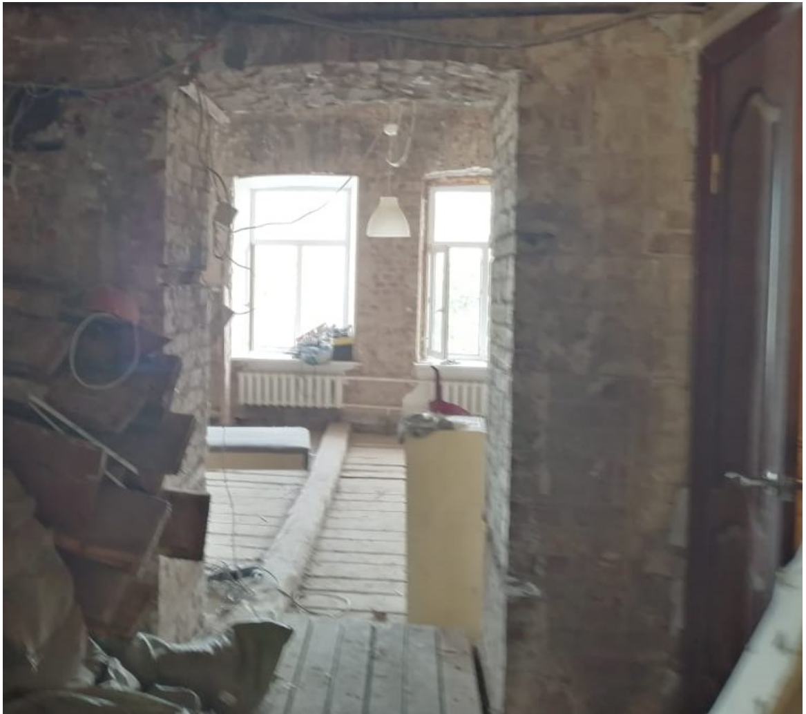
6. Объект культурного наследия регионального значения «Дом К.Я. Маевского» г. Санкт-Петербург, наб. реки Фонтанки, д. 110, лит. А. квартира 18. 4 этаж. Помещение у дворового фасада. Вид на проем в продольной стене (направление съемки – север).
