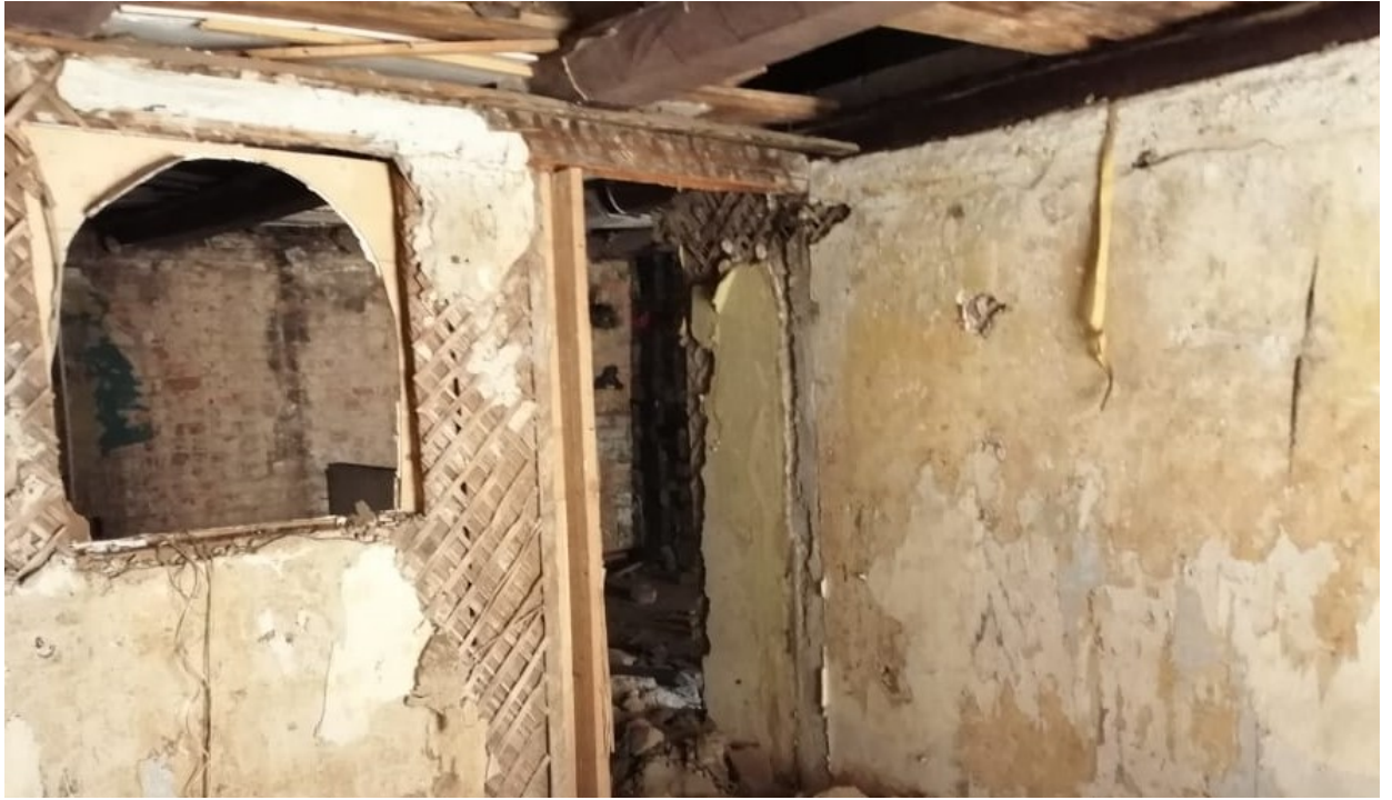
17. Объект культурного наследия регионального значения «Дом К.Я. Маевского» г. Санкт-Петербург, наб. реки Фонтанки, д. 110, лит. А. квартира 18. Помещения 5 этажа. Вид на север.
