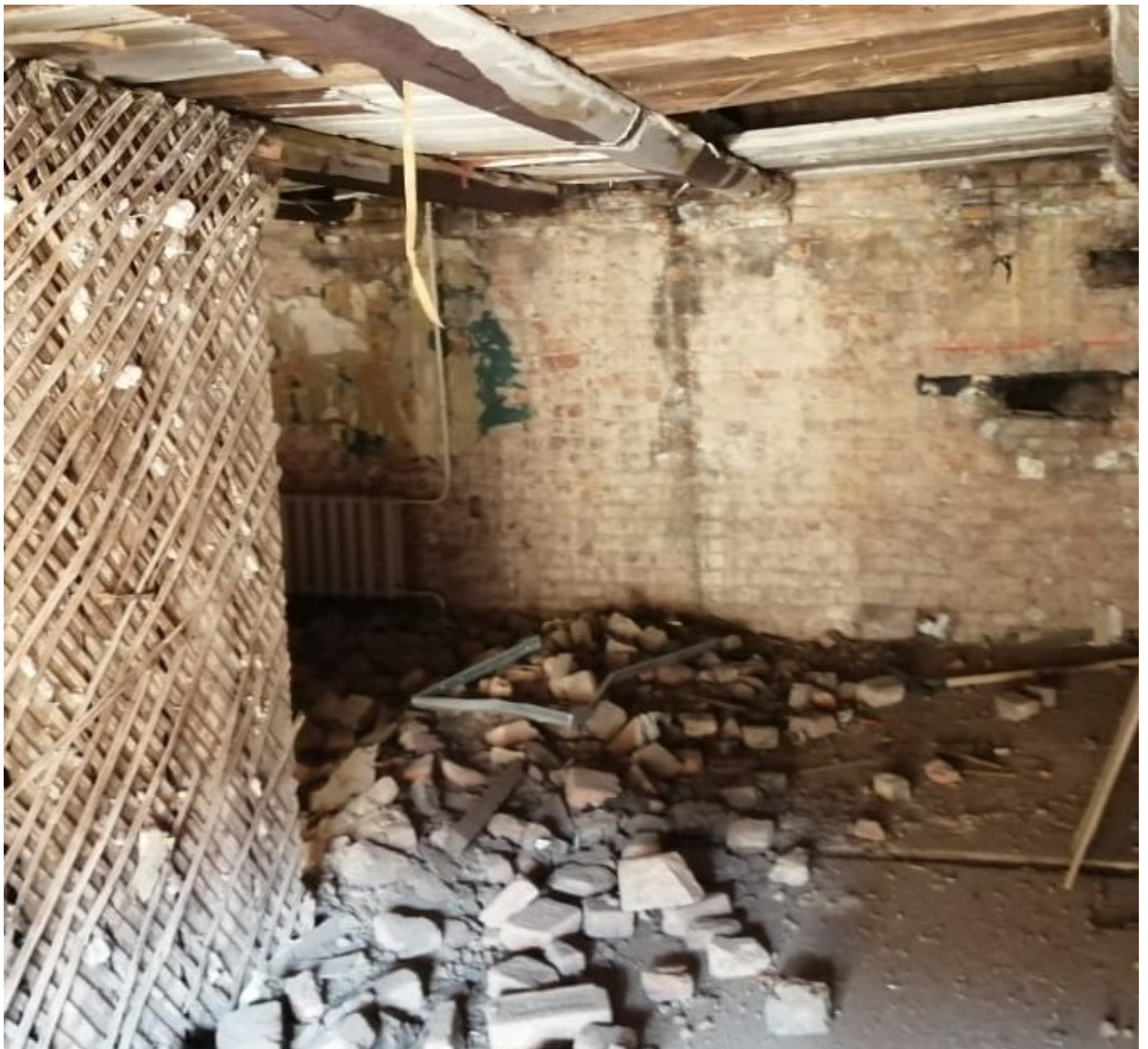
16. Объект культурного наследия регионального значения «Дом К.Я. Маевского» г. Санкт-Петербург, наб. реки Фонтанки, д. 110, лит. А. квартира 18. Помещения 5 этажа. Вид на север.
