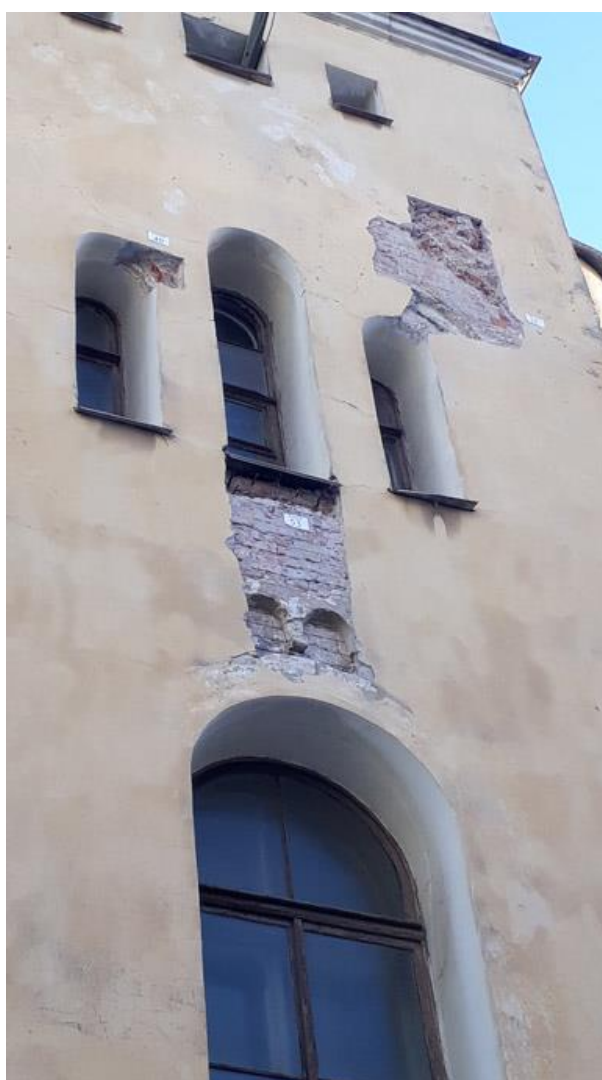
Фото 16. Объект культурного наследия регионального значения «Подворье Старо-Афонского Свято-Андреевского мужского скита» по адресу: Санкт-Петербург, 5-я Советская ул., д. 31-33, лит. А — церковь Благовещения Пресвятой Богородицы. Вид со стороны двора на фрагмент западного фасада здания — объем колокольни. Над окном обнаружен заштукатуренный аркатурный пояс, над окнами второго этажа видны следы стесанных декоративных элементов.
