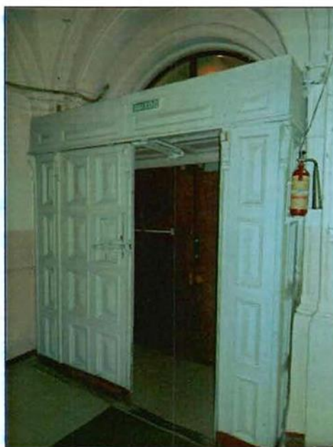
5. Деревянный тамбур. Общий вид.
