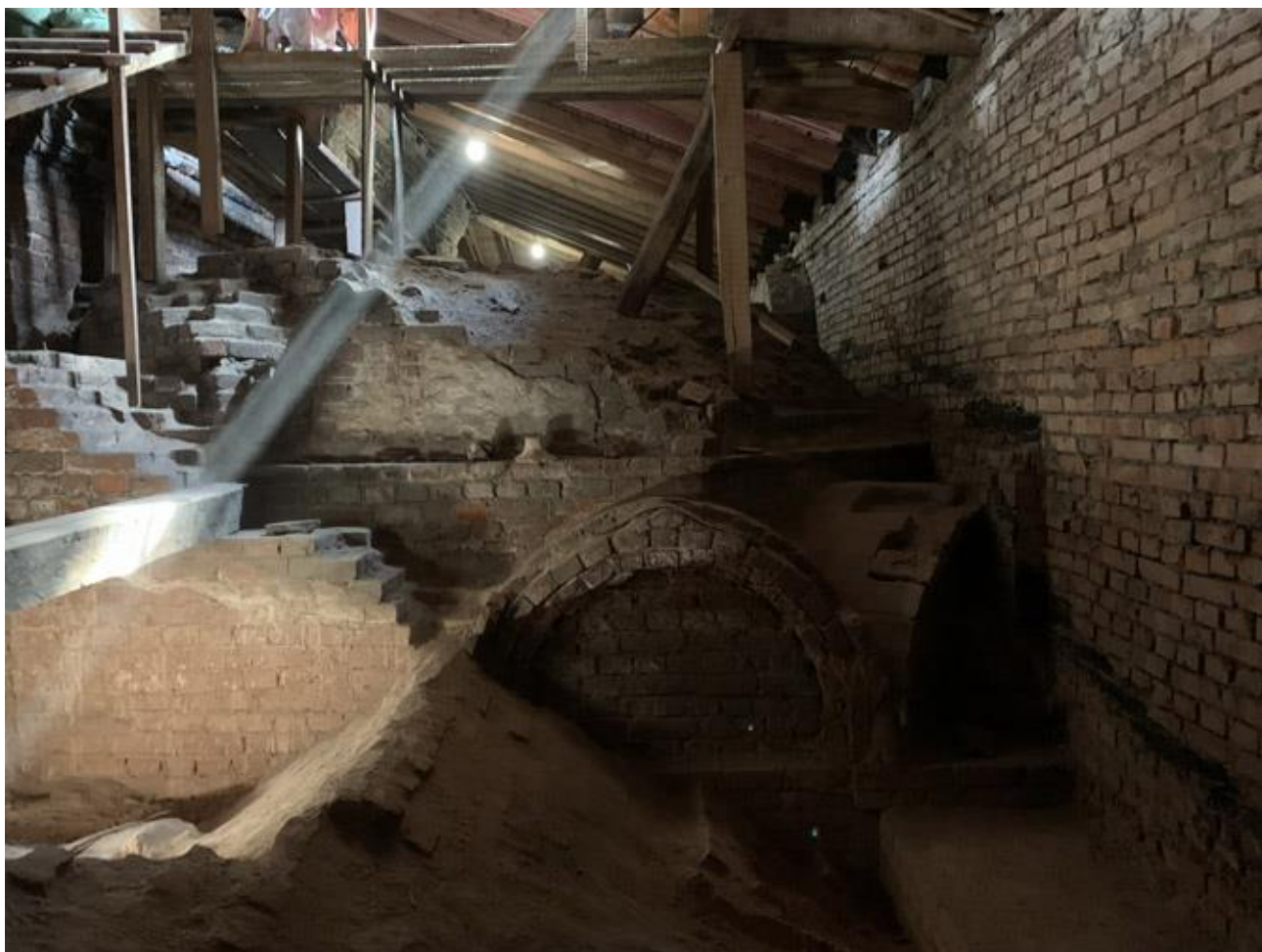
Фото 28. Объект культурного наследия регионального значения «Подворье Старо-Афонского Свято-Андреевского мужского скита» по адресу: Санкт-Петербург, 5-я Советская ул., д. 31-33, лит. А — церковь Благовещения Пресвятой Богородицы. Пространство чердака (надстроенный третий этаж). Вид со стороны юго-западного среднего барабана на центральный восьмерик и закомары. Кирпичная стена возведена в 1960-е гг.
