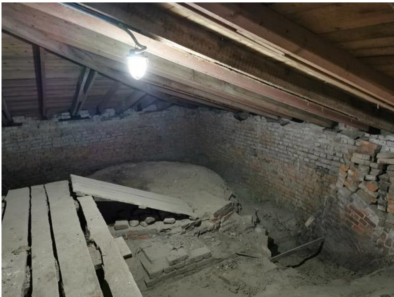
Фото 27. Объект культурного наследия регионального значения «Подворье Старо-Афонского Свято-Андреевского мужского скита» по адресу: Санкт-Петербург, 5-я Советская ул., д. 31-33, лит. А — церковь Благовещения Пресвятой Богородицы. Пространство чердака (надстроенный третий этаж). Вид на основание северо-восточного среднего барабана. Кирпичная стена возведена в 1960-е гг.
