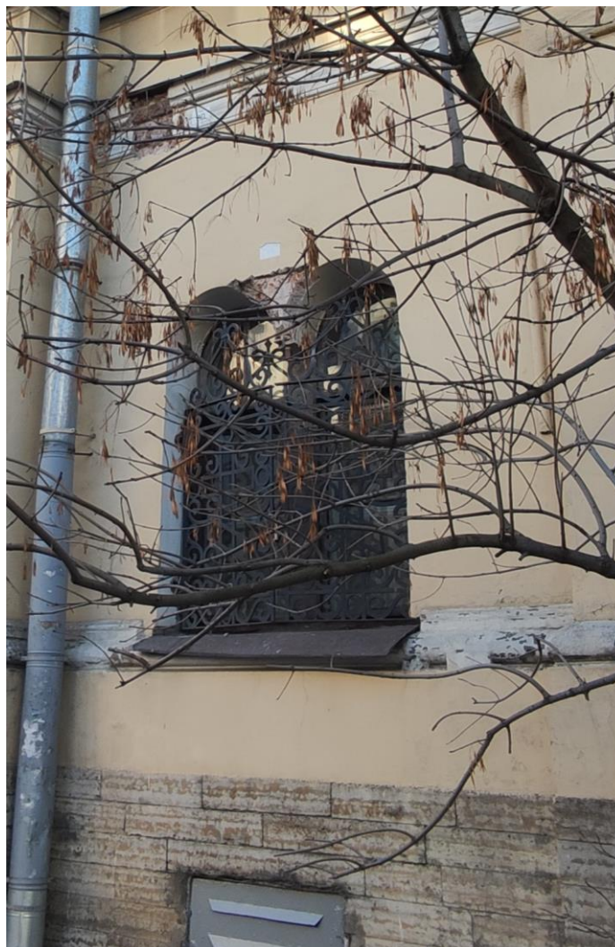
Фото 10. Объект культурного наследия регионального значения «Подворье Старо-Афонского Свято-Андреевского мужского скита» по адресу: Санкт-Петербург, 5-я Советская ул., д. 31-33, лит. А — церковь Благовещения Пресвятой Богородицы. Вход с 5-й Советской улицы. Парное окно первого этажа с ковanej металлической решеткой.
