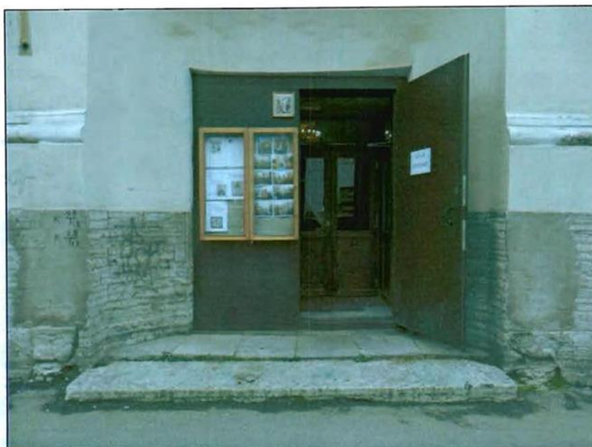
4. Северный фасад. Крыльцо.
