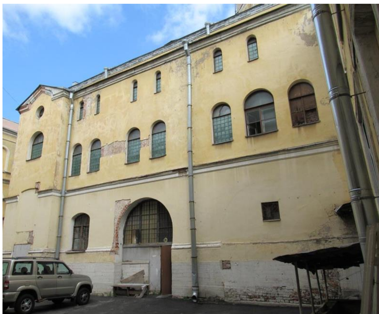
Фото 14. Объект культурного наследия регионального значения «Подворье Старо-Афонского Свято-Андреевского мужского скита» по адресу: Санкт-Петербург, 5-я Советская ул., д. 31-33, лит. А — церковь Благовещения Пресвятой Богородицы. Вид со стороны двора на южный фасад здания. На первом этаже находилась открытая галерея для выхода на Дегтярную улицу (в настоящее время вторая арка заложена).
