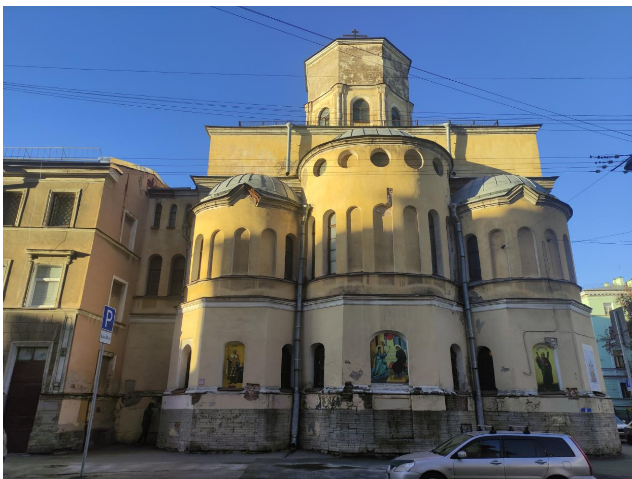
Фото 3. Объект культурного наследия регионального значения «Подворье Старо-Афонского Свято-Андреевского мужского скита» по адресу: Санкт-Петербург, 5-я Советская ул., д. 31-33, лит. А — церковь Благовещения Пресвятой Богородицы. Между зданием церкви и флигелем для монахов имеется переходная галерея с оконными проемами в уровне второго и третьего этажей. Проемы с полуциркульными завершениями идентичными проемам на абсидах.
