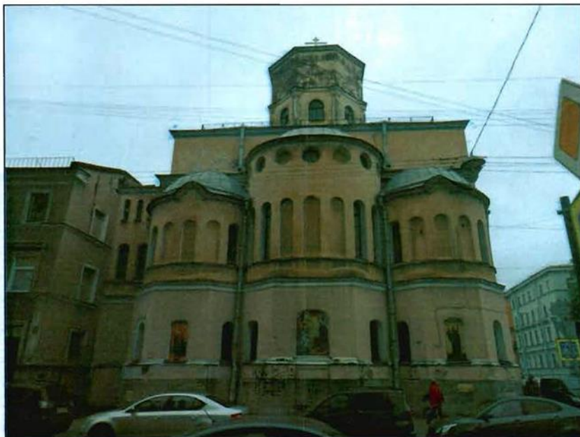
2. Восточный фасад. Общий вид.
