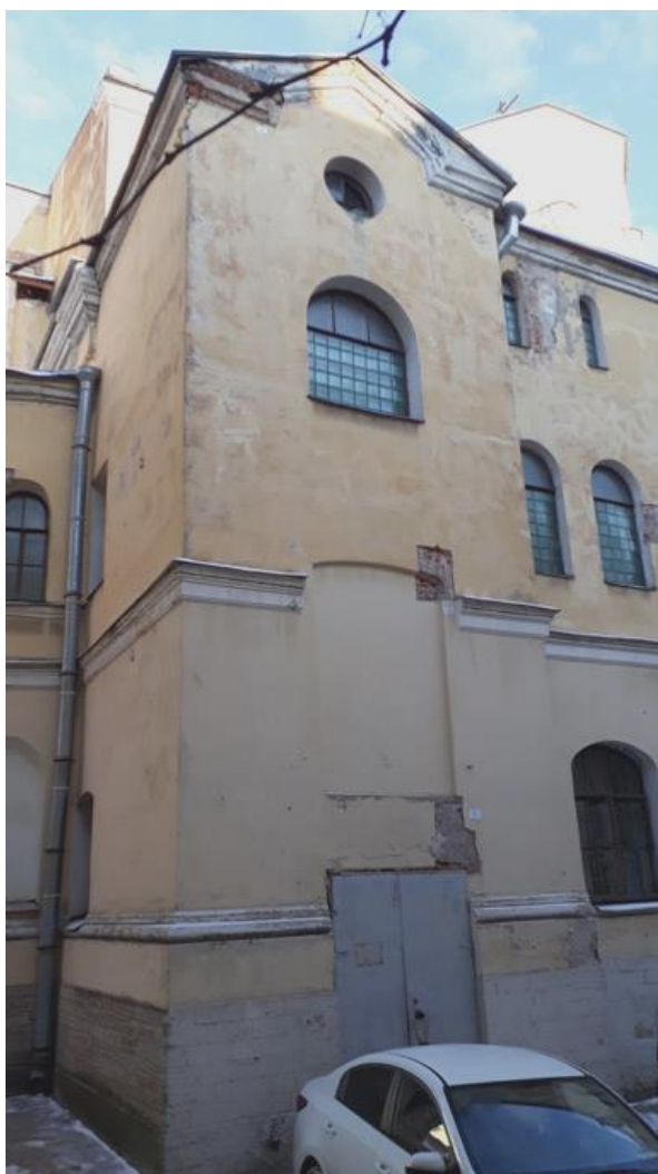
Фото 15. Объект культурного наследия регионального значения «Подворье Старо-Афонского Свято-Андреевского мужского скита» по адресу: Санкт-Петербург, 5-я Советская ул., д. 31-33, лит. А — церковь Благовещения Пресвятой Богородицы. Вид со стороны двора на фрагмент южного фасада здания. В выступающем ризалите расположена лестничная клетка. Сохранился исторический венчающий карниз и междуэтажная тяга. Видны следы заложенного оконного проема. Оконные заполнения заменены на современные.
