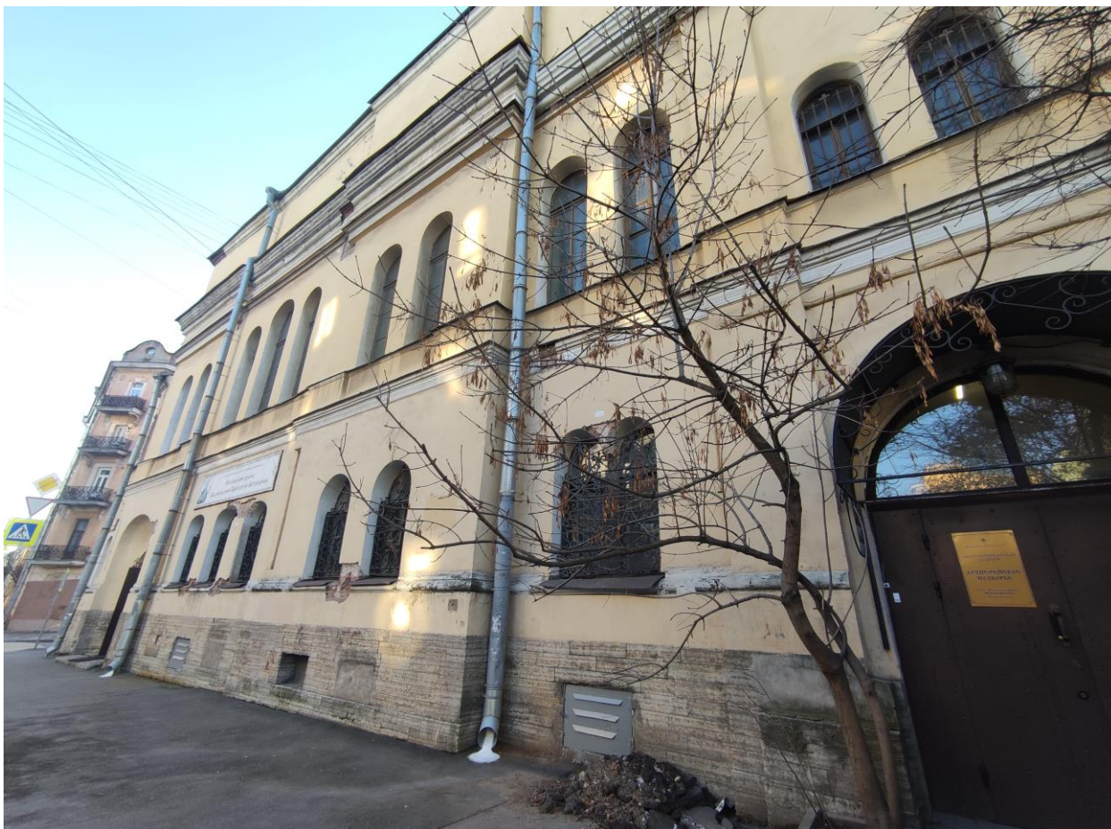
Фото 9. Объект культурного наследия регионального значения «Подворье Старо-Афонского Свято-Андреевского мужского скита» по адресу: Санкт-Петербург, 5-я Советская ул., д. 31-33, лит. А — церковь Благовещения Пресвятой Богородицы. Вход с 5-й Советской улицы. Цоколь выложен из известняка. Видны восемь рядов камня. В цоколе были выполнены оконные проемы прямоугольной формы по световым осям верхних этажей — большинство в настоящее время заложены.
