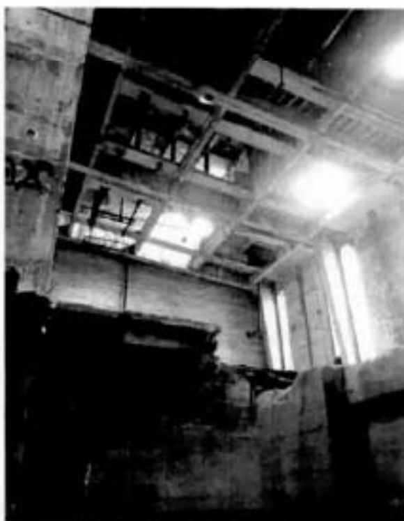
Фото 9. Бывш. котельный зал.
