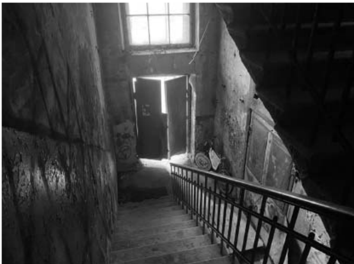
16. Вид на черную лестницу
