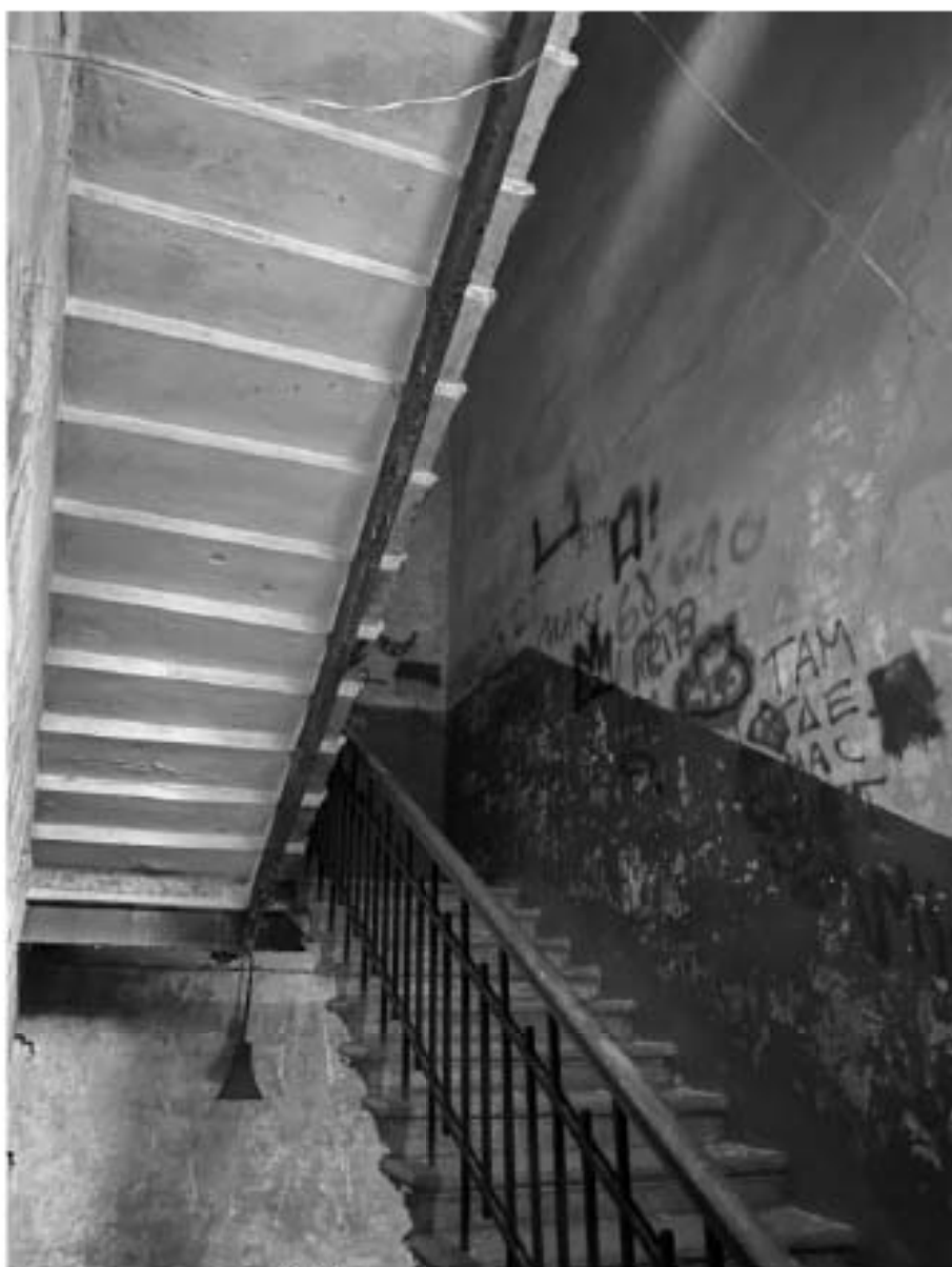
15. Вид на черную лестницу
