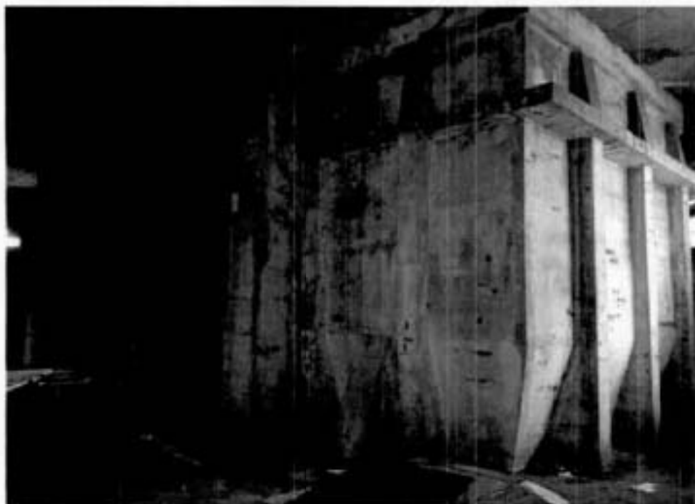
Фото 15. Железобетонный бак в быш. отделение водоподготовки.
