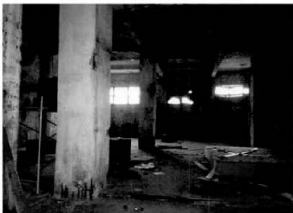
Фото 14. Бывш. отделение водоподготовки.
