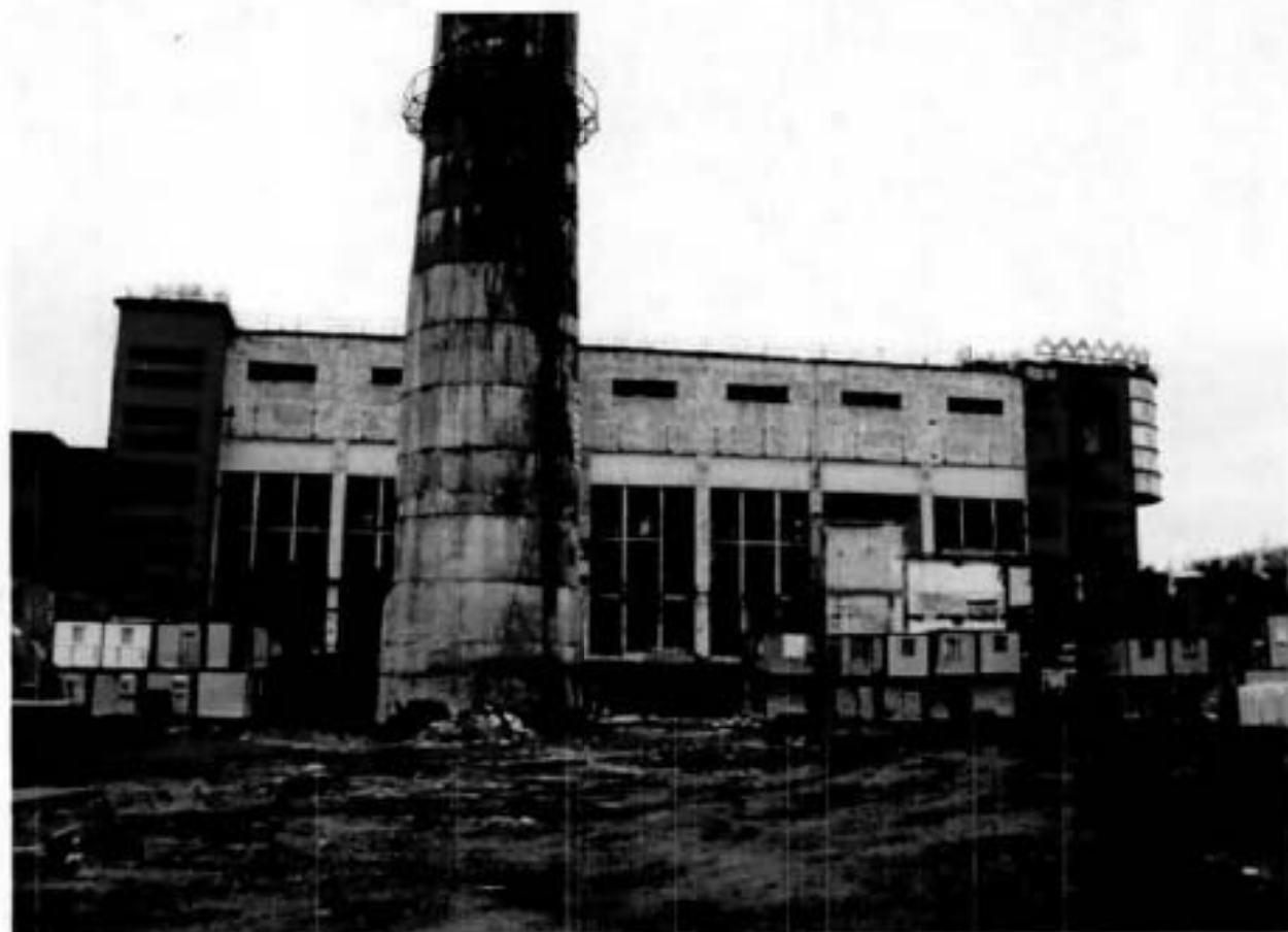
Фото 5. Фрагмент Северо-восточного фасада.
