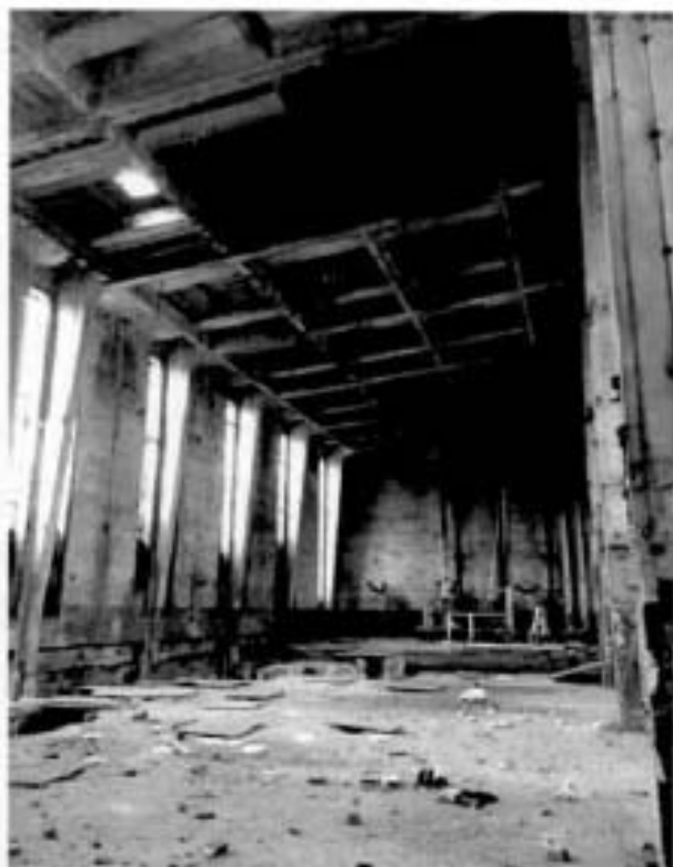
Фото 7. Бывш. котельный зал.
