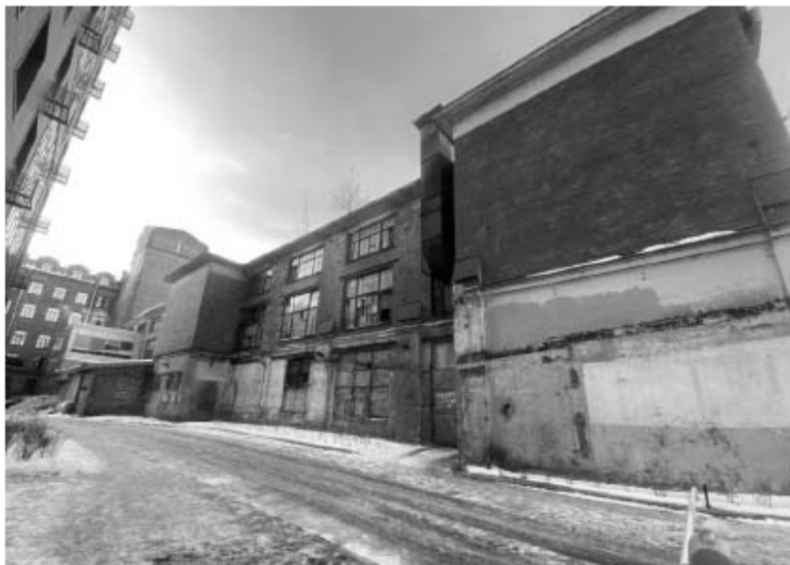
3. Вид на дворовые фасады с северо-восточной стороны
