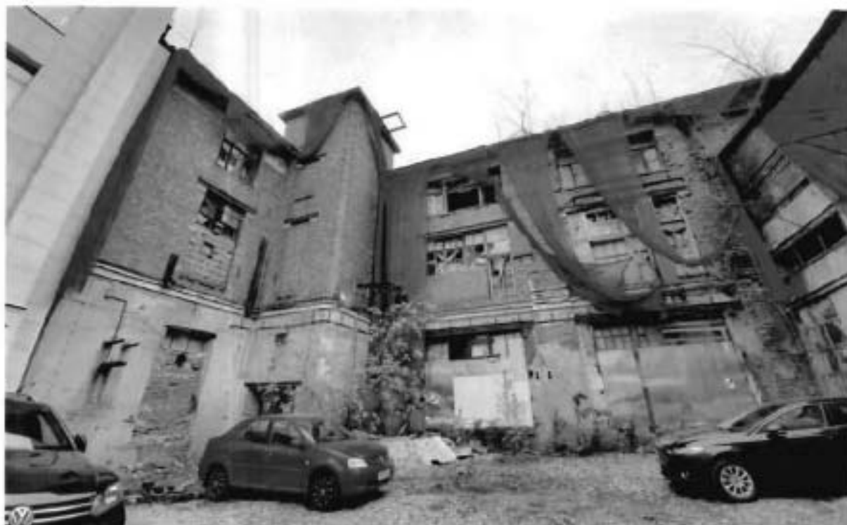
4. Вид на северо-западный фасад объекта культурного наследия
