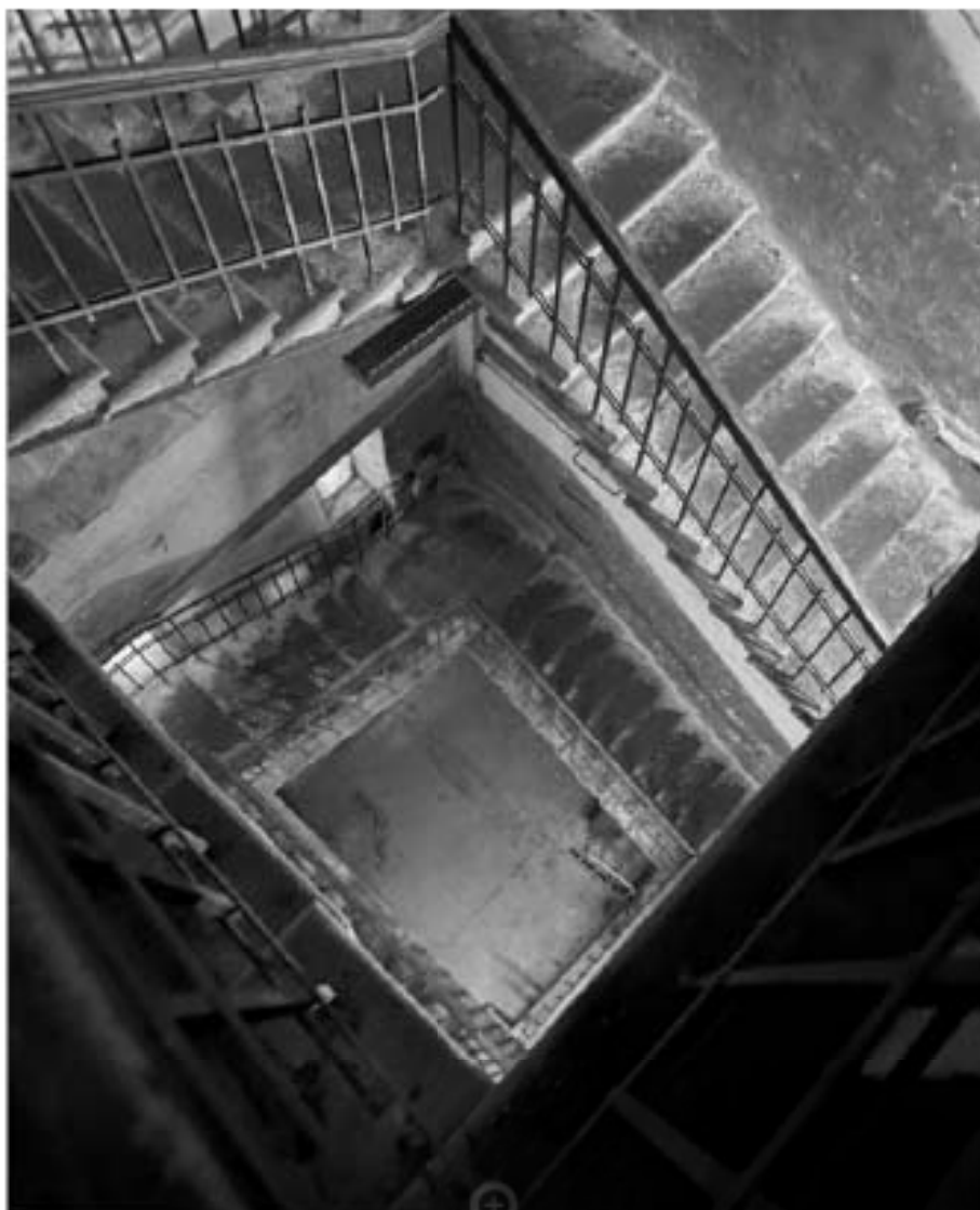
12. Вид на лестницу в южной части здания
