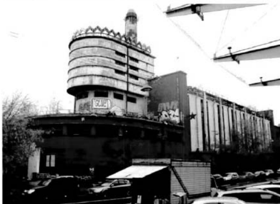
Фото 1. Полуциркульный северо-западный фасад и юго-западный фасад.
