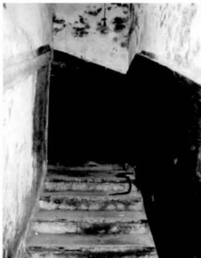
Фото 17. Лестница в северной части здания.
