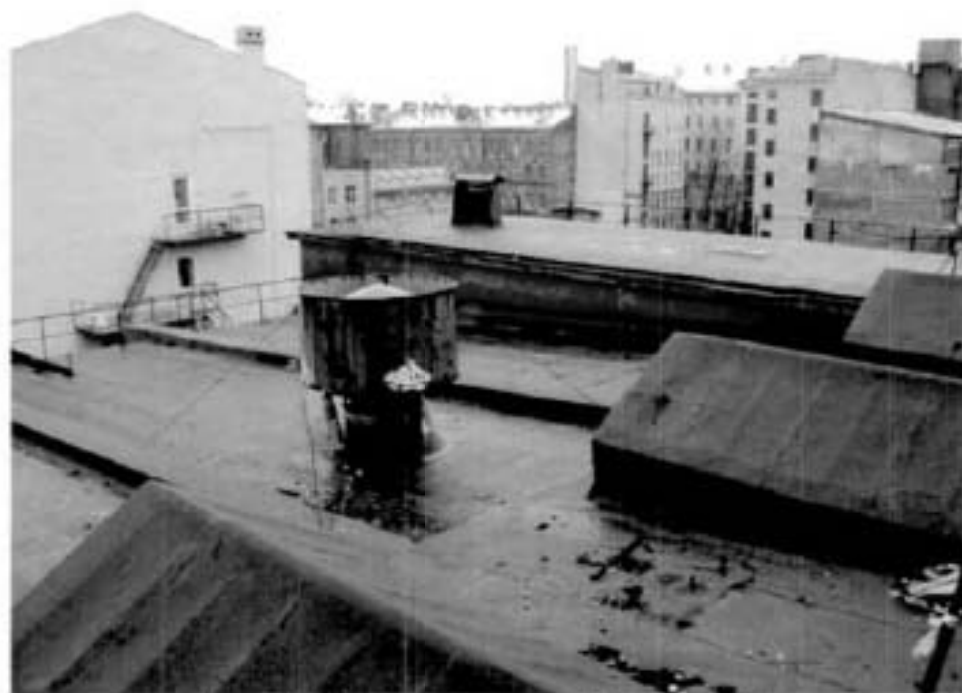
Фото 19. Кровля юго-восточной части здания.
