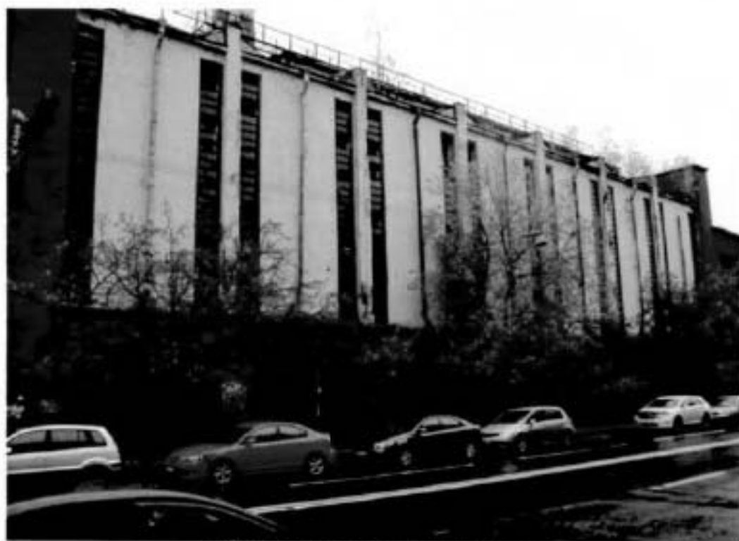
Фото 2. Фрагмент юго-западный фасад.
