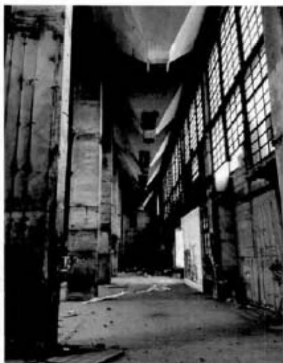
Фото 8. Бывш. котельный зал.
