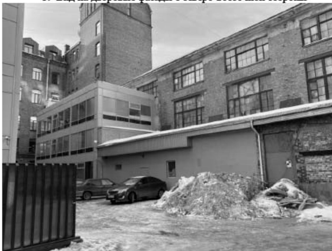
4. Вид на дворовые фасады с северо-восточной стороны
