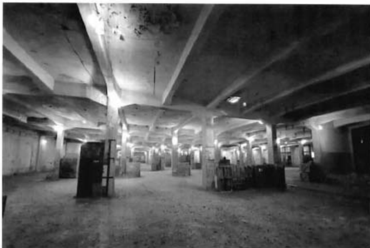
6. Интерьеры объекта культурного наследия, 2 этаж
