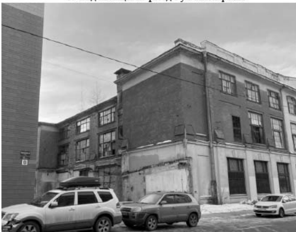
2. Вид на лицевой фасад с ул. Пионерская
