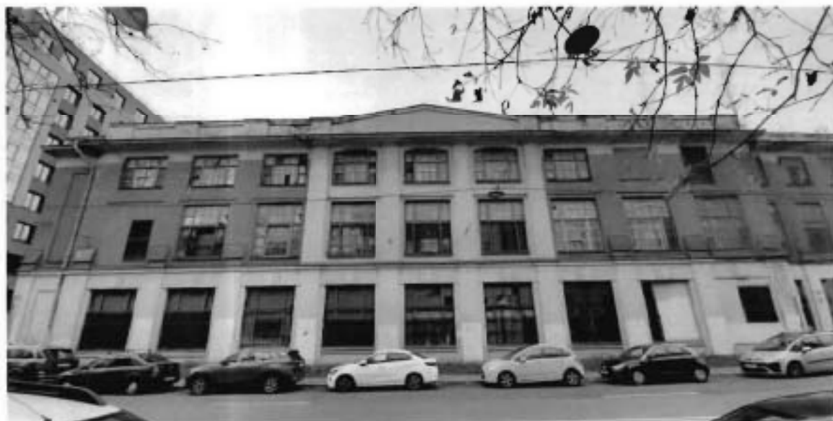
1. Вид на северо-восточный фасад объекта культурного наследия
