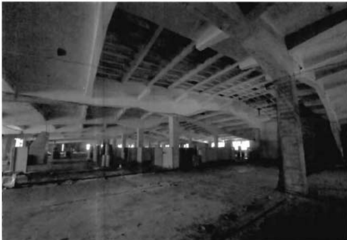
7. Интерьеры объекта культурного наследия, 3 этаж
