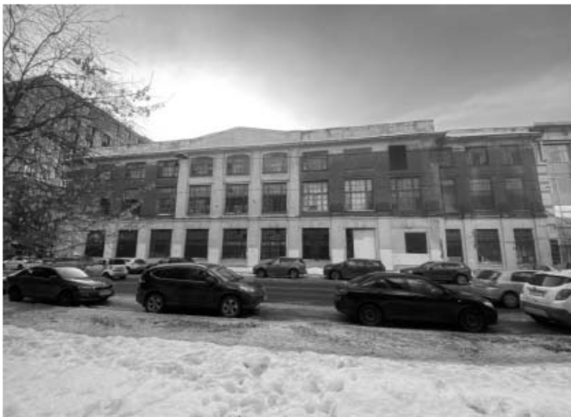
1. Вид на лицевой фасад с ул. Пионерская
