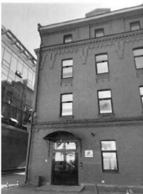
2. Северо-западный фасад. Главный вход.
