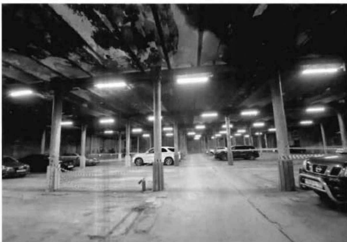
5. Интерьеры объекта культурного наследия, 1 этаж
