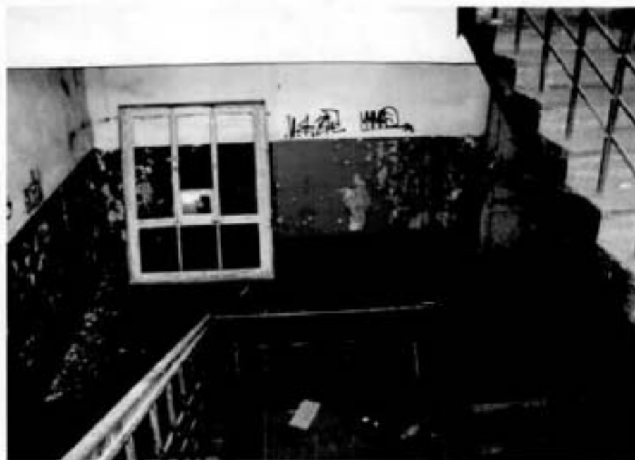
Фото 16. Центральная лестница в южной части здания.
