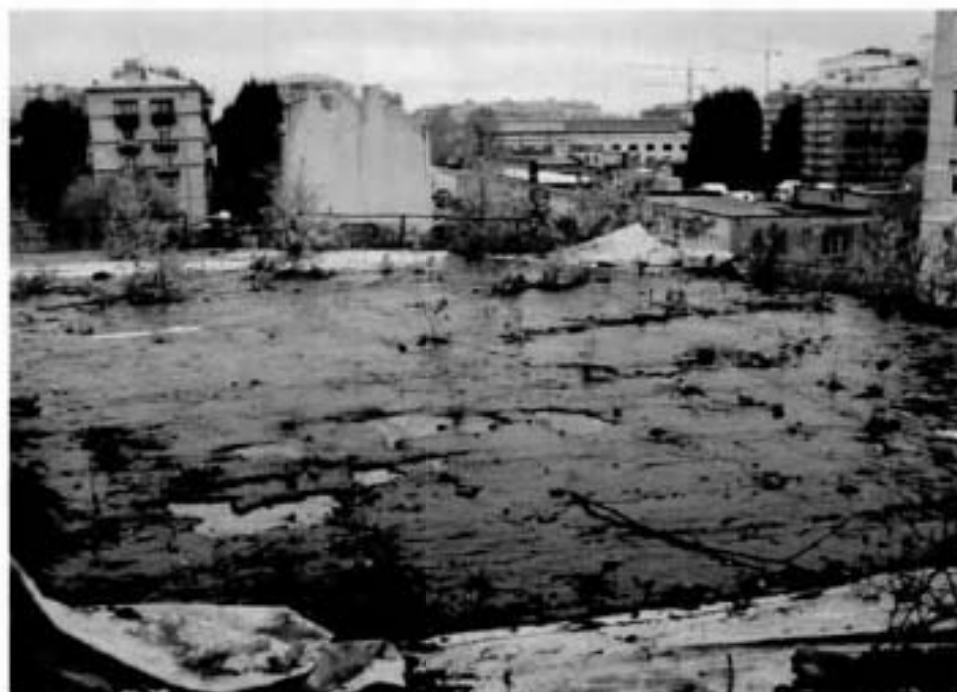
Фото 18. Кровля северо-западной части здания.
