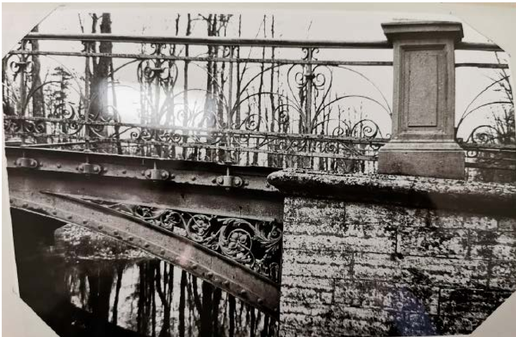
4. Фрагмент металлического моста на Крестовом канале. 1981 // Научный архив ГМЗ «Царское Село, дело №1516
