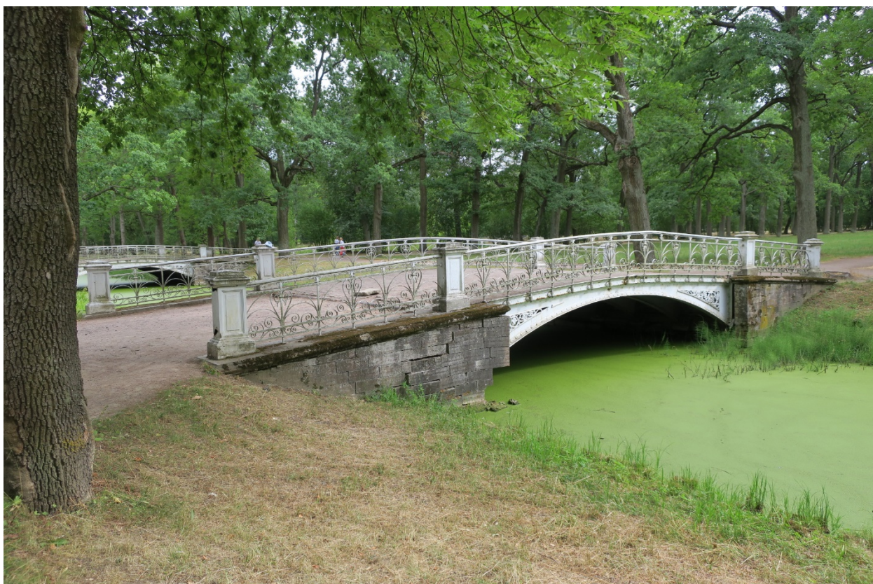
1. Низовой восточный фасад объекта культурного наследия федерального значения «Мост Металлический», расположенного по адресу: Санкт-Петербург, г. Пушкин, Александровский парк, литера ББ. Вид с юго-востока. 01.08.2021
