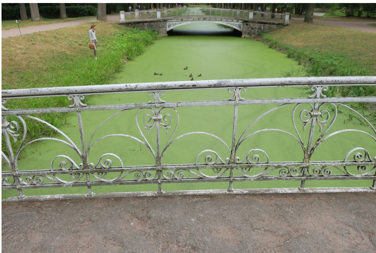
7. Перильное ограждение верхового фасада объекта культурного наследия федерального значения «Мост Металлический», расположенного по адресу: Санкт-Петербург, г. Пушкин, Александровский парк, литера ББ. 01.08.2021
