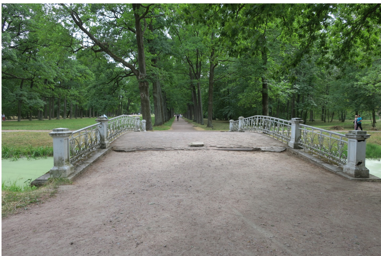
6. Проезжая часть объекта культурного наследия федерального значения «Мост Металлический», расположенного по адресу: Санкт-Петербург, г. Пушкин, Александровский парк, литера ББ. 01.08.2021
