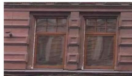
междуэтажный профилированный карниз, фриз с каннелированными метопами и брильянтовым рустом - между 2-м и 3-м этажами;
