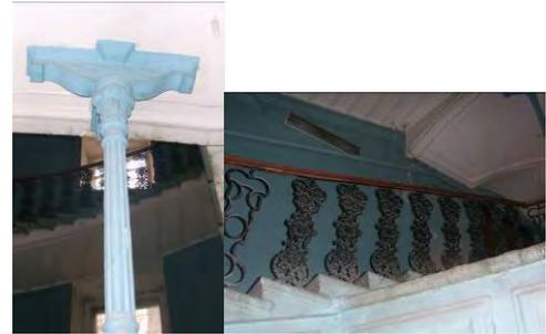
металлическое кованое ограждение - габариты, рисунок (вертикальные стойки со сквозным ажурным орнаментом);
