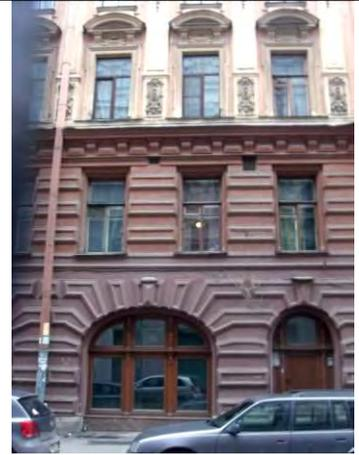
профилированные наличники, рустованное обрамление, замковые камни дверных и оконных проемов 1-го этажа;
