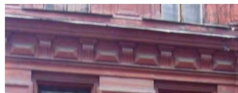
профилированные наличники оконных проемов 3-го этажа; каннелированные пилястры с капителями дорического ордера и картушами - в простенках между оконных проемов; орнаментированный фриз над оконными перемычками 3-го этажа;
