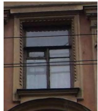
профилированные наличники оконных проемов 5-го этажа; пилястры с капителями ионического ордера, с декором из брильянтового руста, пальметт и растительных гирлянд; профилированные филенки в подоконном пространстве с орнаментом из розеток и брильянтового руста;
