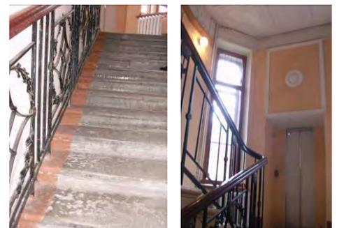
парадная лестница (по 7-й оси восточного лицевого фасада по просп. Бакунина) - местоположение, габариты, конфигурация (маршевая с поворотом), материал (каменная), ступени из лещадной плиты;
