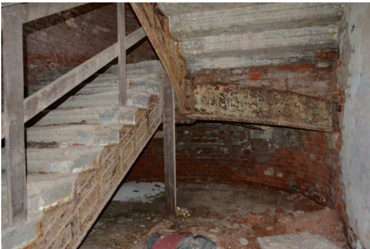
Фото 11. Первый этаж. Западная лестница в горжевой части.
