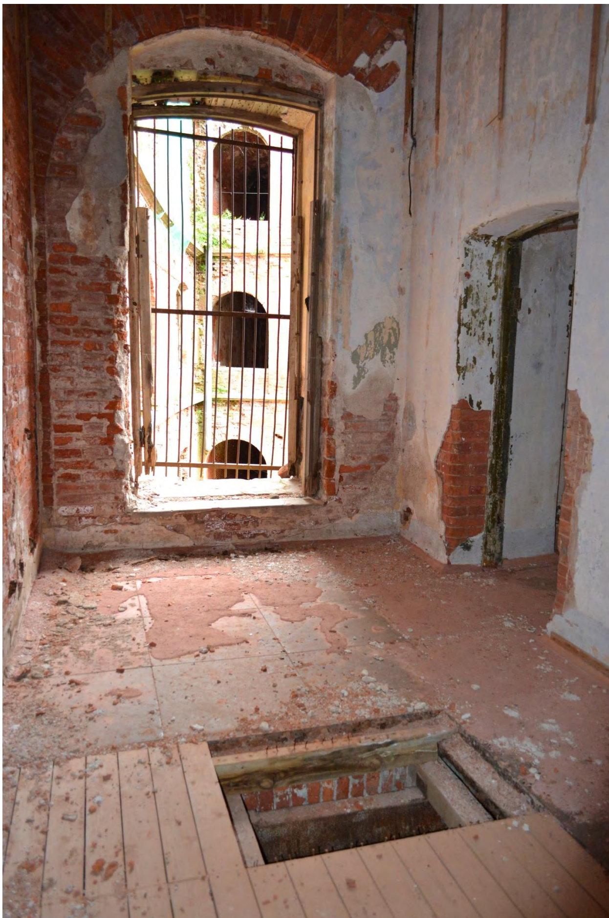
Фото 14. Помещение второго этажа.
