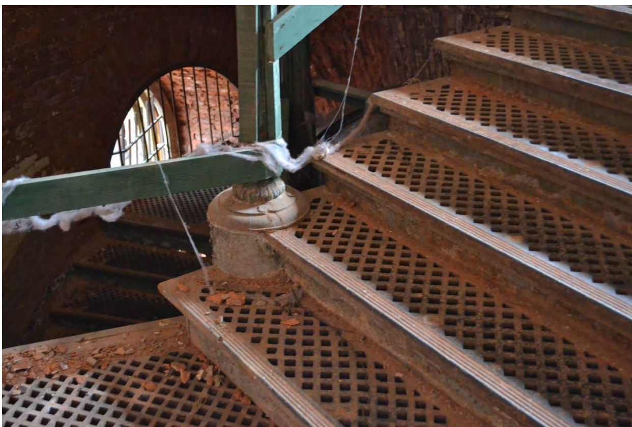
Фото 7. Лестничная площадка в уровне кровли. Общий вид на профиль ступеней.
