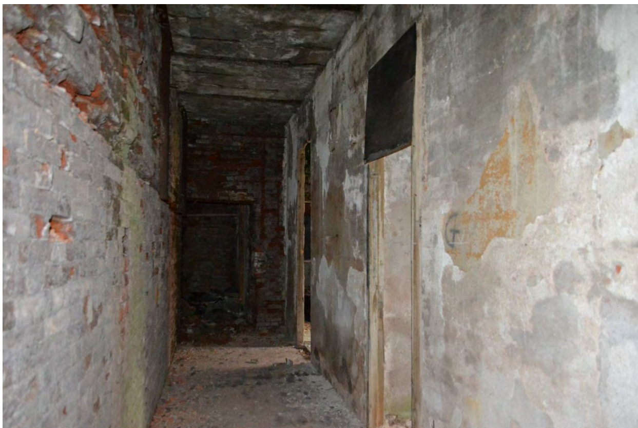
Фото 14. Третий этаж. Помещения горжевой части.
