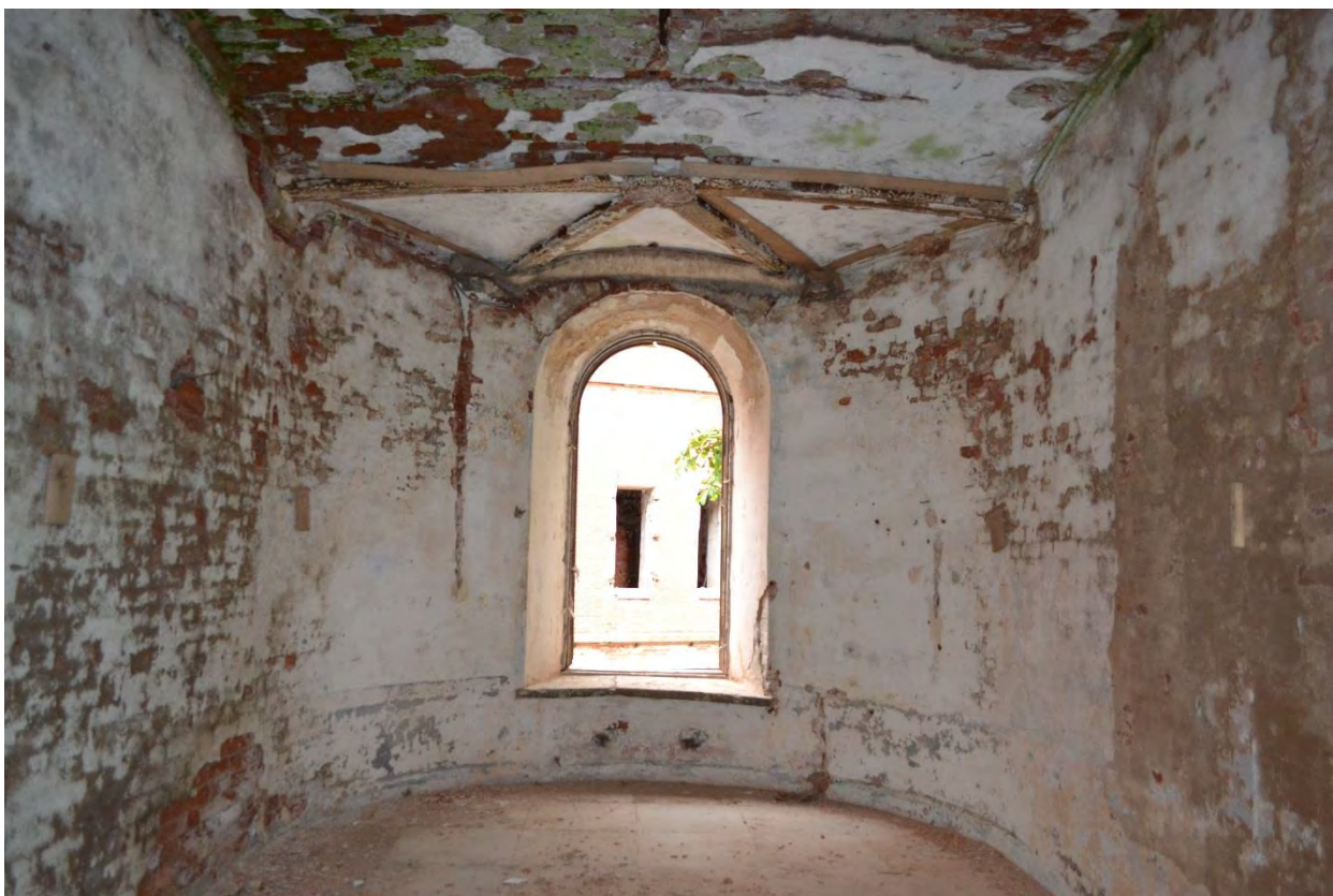
Фото 6. Второй этаж. Помещение горжевой части.
