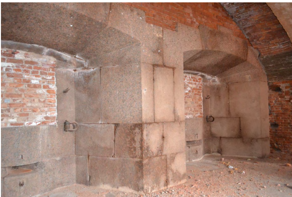
Фото 7. Казематы. Помещения третьего этажа. Вид на заложенные амбразуры.
