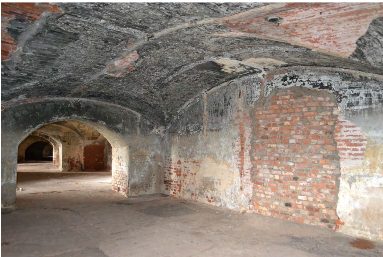
Фото 3. Первый этаж. Помещение казематов. Заложенный проем.
