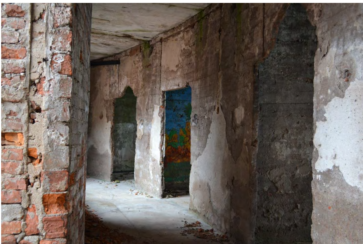
Фото 3. Казематы. Помещения третьего этажа.
