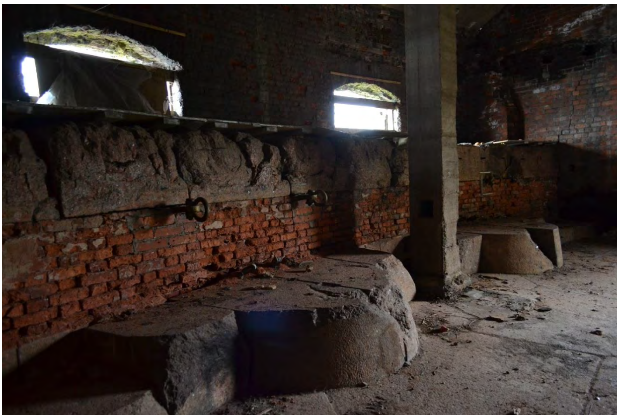
Фото 12. Казематы. Помещения третьего этажа.
