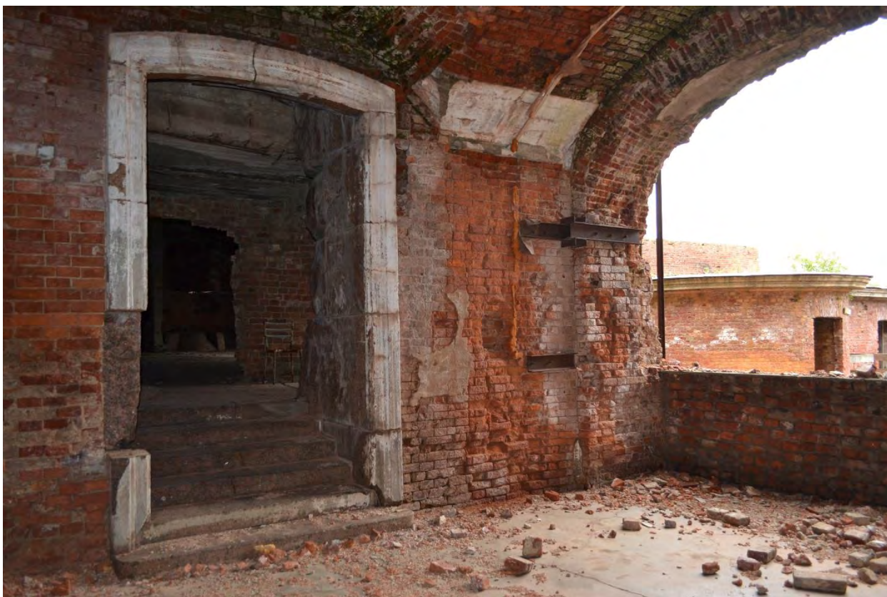
Фото 9. Казематы. Помещения третьего этажа.
