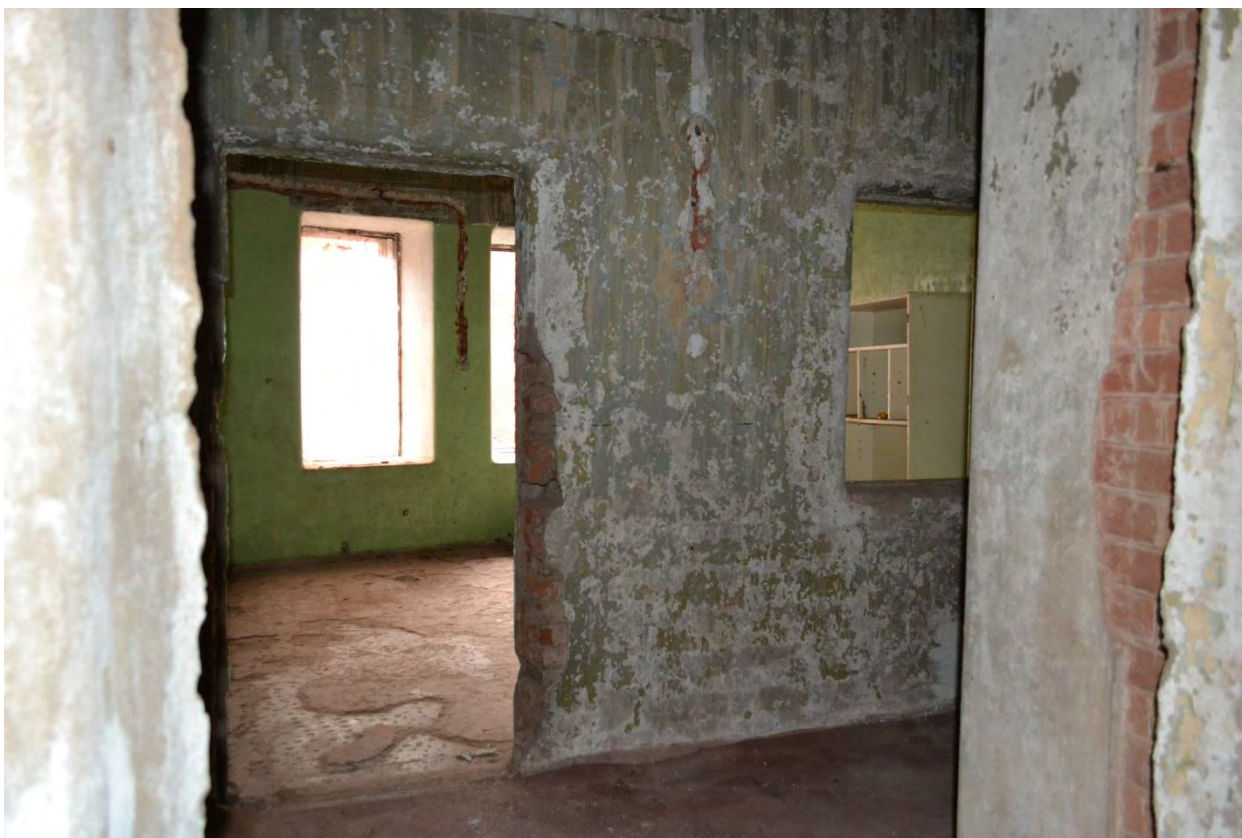
Фото 9. Помещение второго этажа.
