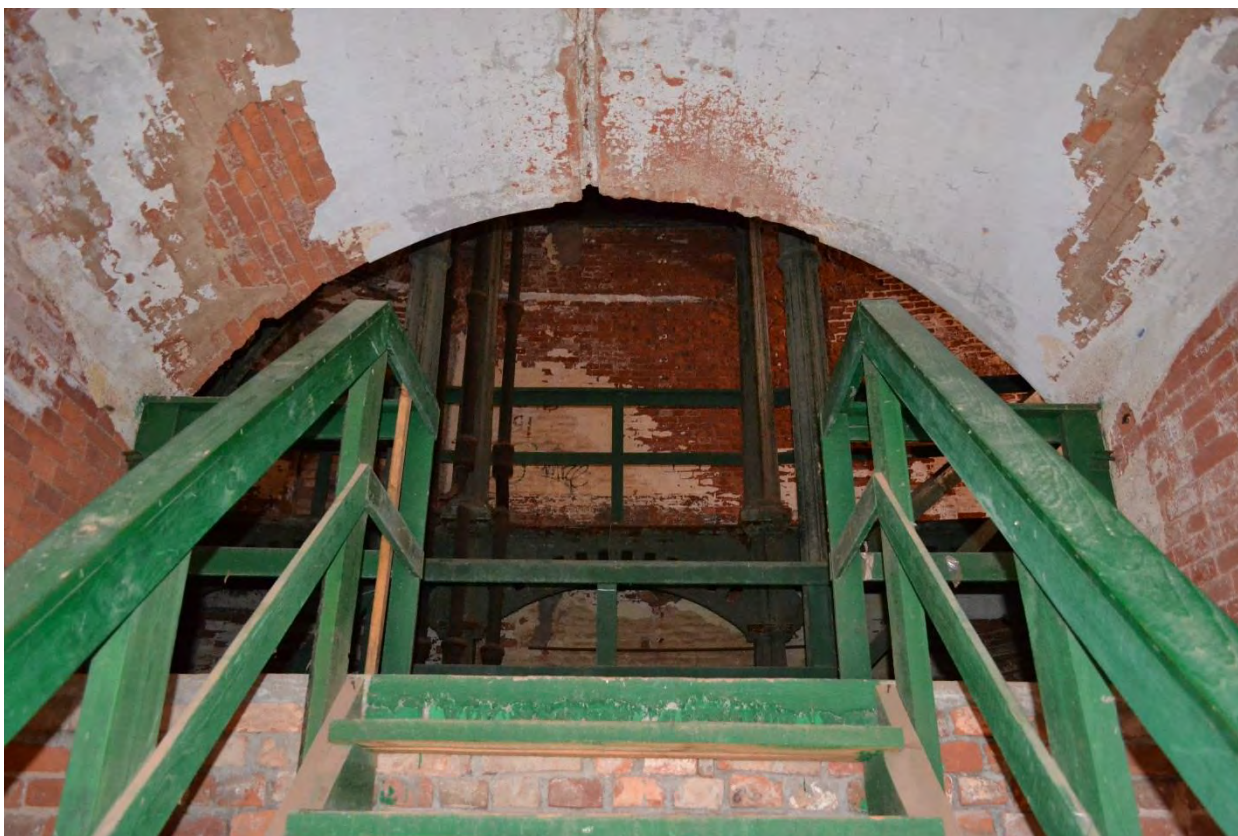
Фото 1. Вход в лестничную клетку западного объема.
