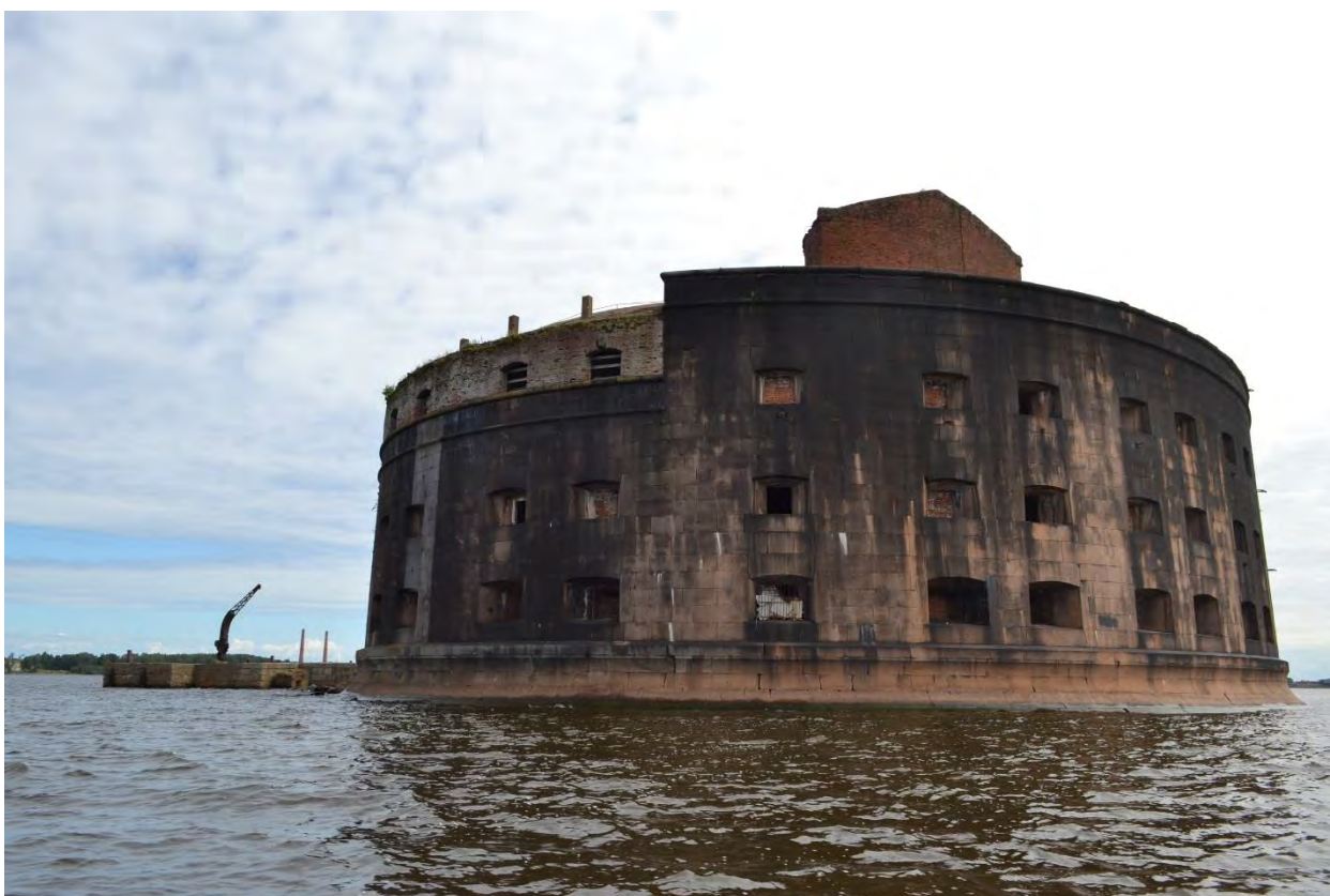
Фото 4. Форт Александр I. Западный фасад. Вид с запада.
