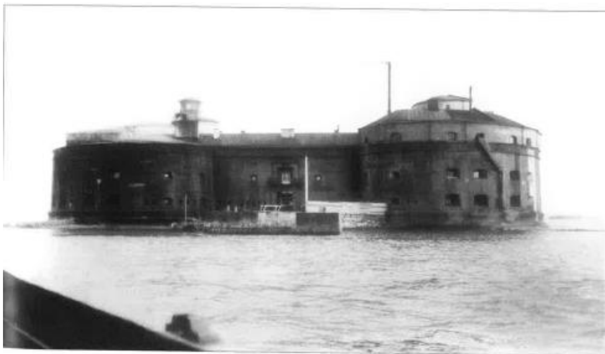
Илл. 32 Форт «Александр I». Вид с острова Котлин. Начало XX в. // Л.И. Амирханов, Ю.П. Голиков, В.В. Чирков, Ю.Е. Иванова. Форт «Император Александр I» – СПб.: «Издательский центр «ОСТРОВ», 2008.
