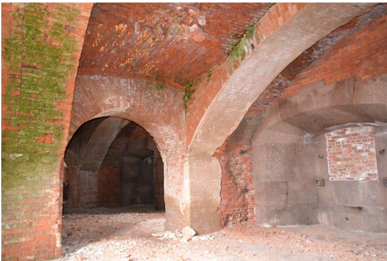
Фото 8. Казематы. Помещения третьего этажа. Общий вид.
