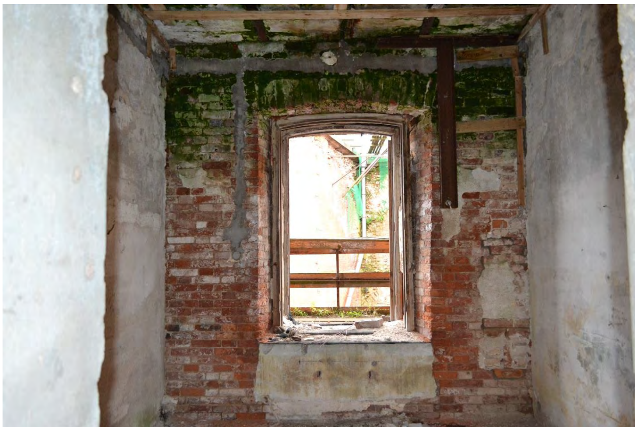
Фото 16. Третий этаж. Помещения горжевой части.
