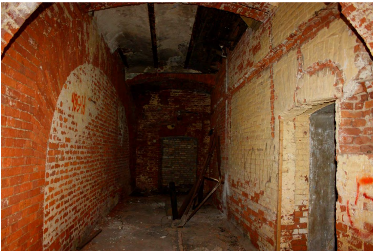
Фото 15. Первый этаж. Помещения порохоохранилища.
