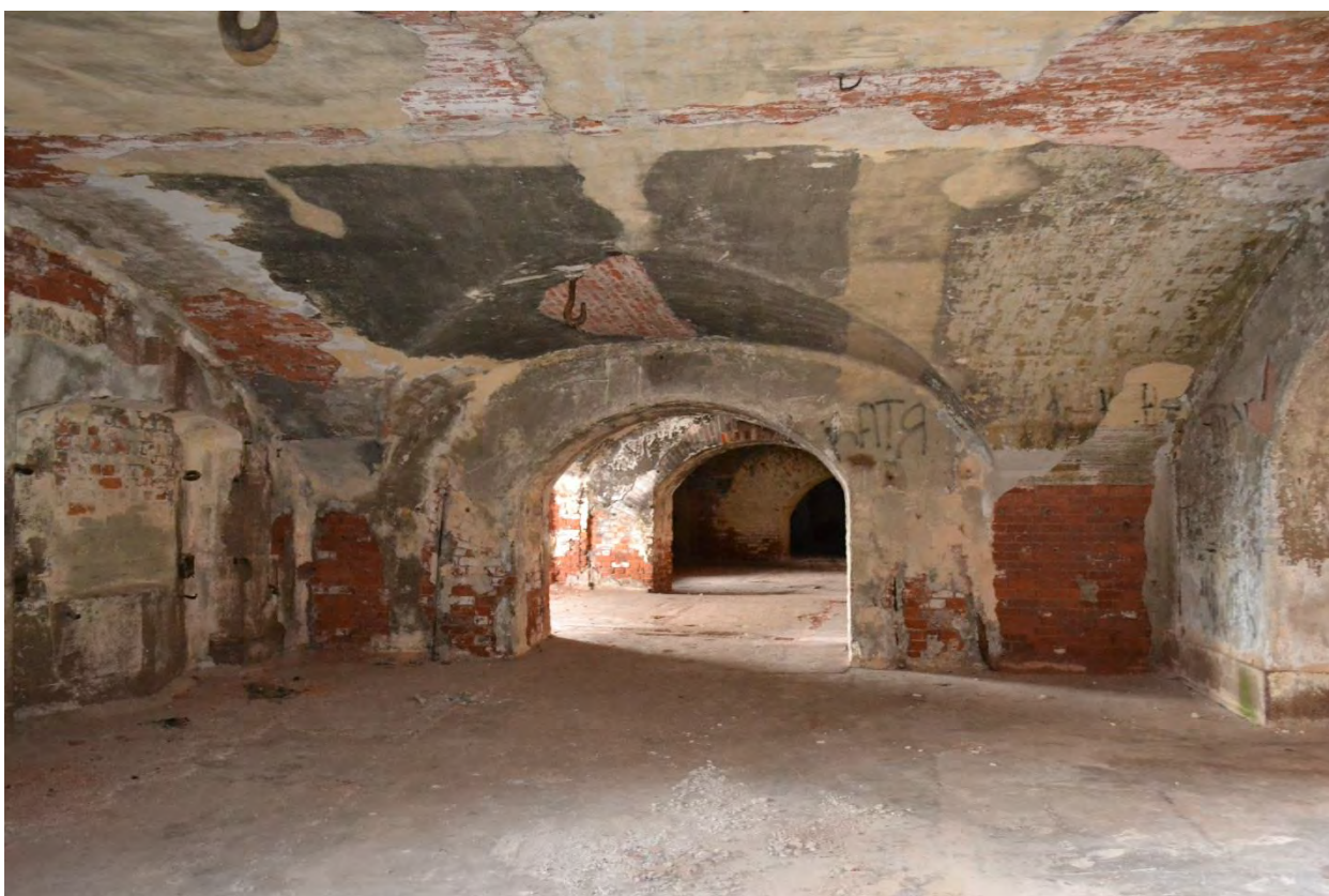
Фото 2. Первый этаж. Помещение казематов.
