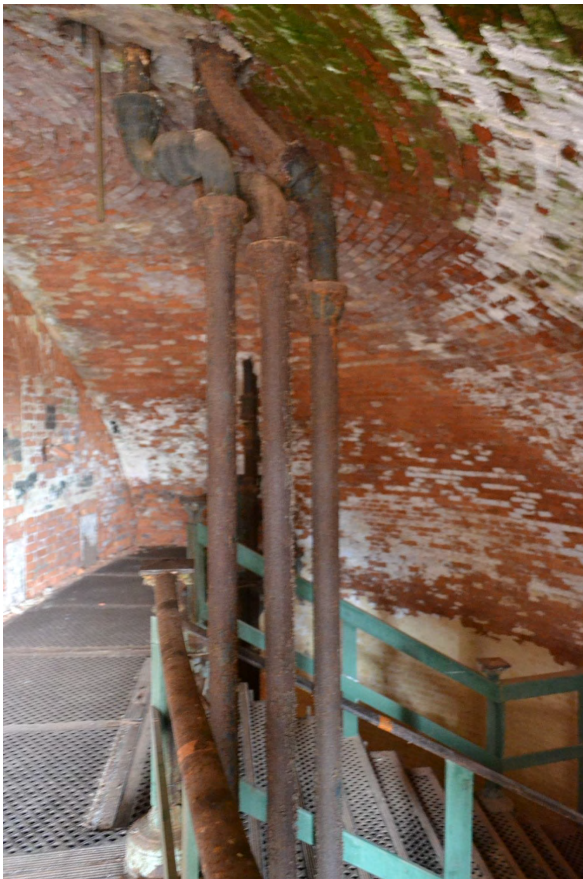
Фото 3. Лестничная клетка западного объема. Общий вид площадки в уровне кровли.
