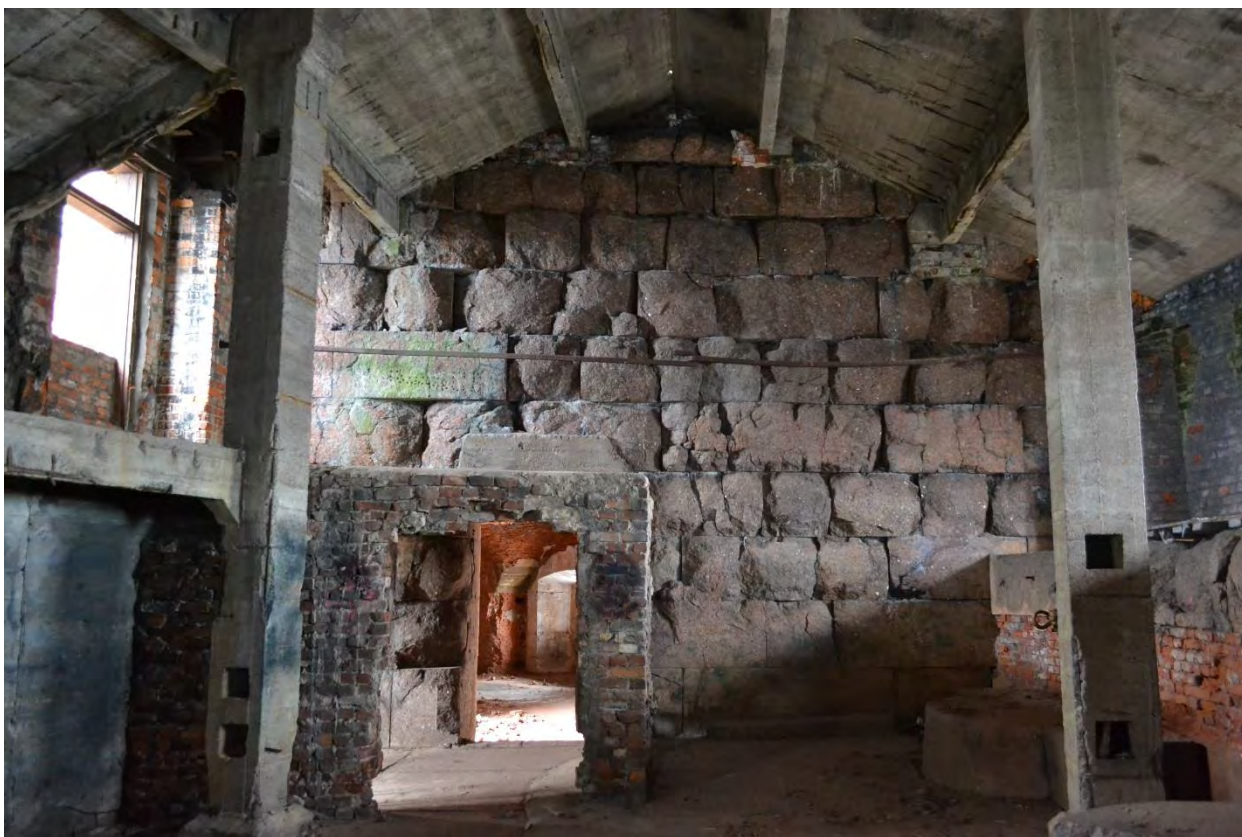
Фото 11. Казематы. Помещения третьего этажа.
