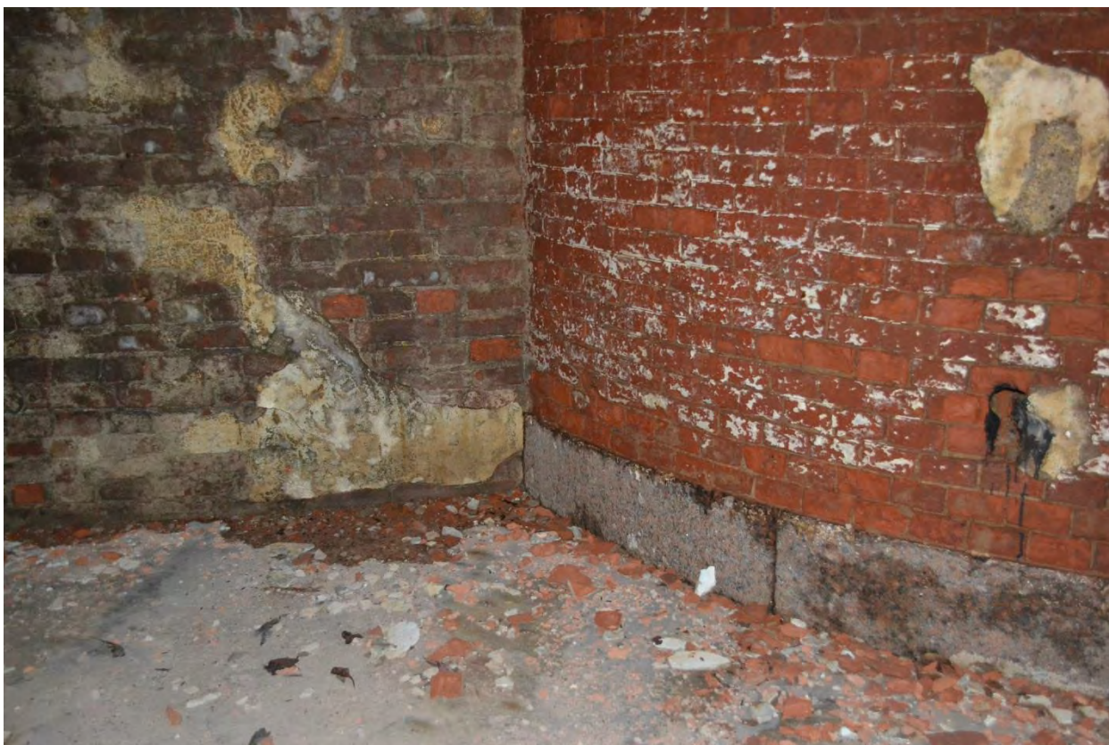
Фото 9. Первый этаж. Бывшая часть внутреннего двора. Сохранившийся гранитный цоколь.
