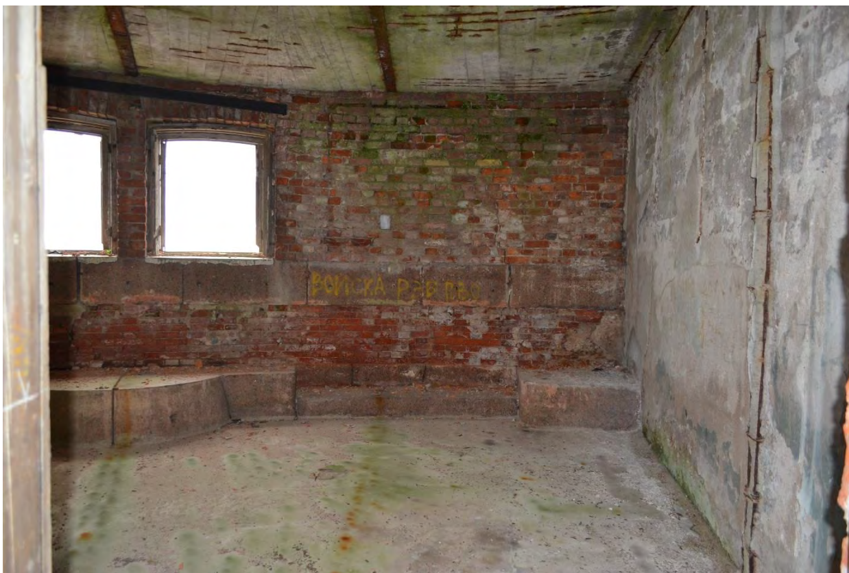
Фото 6. Казематы. Помещения третьего этажа.
