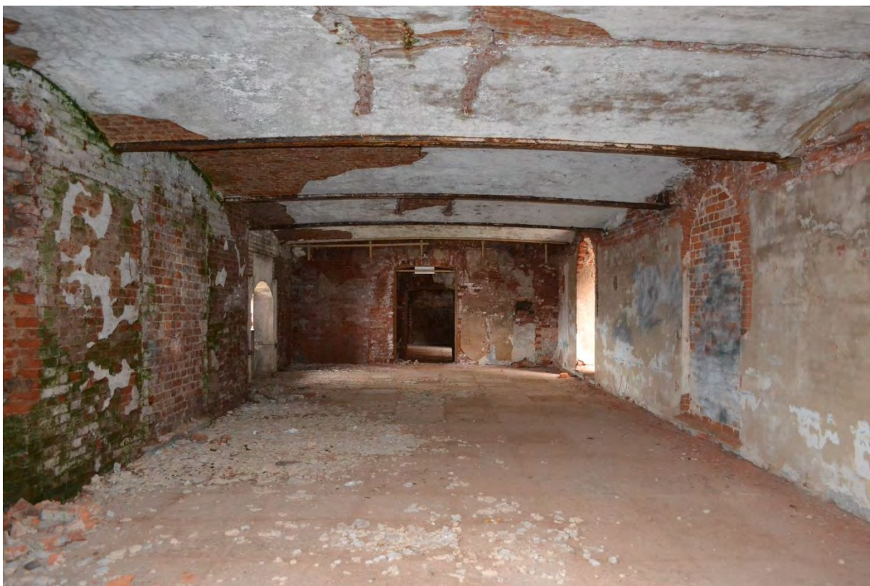
Фото 5. Второй этаж. Помещение горжевой части.
