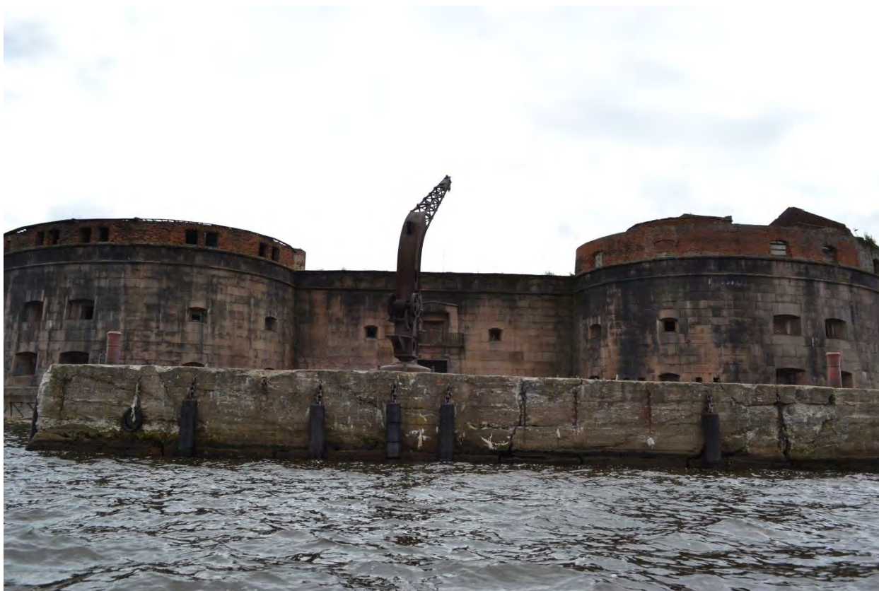
Фото 5. Форт Александр I. Северный фасад. Вид с севера.
