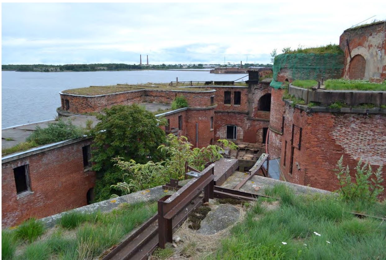
Фото 3. Общий вид кровли.
