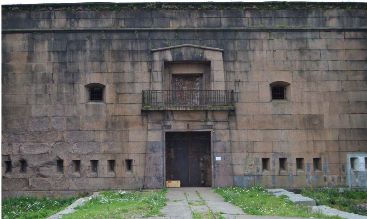
Фото 7. Форт Александр I. Центральная часть северного фасада (лицевого). Входная группа. Вид с севера.
