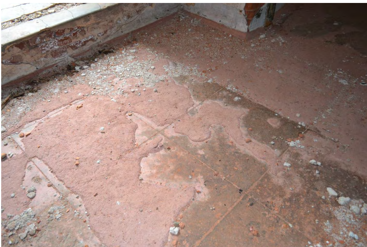
Фото 13. Второй этаж. Вид на напольное покрытие.
