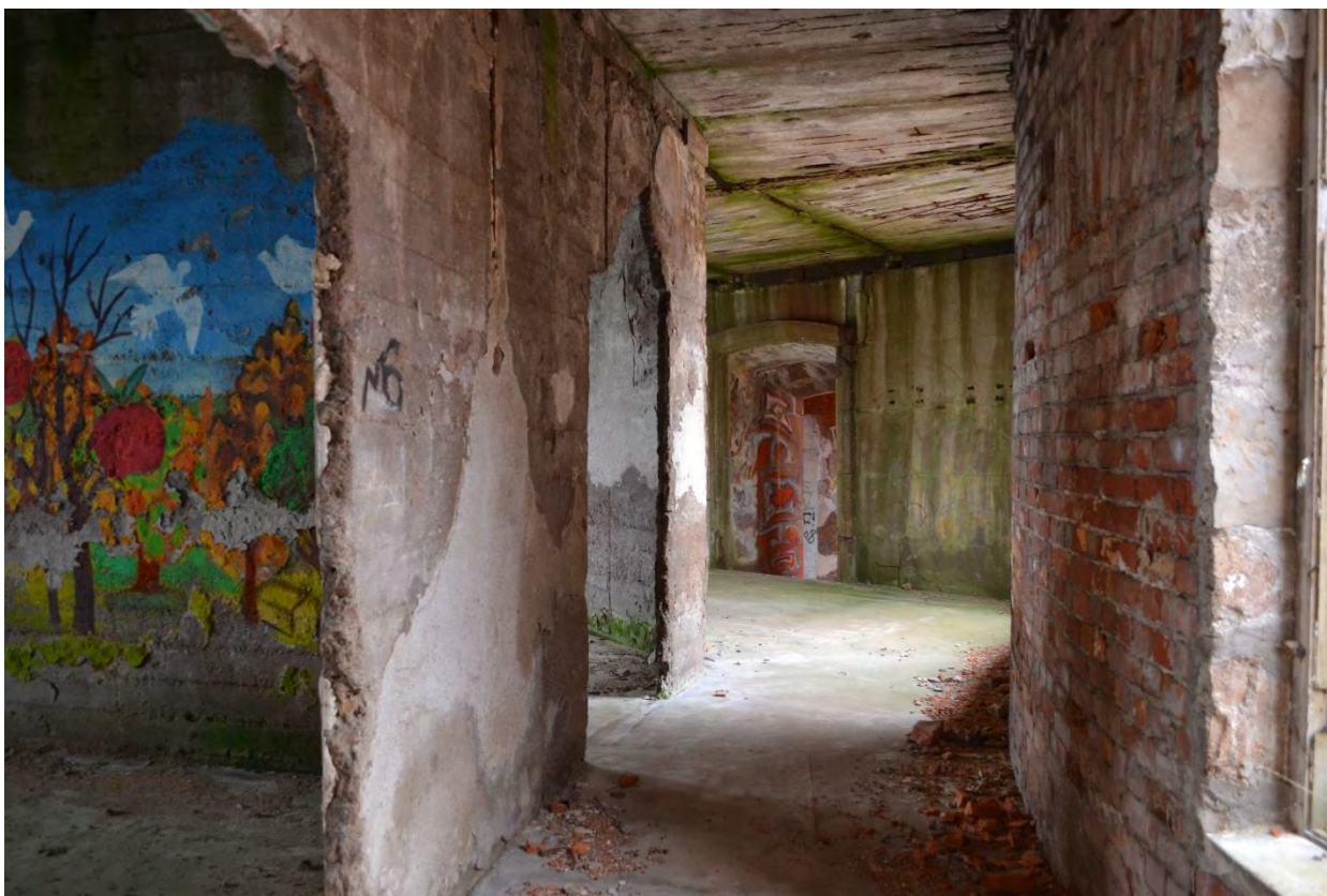
Фото 4. Казематы. Помещения третьего этажа.
