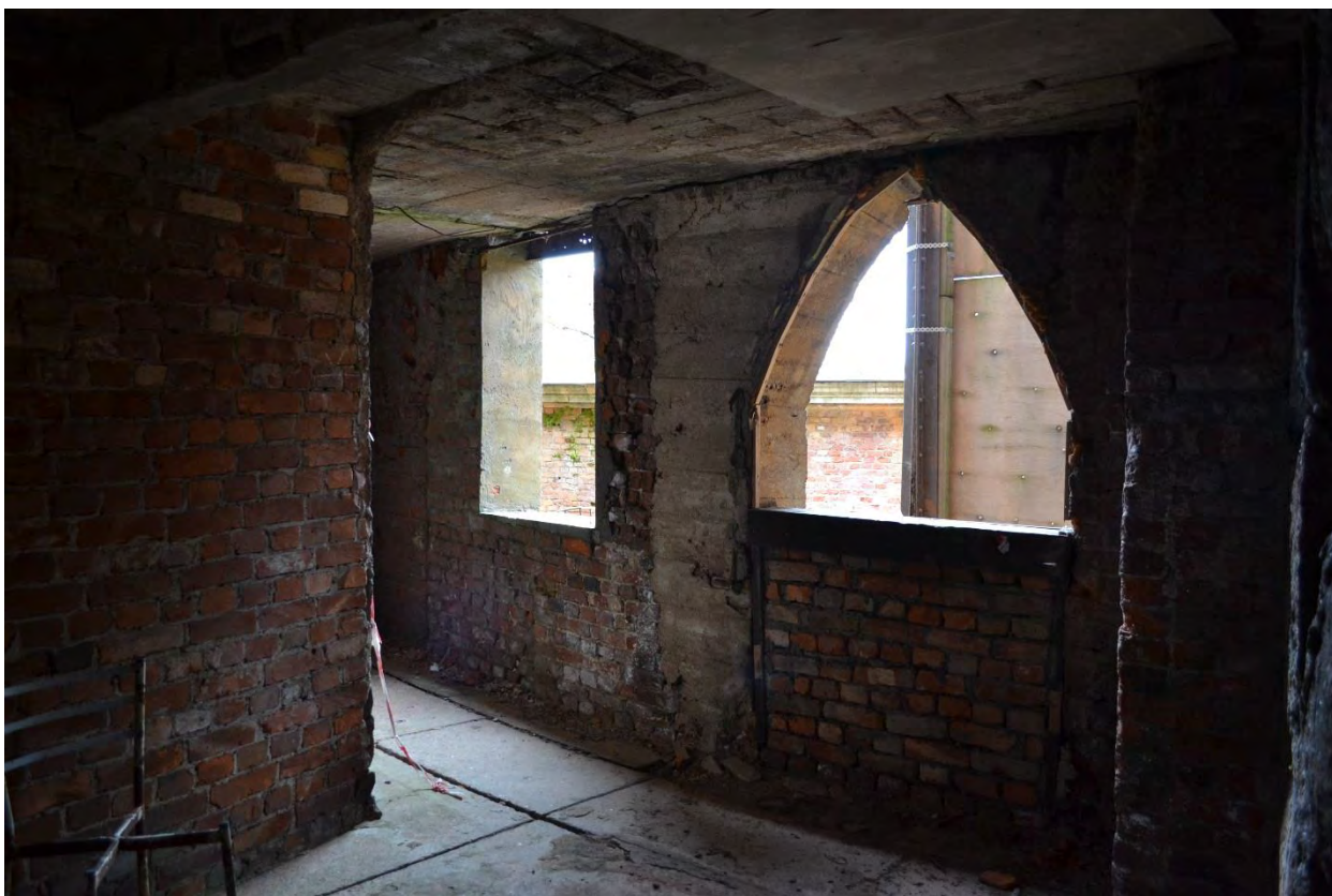
Фото 10. Казематы. Помещения третьего этажа.
