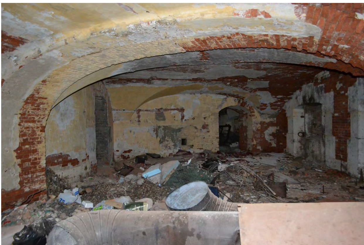
Фото 10. Первый этаж. Помещение казематов.
