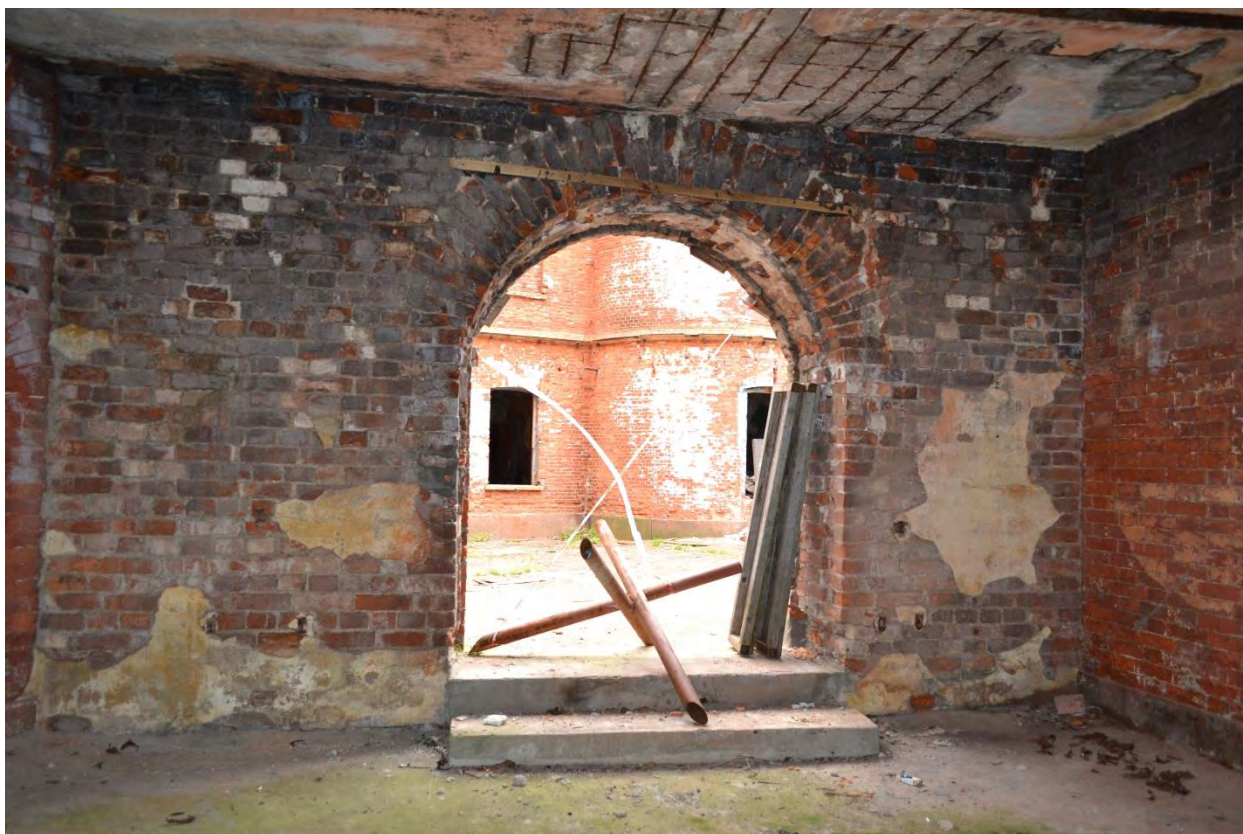
Фото 13. Первый этаж. Помещения порохоохранилища.
