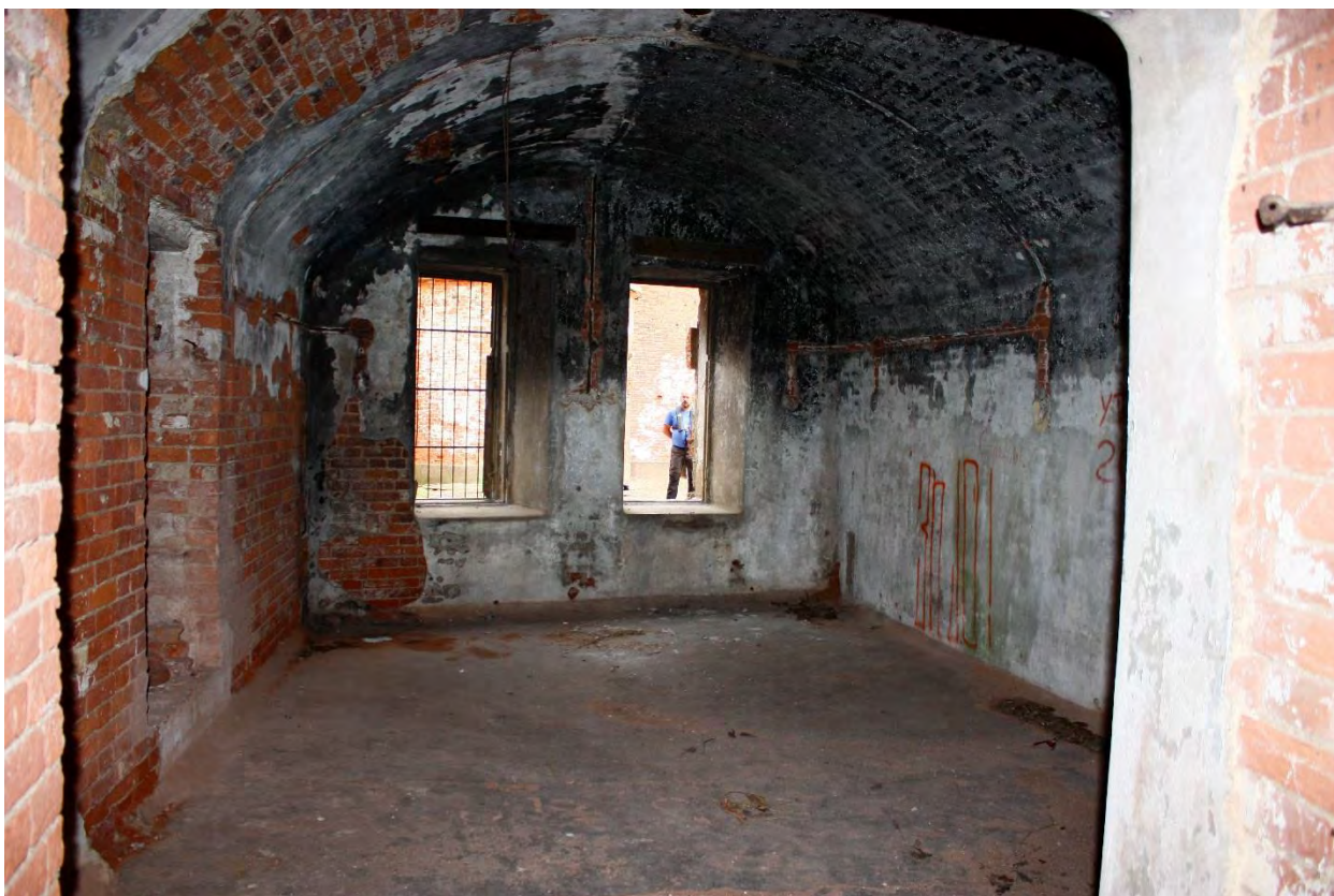
Фото 16. Первый этаж. Помещения порохоохранилища.
