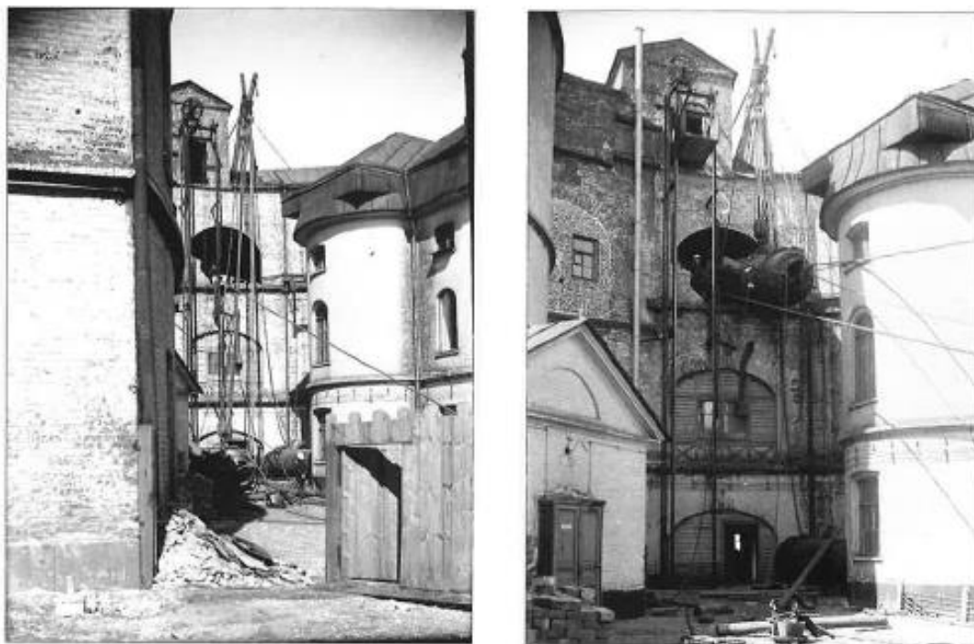
Илл. 34 Форт «Александр I». Подъем автоклава для пастеризации вакцин и сывороток на третий ярус форта. Начало XX в. // Л.И. Амирханов, Ю.П. Голиков, В.В. Чирков, Ю.Е. Иванова. Форт «Император Александр I» – СПб.: «Издательский центр «ОСТРОВ», 2008.
