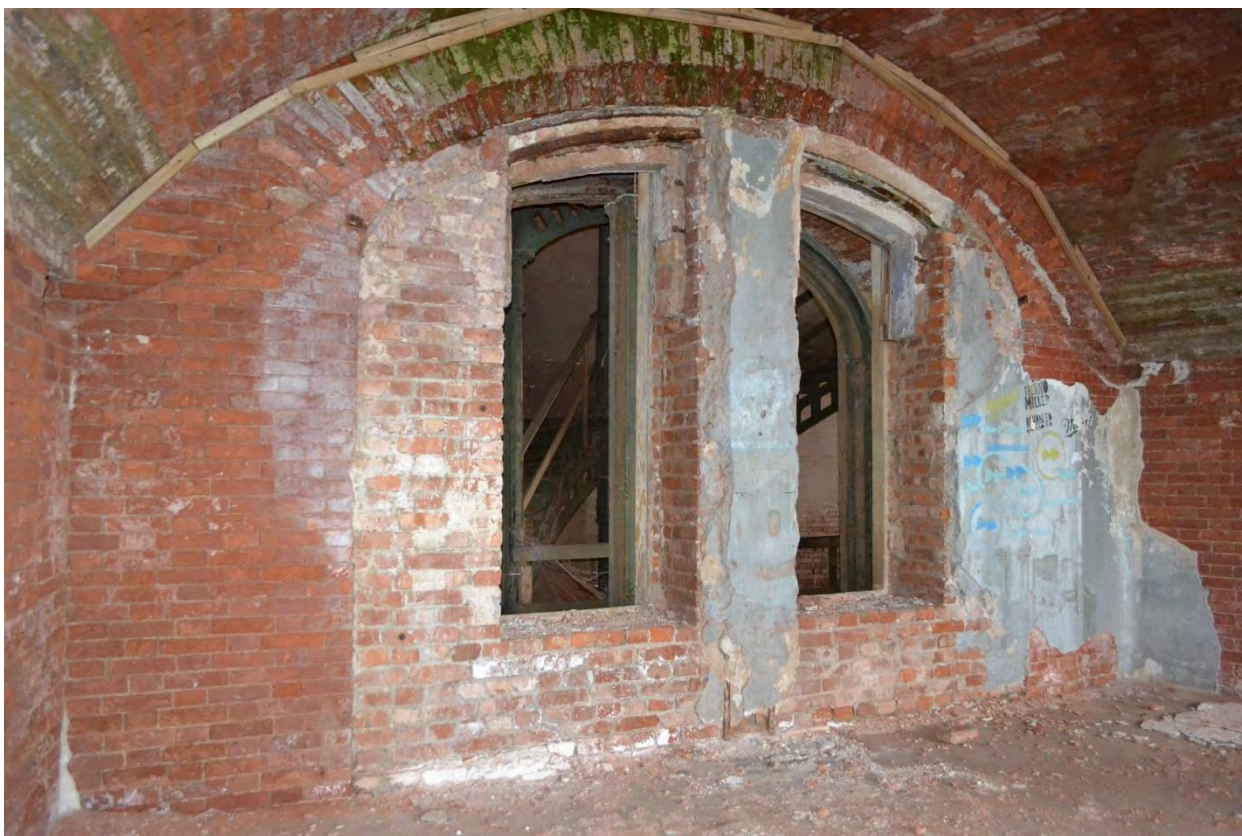
Фото 17. Каземат второго этажа. Частично заложенный проем на лестничную клетку.
