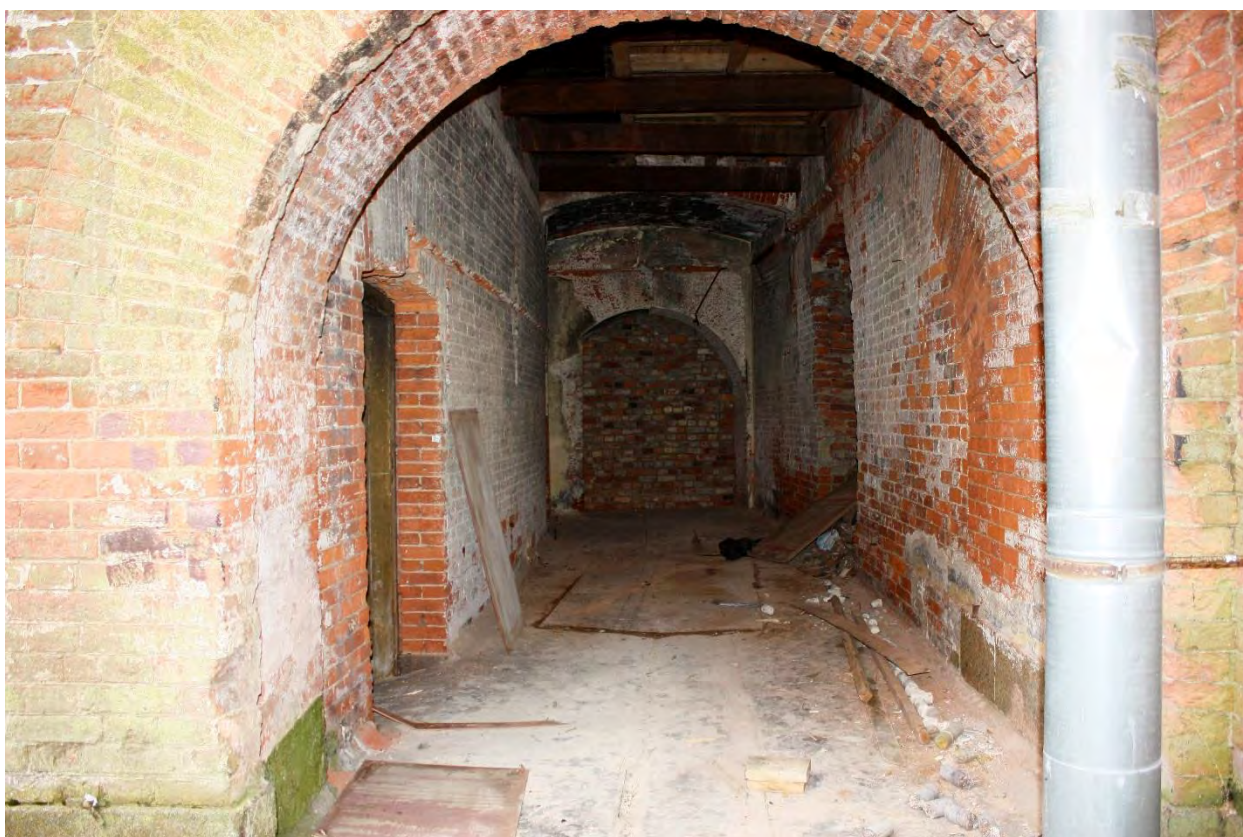
Фото 14. Первый этаж. Помещения порохоохранилища.
