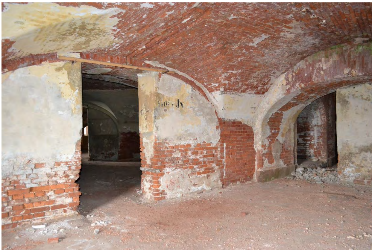
Фото 7. Первый этаж. Помещение казематов.
