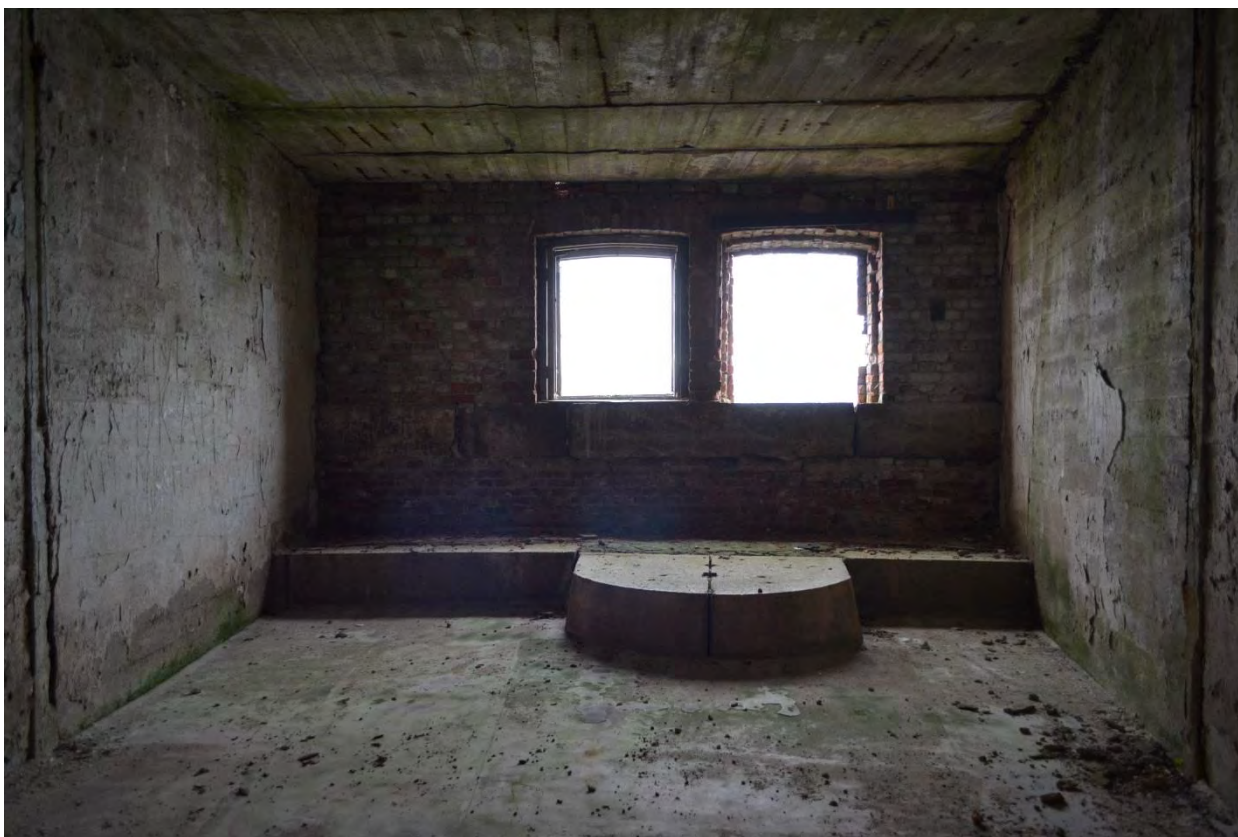
Фото 5. Казематы. Помещения третьего этажа.
