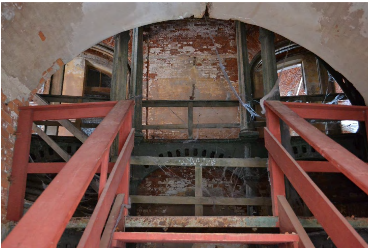
Фото 3. Вход в лестничную клетку с внутреннего двора.
