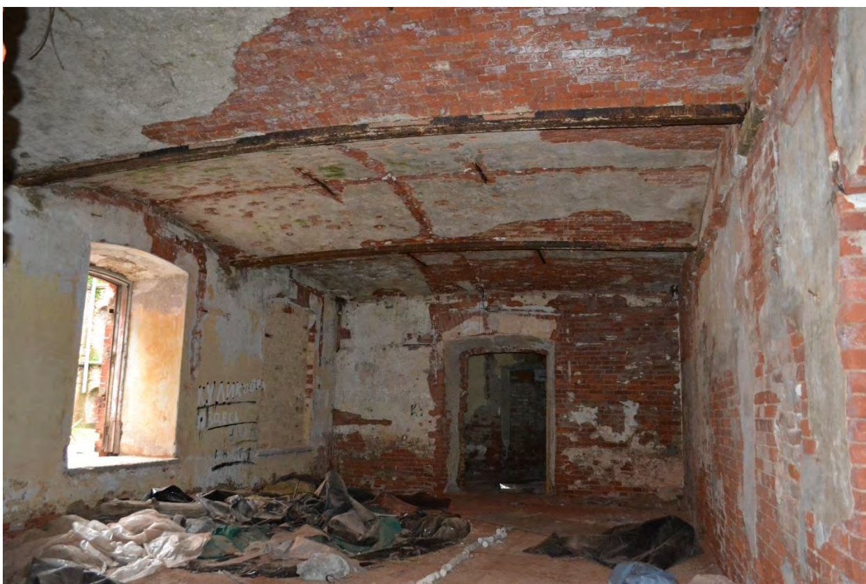
Фото 12. Первый этаж. Помещения горжевой части.
