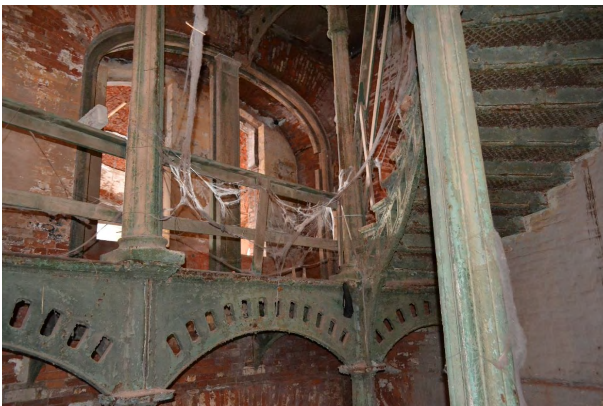
Фото 4. Лестничная площадка в уровне второго этажа. Общий вид.
