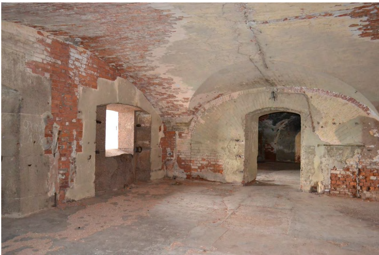
Фото 5. Первый этаж. Помещение казематов.
