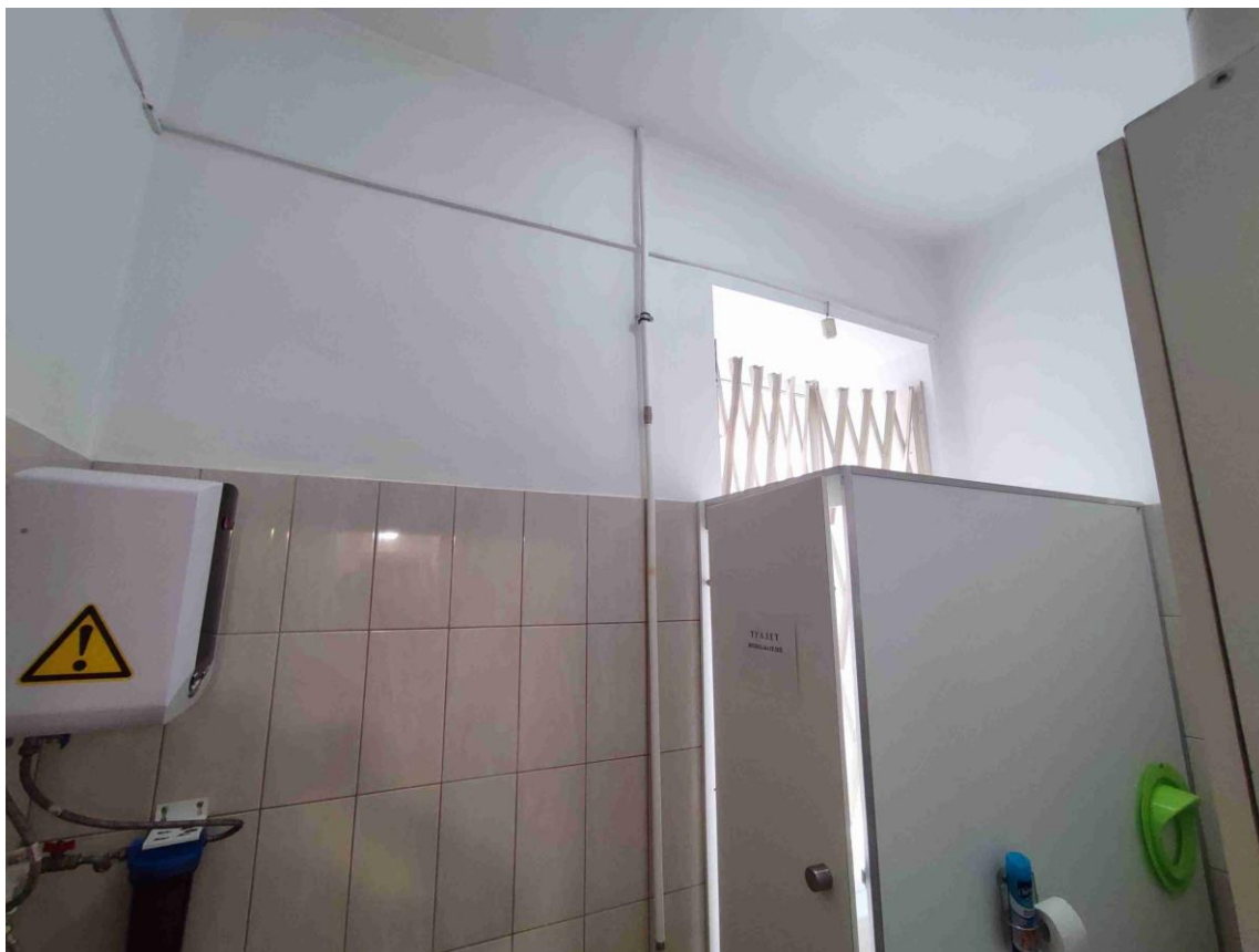
25. Общий вид. пом. № 5-Н (22) в уровне 1-го этажа.
