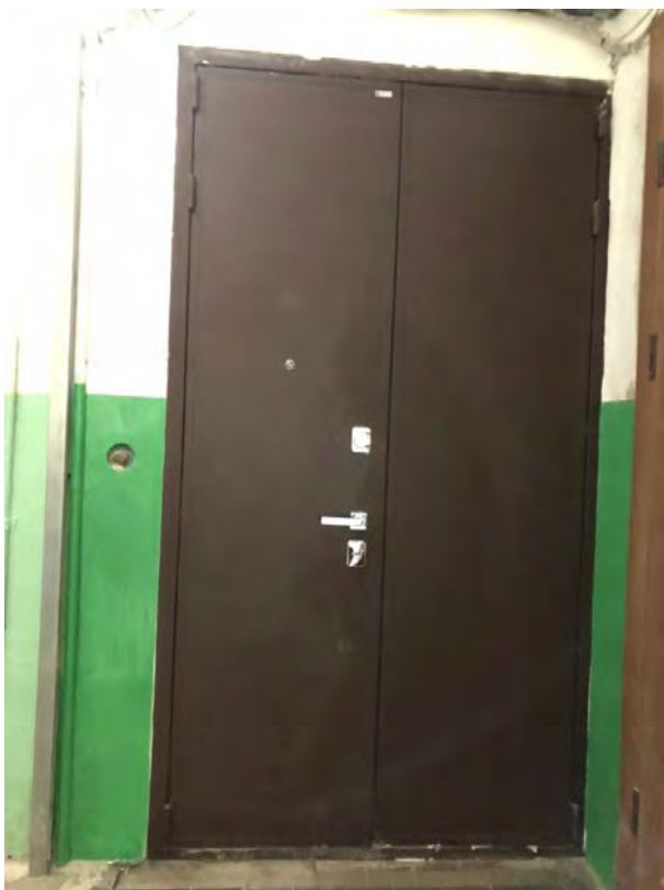
Фото 5. Входная дверь в квартиру №25
