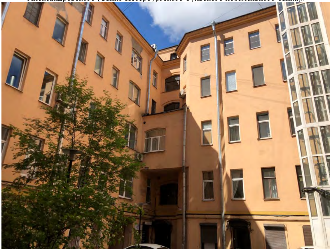
Фото 2. Дворовой фасад выявленного объекта культурного наследия «Дом И.Ф. Александровского (Санкт-Петербургского Тульского поземельного банка)»
