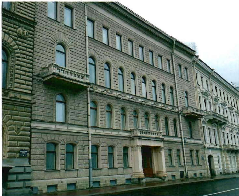
1, 2. Северо-западный фасад здания
