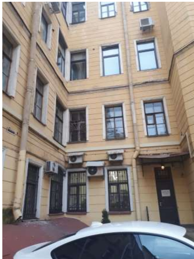
Фото 4. Фрагмент дворового юго-восточного фасада с сохранившимися историческими оконными заполнениями. Вид с юга.
