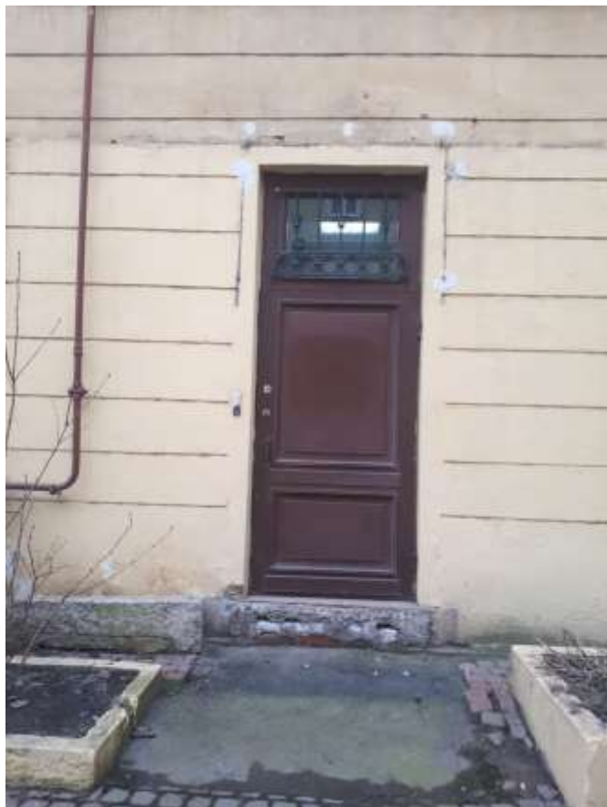
Фото 3. Дворовой северо-восточный фасад. Дверной проем в помещение №5. Вид с северо-востока.
