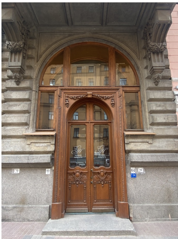
12. Деревянный дверной проем с фрамугами в западной части главного фасада
