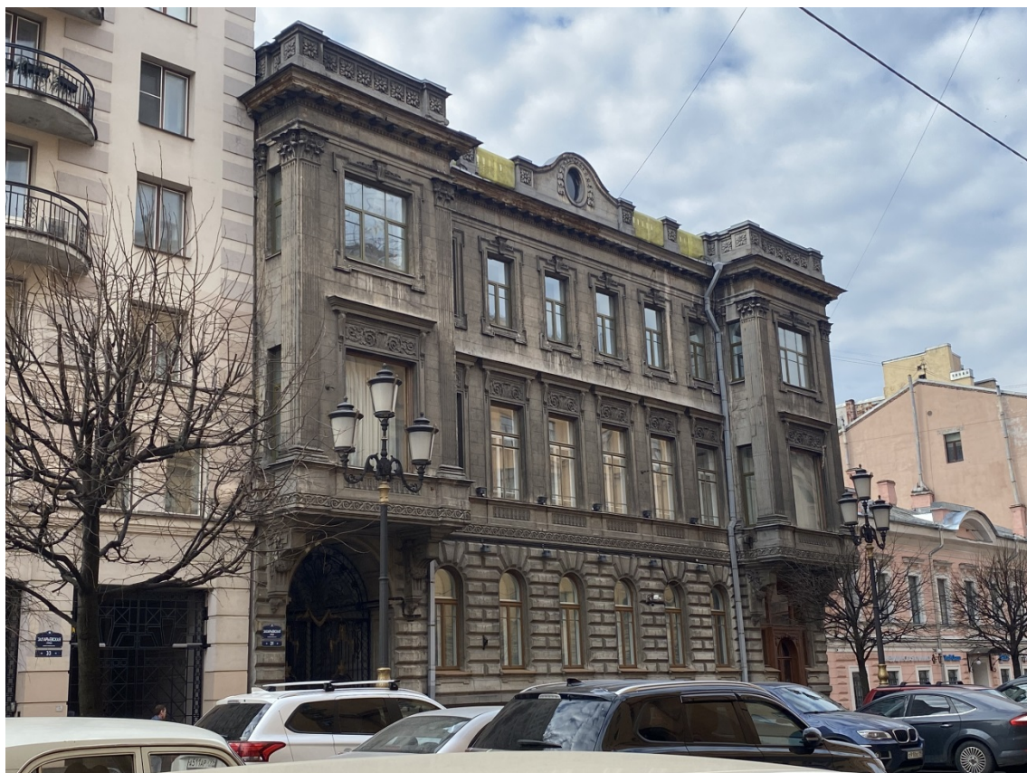
3. Вид с северо-востока на главный фасад объекта культурного наследия регионального значения «Особняк Нейдгардта Д.В.»
