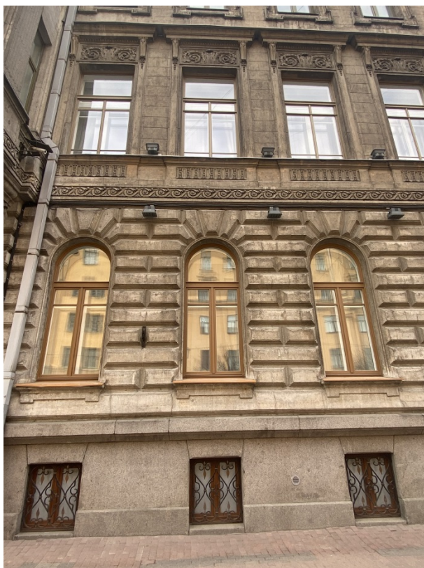
9. Оконные проемы объекта культурного наследия регионального значения «Особняк Нейдгардта Д.В.»
