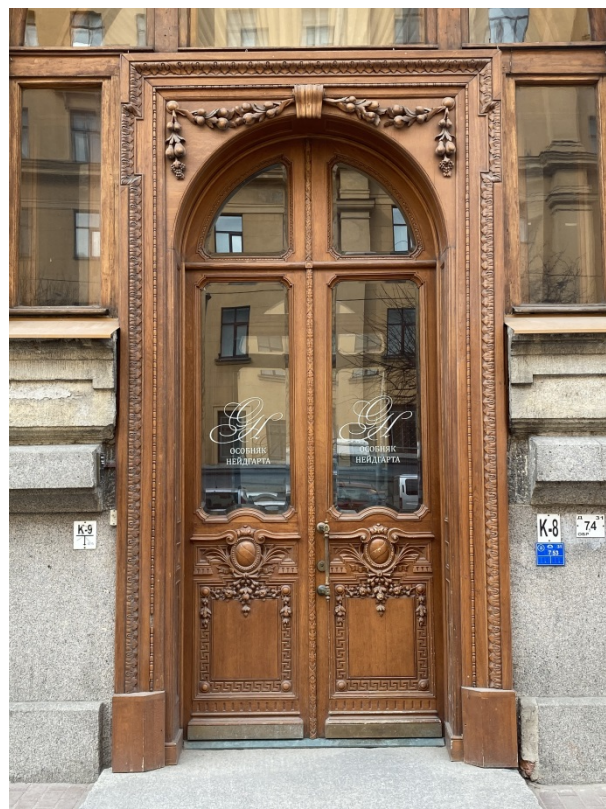
13. Деревянный дверной проем с фрамугами в западной части главного фасада
