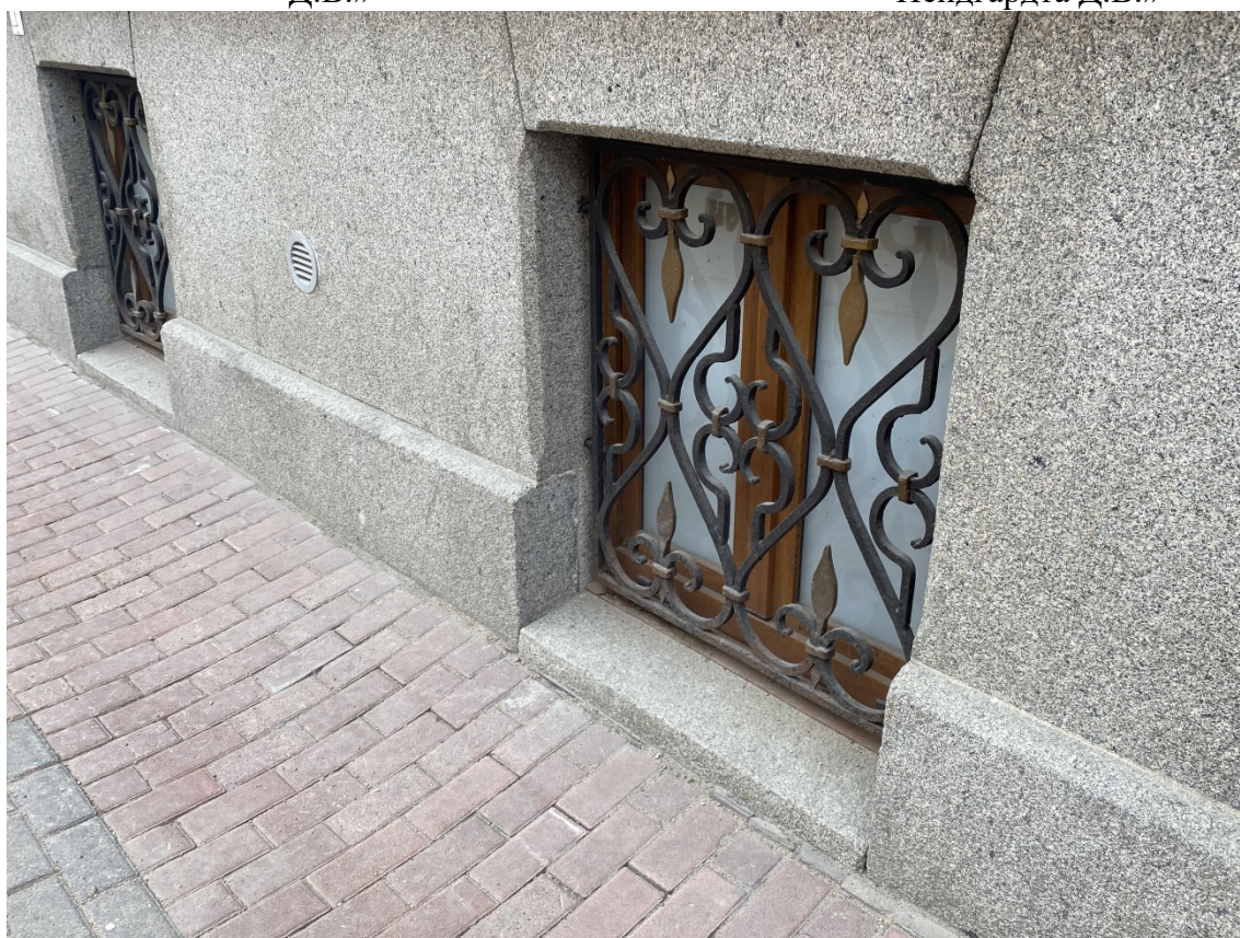
11. Декоративные кованые решетки на оконных проемах цокольного этажа объекта культурного наследия регионального значения «Особняк Нейдгардта Д.В.»
