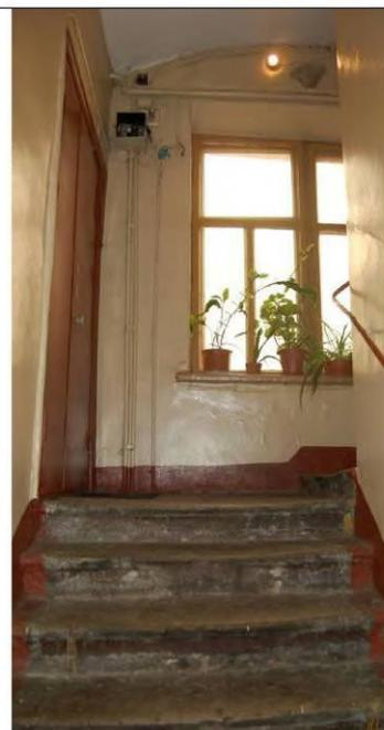
восточная лестница дворового корпуса, ведущая в квартиру № 55 – габариты, конфигурация (поворотная), местоположение, тип (маршевая, средистенная), конструкция чердачного марша (на косоурах); материал ступеней и площадок (известняк), площадки по коробовым сводам;
