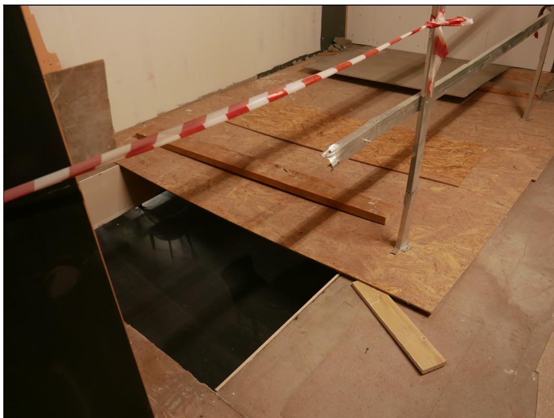
14. Интерьер ресторана (пом.18-Н). Мансардный этаж. Зона устройства проектируемой лестницы для сообщения с нижерасположенным этажом.
