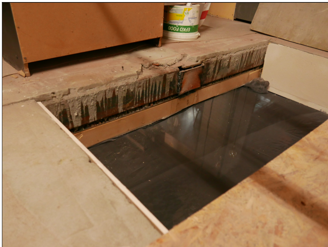
15. Интерьер ресторана (пом.18-Н). Мансардный этаж. Зона устройства проектируемой лестницы для сообщения с нижерасположенным этажом.
