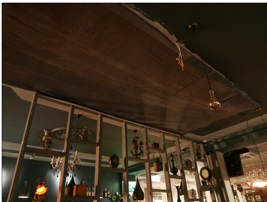
12. Интерьер ресторана (пом.18-Н). Зона устройства проектируемой лестницы для сообщения с вышерасположенным мансардным этажом.
