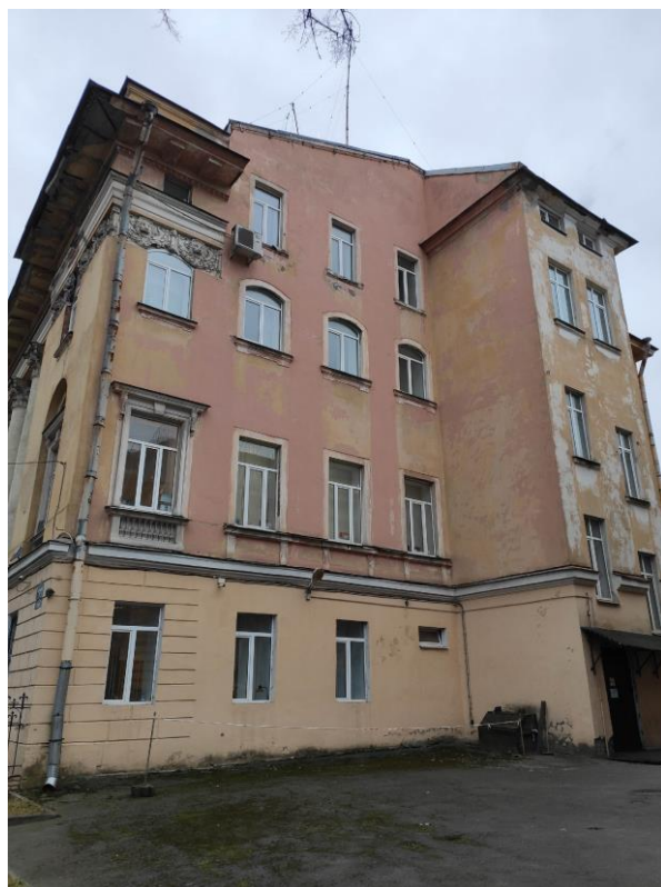
Фото №8. Торцевой восточный фасад. Направление съемки – с севера
