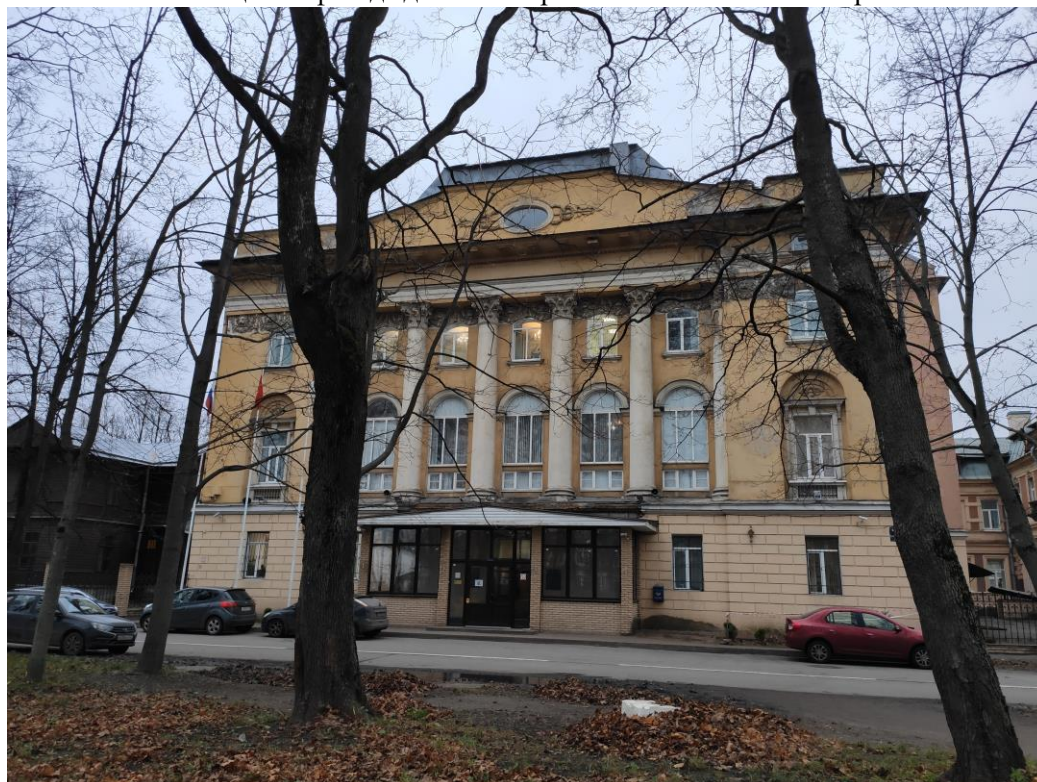
Фото №2. Лицевой фасад. Направление съемки – с востока
