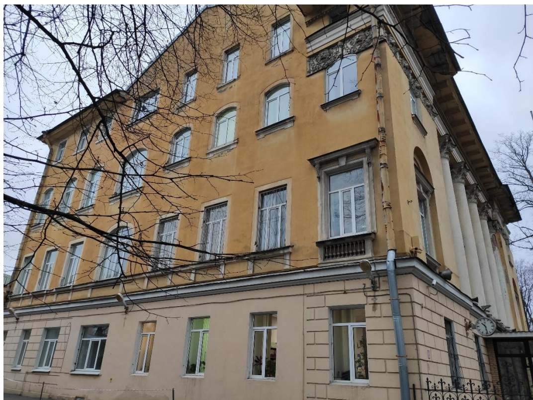
Фото №4. Торцевой южный фасад. Общий вид.
