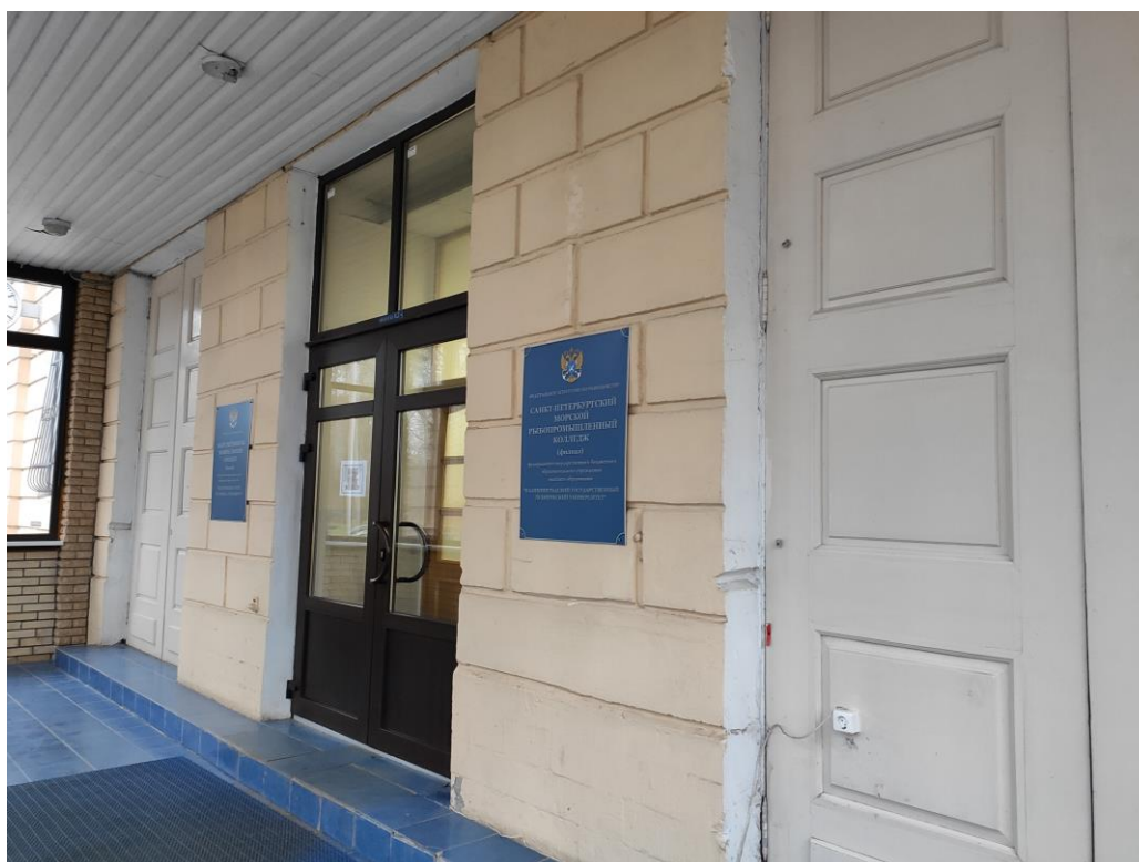
Фото №6. Фрагмент лицевого фасада. Исторический центральный вход.
