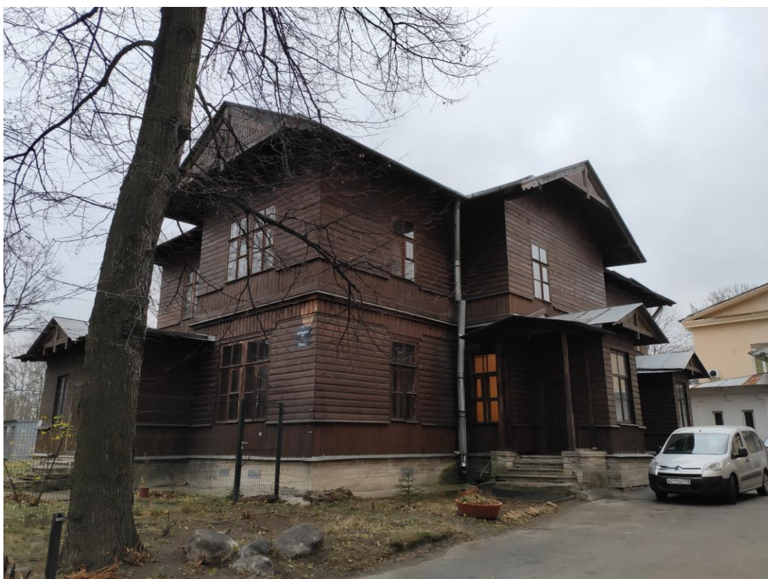
Фото №15. Общий вид соседнего (с юга) здания – деревянного служебного флигеля дачи Доливо-Добровольской.
