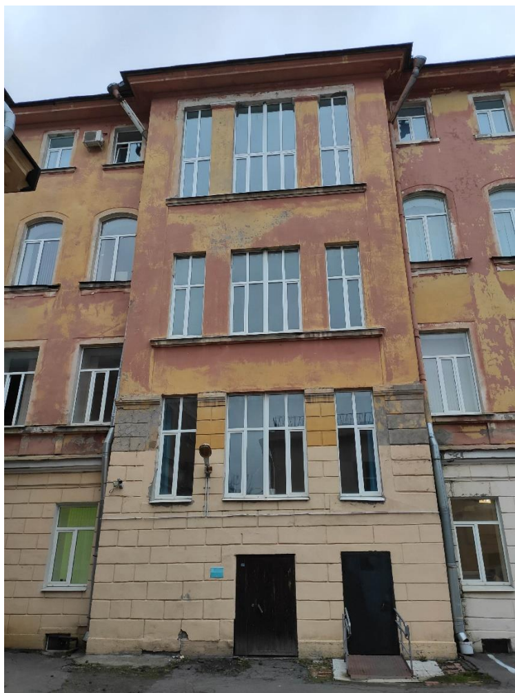
Фото № 13. Фрагмент дворового западного фасада. Вход для МГН.
