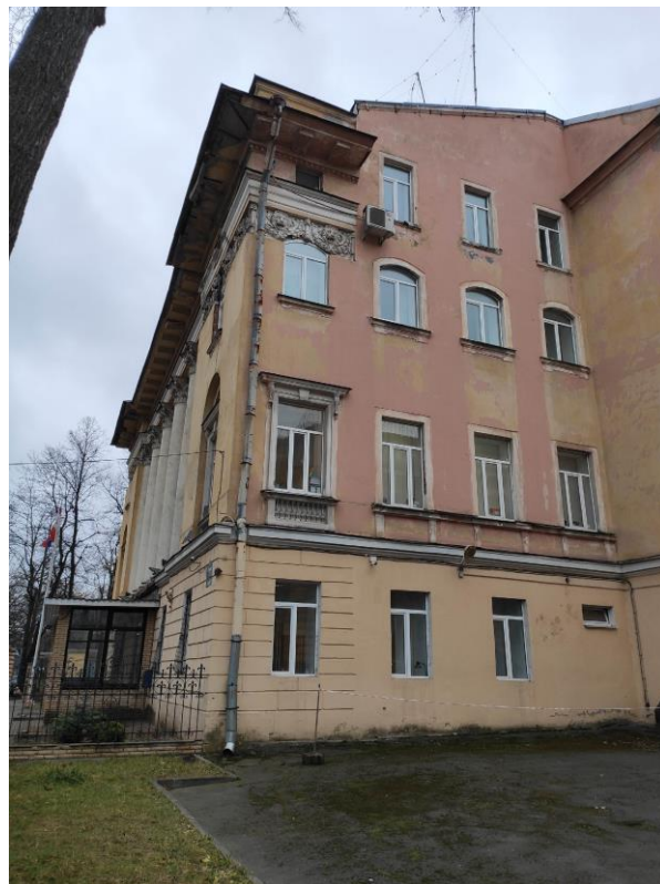
Фото №9. Фрагмент торцевого восточного фасада и поздней пристройки тамбура со стороны лицевого фасада
