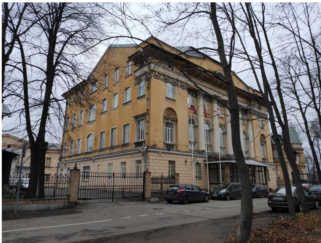
Фото №3. Лицевой и торцевой фасады. Направление съемки – с юго-востока
