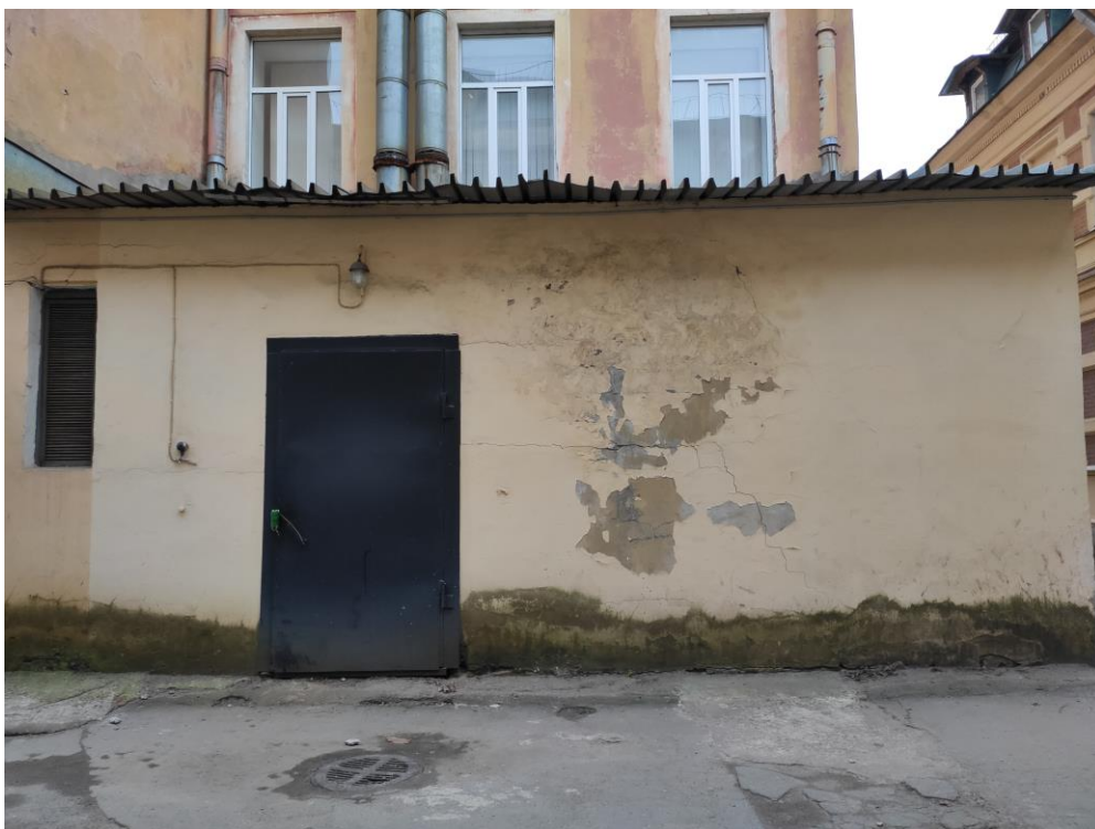
Фото №12. Фрагмент торцевого северного фасада. Пристройка-котельная
