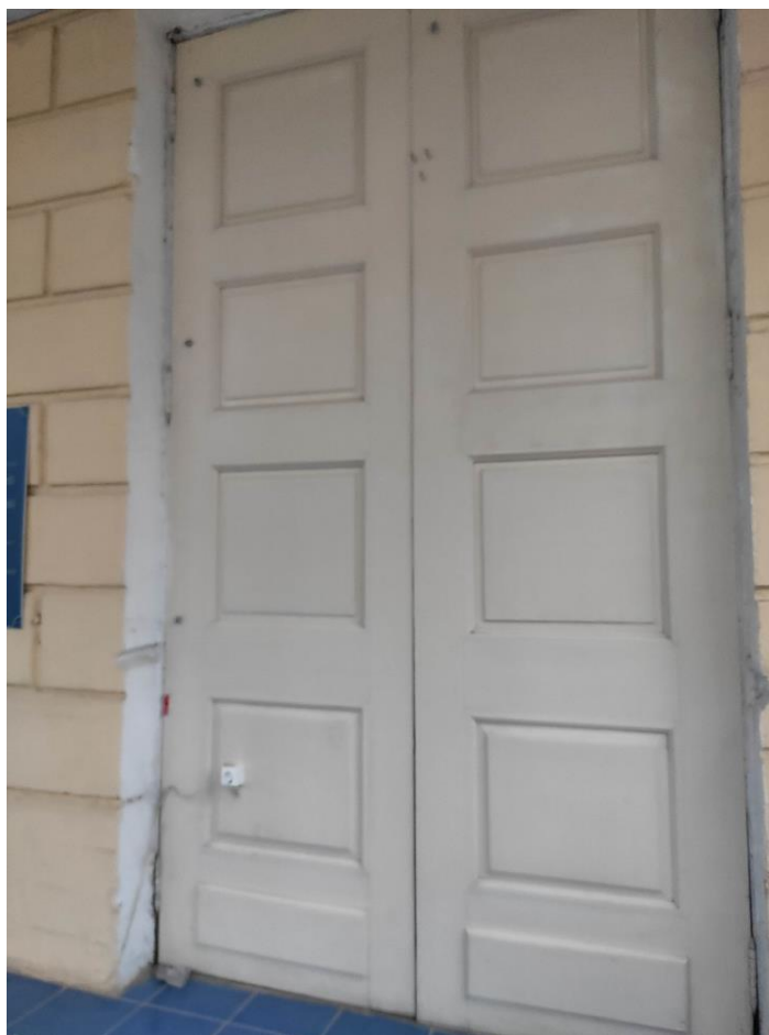
Фото №7. Существующие деревянные дверные заполнения.
