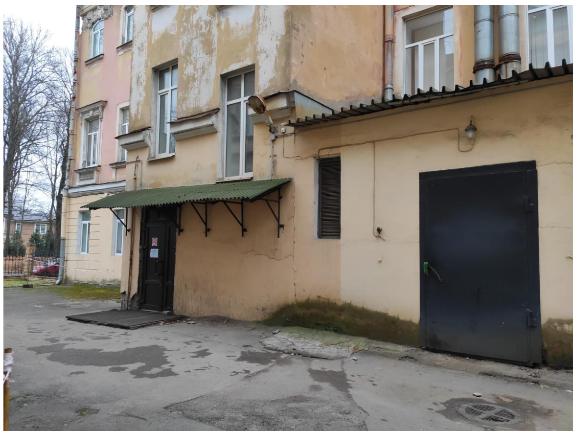
Фото №11. Фрагмент торцевого северного фасада. Фрагмент пристройки-котельной
