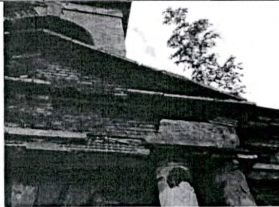
8. Фрагмент юго-западного фасада
