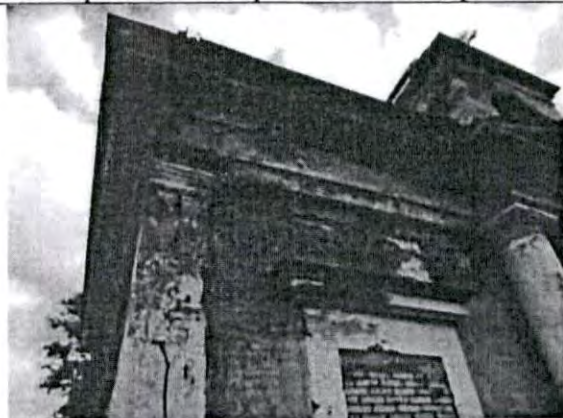
7. Фрагмент юго-западного фасада
