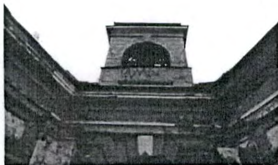
3. Фрагмент северо-восточного фасада
