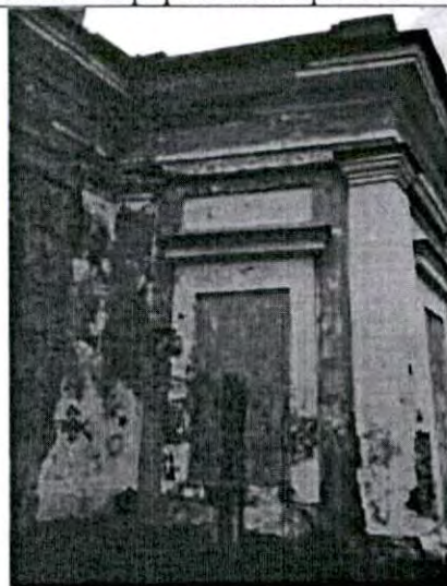
6. Фрагмент северо-восточного фасада
