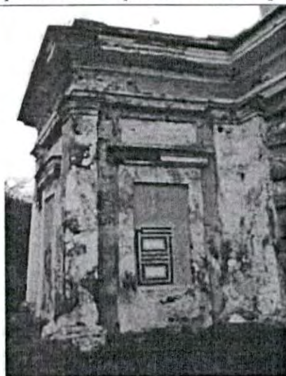
5. Фрагмент северо-восточного фасада
