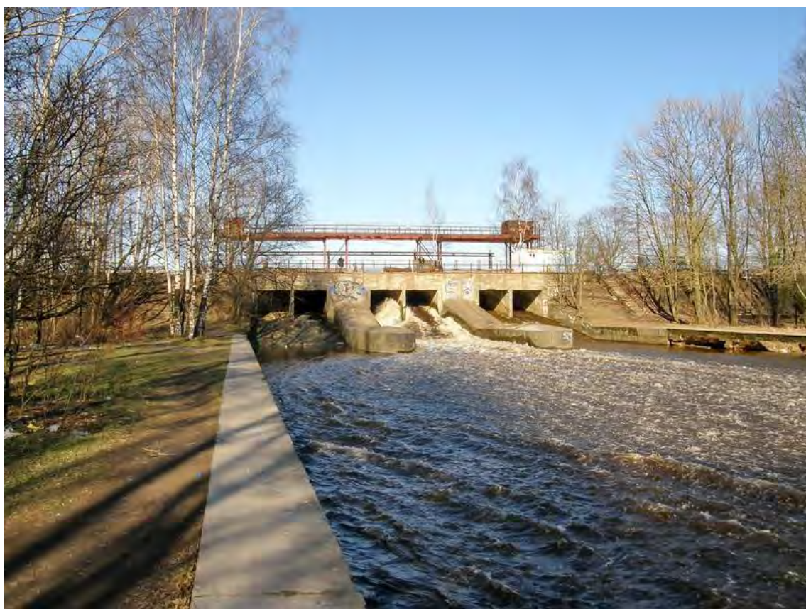
Илл. 41. Главная плотина Охтинских пороховых заводов. 2000-е гг.
