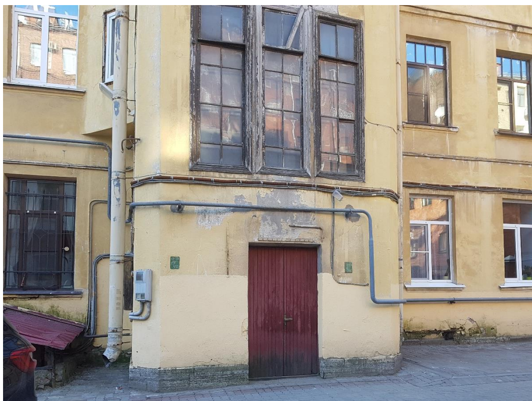
Фото 20. Дверной проем и окно лестницы Л-3. Дворовой фасад.
