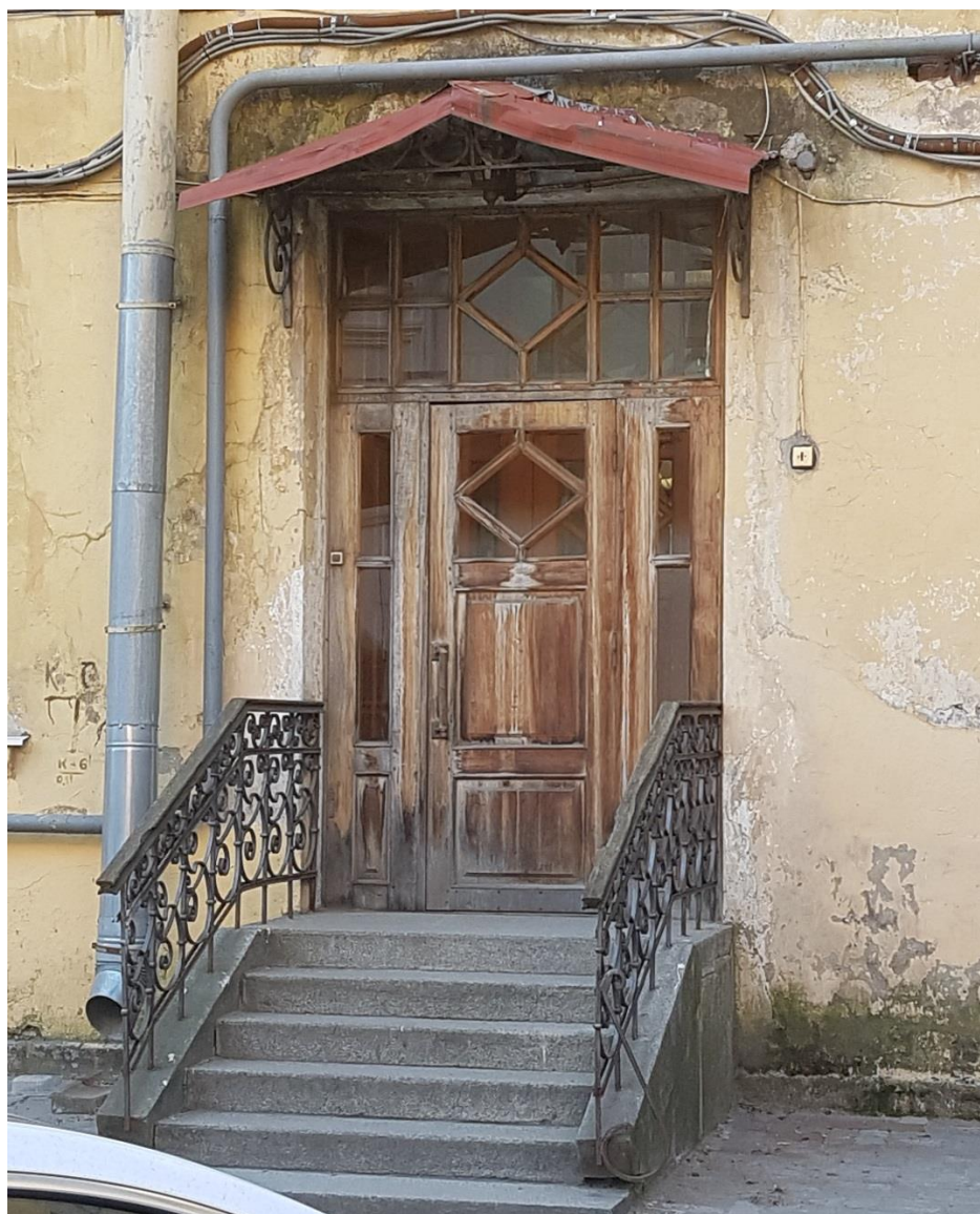
Фото 18. Дверной проем и окно лестницы Л-3. Дворовой фасад.
