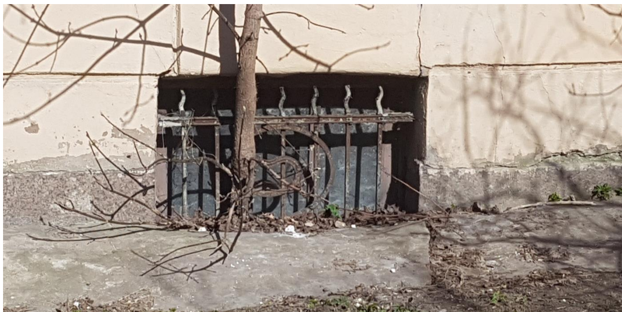
Фото 13. Цоколь. Оконный проем и решетка в уровне подвала. Лицевой фасад.
