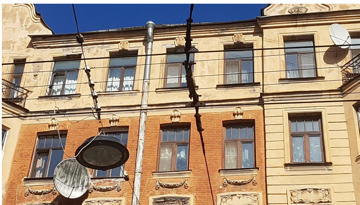
Фото 10. Окна в уровне 4-го и 5-го этажей. Лицевой фасад.
