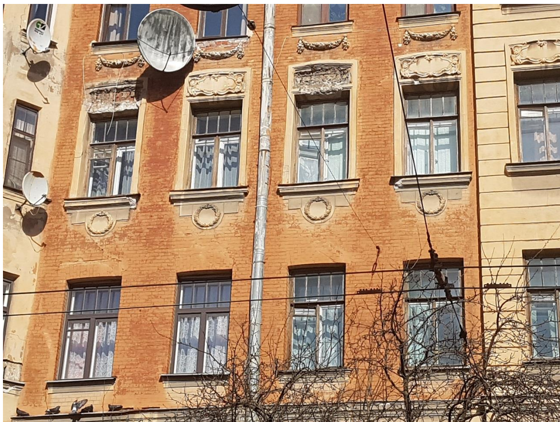
Фото 11. Окна в уровне 2-го и 3-го этажей. Лицевой фасад.
