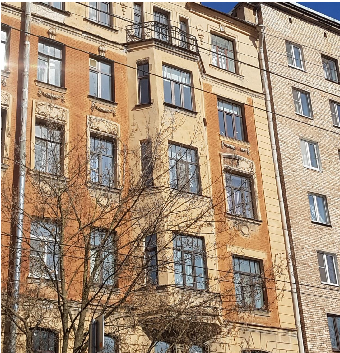
Фото 7. Эркер по правой оси лицевого фасада.
