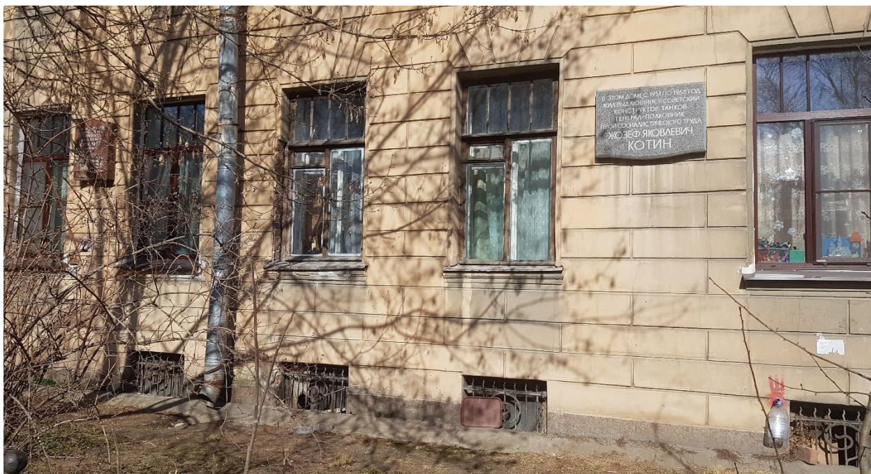
Фото 15. Окна подвала и окна в уровне первого этажа. Лицевой фасад.
