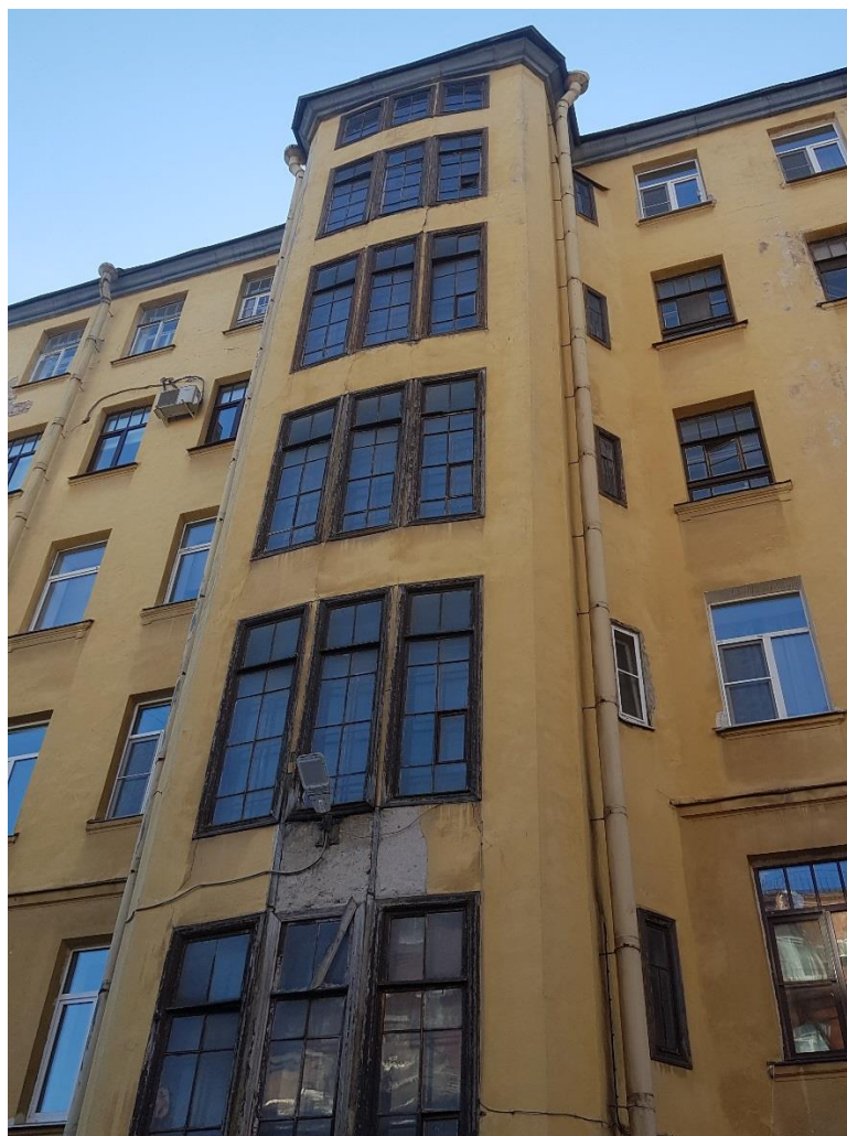
Фото 19. Левый ризалит. Карниз обшит металлом. Дворовой фасад.
