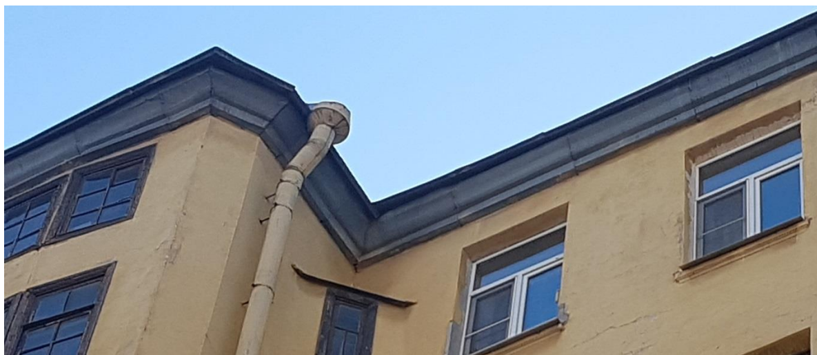
Фото 24. Венчающий карниз обшит металлом. Дворовой фасад.
