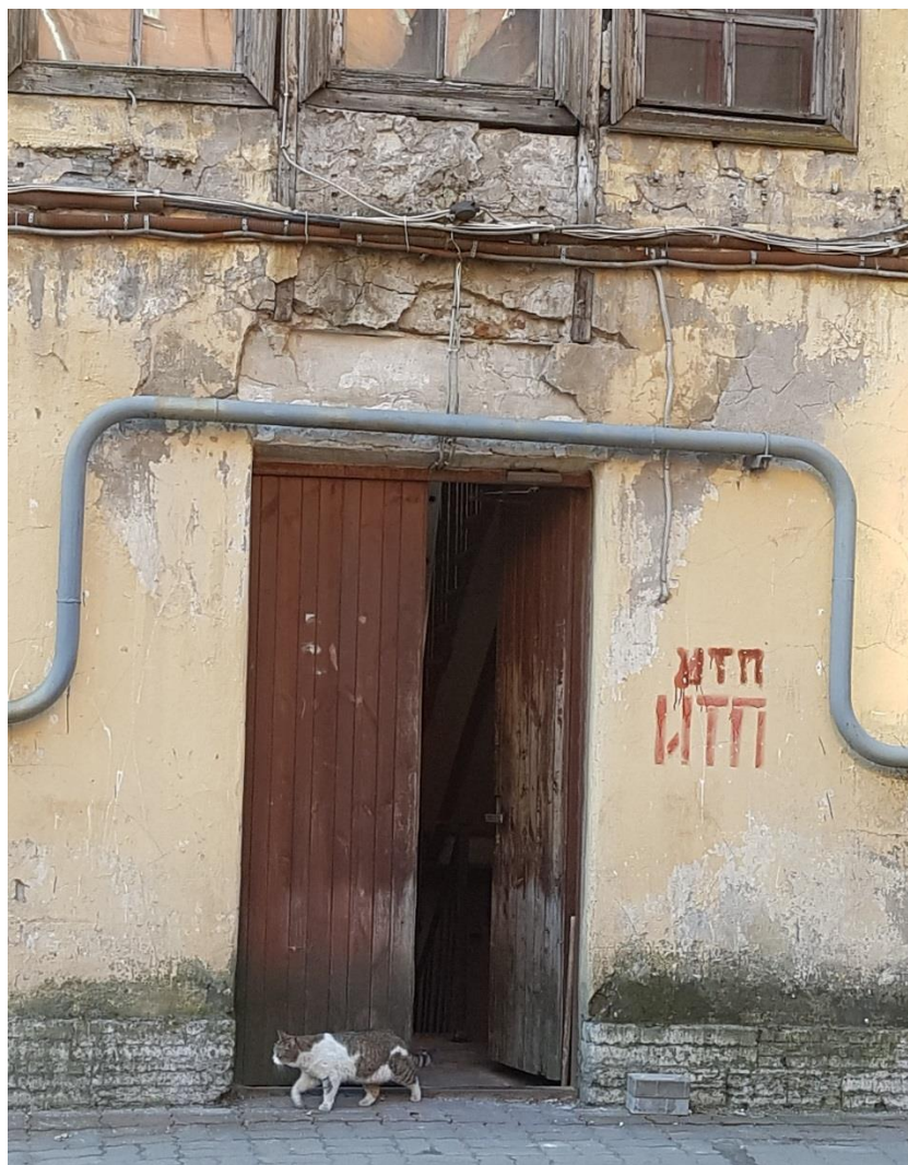
Фото 21. Дверной проем лестницы Л-2. Дворовой фасад.
