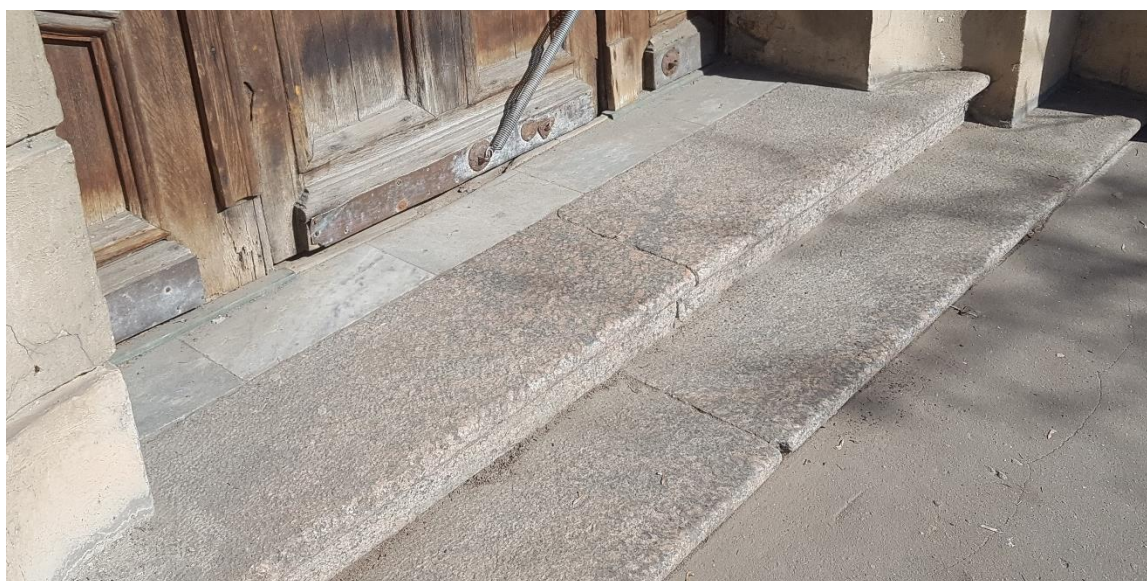
Фото 4. Ступени портала. Лицевой фасад.
